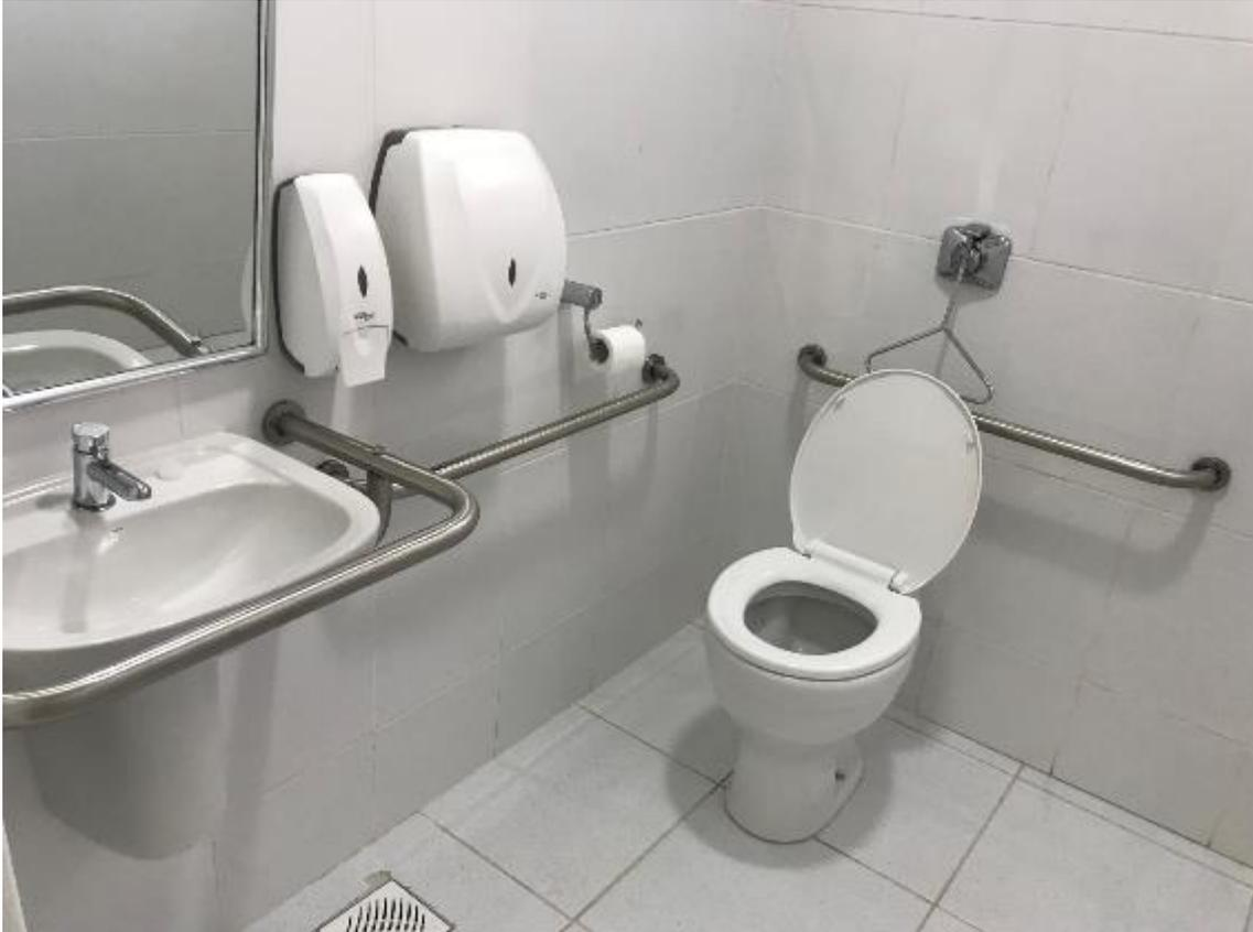
Modelo de Instalações sanitárias PCD
