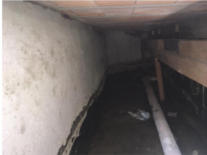
*REBAIXO DA LAJE EXPOSTA – REMOÇÃO DE IMPERMEABILIZAÇÃO EXISTENTE*
