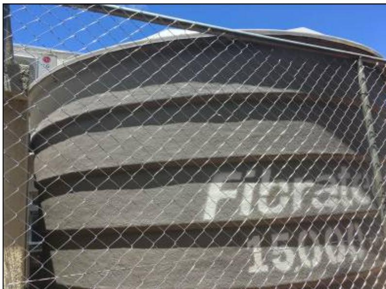
Figura 01 – reservatório fibra de vidro – 15.000 litros
