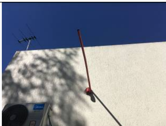
Figura 01: Execução de furos para a passagem das tubulações.
