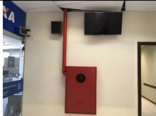
Figura 10: Hidrante instalado
