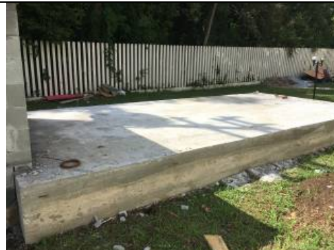
Figura 04: Base de concreto executada.
