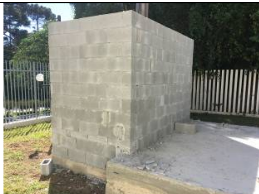
Figura 06: Execução de alvenaria – casa de bombas.
