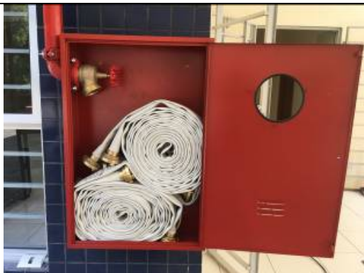
Figura 11: Mangueiras instaladas.
