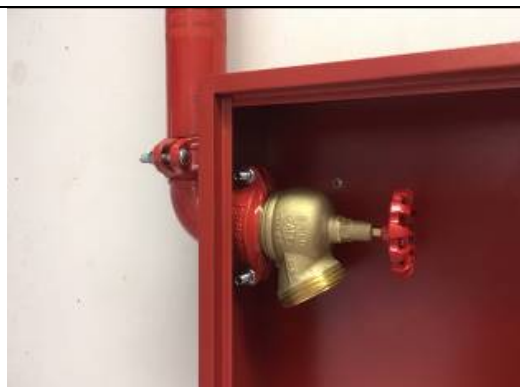
Figura 07: Cotovelo aço galvanizado.
