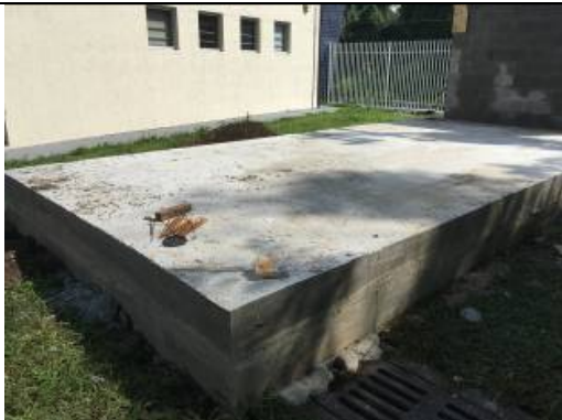
Figura 03: Base de concreto executada.
