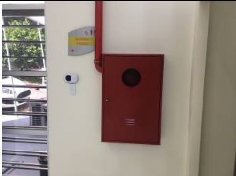
Figura 09: Hidrante instalado
