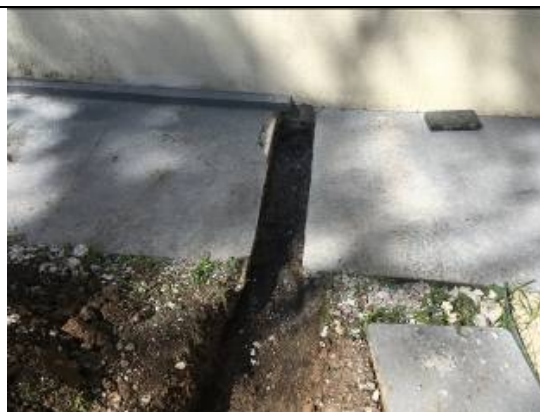
Figura 02: demolição de calçada para a passagem das tubulações.
