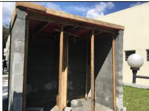
Figura 05: Execução de forma e laje de concreto para a casa de bombas.
