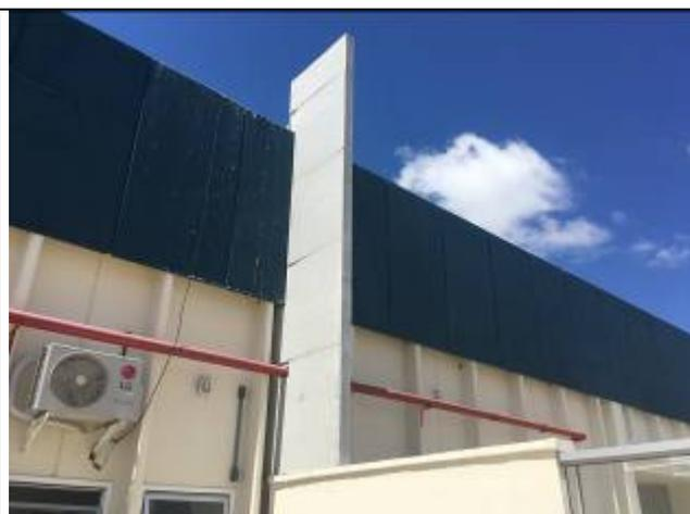
Figura 03: parede steel frame – aba dos fundos.
