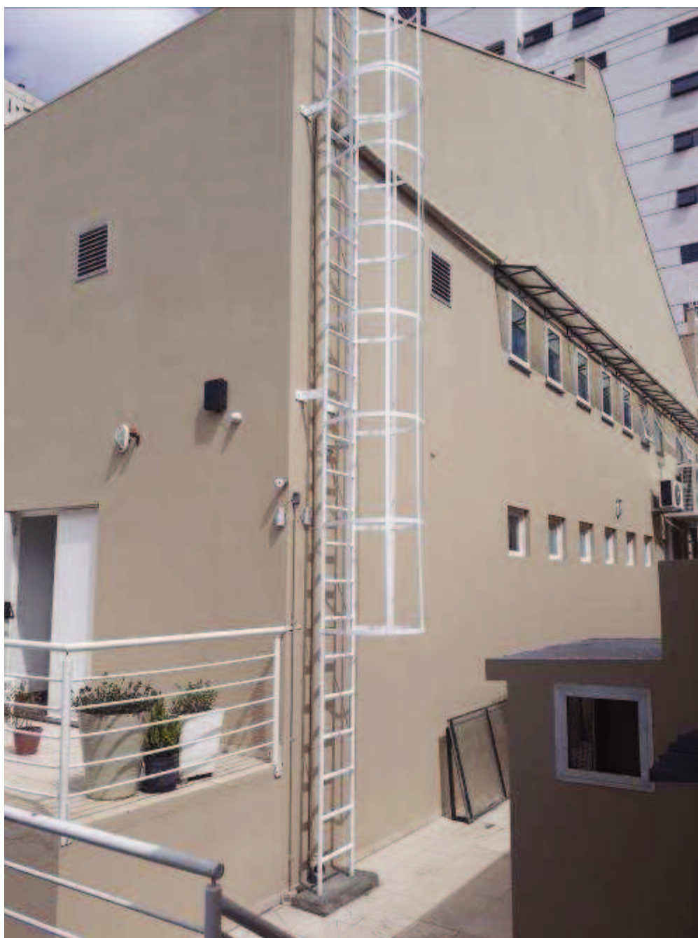
Figura 5: Escada metálica sem patamar pintada.
