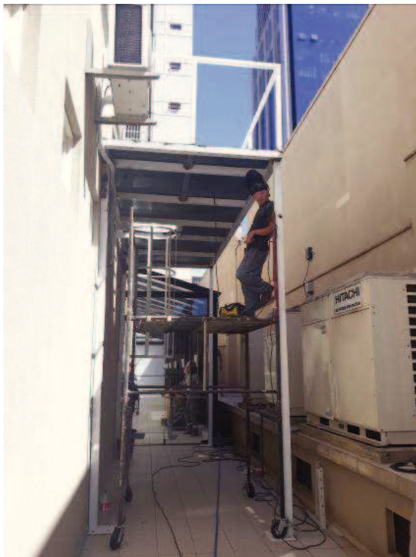
Figura 1: Estrutura de andaimes.
