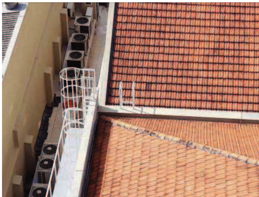
Figura 3: Escada vista superior
