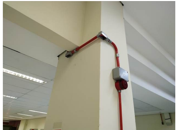
Figura 04: Infraestrutura, cabeamento e indicador audivisual
