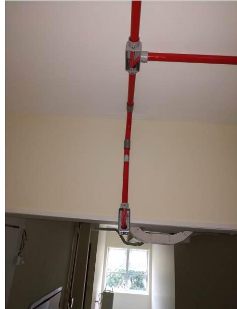
Figura 04: Infraestrutura e cabeamento
