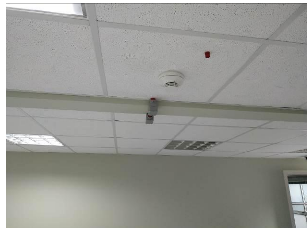
Figura 10: Detector óptico de fumaça e avisador de acionamento
