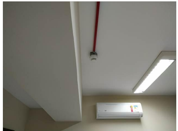
Figura 14 - Detector óptico de fumaça
