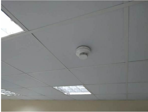
Figura 09: Detector óptico de fumaça
