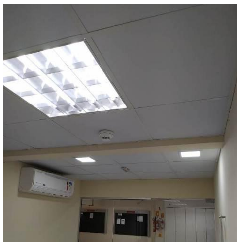
Figura 07: Detector óptico de fumaça
