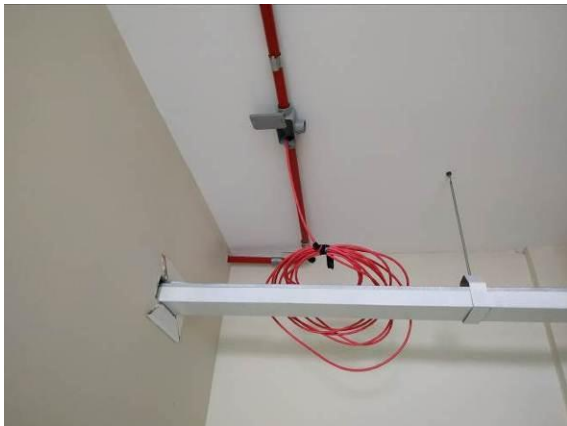
Figura 15 - Infraestrutura e cabeamento - instalação em andamento (área de espera)
