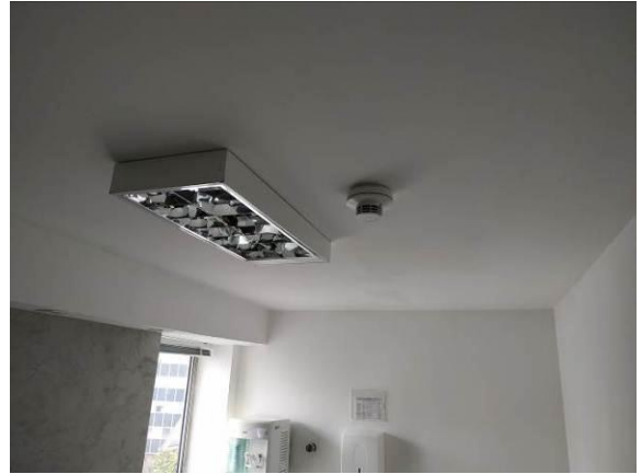
Figura 10: Instalação em forro de gesso - detector térmico
