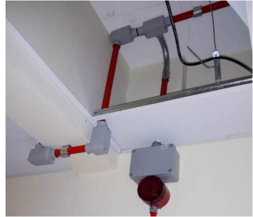
Figura 04: Infraestrutura e cabeamento, avisador (transição para entreforro)
