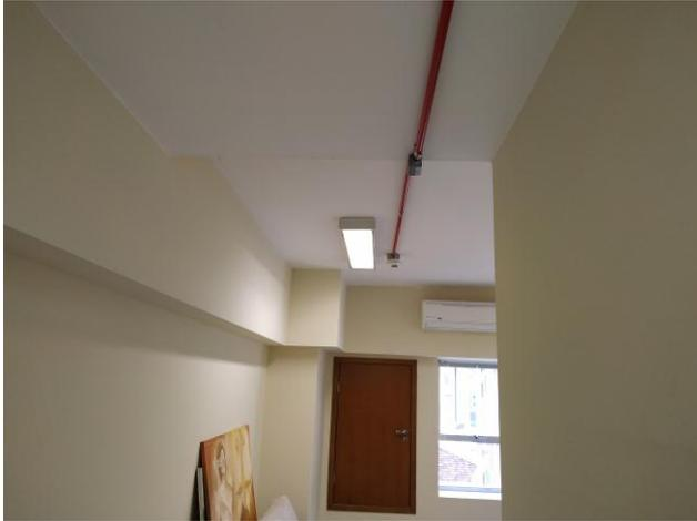
Figura 15 - Infraestrutura e detector óptico de fumaça
