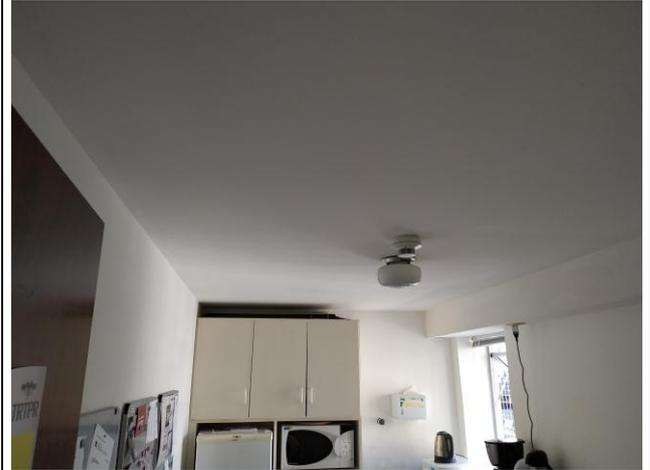
Figura 16 - Instalação em forro de gesso - detector térmico
