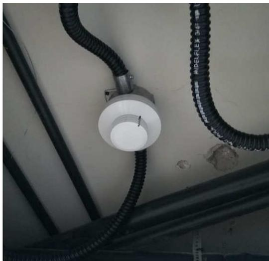
Figura 09: Detector óptico de fumaça endereçável
