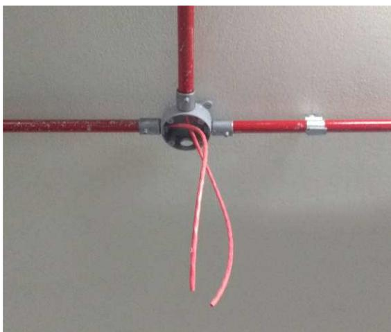
Figura 07: Cabo para sinal de detecção de incêndio
