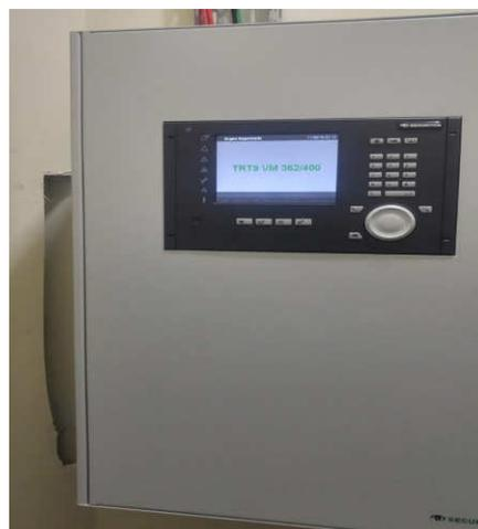
Figura 08: Central de alarme de incêndio
