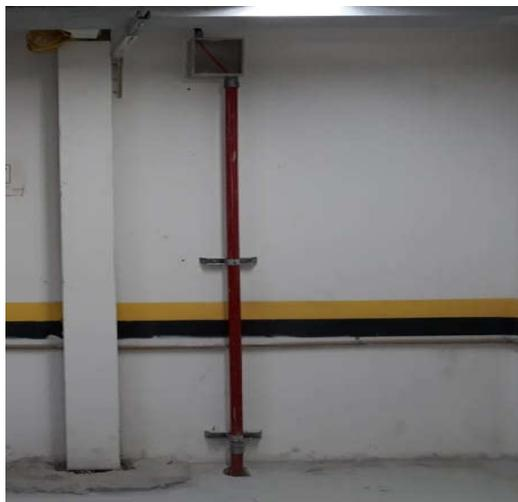
Figura 03: Eletroduto de aço galvanizado 40mm
