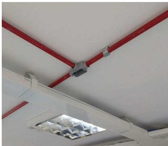
Figura 02: Eletroduto de aço galvanizado 25mm
