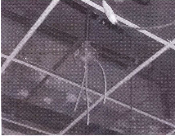
Figura 09: Cabo para sinal e detecção de incêndio
