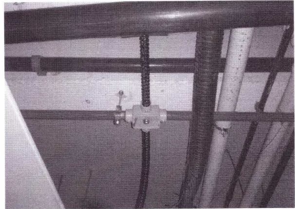
Figura 08: Eletroduto flexível metálico
