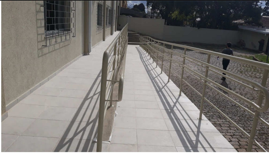
Figura 07 - Rodapés na plataforma e rampa.
