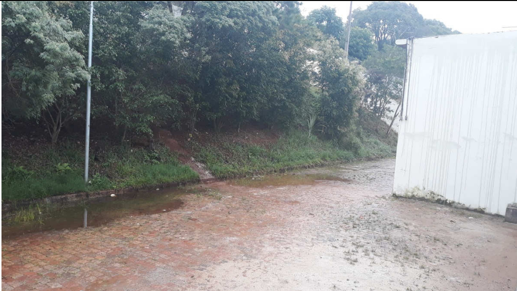
Figura 24 - Limpeza nos taludes.
