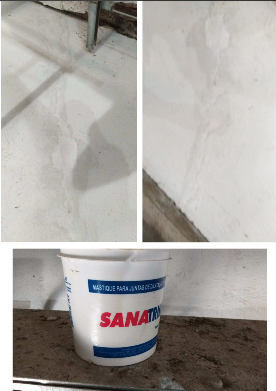
Figuras 05 - Preenchimento de trincas.
