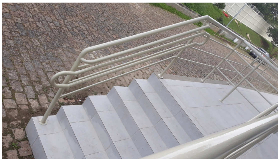
Figuras 06 - Assentamento de revestimento cerâmico na plataforma e rampa.
