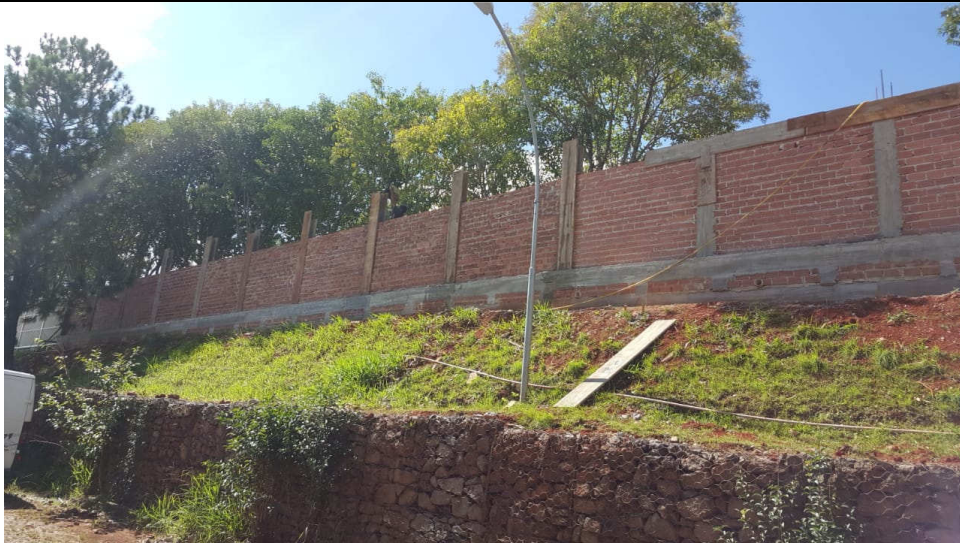
Figura 03: Pilares do muro de divisa.
