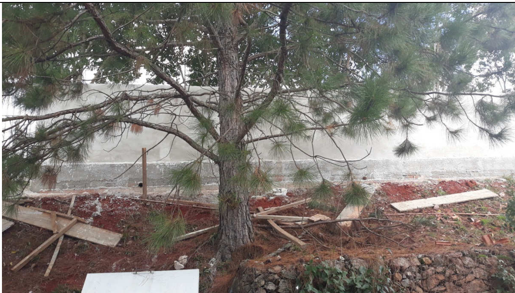
Figura 10 - Chapisco e argamassa no muro da divisa.
