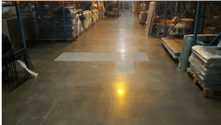
Figura 08 - Piso TecnoGram assentado em vários pontos do almoxarifado.
