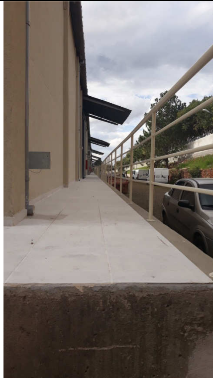
Figura 13 - Guarda corpo instalado.
