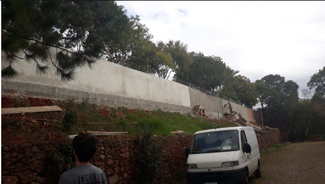
Figura 09 - Alvenaria para construção do muro.
