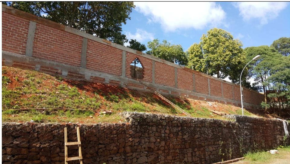
Figura 04 - Vigas de concreto do muro de divisa.
