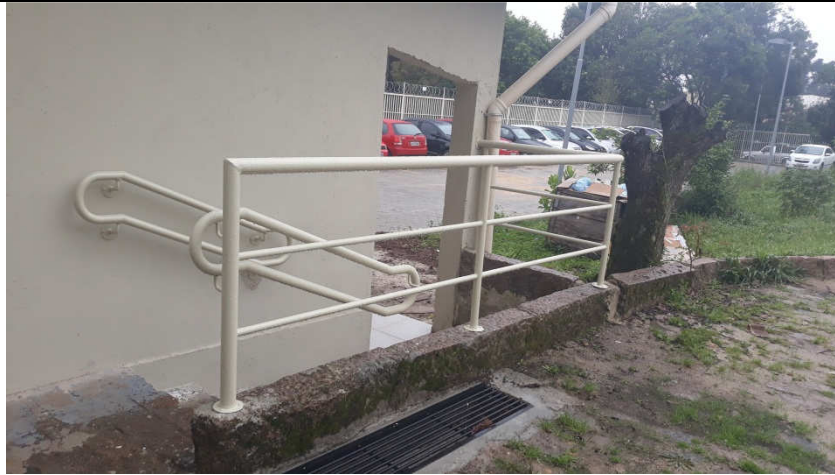
Figuras 14 - Corrimãos e guarda-corpos das escadas da guarita e Área de Vivência.
