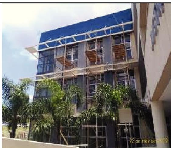
Figura 02: Instalação andaimos - Fachada SUL
