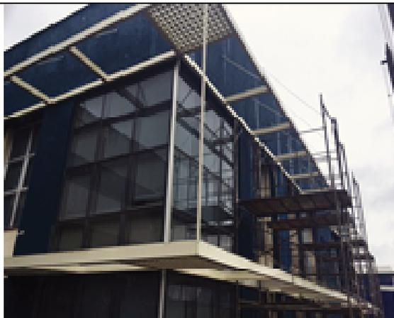
Figura 05: Instalação andaimes- Fachada SUL
