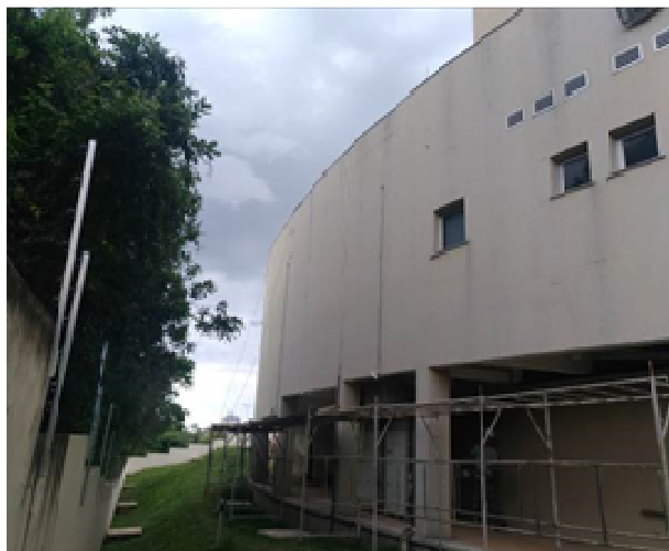
Figura 14: Instalação andaimos- Fachada norte
