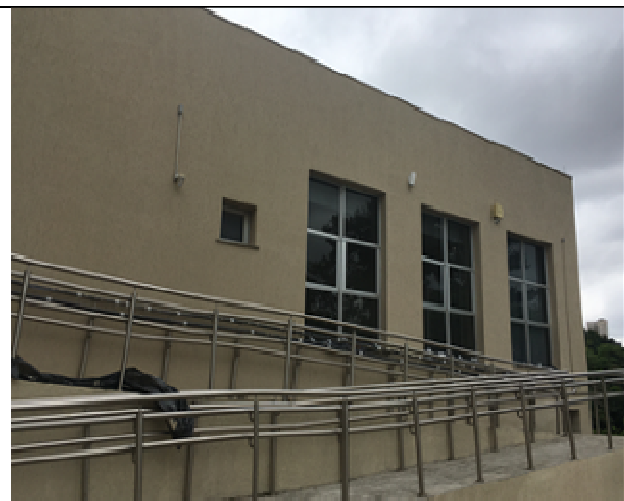
Figura 30: Pintura Fachada Leste
