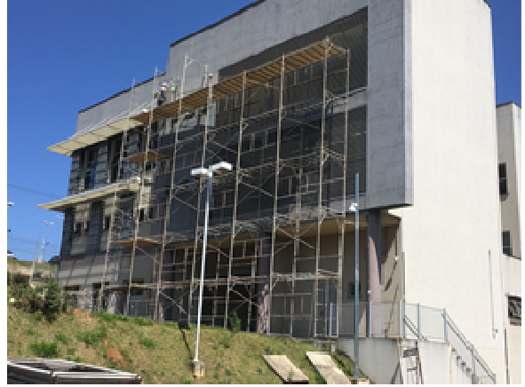
Figura 03: Instalação andaimes- Fachada leste
