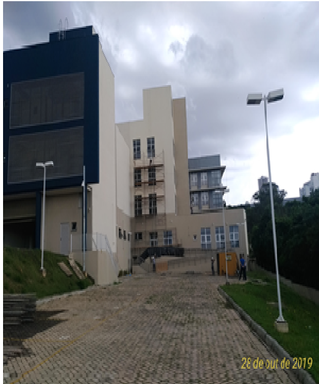
Figura 12. Instalação andaimos- Fachada leste
