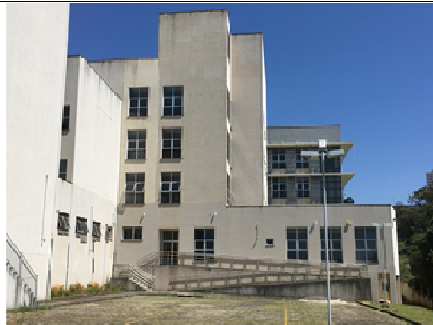
Figura 28. Fachada Leste - ANTES.
