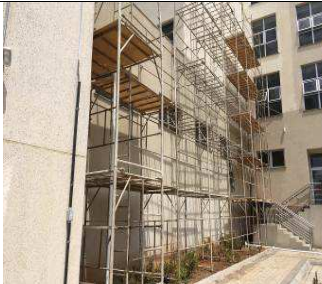
Figura 10: Instalação andaimes- Fachada norte
