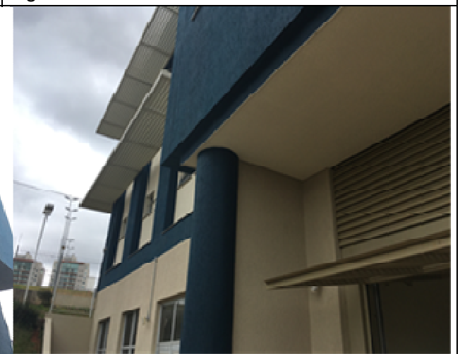
Figura 27: Pintura Fachada Leste
