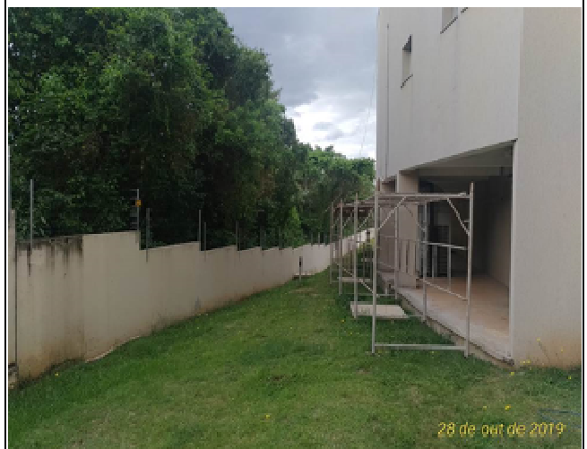
Figura 15: Instalação andaimos- Fachada norte
