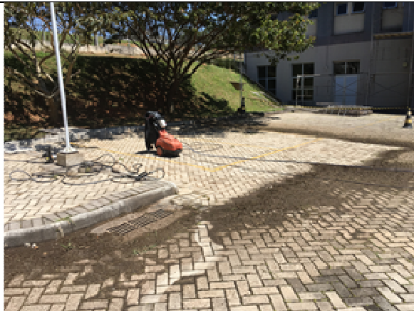
Figura 20. Lavagem de paver.
