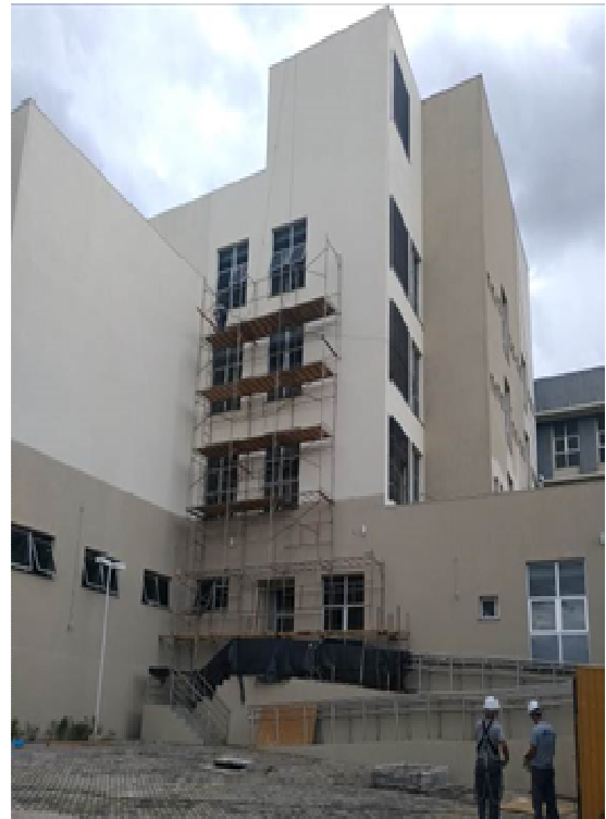
Figura 13: Instalação andaimos- Fachada leste
