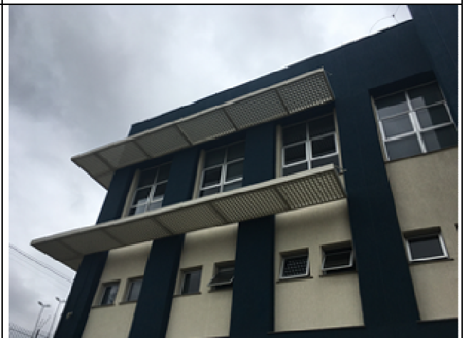
Figura 25: Pintura Fachada Leste
