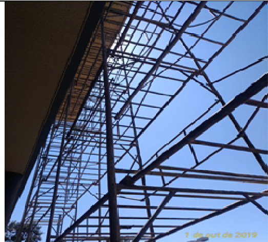
Figura 05: Instalação andaimes- Fachada leste
