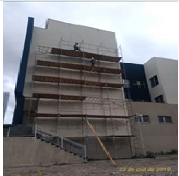
Figura 11: Instalação andaimes- Fachada norte
