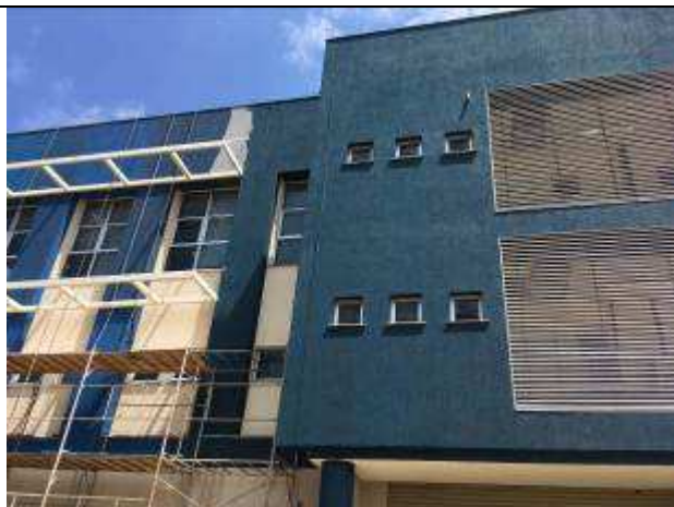
Figura 24: Pintura Fachada Leste
