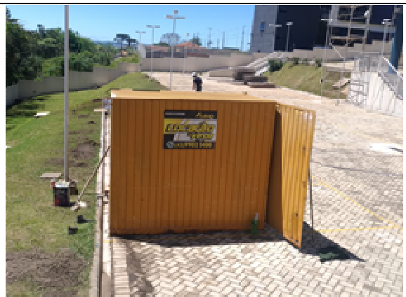
Figura 07: Container para guarda de materiais.
