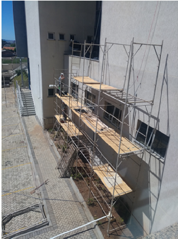
Figura 08: Instalação andaimes- Fachada norte
