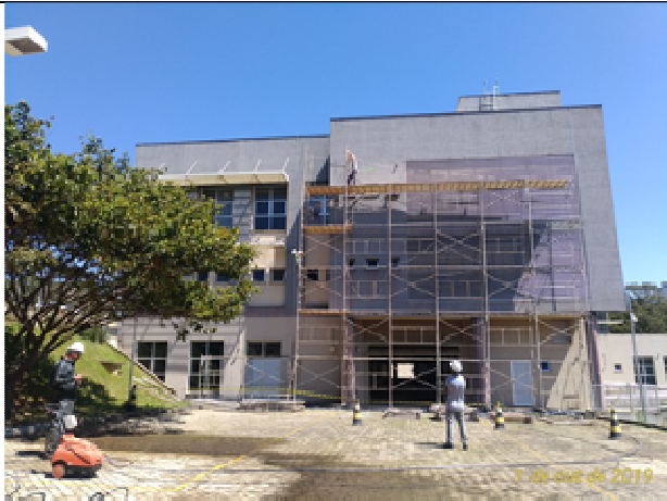
Figura 04: Instalação andaimes- Fachada leste
