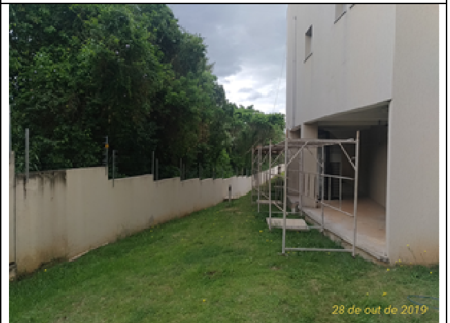
Figura 19: Lavagem de muro e fachada
