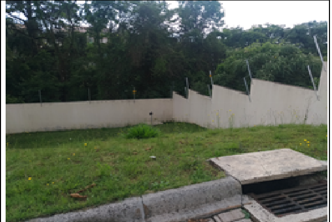
Figura 17: Lavagem de muro.
