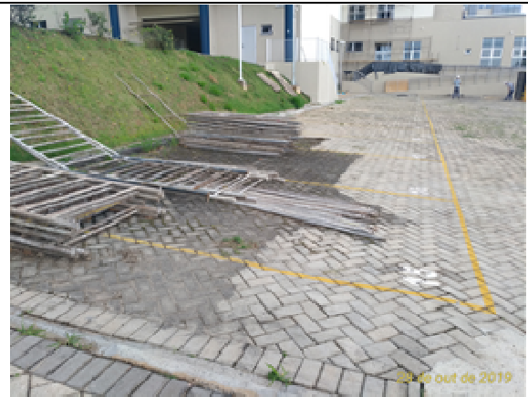
Figura 21: Lavagem de paver.
