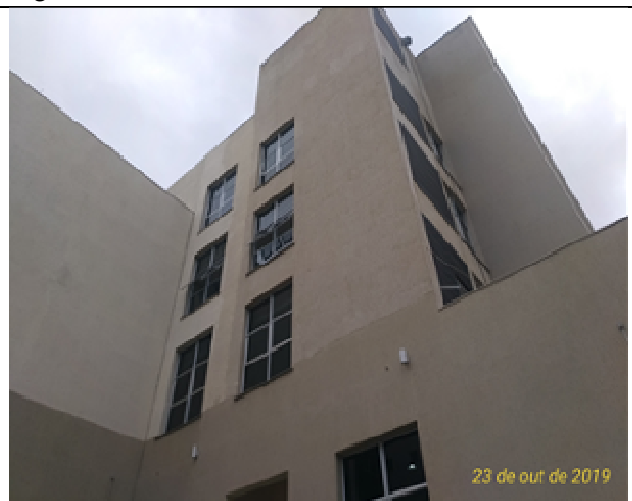
Figura 31: Pintura Fachada Leste
