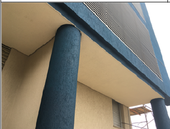
Figura 26. Pintura Fachada Leste
