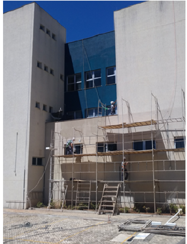
Figura 09: Instalação andaimes- Fachada norte
