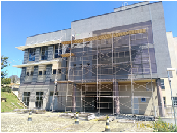
Figura 22. Fachada Leste -ANTES.
