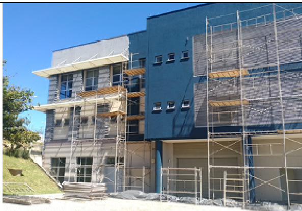
Figura 06: Instalação andaimes- Fachada leste
