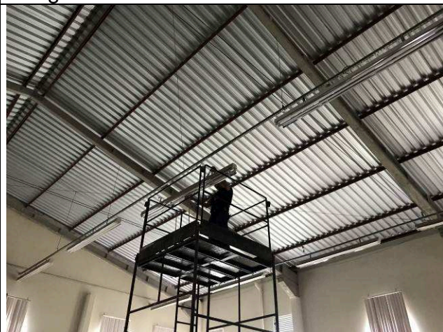
Figura 09C: Retirada das luminárias para limpeza e troca de lâmpadas - Setorial.
