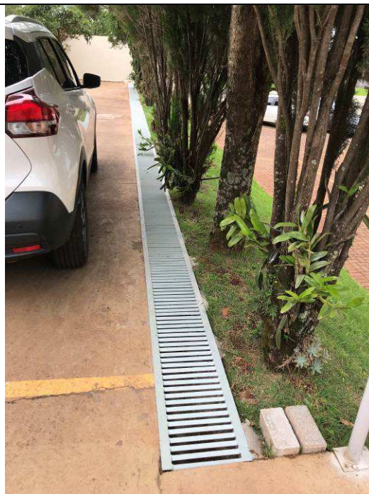
Figura 02C: Grelha Metálica - estacionamento.
