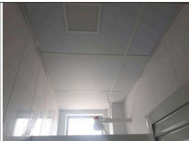
Figura 81C: Instalações elétricas - iluminação e chuveiro vestiários - Setorial
