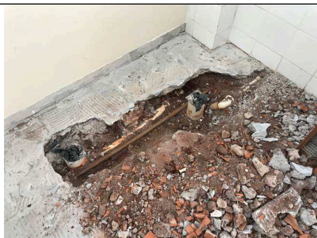
Figura 29C: Demolição de piso para rede hidráulica - VESTIÁRIOS.
