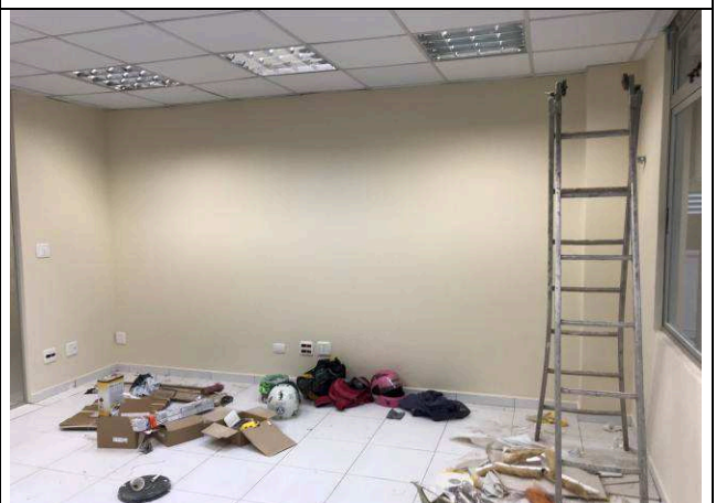
Figura 16C: Pintura das paredes - CEJUSC.
