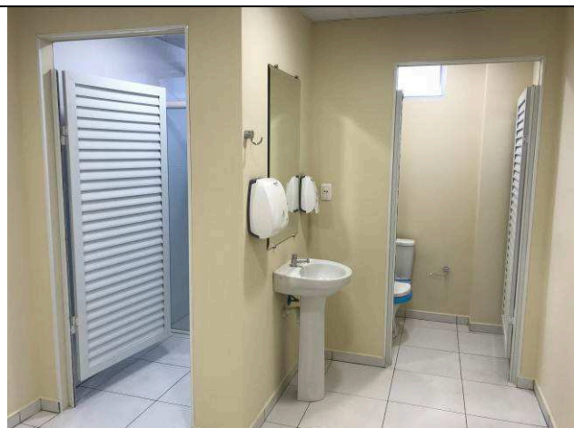
Figura 43C: Lavatório e acessórios - VESTIÁRIO MASCULINO.
