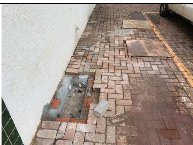
Figura 34C: Caixa de passagem de esgoto - VESTIÁRIOS.
