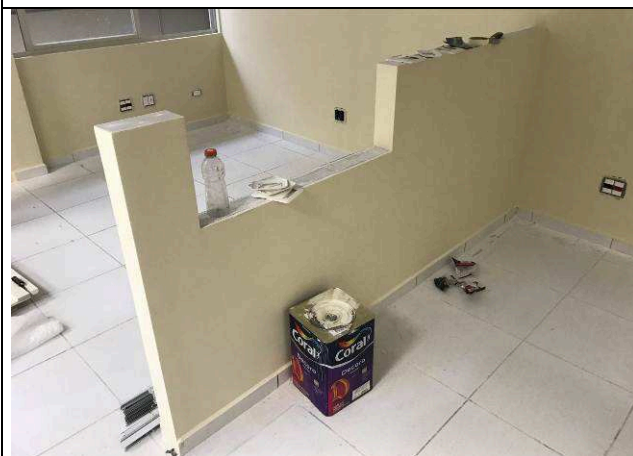
Figura 15C: Execução do balcão de atendimento e pintura - CEJUSC.
