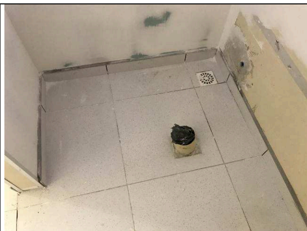
Figura 36C: Pontos de esgoto e água fria executados - VESTIÁRIOS.
