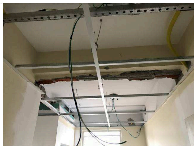
Figura 38C: Montagem de forro - VESTIÁRIOS.
