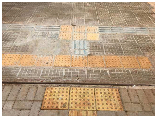
Figura 08C: Piso Tátil - Calçada.
