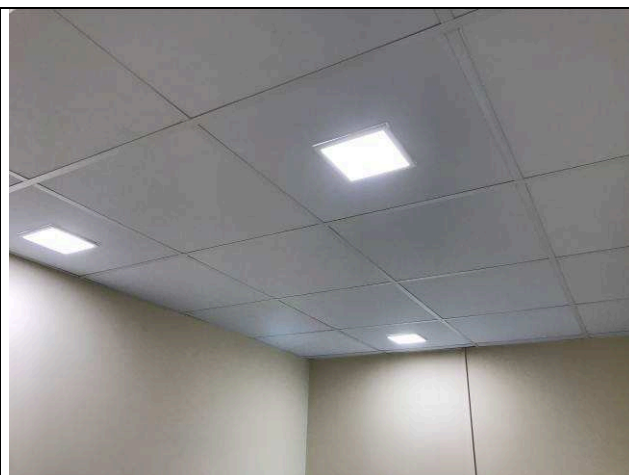
Figura 58C: Forro modular instalado - Escada do Fórum.
