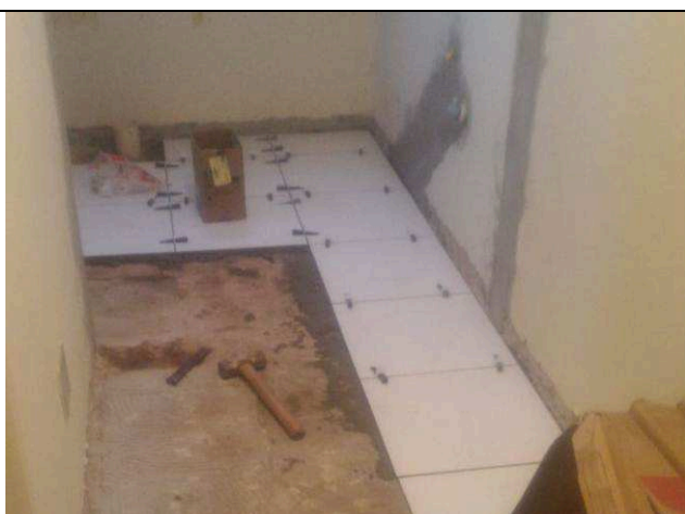
Figura 32C: Instalação do piso cerâmico - VESTIÁRIOS.
