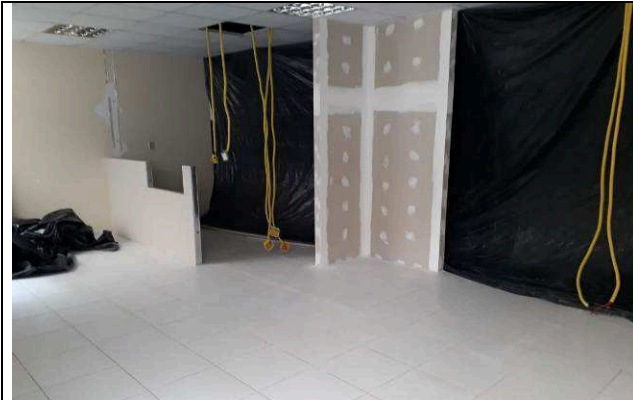
Figura 13C: Execução de paredes de gesso acartonado - CEJUSC.
