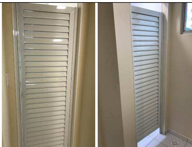
Figura 52C: Portas de alumínio - VESTIÁRIO FEMININO.
