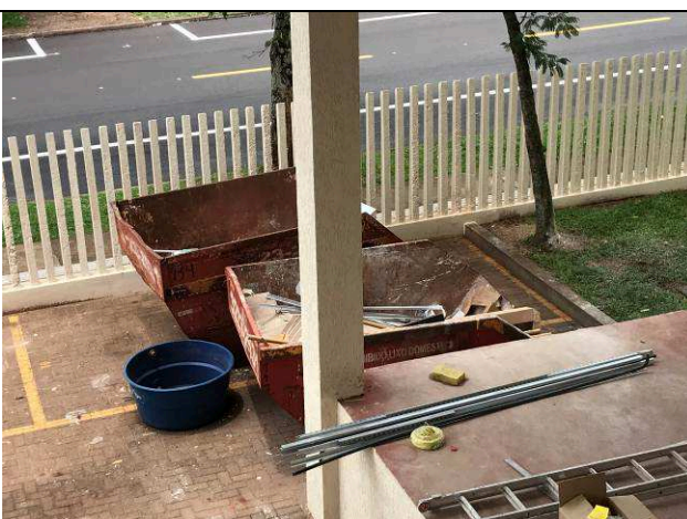
Figura 56C: Caçambas para remoção de entulhos.
