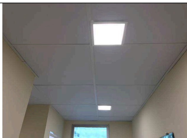
Figura 55C: Forro modular - VESTIÁRIO FEMININO.
