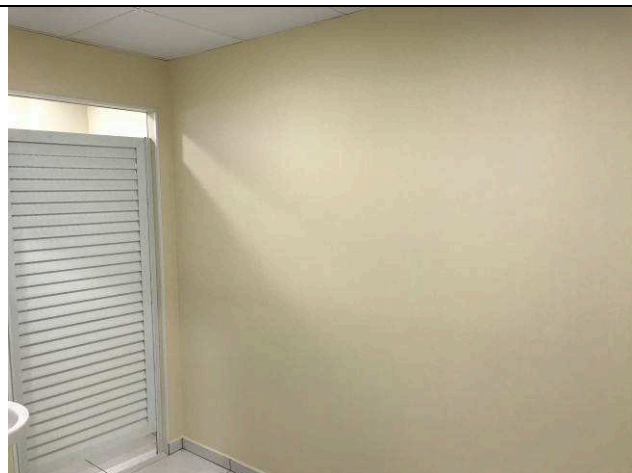
Figura 41C: Pintura das paredes - VESTIÁRIO MASCULINO.
