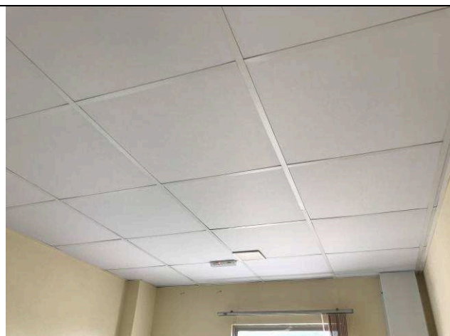
Figura 59C: Forro modular instalado - Escada Setorial.
