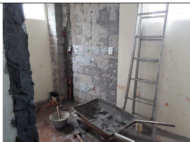
Figura 31C: Execução da rede hidráulica - VESTIÁRIOS.
