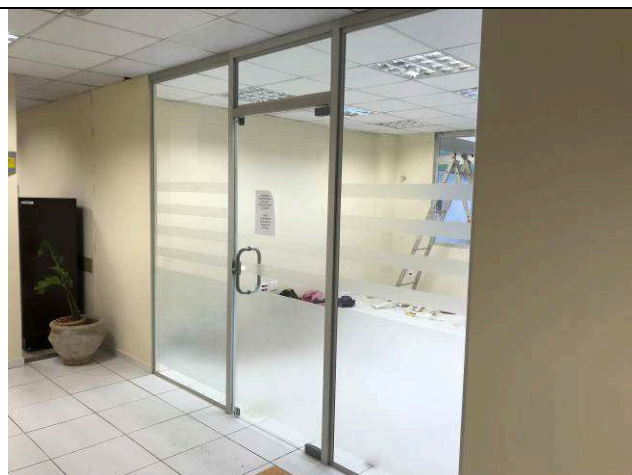
Figura 23C: Esquadria de vidro temperado realocada e reinstalada - CEJUSC.
