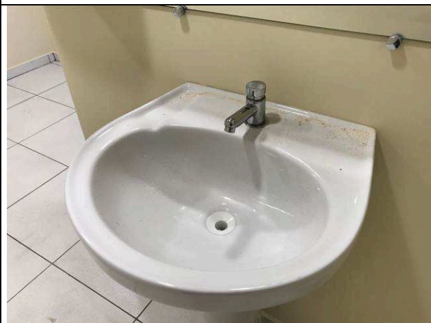
Figura 44C: Lavatório - VESTIÁRIO MASCULINO.
