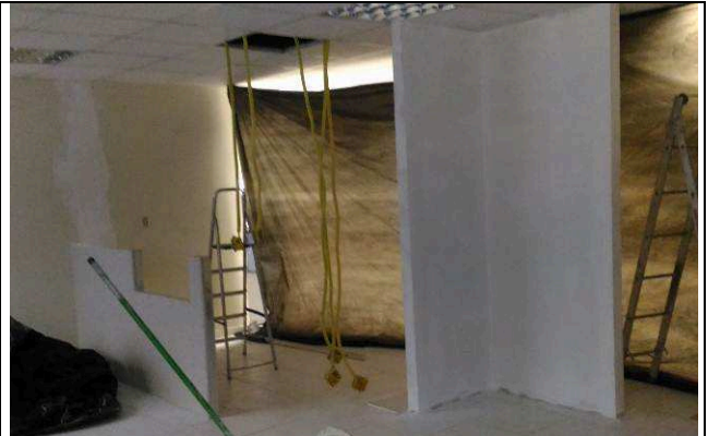
Figura 14C: Emassamento das paredes e instalações elétricas - CEJUSC.
