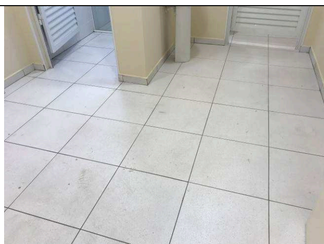
Figura 39C: Piso cerâmico - VESTIÁRIOS.
