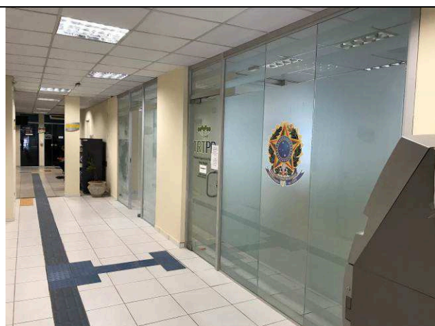
Figura 25C: Esquadrias de vidro temperado realocadas e reinstaladas - CEJUSC.
