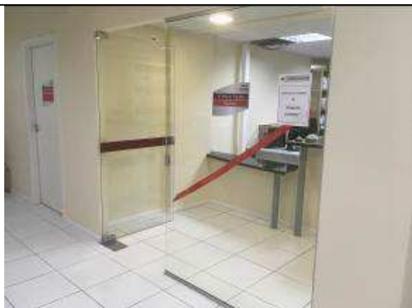
Figura 17C - porta vidro temperado - painéis fixos - 13ª VT
