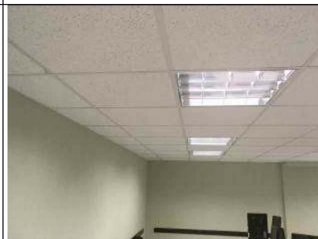
Figura 20C - forro acústico - 13ª VT
