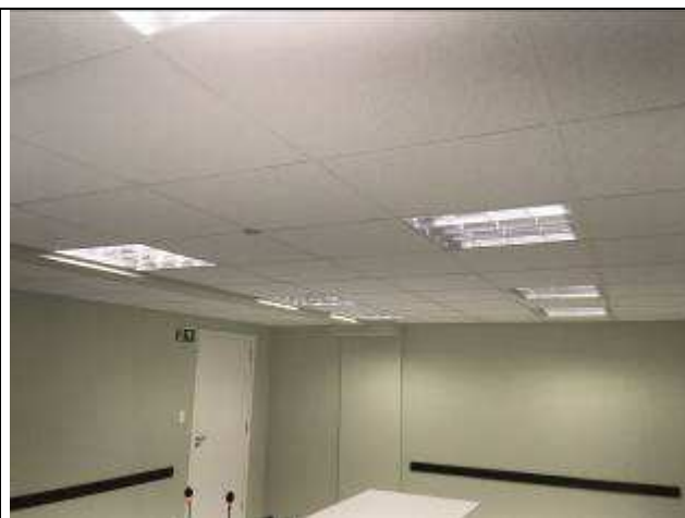
Figura 22C - forro acústico - 15ª VT
