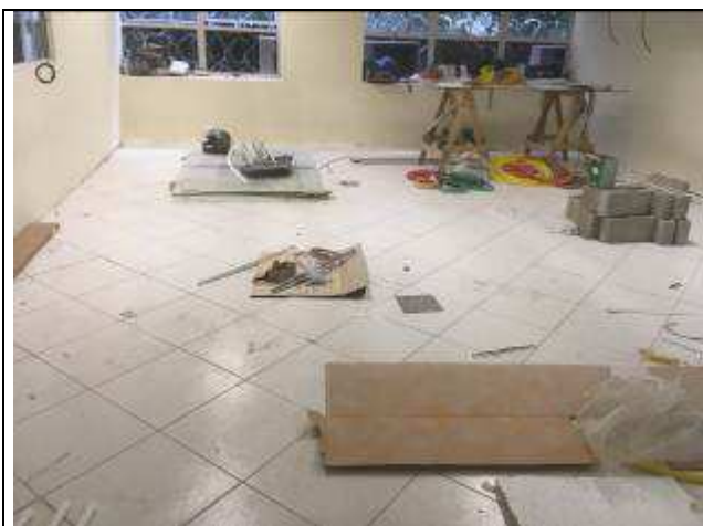
Figura 1C - piso cerâmico - 16ª VT
