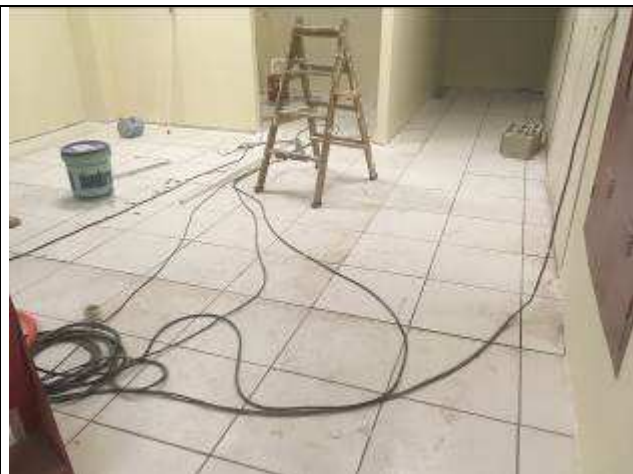
Figura 3C - piso cerâmico - 16ª VT
