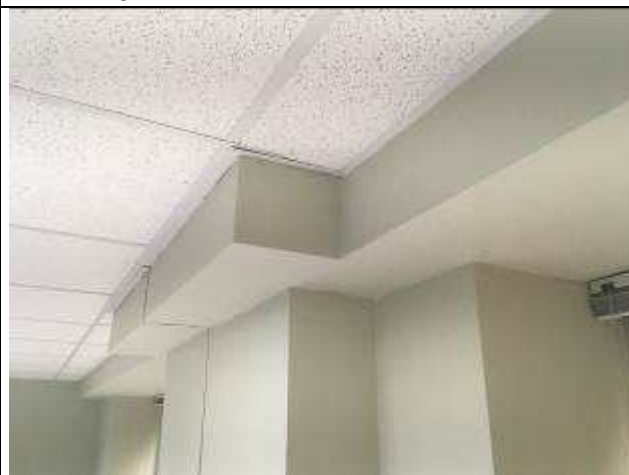
Figura 24C - envelopamento redes frigorígenas - 15ª VT
