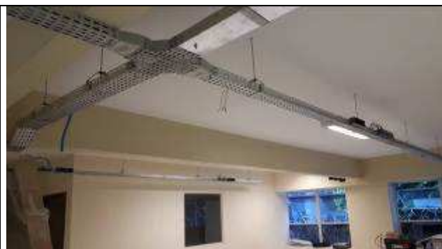
Figura 01E - infraestrutura 16ª VT
