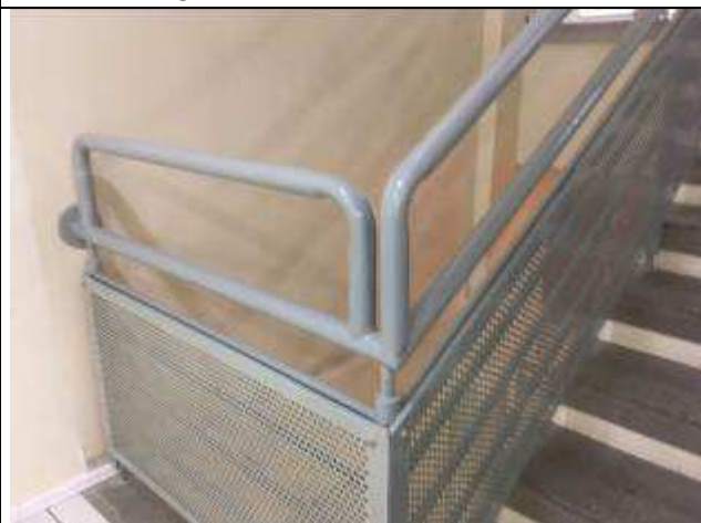
Figura 31C - pintura guarda-corpo - escada
