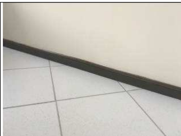
Figura 16C - pintura rodapés - 14ª VT
