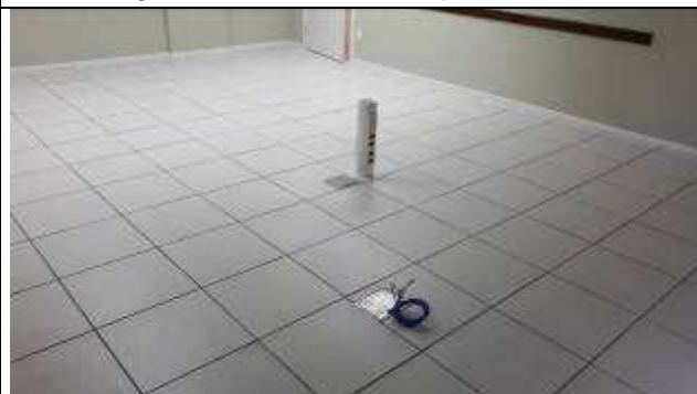
Figura 24E - instalações sala audiências 15ª VT
