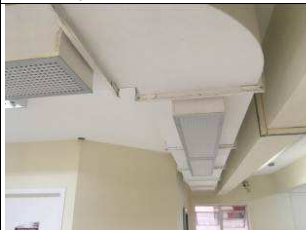
Figura 32C - pintura dutos de insuflamento e exaustão
