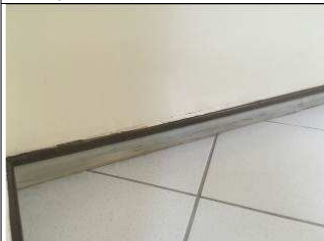
Figura 35C - pintura rodapés - 13ª VT
