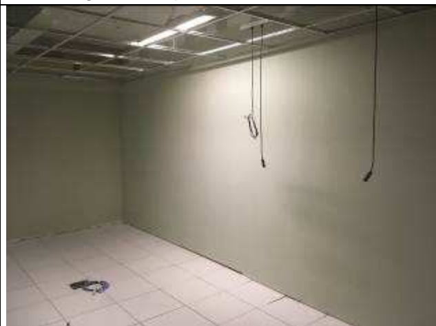
Figura 5C - paredes dry-wall - 16ª VT
