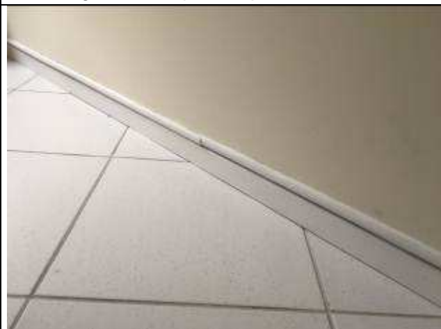
Figura 36C - pintura rodapés - 15ª VT
