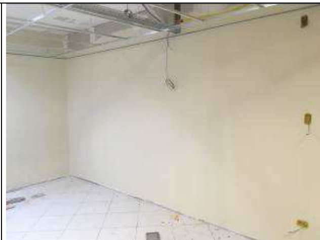
Figura 4C - paredes dry-wall - 16ª VT
