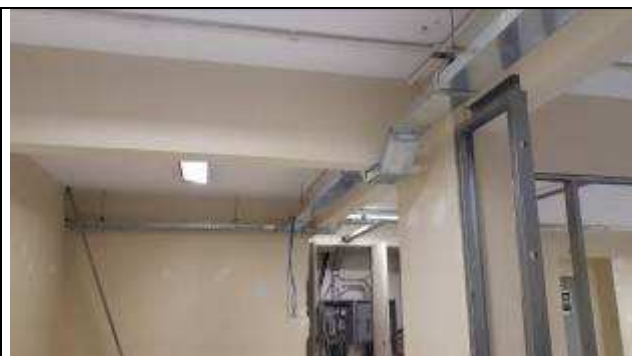
Figura 02E - infraestrutura 16ª VT
