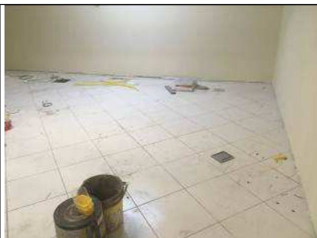
Figura 2C - piso cerâmico - 16ª VT
