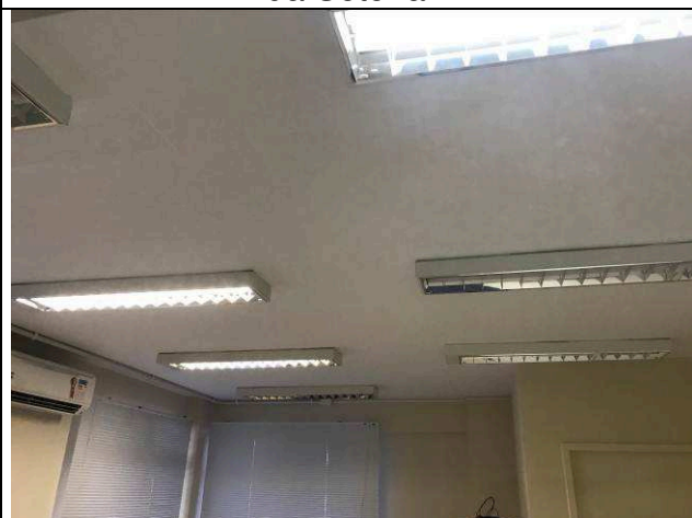
Figura 94C: Pintura interna - Laje do térreo da Setorial.
