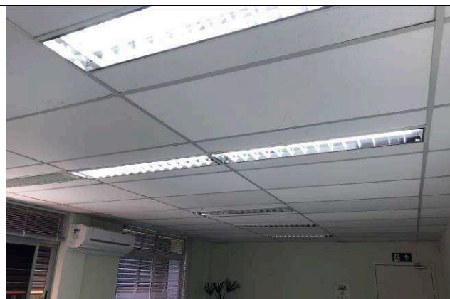
Figura 41C: Substituição de placas de forro - sala de audiências da 4ª Vara.
