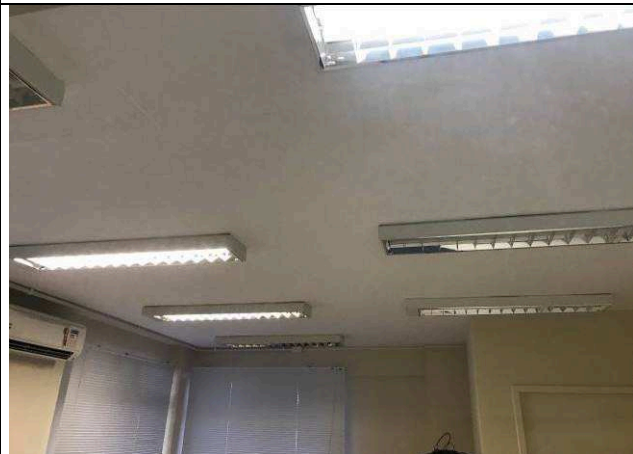
Figura 14E: substituição lâmpadas
