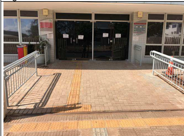
Figura 117C: Rampa de entrada.
