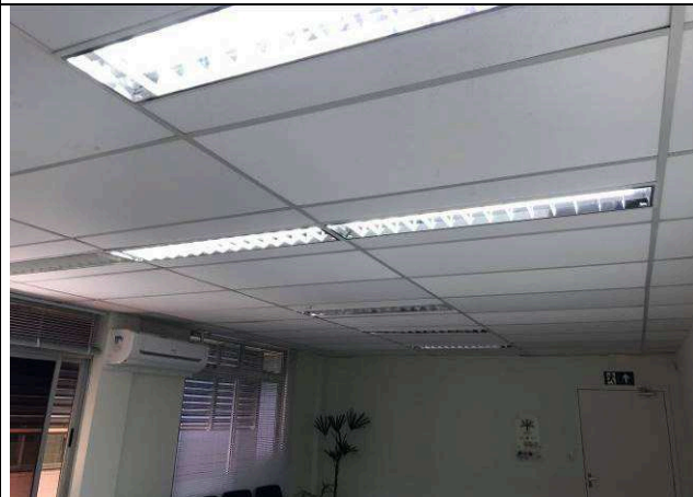
Figura 13E: substituição lâmpadas
