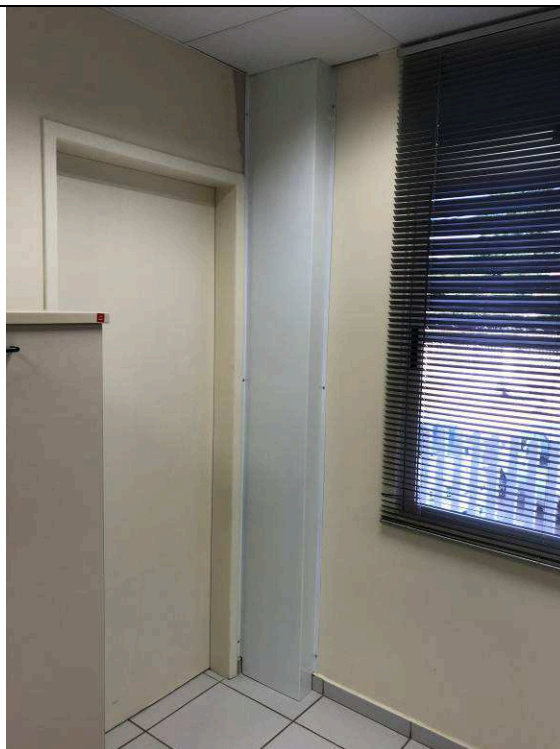
Figura 112C: Shaft 1ª Vara - Fechamento das tubulações da rede frigorígena.
