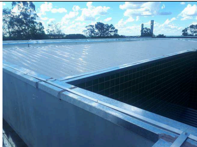
Figura 19E: SPDA edificação principal
