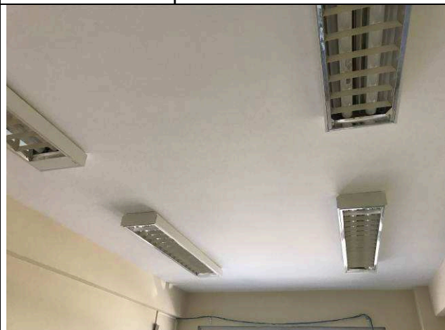
Figura 91C: Pintura interna - Laje do térreo da Setorial.
