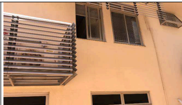
Figura 104C: Rede frigorígena nova e condensadora - site.
