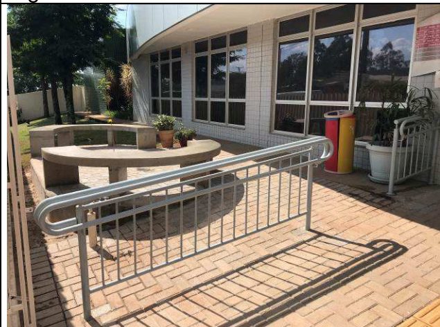
Figura 118C: Pavimentação intertravada - entrada principal.
