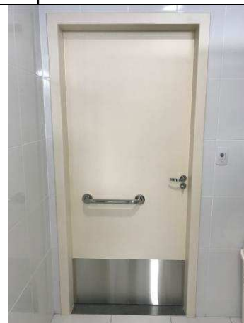
Figura 80C: Porta de madeira - banheiro público feminino.
