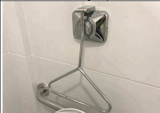
Figura 10C: Barra de acionamento válvula de descarga - BWC PNE público masculino.
