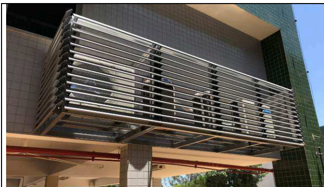
Figura 103C: Rede frigorígena nova e condensadoras - 4ª Vara.
