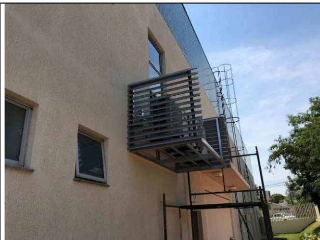
Figura 108C: Rede frigorígena nova e condensadoras - Setorial.
