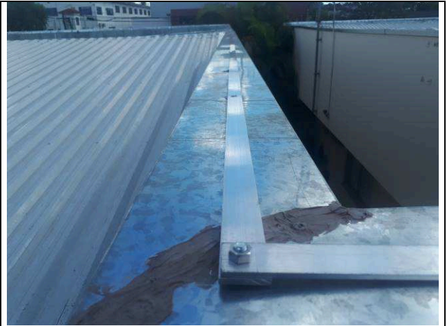
Figura 18E: SPDA edificação principal
