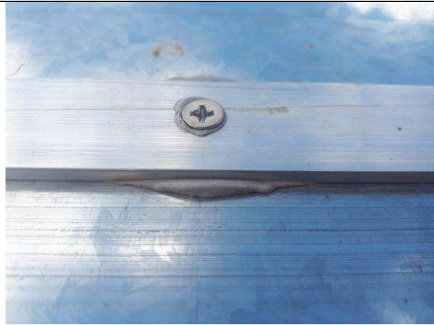
Figura 17E: SPDA edificação principal
