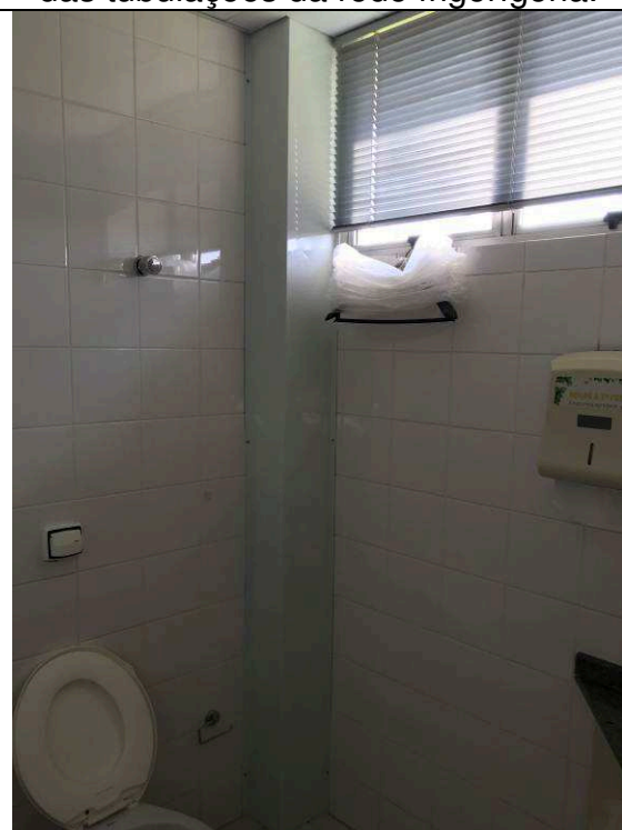
Figura 114C: Shaft 2ª Vara - Fechamento das tubulações da rede frigorígena.
