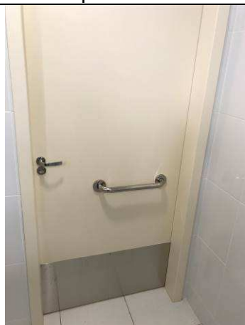
Figura 79C: Porta de madeira - banheiro público masculino PNE.
