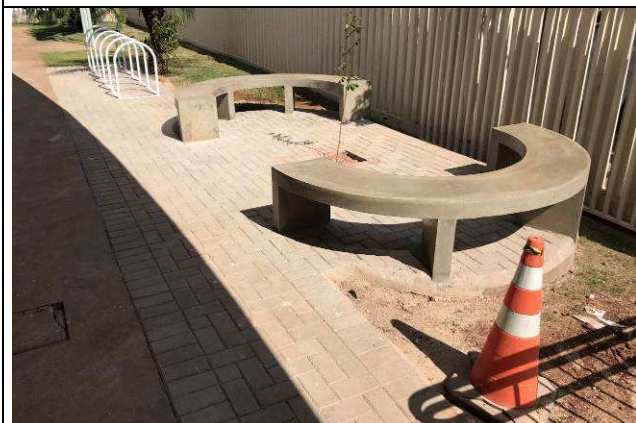
Figura 119C: Pavimentação intertravada - entrada principal.
