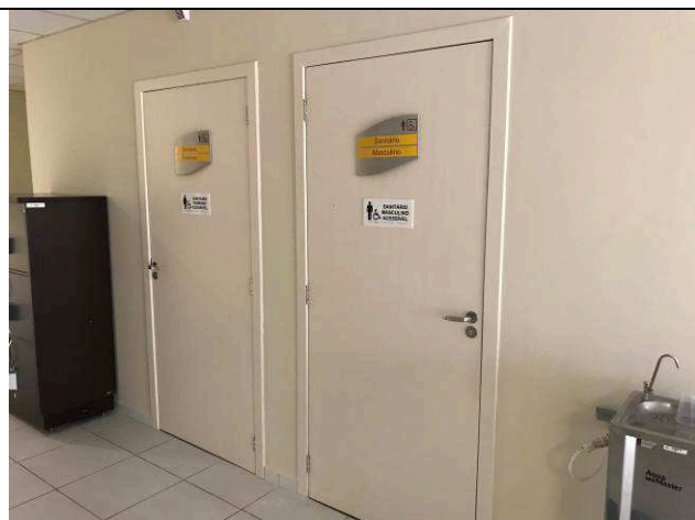
Figura 77C: Portas de madeira - banheiros públicos.
