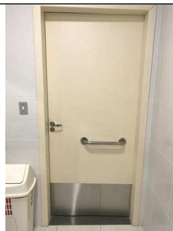
Figura 78C: Porta de madeira - banheiro público masculino.
