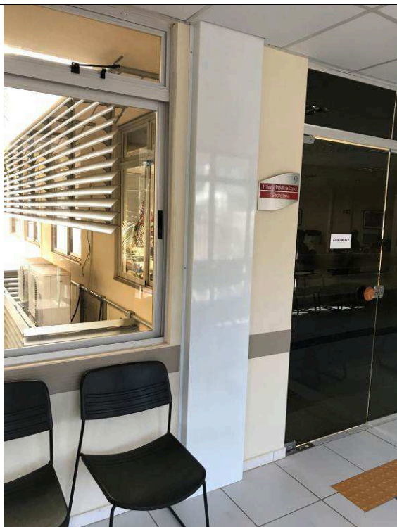
Figura 111C: Shaft 1ª Vara - Fechamento das tubulações da rede frigorígena.
