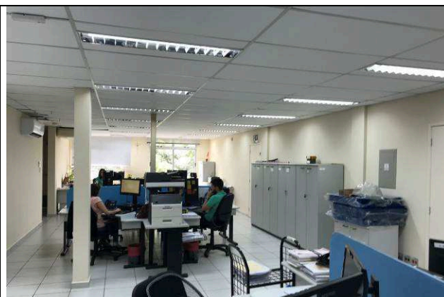
Figura 42C: Substituição de placas de forro - secretaria da 3ª Vara.
