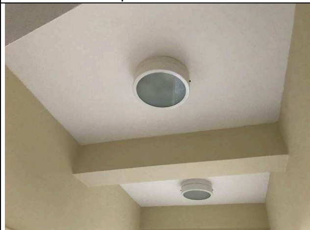
Figura 92C: Pintura interna - Laje do térreo da Setorial.
