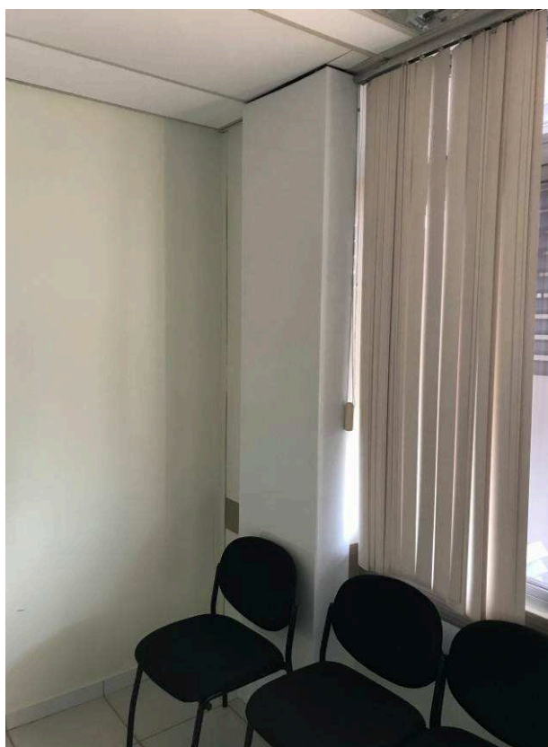
Figura 109C: Shaft - Fechamento das tubulações da rede frigorígena.
