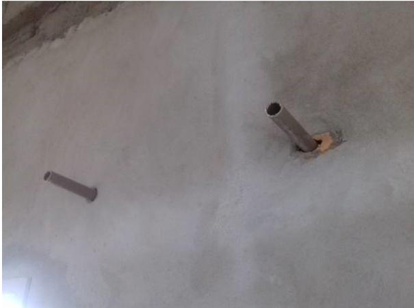
Figura 58C: Sistema de drenagem dos aparelhos de ar condicionado - ramais de coleta
