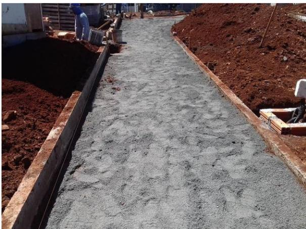
Figura 68C: Guia de travamento da calçada e meio-fio do estacionamento, já executados na parte frontal do imóvel - entrada de pedestres e de veículos
