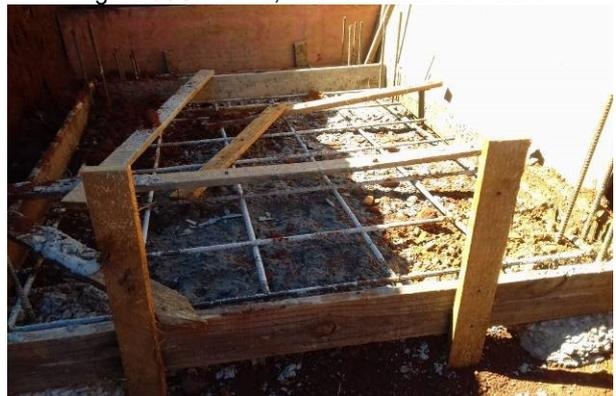
Figura 51C: Armadura da laje do filtro
