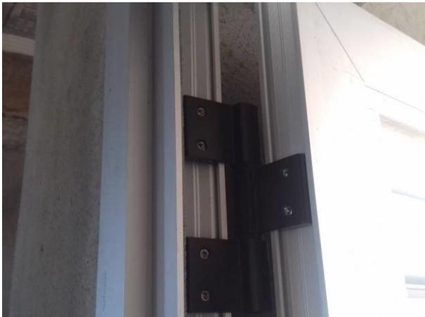
Figura 03C: Detalhe de dobradiça de porta de alumínio
