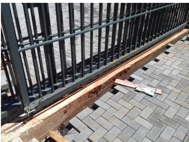
Figura 74C: Detalhe do sistema de movimentação (trilho e corrente) do portão
