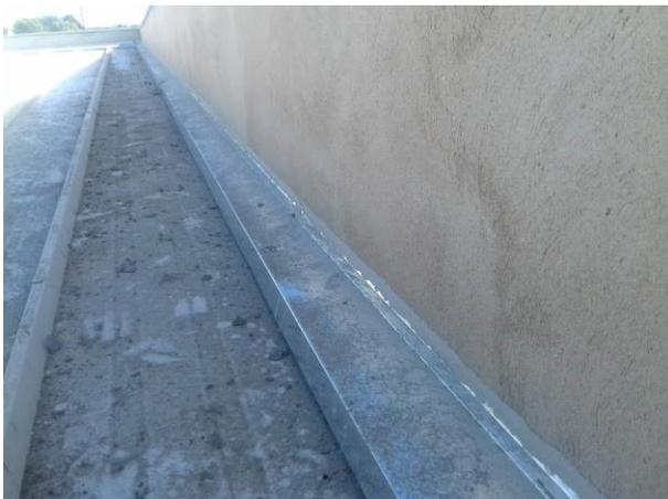
Figura 32C: Detalhe de rufo longitudinal e seu acoplamento com platibanda e telha
