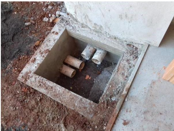
Figura 54C: Caixa de inspeção de esgoto - Parte frontal do imóvel
