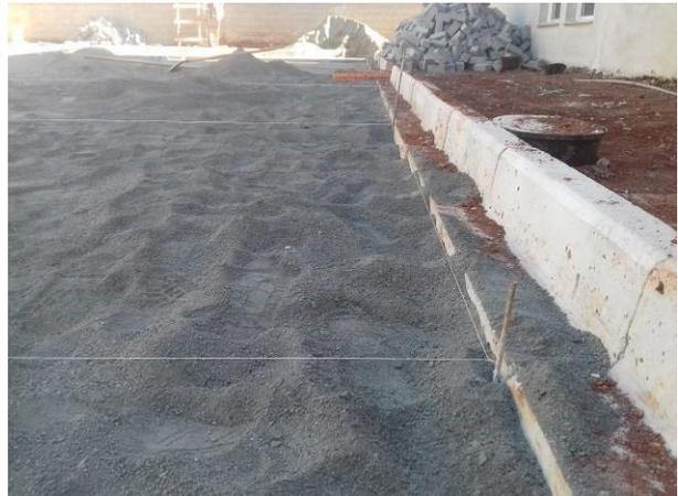
Figura 61C: Detalhe de meio-fio pré-moldado, instalado na área do estacionamento
