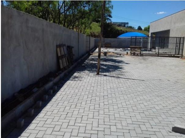
Figura 64C: Paver e meio-fio, já instalados no estacionamento público
