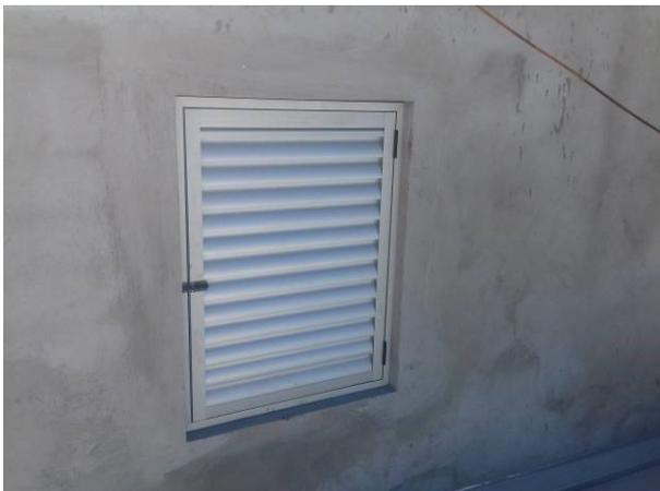
Figura 05C: Porta de alumínio 80x105cm, instalada no reservatório
