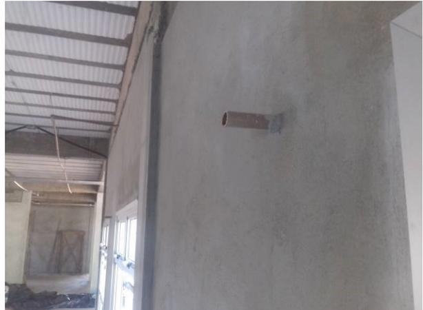
Figura 59C: Sistema de drenagem dos aparelhos de ar condicionado - ramais de coleta
