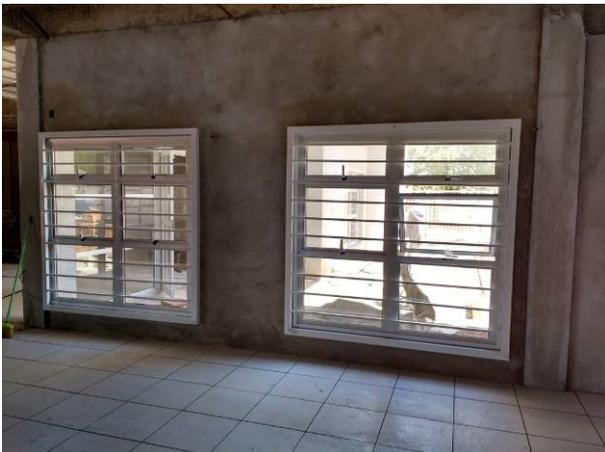
Figura 15C: Gradis de proteção das janelas de 180x180cm - Sala de conciliação 1)
