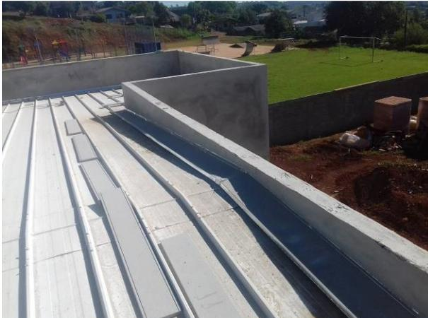
Figura 30C: Rufo longitudinal, instalado junto ao oitão da direita
