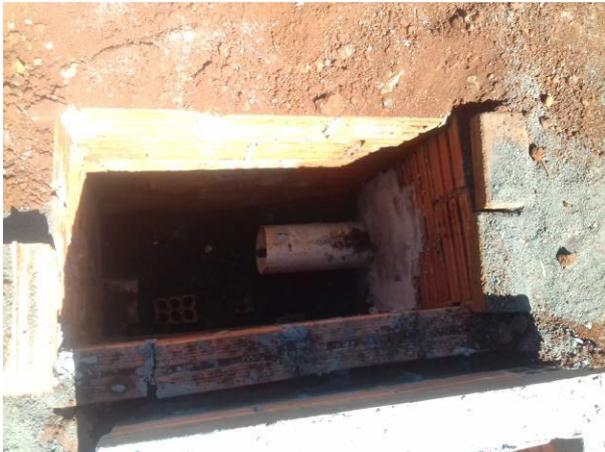
Figura 47C: Boca-de-lobo, executada no estacionamento público
