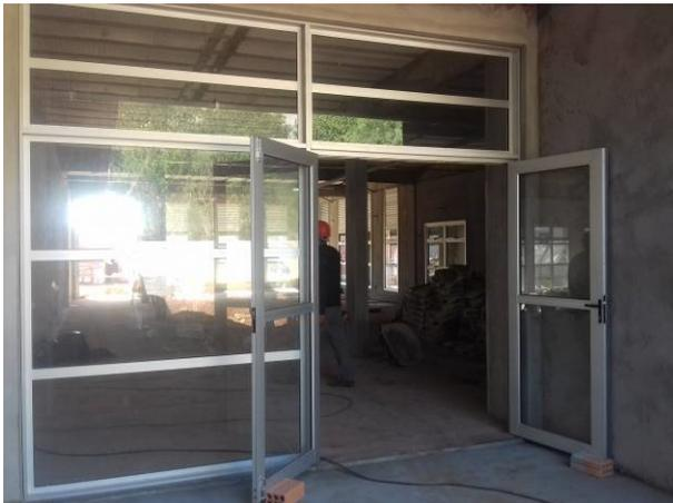
Figura 11C: Porta dupla de alumínio e vidro temperado, tamanho 180x210 mais bandeiras fixas superiores e laterais - saída "Hall público externo 2" - no detalhe todo o conjunto de folhas, bandeiras e caixilhos fixos laterais
