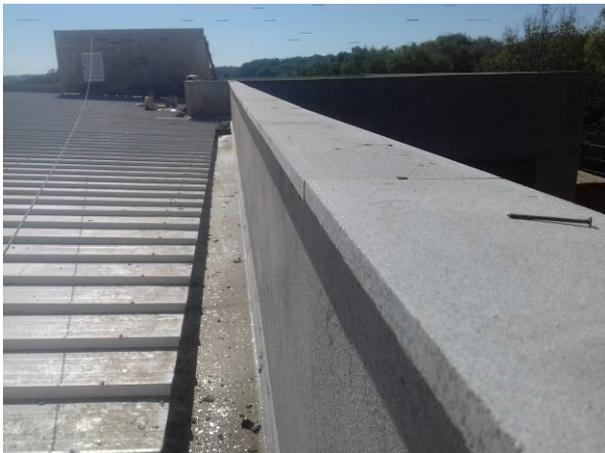
Figura 26C: Copeamento de platibanda - platibanda divisora de águas
