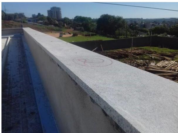
Figura 22C: Capeamento de platibanda - lateral direita
