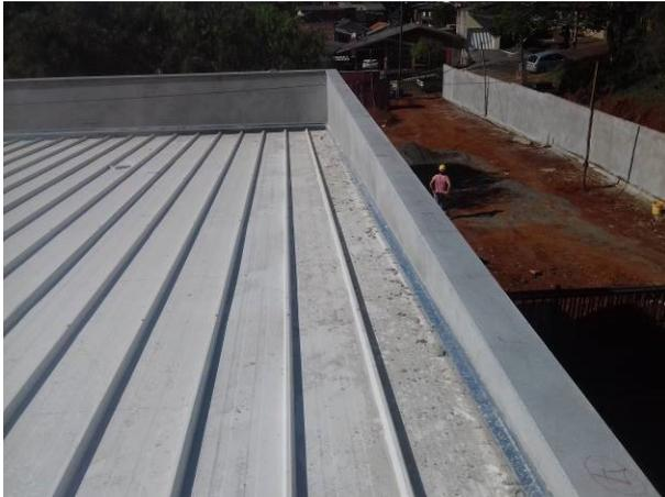
Figura 24C: Copeamento de platibanda - lateral esquerda
