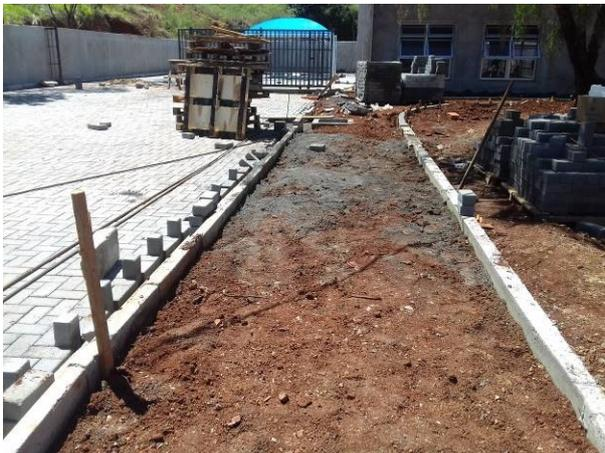
Figura 66C: Guia de travamento da calçada, já executada na parte frontal do imóvel - entrada de pedestres
