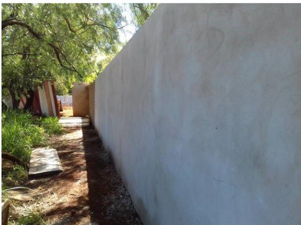
Figura 80C: Rebôco externo do muro frontal
