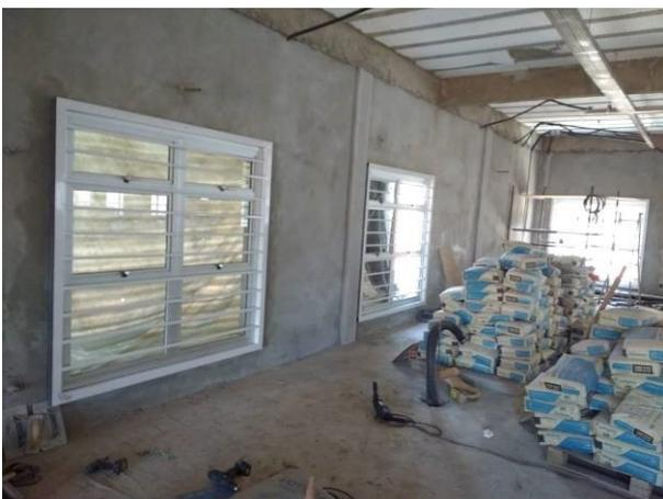
Figura 17C: Gradis de proteção das janelas de 180x180cm - OAB e PAB)
