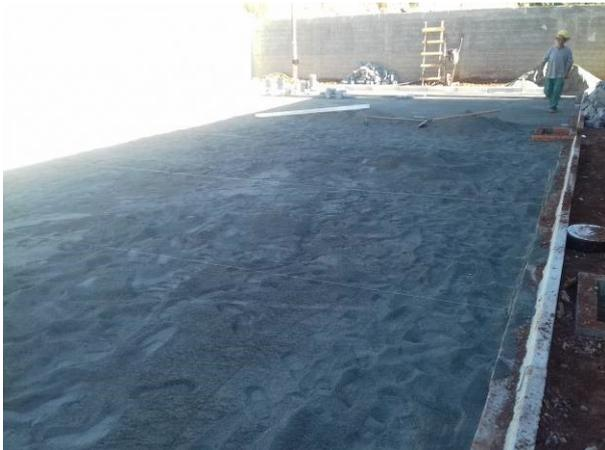
Figura 60C: Preparo da camada de pó de pedra, para assentamento do paver, no estacionamento
