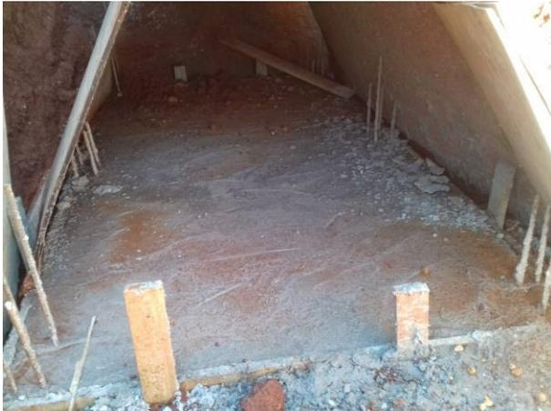
Figura 52C: Laje da fossa séptica, já concretada
