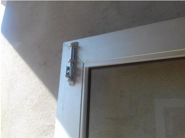
Figura 13C: Detalhe de tranca de teto de porta de alumínio com vidro temperado de 8mm (Hall público externo 2 e 3)
