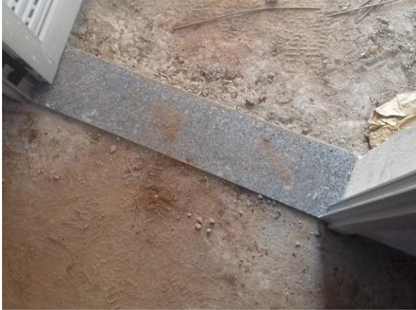
Figura 44C: Soleira em granito cinza andorinha, instalada sob a porta do hall de serviço - lateral direita
