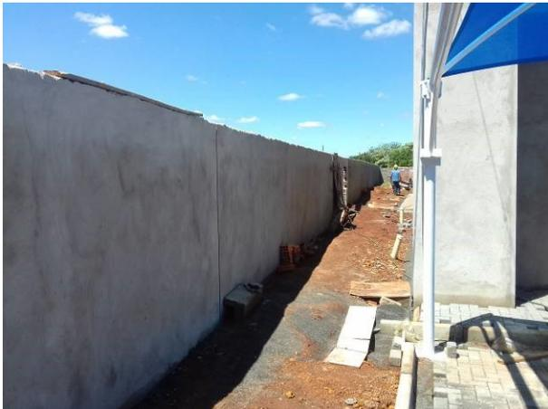
Figura 78C: Rebôco interno do muro dos fundos
