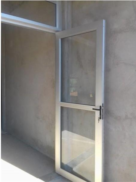
Figura 09C: Porta dupla de alumínio e vidro temperado, tamanho 180x210 - detalhe de uma das folhas
