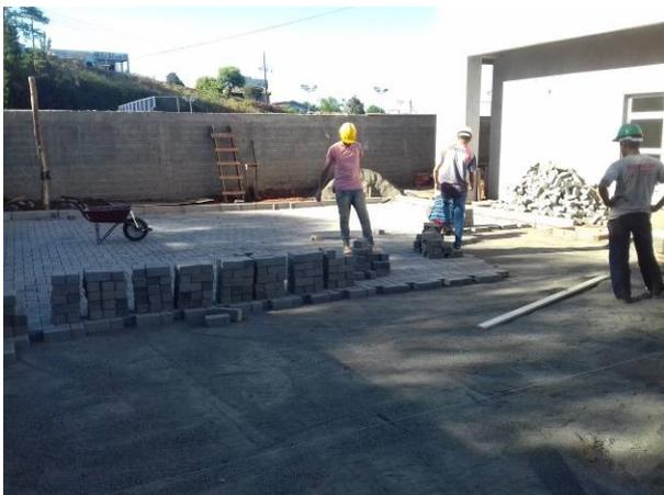
Figura 62C: Início da instalação do paver do estacionamento privativo
