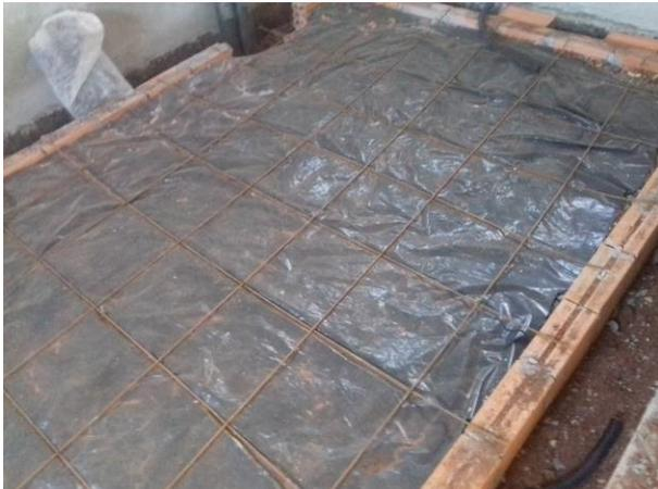
Figura 38C: Aplicação de tela soldada para execução do contrapiso - sala técnica
