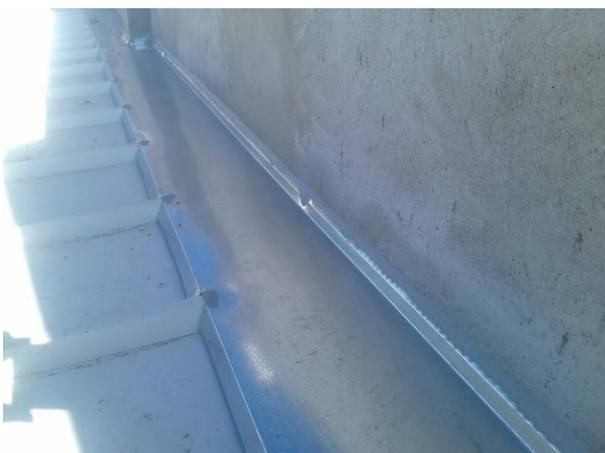
Figura 28C: Rufo transversal, instalado junto a platibanda divisora de água
