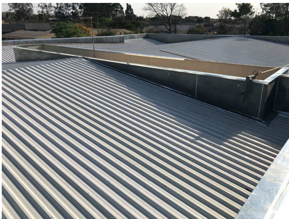
Figura 1 – Cobertura - Hall Central e 2ª Vara do Trabalho.
