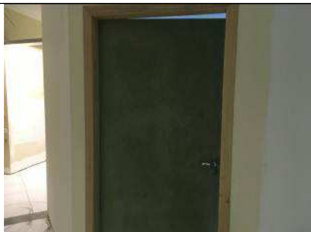
Figura 29C - Porta acústica - sala de audiências - 13ª VT
