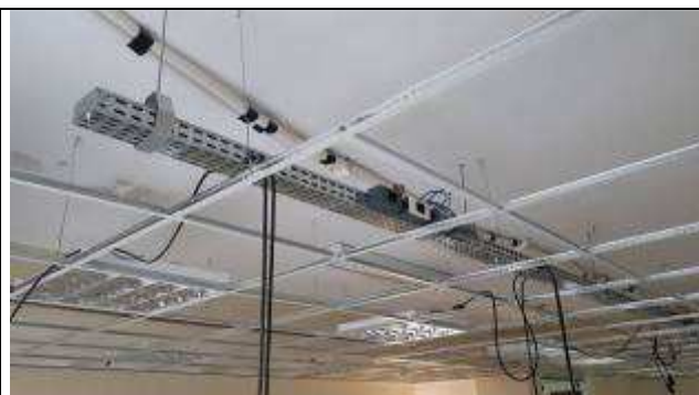
Figura 20E - infraestrutura 13ª e 15ª VT
