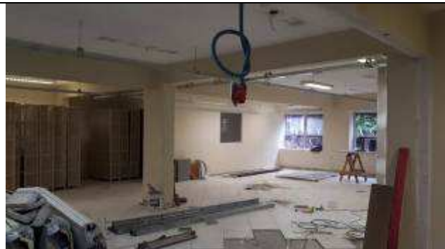
Figura 01E - retirada instalações 16ª VT
