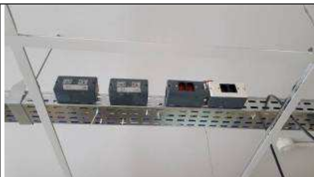
Figura 19E - infraestrutura 13ª e 15ª VT
