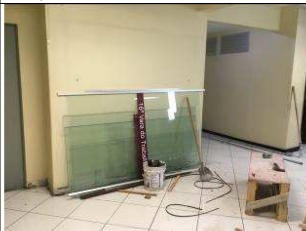
Figura 6C - retirada de esquadrias - 16ª VT
