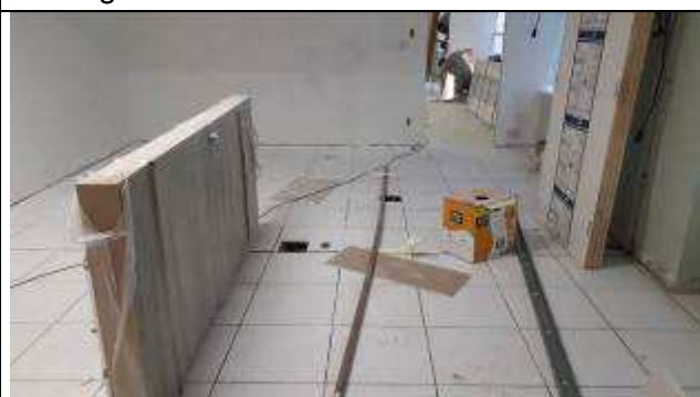
Figura 22E - caixas de piso
