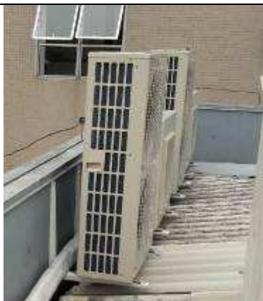
Figura 1C - mãos francesas para suporte das condensadoras
