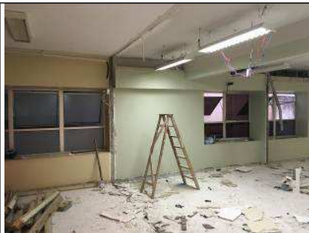
Figura 4C - retirada de divisórias - 16ª VT
