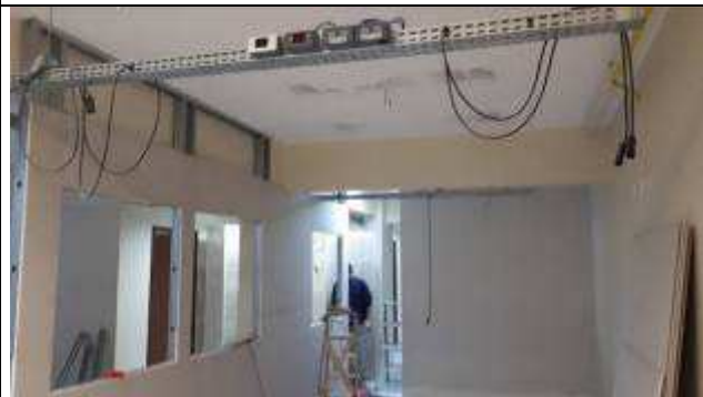
Figura 26E - instalações lógicas 13ª e 15ª VT
