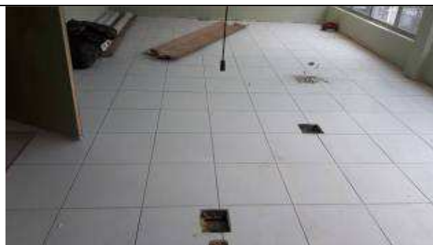
Figura 07E - caixas de piso
