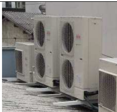
Figura 2C - mãos francesas para suporte das condensadoras
