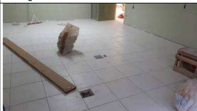
Figura 21E - caixas de piso
