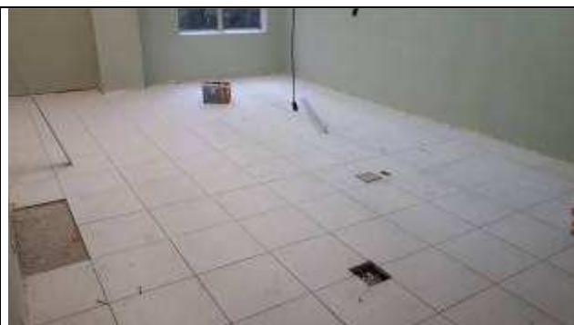
Figura 08E - caixas de piso
