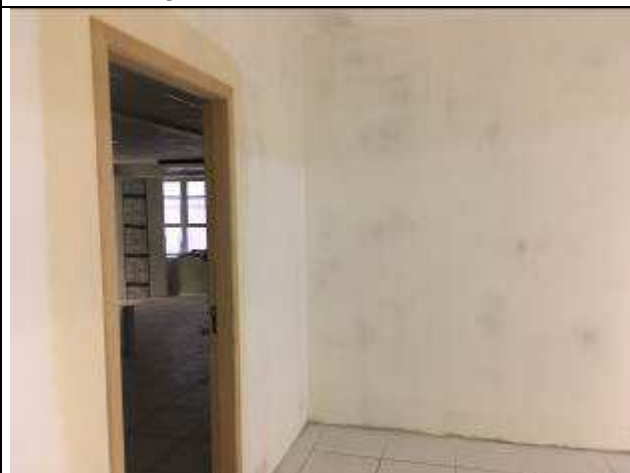
Figura 36C - fundo selador e massa PVA - paredes - 15ª VT
