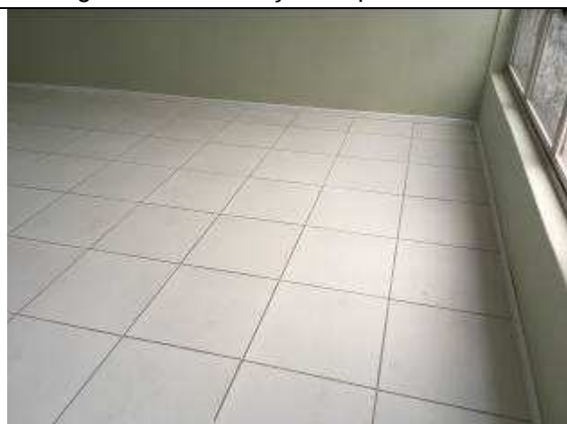
Figura 7C - pisos cerâmicos instalados - 14ª VT
