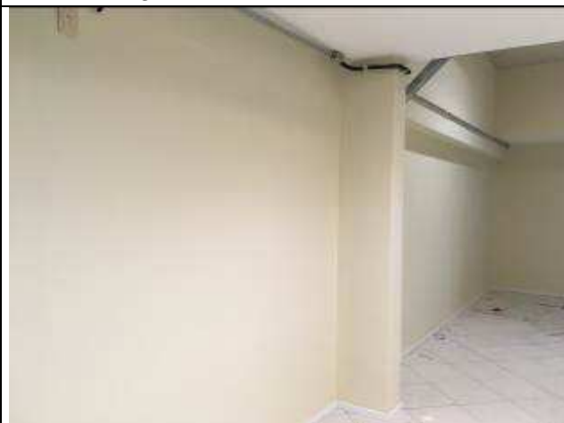
Figura 18C - pintura - hall público - 14ª VT
