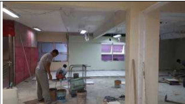
Figura 02E - retirada instalações 16ª VT
