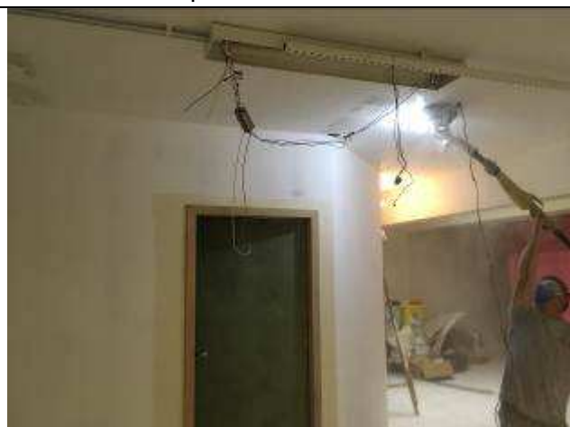
Figura 37C - fundo selador e massa PVA - hall público - 13ª e 15ª VTs
