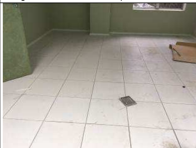
Figura 8C - pisos cerâmicos instalados - 14ª VT
