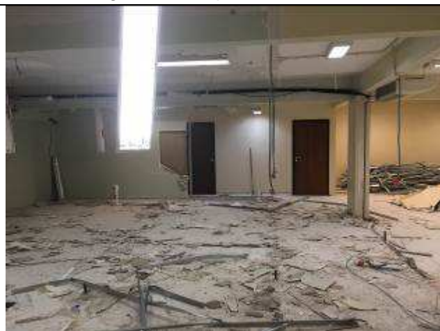
Figura 5C - demolição de pisos - 16ª VT
