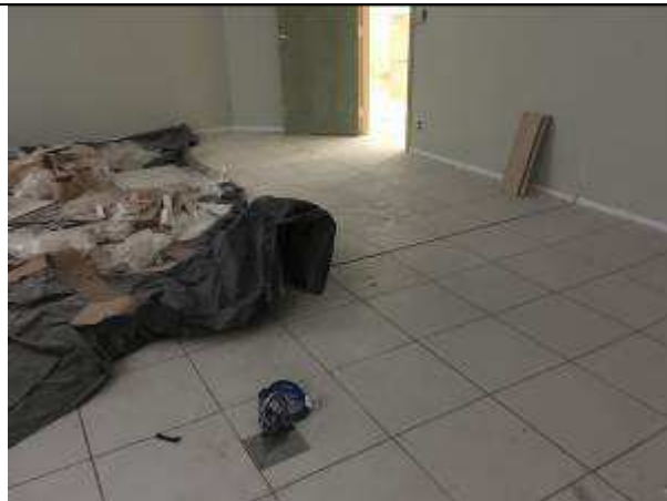
Figura 22C - piso cerâmico - 15ª VT
