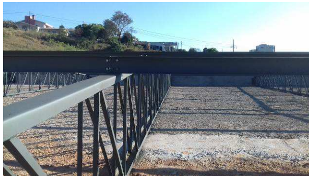
Figura 104C: Pintura da estrutura metálica de cobertura
