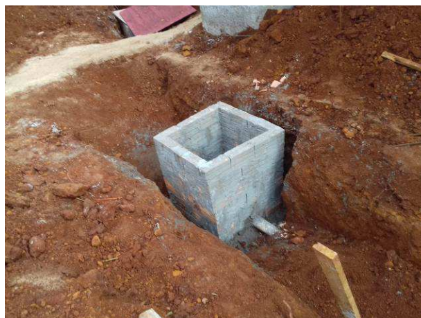
Figura 98C: Caixa de inspeção (pluvial) executada na lateral direita
