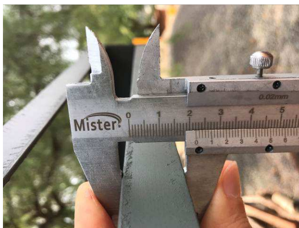
Figura 26C: Aferição da aba de cantoneira componente de diagonal
