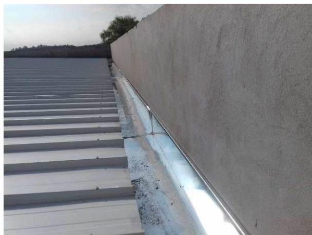
Figura 36C: Calhas em chapa galvanizada #24 instaladas na cobertura do arquivo e PAB
