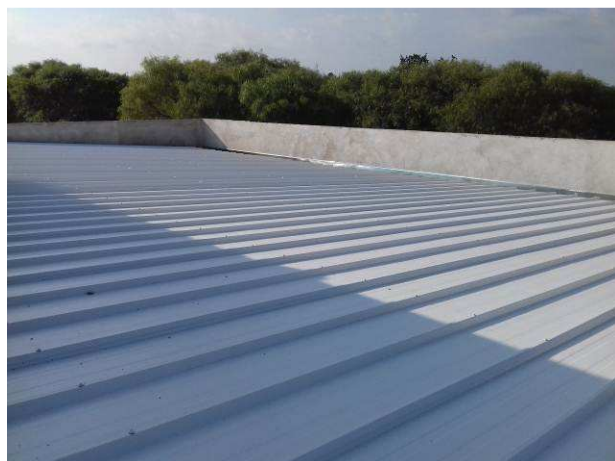
Figura 29C: Telhas metálicas instaladas sobre o arquivo
