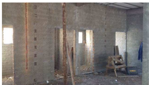
Figura 42C: Chapisco executado em paredes na região dos sanitários públicos
