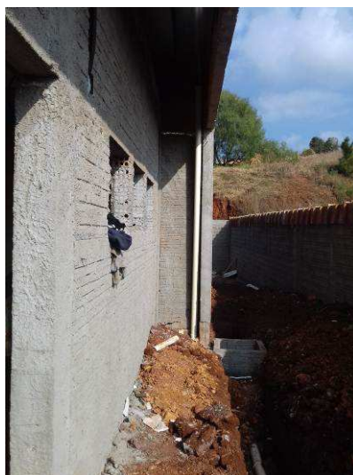
Figura 89C: Tubo de queda de 100mm - fundos com lateral esquerda
