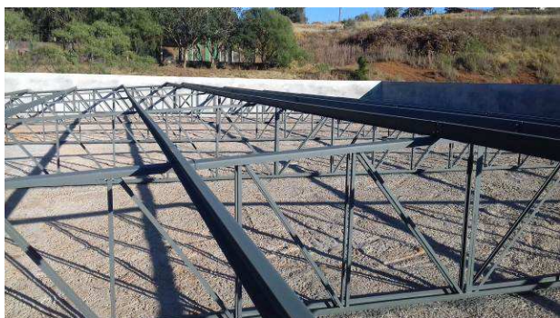
Figura 19C: Estrutura metálica de cobertura - Tesouras e terças
