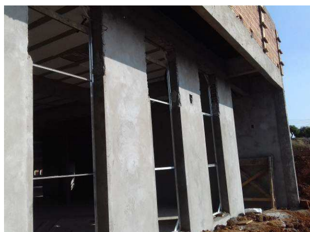
Figura 60C: Rebôco aplicado na fachada lateral direita - Sala múltiplo uso
