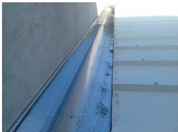
Figura 35C: Calhas em chapa galvanizada #24 instaladas na cobertura da secretaria
