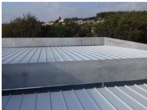
Figura 33C: Telhas metálicas instaladas sobre o PAB
