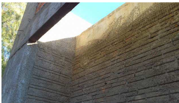
Figura 55C: Detalhe da tela para prevenção de trincas Belgofix
