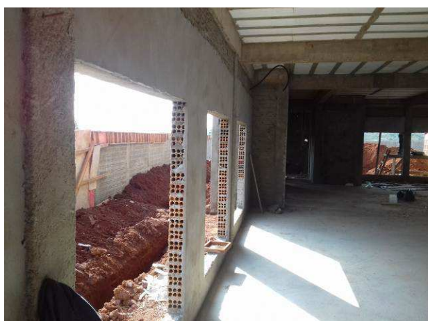
Figura 48C: Rebôco executado na região da secretaria
