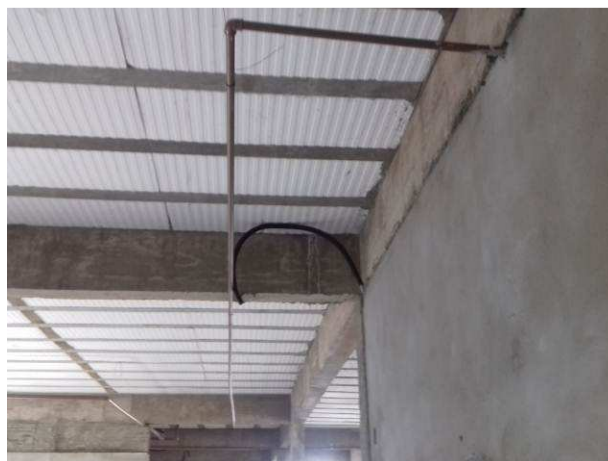
Figura 83C: Ramal distribuidor de 50mm - alimentando as prumadas dos sanitários públicos
