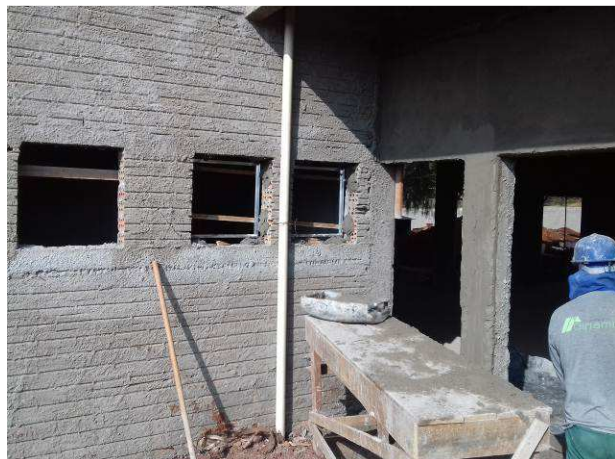
Figura 50C: Chapisco executado externamente, junto aos sanitários públicos
