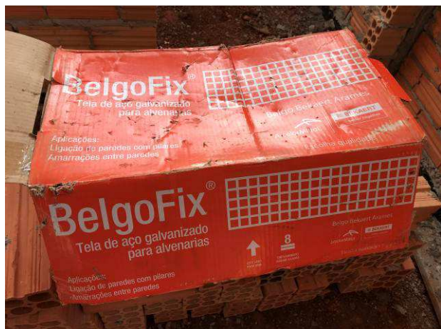
Figura 56C: Caixa de tela para prevenção de trincas
