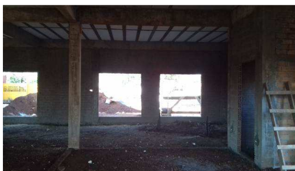
Figura 43C: Chapisco executado em paredes na região da sala de audiência 1
