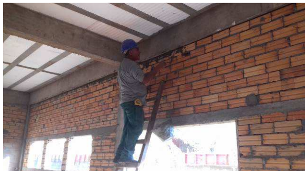
Figura 09C: Operário realizando o encunhamento da alvenaria, junto à viga de cobertura
