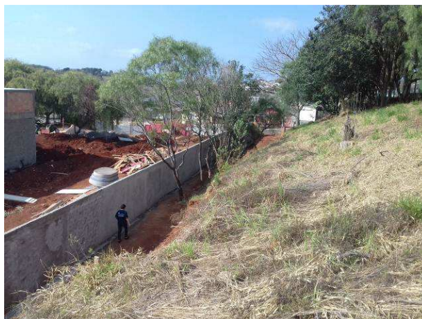
Figura 102C: Rebôco parcial da face externa de muro - lateral esquerda
