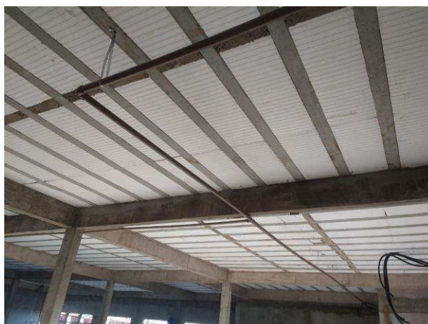
Figura 85C: Ramal distribuidor de 50mm - alimentando as prumadas dos sanitários públicos
