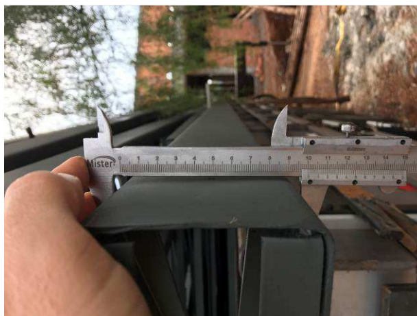
Figura 28C: Aferição da largura da alma de um banzo
