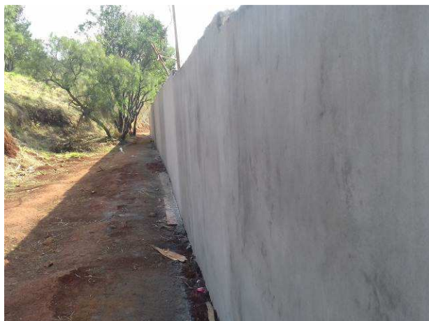
Figura 101C: Rebôco da face externa de muro - lateral esquerda
