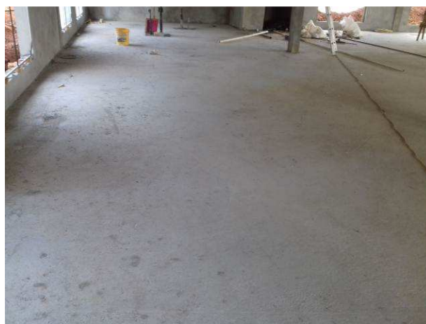
Figura 65C: Contrapiso executado - Sala de audiência 1
