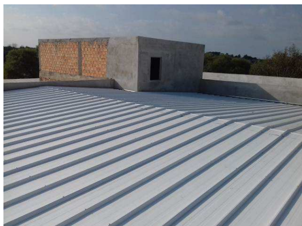
Figura 31C: Telhas metálicas instaladas sobre a secretaria
