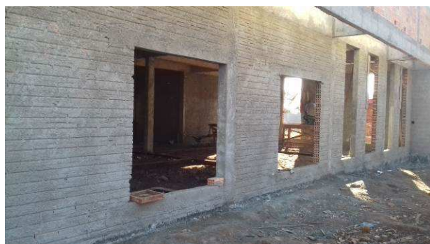
Figura 52C: Chapisco executado externamente, junto ao PAB, sala de perícia e arquivo
