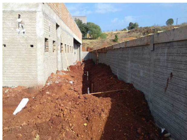
Figura 01C: Valas abertas para instalação de tubulações pluviais e de esgoto - fundos do imóvel
