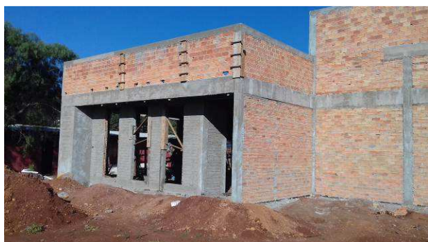
Figura 11C: Alvenaria lateral e platibandas - lateral direita
