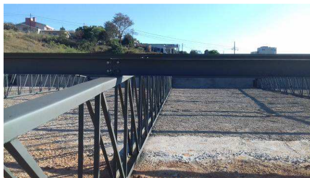
Figura 22C: Visão de diagonais e banço superior de tesoura
