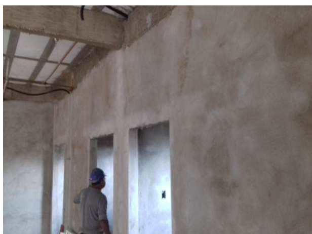
Figura 46C: Rebôco executado na região dos sanitários públicos
