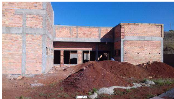
Figura 10C: Alvenaria lateral e platibandas - lateral direita
