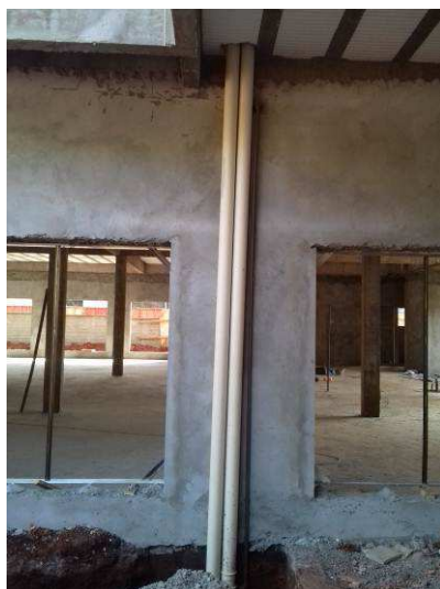
Figura 88C: Tubos de queda pluviais de 100mm - frontais
