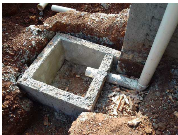
Figura 96C: Tubos de drenagem pluvial já conectados à caixa de inspeção
