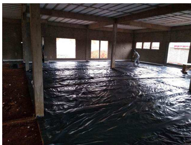
Figura 41C: Aplicação de lona plástica preta, sobre camada de brita, na região da secretaria
