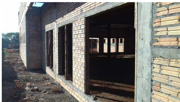
Figura 08C: Vergas e contravergas em janelas da secretaria - fundos do imóvel
