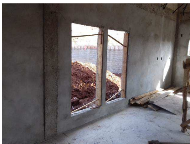
Figura 49C: Rebôco executado na região da sala dos assistentes
