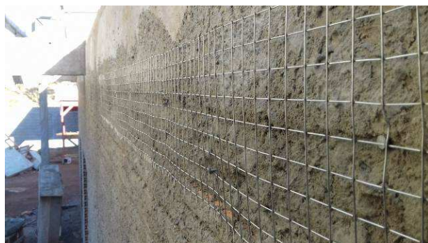
Figura 54C: Detalhe da tela para prevenção de trincas Belgofix
