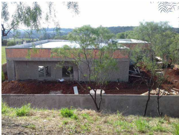
Figura 51C: Chapisco executado externamente, junto à secretaria
