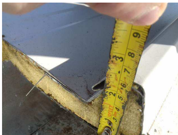
Figura 32C: Aferição da espessura da telha
