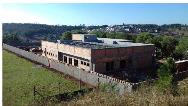
Figura 13C: Visão geral do imóvel, com alvenaria já finalizada
