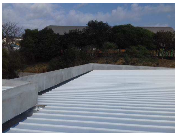
Figura 61C: Rebôco aplicado na face interna das platibandas
