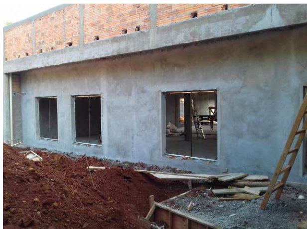
Figura 17C: Detalhe de janelas requadradas e com contramarcos instalados
