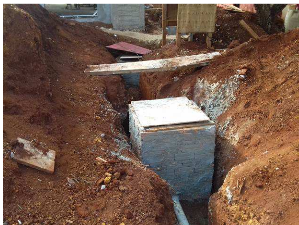
Figura 100C: Caixas de inspeção (pluvial) executada na parte frontal do imóvel
