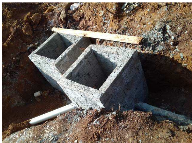
Figura 97C: Caixas de inspeção (esgoto e pluvial) executadas na parte frontal do imóvel
