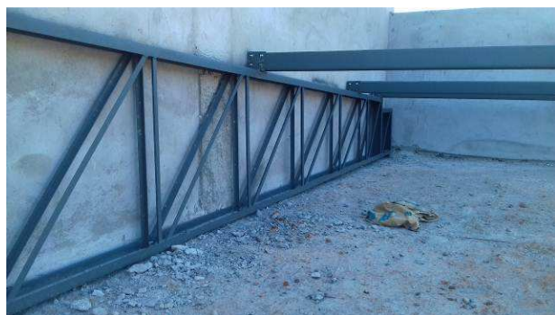
Figura 23C: Tesoura localizada junto à platibanda
