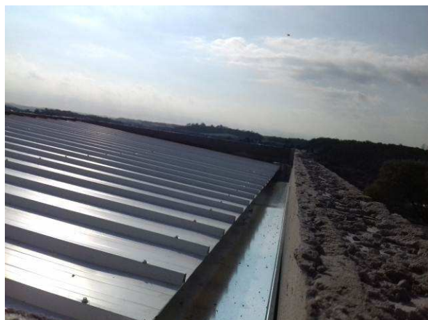
Figura 39C: Calha localizada sobre os reservatórios
