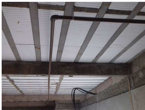
Figura 81C: Ramal distribuidor de 50mm - alimentando as prumadas dos sanitários da secretaria
