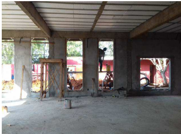
Figura 15C: Realização de requadro e instalação de contramarco nas janelas do arquivo
