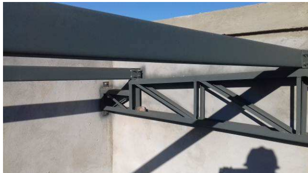
Figura 103C: Pintura da estrutura metálica de cobertura
