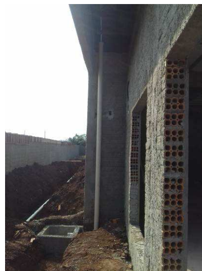
Figura 90C: Tubo de queda de 100mm - fundos com lateral direita
