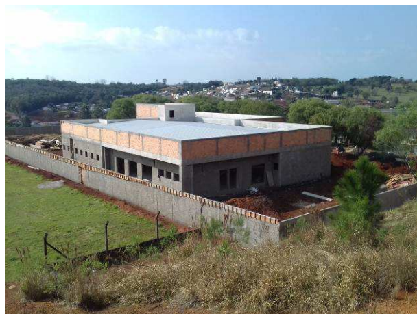
Figura 40C: Vista geral do imóvel, após instalação das telhas de cobertura
