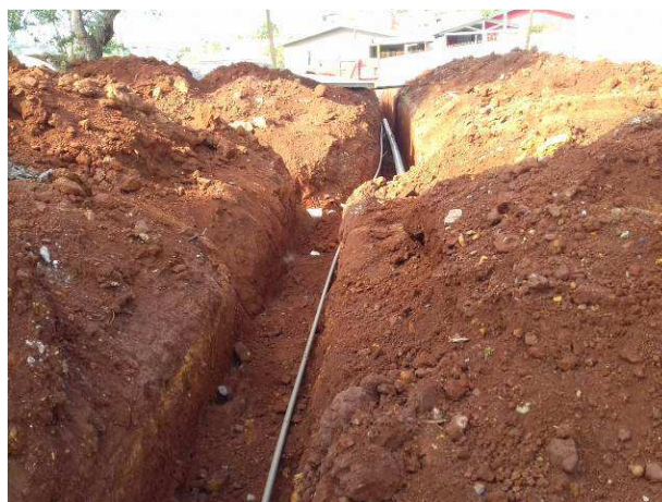
Figura 02C: Valas abertas para instalação de tubulações pluviais e hidráulicas - lateral esquerda
