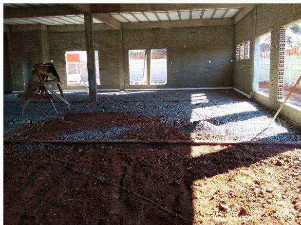
Figura 62C: Aplicação de lastro de brita sobre a base, para assentamento de contrapiso
