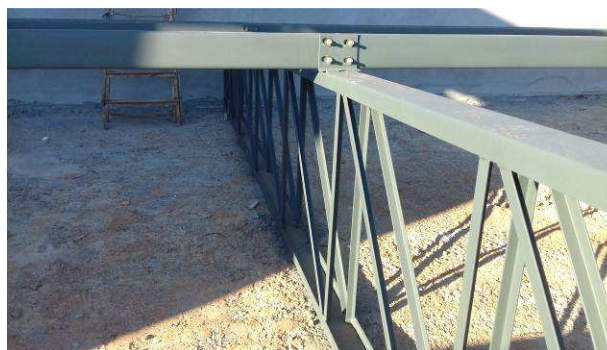
Figura 20C: Detalhe da ligação parafusada entre tesoura e terça
