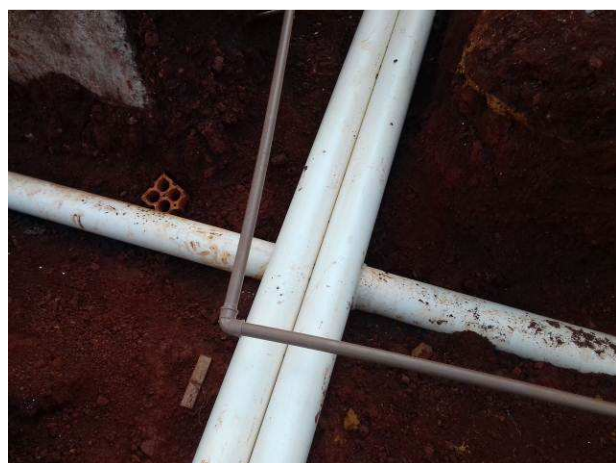
Figura 93C: Tubos de drenagem pluvial e esgoto de 100mm (frontal)
