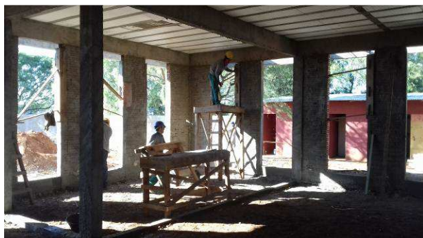
Figura 44C: Chapisco executado em paredes na região da sala múltiplo-uso e arquivo
