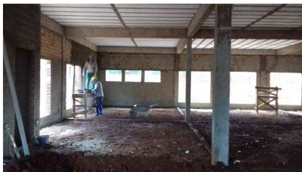
Figura 45C: Rebôco sendo executado na região da sala dos assistentes e copa
