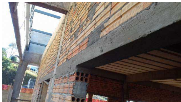
Figura 05C: Vergas em janelas - lateral esquerda
