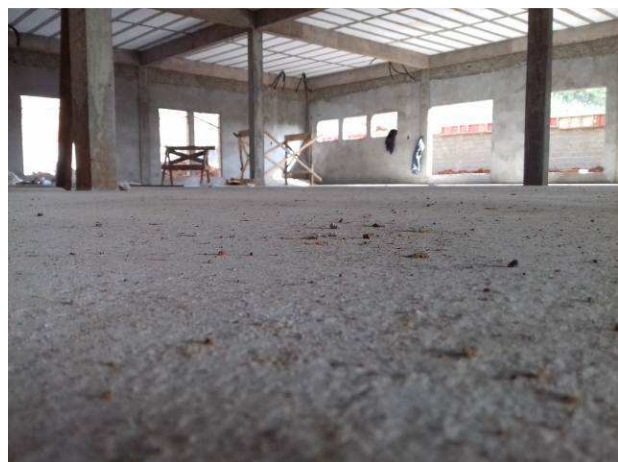
Figura 66C: Contrapiso executado - Secretaria, Copa e Assistentes
