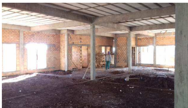
Figura 12C: Alvenaria da secretaria - fundos
