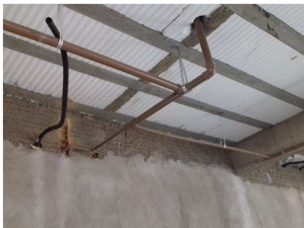
Figura 82C: Ramal distribuidor de 50mm, proveniente dos reservatórios
