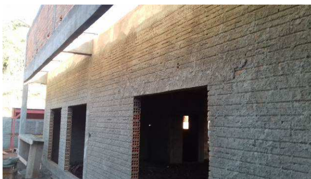
Figura 53C: Chapisco executado externamente, junto à sala de audiência e sala de testemunhas
