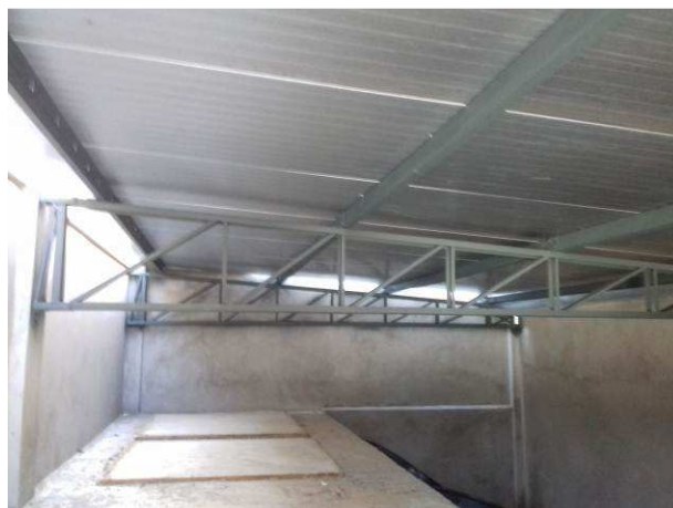
Figura 34C: Telhas metálicas instaladas no reservatório
