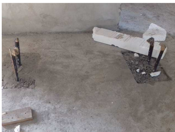
Figura 10E: Eletroduto de 60mm - utilizado na sala de audiência 2
