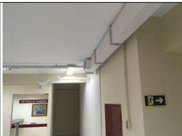
Figura 3C - Instalação dutos insuflamento - 12ª VT
