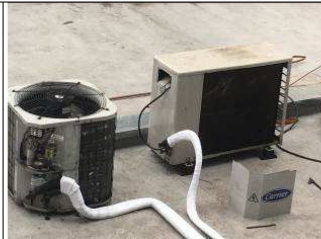
Figura 25C - retirada e reinstalação SPLITs - laje técnica
