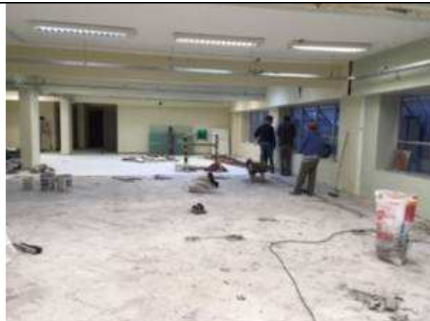
Figura 16C - retirada de divisórias - 15ª VT
