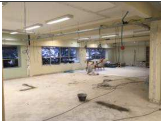
Figura 20C - retirada de piso - 13ª VT
