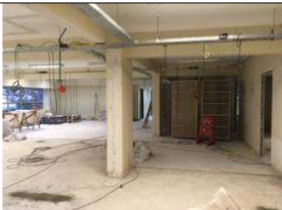
Figura 19C - retirada de divisórias - 13ª VT
