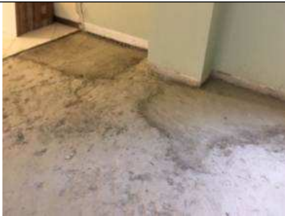
Figura 13C - retirada de piso - 14ª VT
