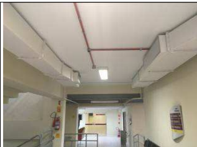
Figura 2C - pintura dutos insuflamento - 12ª VT
