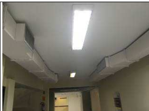
Figura 4C - Instalação dutos insuflamento - 12ª VT
