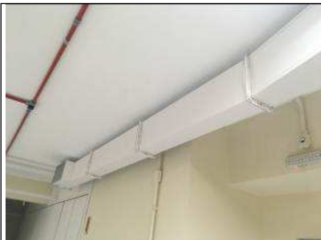
Figura 1C - pintura dutos insuflamento - 12ª VT
