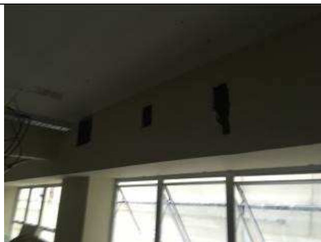
Figura 21C - retirada de SPLITS - 15ª VT
