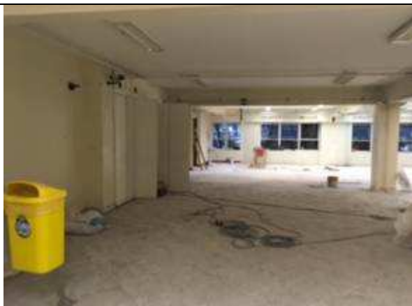
Figura 17C - retirada de piso - hall público - 13ª/15ª VTs
