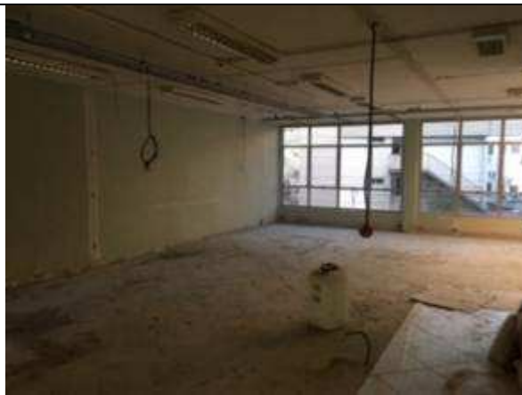
Figura 11C - retirada de divisórias - 14ª VT
