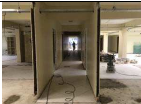
Figura 18C - retirada de divisórias - 13ª/15ª VT
