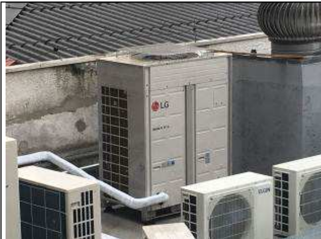
Figura 24C - retirada e reinstalação de equipamento VRF - laje técnica
