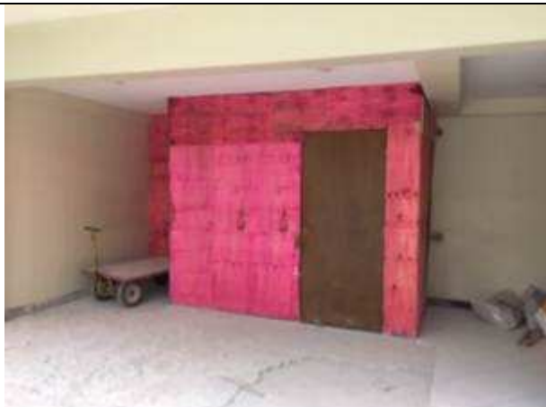
Figura 15C - Instalação de tapumes - 13ª/15ª VTs
