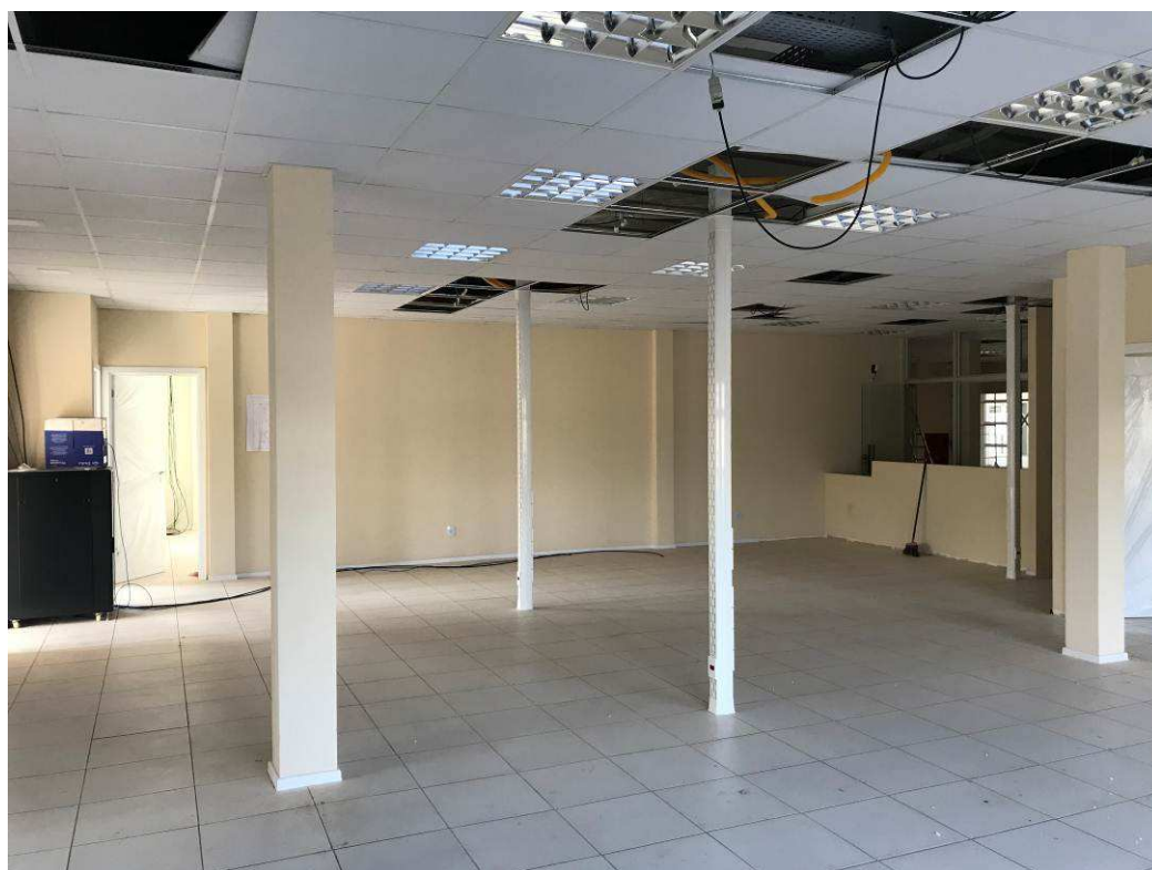
Figura 5 – Fórum - Vista interna - Secretaria da 2ª Vara.
