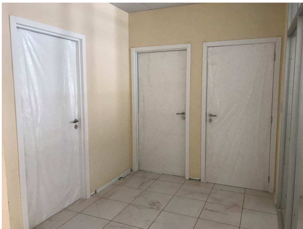
Figura 4 – Fórum - Vista interna - Portas de madeira.
