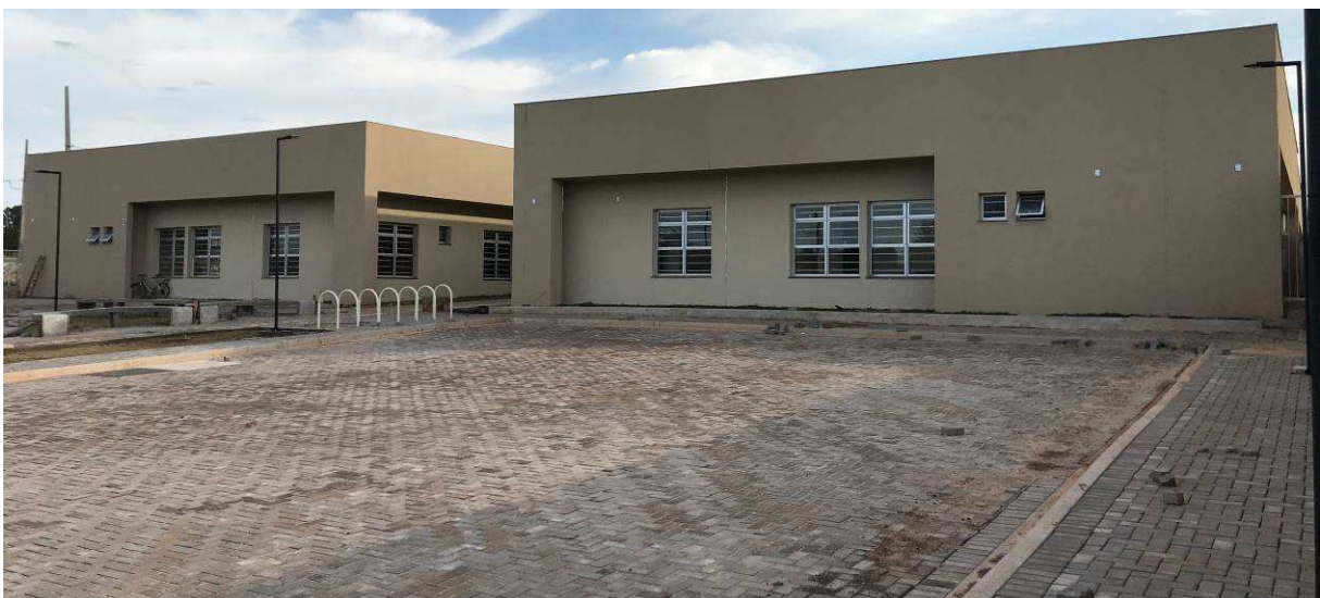
Figura 1 – Fórum - Vista externa - Frente.
