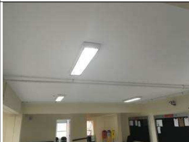
Figura 41C - pintura interna - laje de forro hall público - 10ª VT
