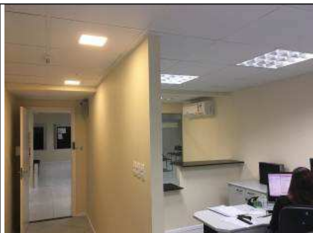
Figura 42C - pintura interna - 11ª VT
