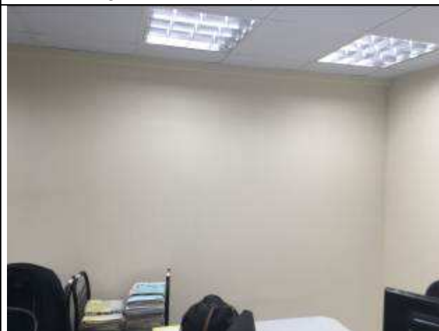
Figura 12C - pintura interna - 12ª VT
