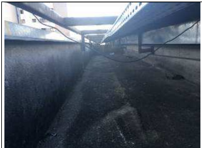
Figura 52C - adequação plataformas metálicas
