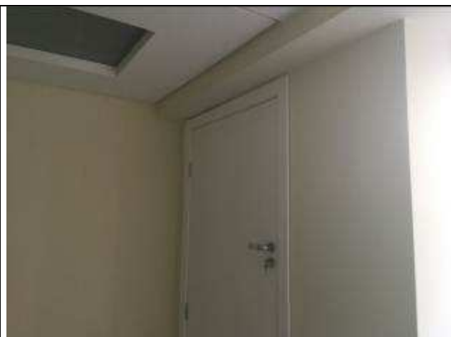
Figura 4C - abertura vão passagem rede frigorígena - gabinete 12ª VT
