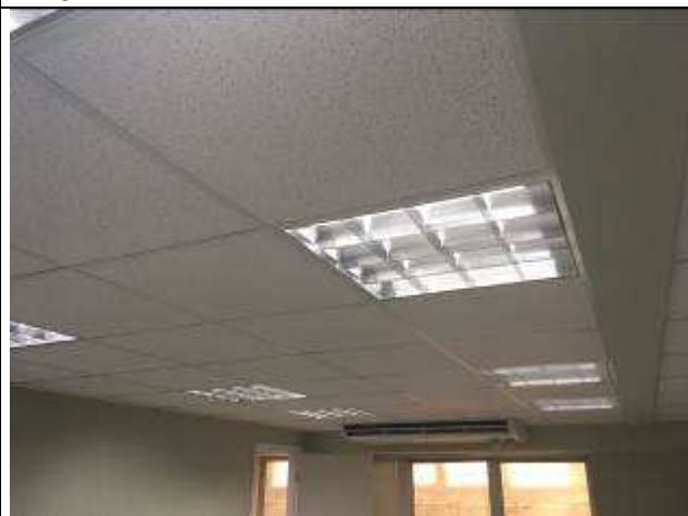
Figura 27C - forro removível acústico- 11ª VT
