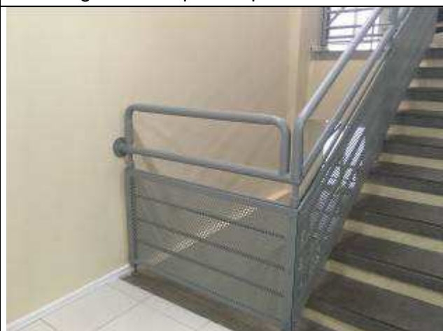
Figura 47C - pintura guarda corpos e corrimãos - hall público/escada - 11ª VT
