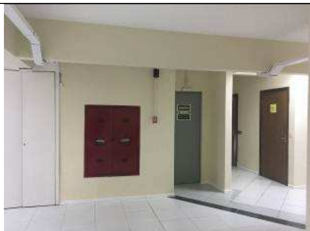
Figura 38C - pintura interna - hall público - 10ª VT
