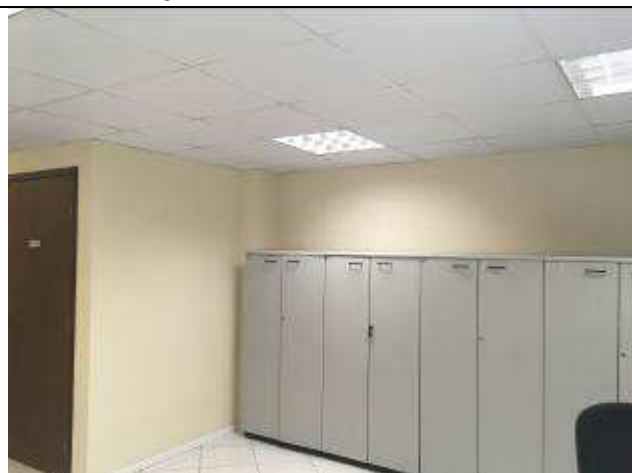
Figura 13C - pintura interna - 12ª VT
