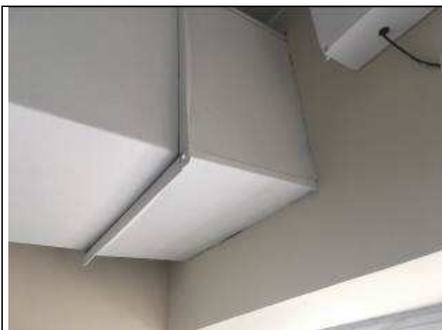
Figura 50C - abertura em alvenaria - interligação de dutos
