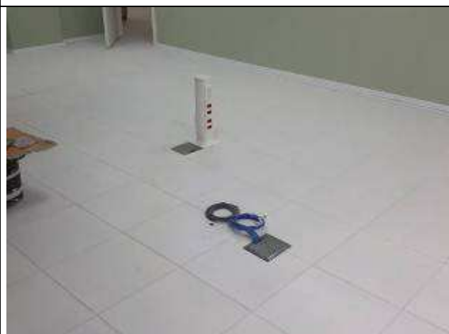
Figura 25E: instalações salas de audiências 10ª e 11ª VT
