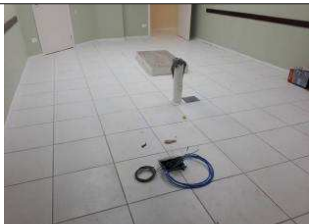
Figura 07E: instalações salas de audiências - 12ª VT
