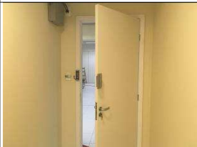
Figura 39C - pintura esquadrias - 10ª VT
