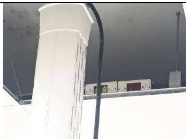
Figura 19E: colunas Dutotec e tomadas padrão genérico - 10ª e 11ª VT
