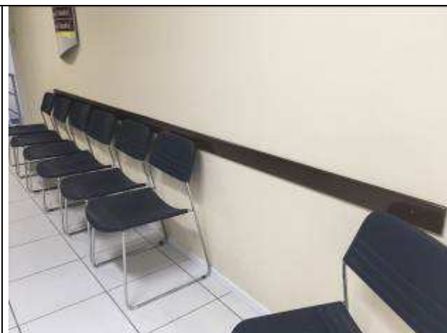
Figura 16C - pintura bate macas - 12ª VT
