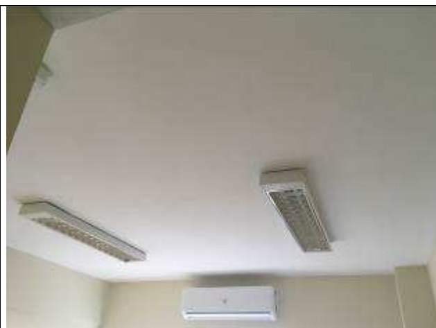
Figura 37C - pintura laje de forro - gabinete - 10ª VT
