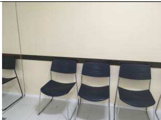
Figura 40C - pintura protetores de parede - 10ª VT
