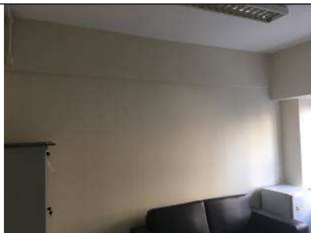
Figura 36C - pintura interna - gabinetes - 10ª VT
