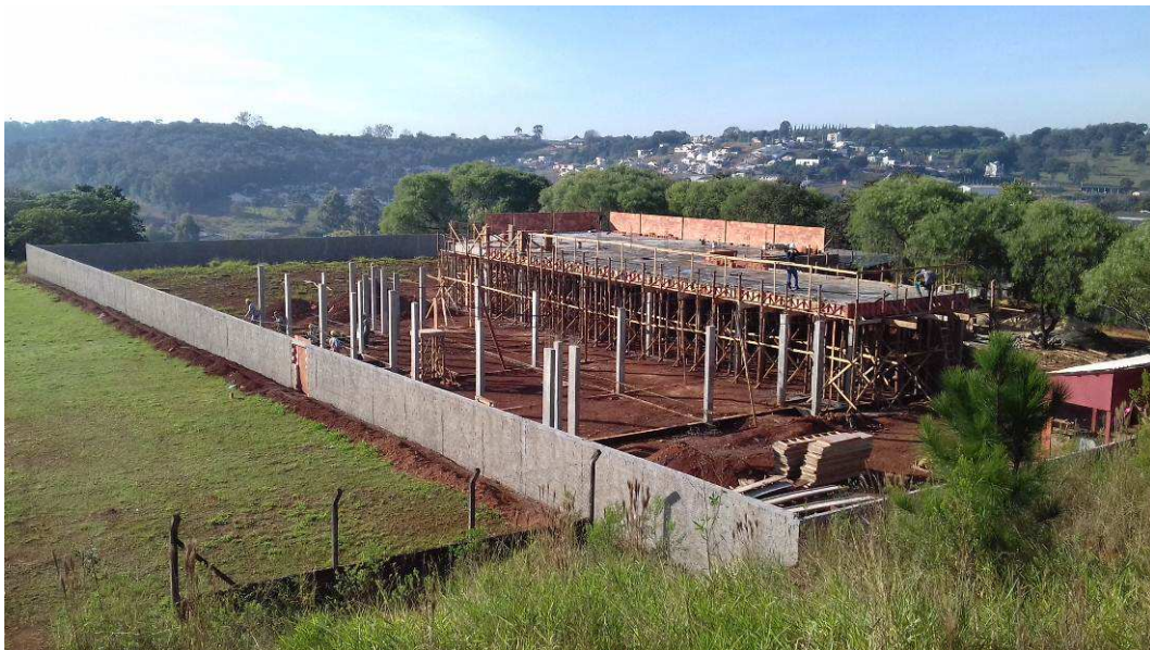
Figura 1 – Visão geral do canteiro de obra
