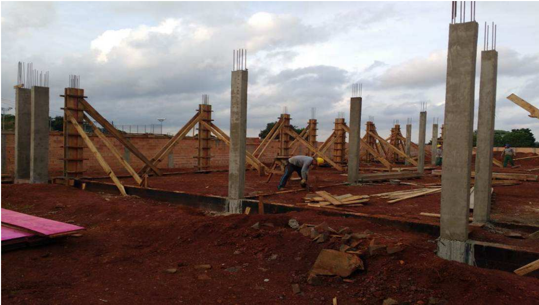
Figura 2 – Concretagem dos últimos pilares
