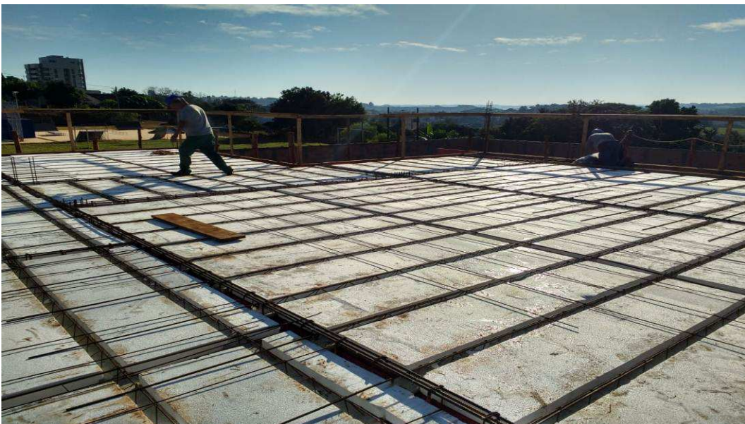
Figura 3 – Preparo da laje de cobertura
