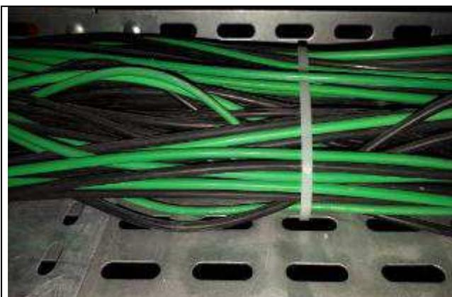
Figura 29E: infraestrutura - eletrocalhas ar cobertura VM362
