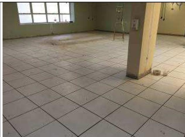
Figura 4C - Execução de piso cerâmico - 12ª VT
