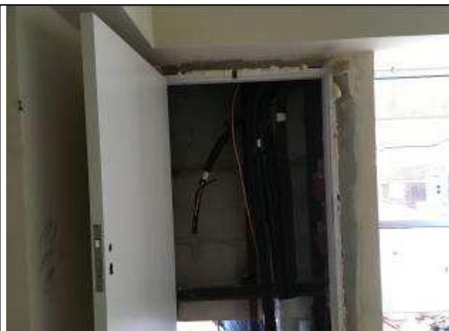
Figura 37C - vergas e requadros - aberturas para passagem da rede frigorígena - gabinetes dos Juízes
