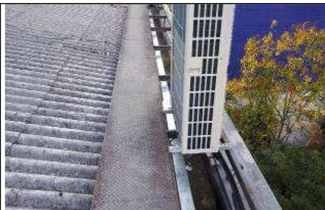
Figura 32E: cabeamento elétrico ar condicionado cobertura VM362
