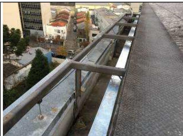
Figura 40C - adaptação e reinstalação de plataforma metálica
