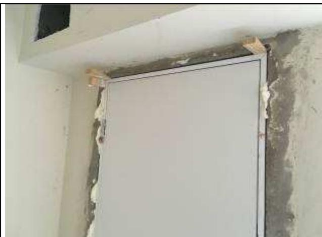
Figura 36C - vergas e requadros - aberturas para passagem da rede frigorígena - gabinetes dos Juízes
