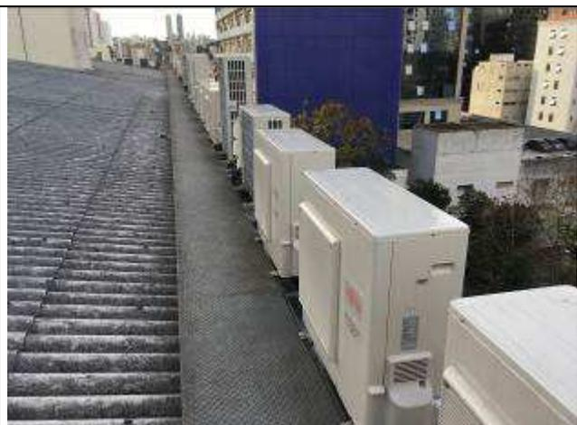
Figura 42C - instalação de novos SPLITs -
