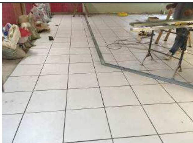
Figura 5C - Execução de piso cerâmico - 12ª VT
