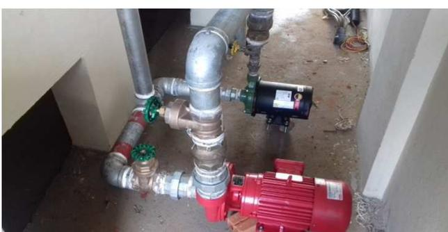
Figura 13C: Bombas, Registros, tubulações e válvulas de retenção - sistema de recalque
