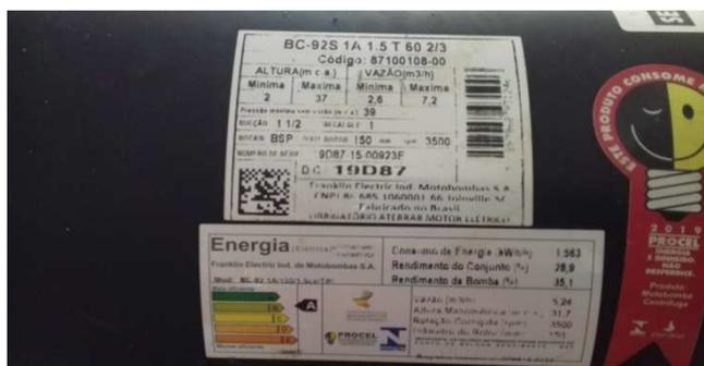
Figura 17C: Etiqueta com especificação da bomba Jockey
