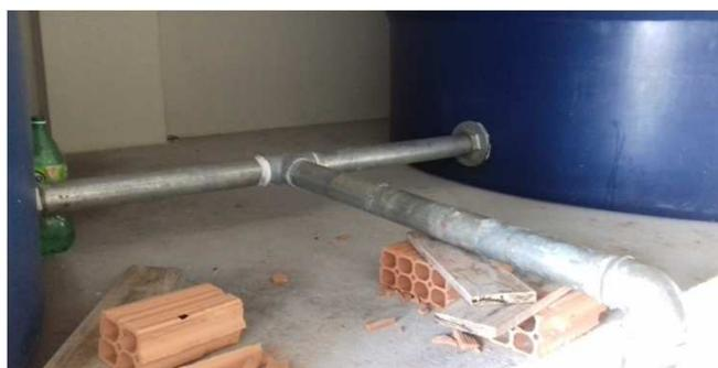
Figura 10C: Tubulação de incêndio - Barrilete do reservatório de incêndio
