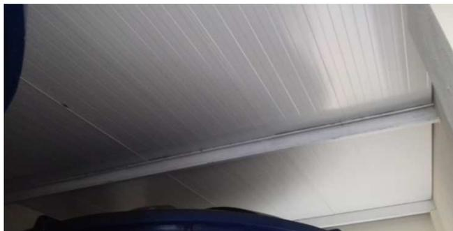
Figura 03C: Telha metálica instalada na cobertura do reservatório de incêndio
