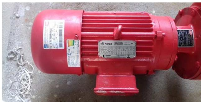
Figura 15C: Bomba de recalque e pressurização do sistema de incêndio
