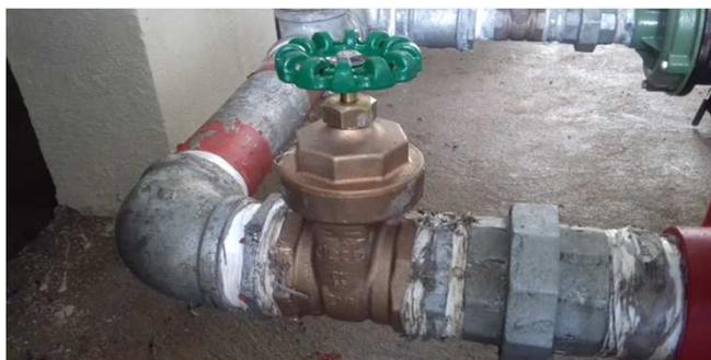
Figura 14C: Registro instalado junto á bomba de 5CV
