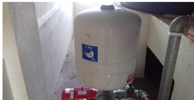
Figura 19C: Tanque de pressão
