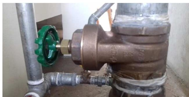
Figura 12C: Registro de gaveta instalado no sistema de recalque
