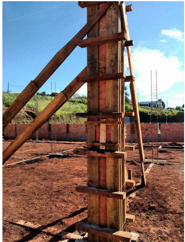
Figura 22C: Detalhe da janela de concretagem a meia-altura do pilar
