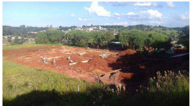
Figura 02C: Abertura de valas para execução da infraestrutura (baldrames e blocos), visão geral do terreno
