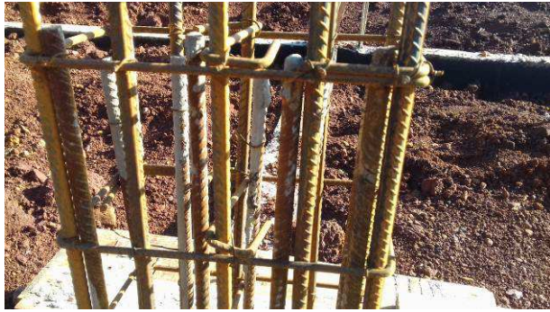
Figura 17C: Detalhe da ancoragem de armadura na espera
