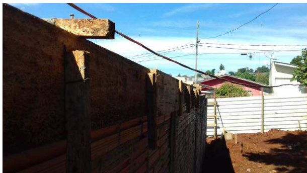
Figura 37C: No detalhe, fôrma da viga cinta de travamento do muro
