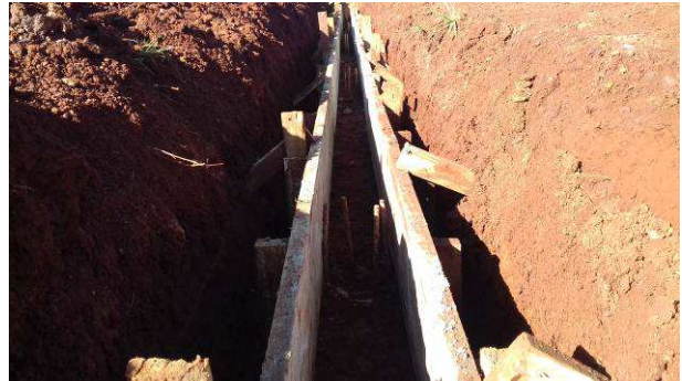
Figura 30C: Fôrma de viga baldrame do muro sendo concluída
