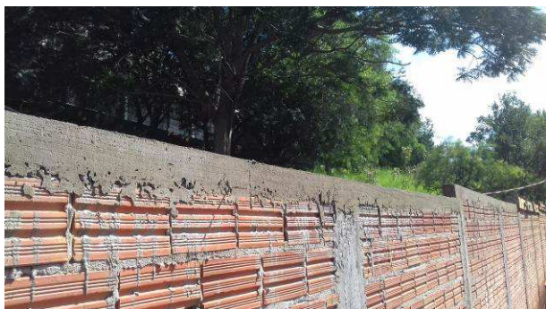
Figura 39C: Viga cinta de travamento do muro, após concretagem e desforma
