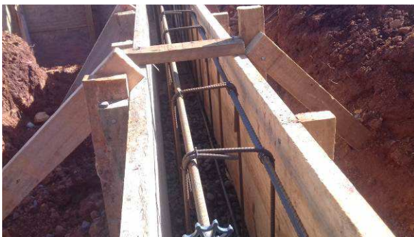
Figura 07C: Fôrmas e armaduras de uma viga baldrame
