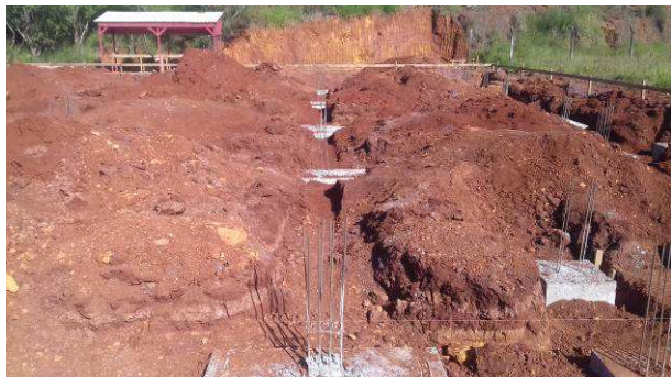
Figura 01C: Abertura de valas para execução da infraestrutura (baldrames e blocos)
