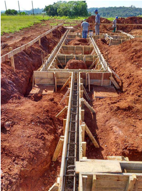
Figura 05C: Execução de fôrmas para vigas baldrame
