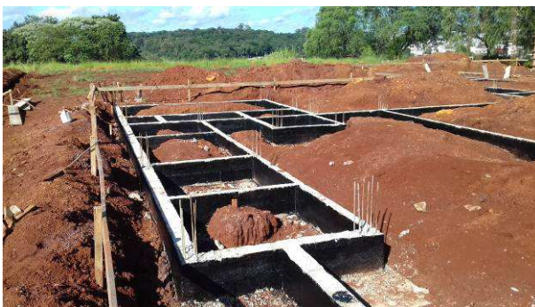
Figura 09C: Vigas baldrame já desformadas
