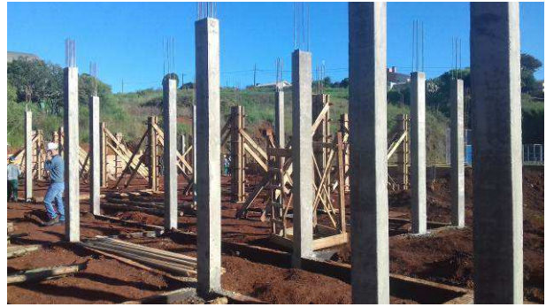
Figura 18C: Pilares concretados e já desformados
