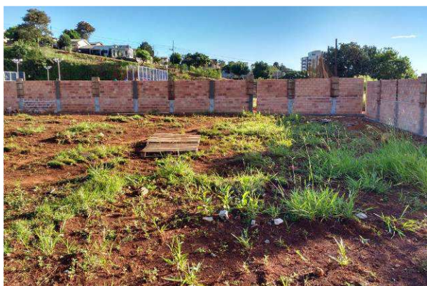
Figura 41C: Muro de fechamento do terreno - Fundos e parte da lateral direita
