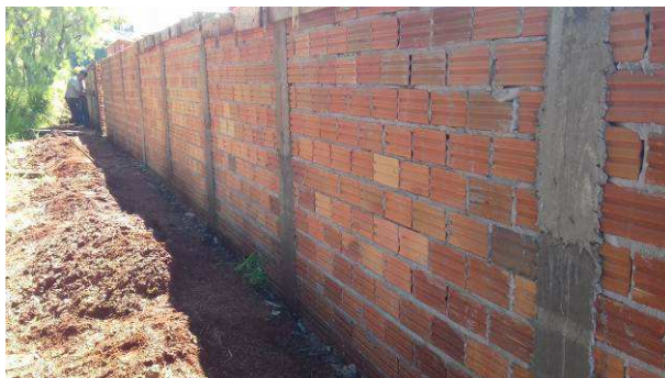
Figura 38C: Alvenaria do muro de fechamento do terreno
