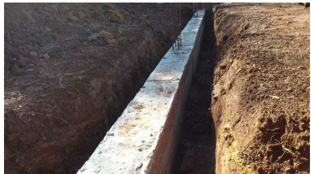
Figura 32C: Viga baldrame do muro de fechamento do terreno, já concretada e desformada
