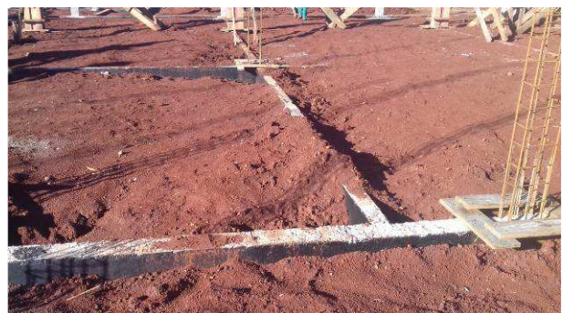
Figura 04C: Reaterro de blocos, baldrames e entre baldrames
