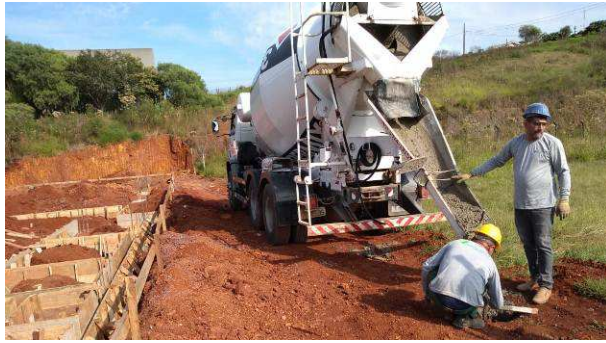
Figura 27C: Realização de concretagem de estacas com uso de caminhão-betoneira
