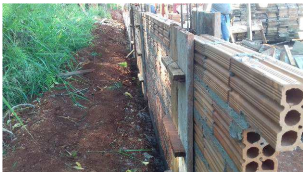
Figura 35C: No detalhe, alvenaria do muro e fôrmas de pilaretes de travamento
