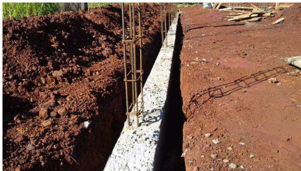
Figura 31C: Viga baldrame do muro de fechamento do terreno, já concretada e desformada
