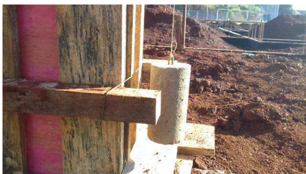
Figura 13C: Preparação do pilar para concretagem - execução do nivelamento (prumo) da fôrma
