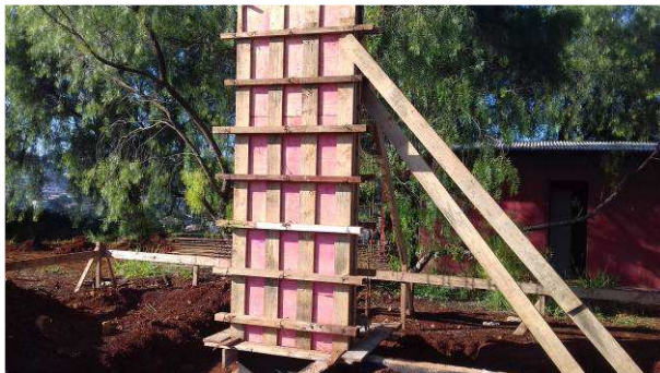
Figura 12C: Fôrma de pilar montada e escorada
