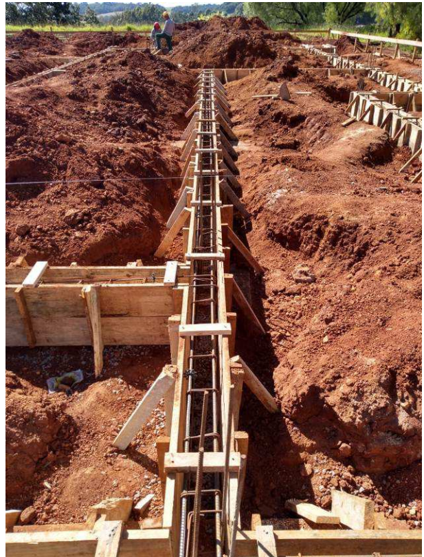
Figura 06C: Execução de fôrmas para vigas baldrame
