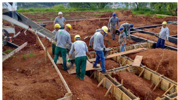
Figura 10C: Operários realizando a concretagem de vigas baldrame
