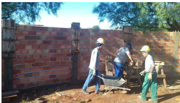
Figura 40C: Operários realizando a concretagem de pilaretes de travamento do muro
