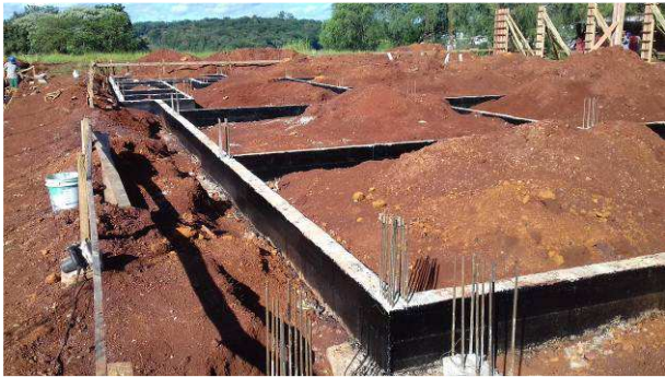
Figura 23C: Vigas baldramas com faces laterais "pintadas" com impermeabilizante a base de emulsão asfáltica
