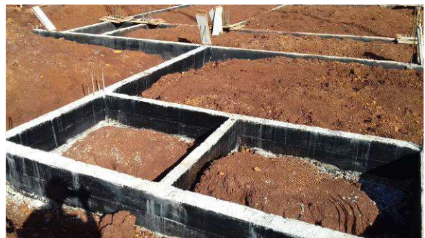
Figura 08C: Vigas baldrame já desformadas
