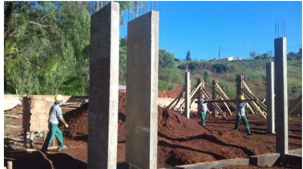
Figura 20C: Pilares concretados e já desformados
