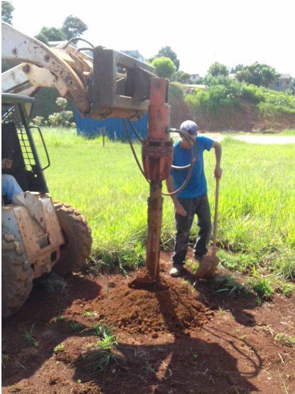
Figura 25C: Perfuração de uma estaca-broca
