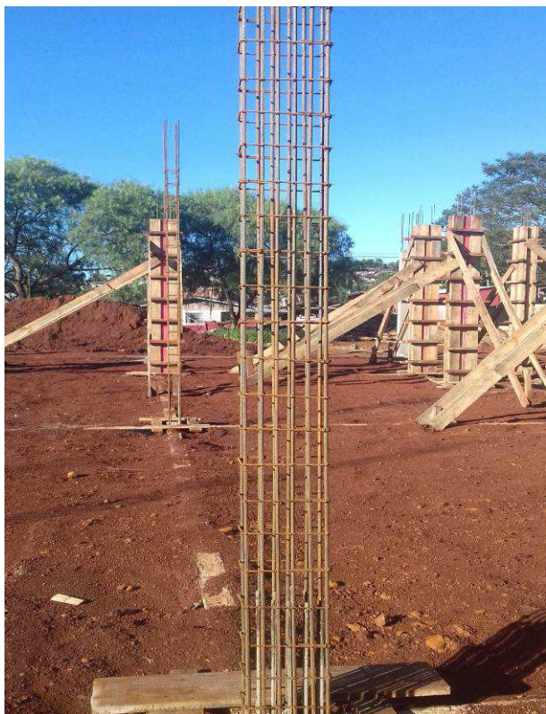
Figura 15C: Armadura de pilar, já ancorada na espera
