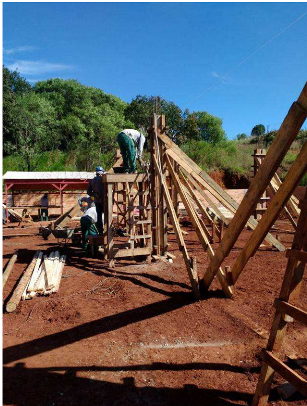
Figura 21C: Operários realizando a concretagem de pilar
