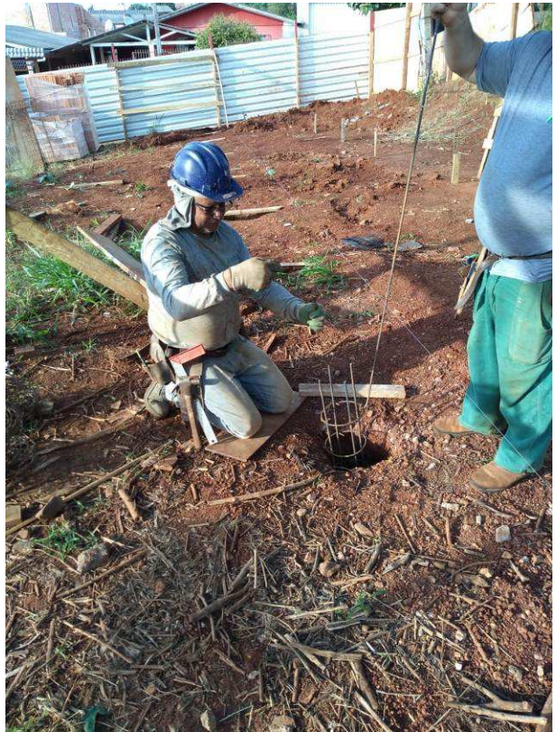
Figura 26C: Operários realizando a acomodação da armadura de estaca, para concretagem do furo
