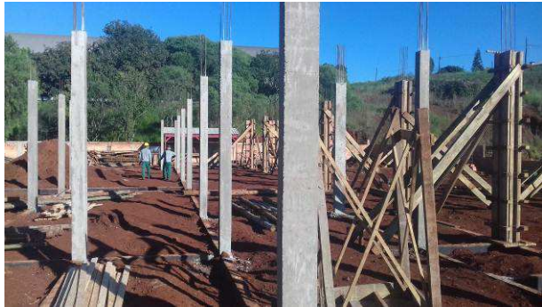
Figura 19C: Pilares concretados e já desformados
