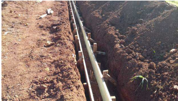
Figura 29C: Fôrma de viga baldrame do muro sendo concluída
