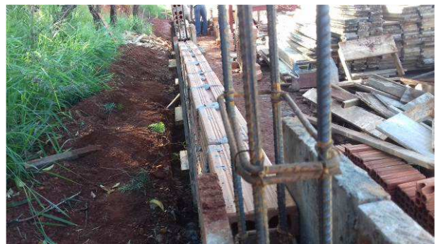
Figura 34C: Pilaretes de travamento da alvenaria do muro
