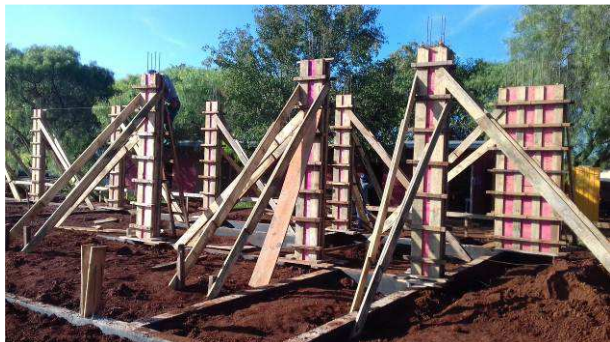
Figura 11C: Fôrmas de pilares sendo escoradas
