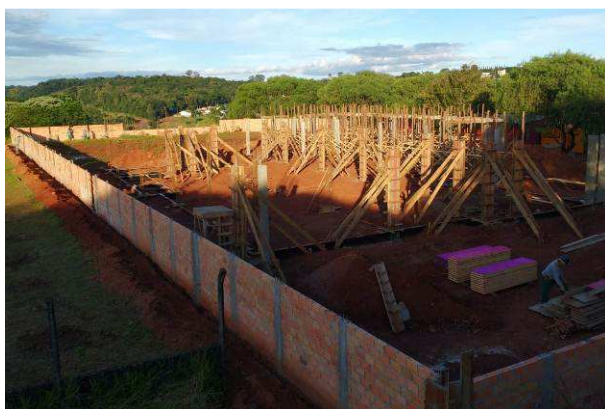
Figura 42C: Muro de fechamento do terreno - visão geral
