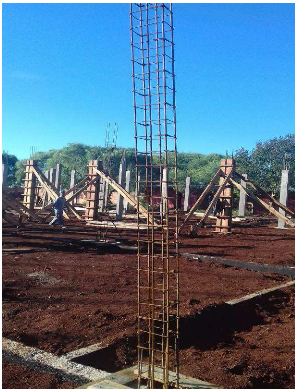
Figura 16C: Armadura de pilar, aguardando fôrma
