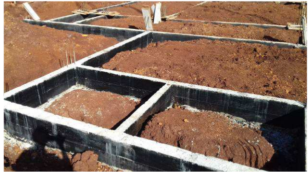
Figura 24C: Vigas baldramas com faces laterais "pintadas" com impermeabilizante a base de emulsão asfáltica
