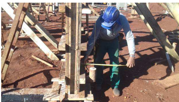
Figura 14C: Operários realizando o nivelamento (prumo) da fôrma
