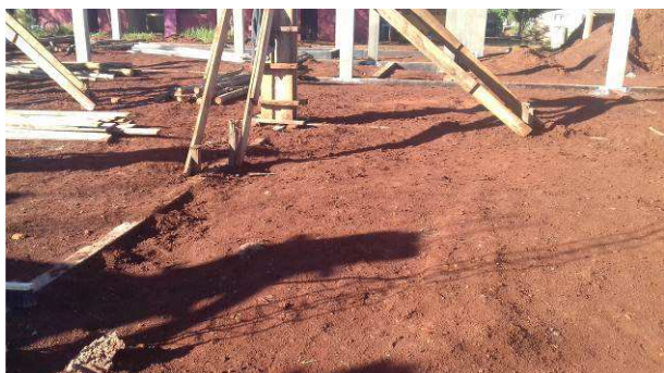
Figura 03C: Reaterro de blocos, baldrames e entre baldrames
