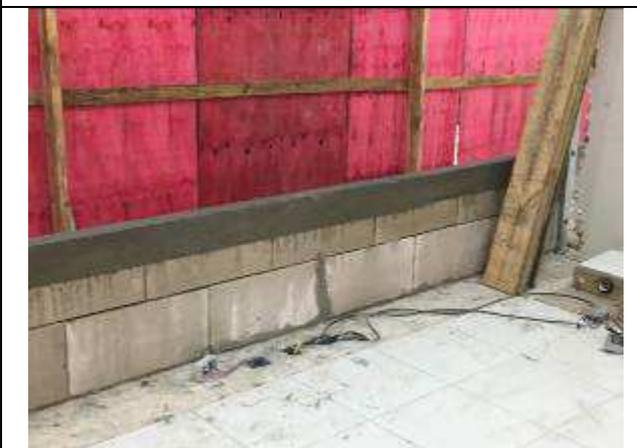
Figura 06C: Blocos de concreto.
