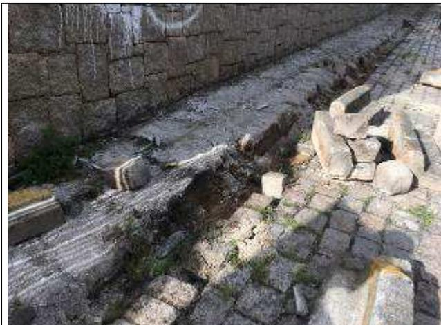
Figura 13C: Demolição do pavimento existente.
