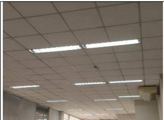
Figura 01E: Lâmpadas LED substituídas
