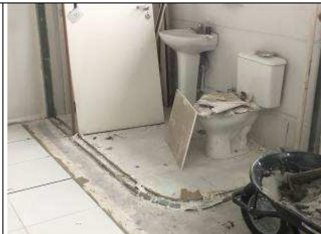
Figura 8C: retirada paredes dry-wall.
