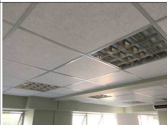
Figura 05C - forro acústico instalado.
