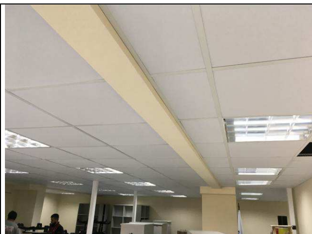
Figura 04C - forros instalados
