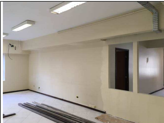
Figura 13C - divisórias dry-wall instaladas.
