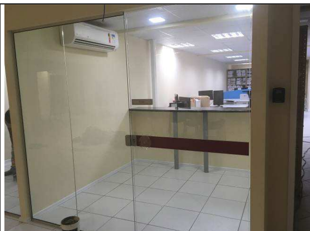
Figura 03C - portas e painéis de vidro reinstalados.
