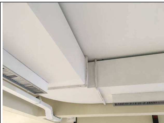
Figura 10C - pintura de dutos de insuflamento.
