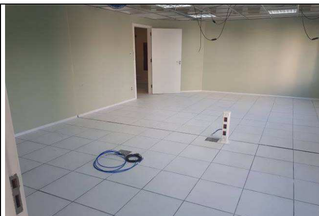
Figura 10E: instalações salas de audiências 4a e 5a VT
