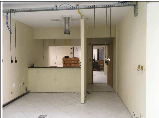
Figura 14C - balcão de atendimento reinstalado.
