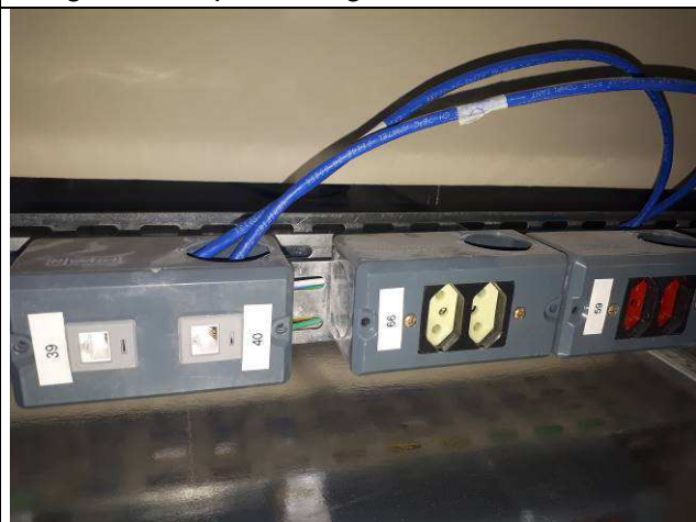
Figura 24E: pontos lógicos RJ45 4a e 5a VT
