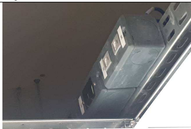
Figura 21E: cabearamento UTP cat6 4a e 5a VT
