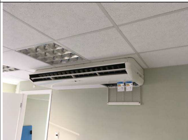
Figura 11C - SPLIT instalado..
