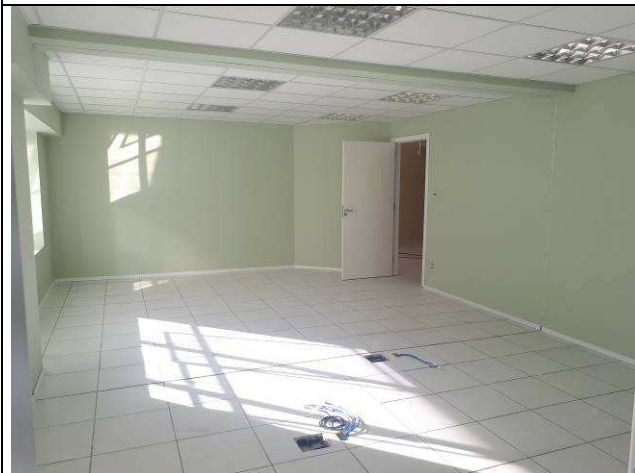
Figura 19E: cabeamento UTP cat6 4a e 5a VT
