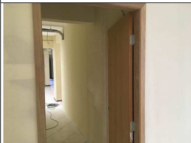
Figura 15C - portas de madeira instaladas.
