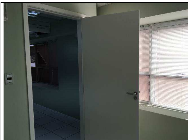
Figura 01C - portas de madeira instaladas
