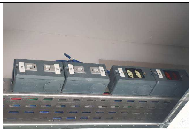
Figura 22E: pontos lógicos RJ45 4a e 5a VT
