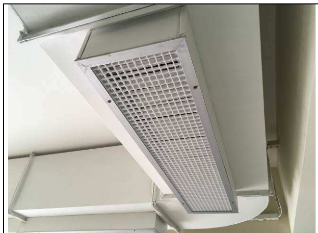
Figura 25C - grelhas instaladas.
