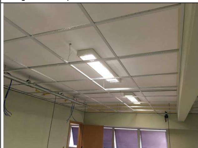
Figura 17C - Estrutura de forro instalada.
