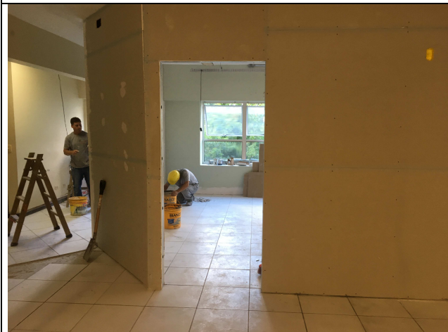
Figura 13C: divisórias instaladas.
