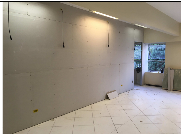
Figura 14C: divisórias instaladas.
