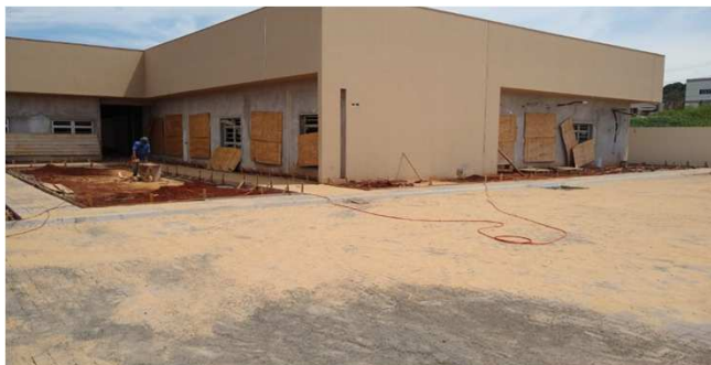
Figura 28C: Paver instalado no estacionamento da direita
