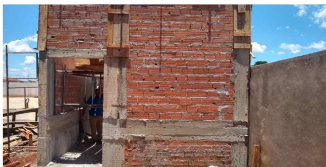
Figura 01C: Vigas intermediárias, alvenaria e pilares do reservatório de incêndio
