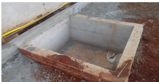
Figura 18C: Boca-de-lobo, executada no estacionamento da esquerda
