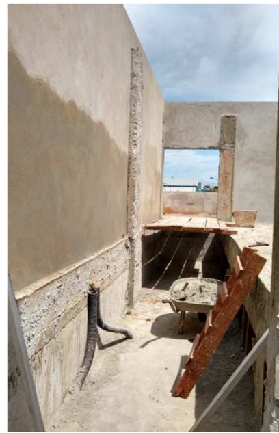
Figura 15C: Rebôco aplicado no reservatório de incêndio - interior
