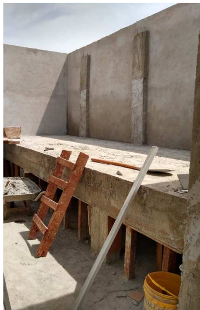
Figura 14C: Rebôco aplicado no reservatório de incêndio - interior
