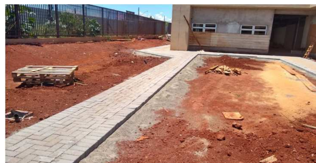
Figura 32C: Calçada sendo executada defronte ao bloco da direita
