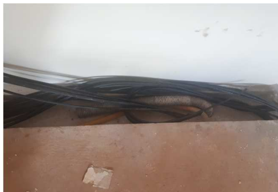
Figura 36E: ramais alimentadores QDAR1, QDAR2, QDAR3
