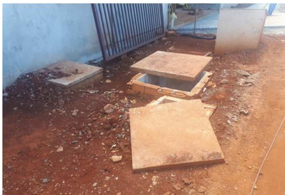
Figura 25E: infraestrutura externa - caixas tampadas, CFTV externo
