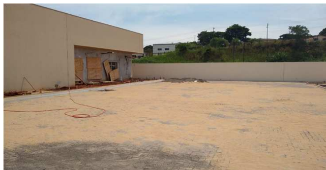
Figura 27C: Paver instalado no estacionamento da direita
