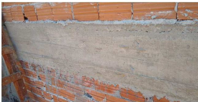
Figura 03C: Detalhe de viga intermediária, no reservatório de incêndio
