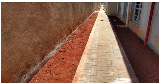
Figura 35C: Reaterro de baldrame, entre muro e calçada
