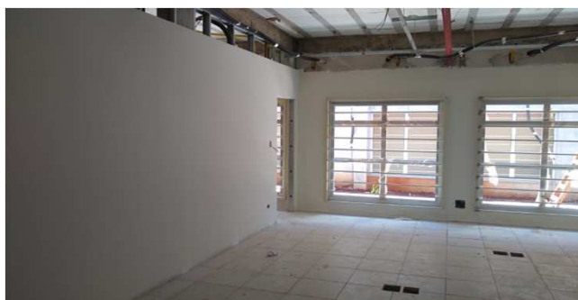
Figura 39C: Pintura da sala de audiência 2 (bloco da esquerda)
