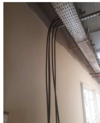
Figura 34E: ramais alimentadores QDAR1, QDAR2, QDAR3
