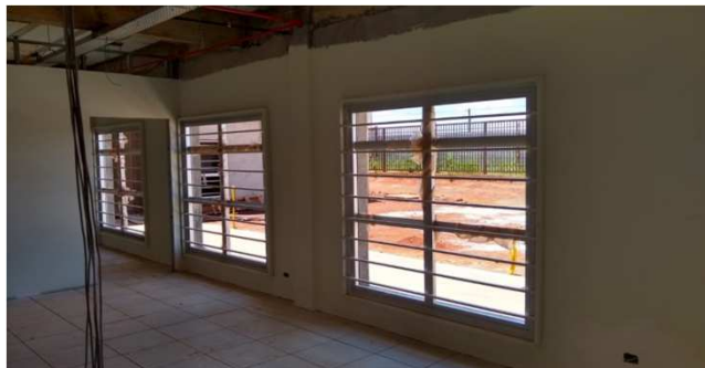
Figura 43C: Pintura da sala de audiência 1 - bloco da esquerda
