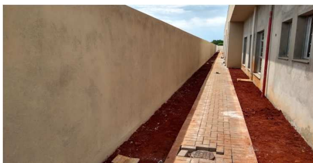
Figura 34C: Reaterro de baldrame, entre muro e calçada
