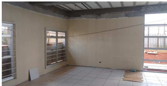
Figura 17C: Piso na área destinada ao PAB
