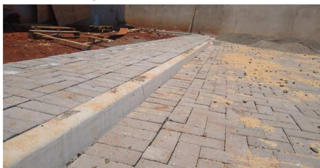
Figura 31C: Detalhe de calçada e meio-fio, na lateral direita
