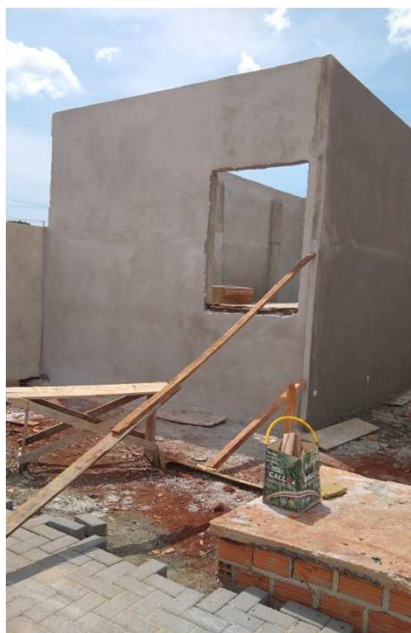
Figura 13C: Rebôco aplicado no reservatório de incêndio - face esquerda
