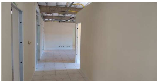
Figura 38C: Pintura da área de circulação - bloco esquerdo
