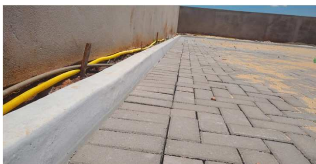
Figura 30C: Detalhe de Paver e meio-fio
