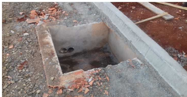
Figura 19C: Boca-de-lobo, executada no estacionamento da esquerda
