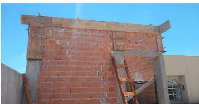
Figura 05C: Estrutura de pilares e vigas de cobertura, além de alvenaria do reservatório de incêndio
