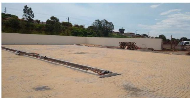
Figura 26C: Paver instalado no estacionamento da direita
