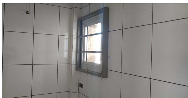
Figura 11C: Azulejo instalado em sanitário público masculino
