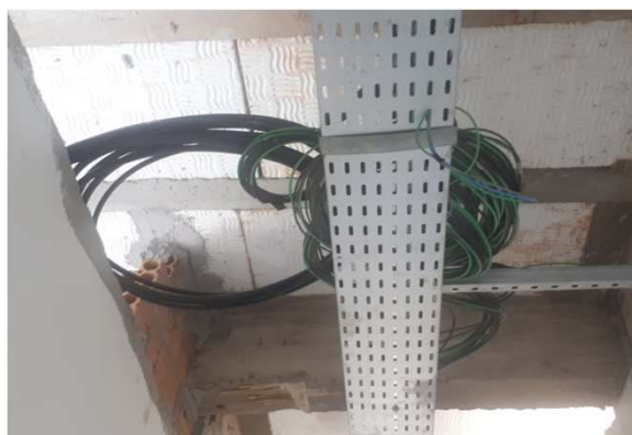
Figura 33E: ramais alimentadores QDAR1, QDAR2, QDAR3
