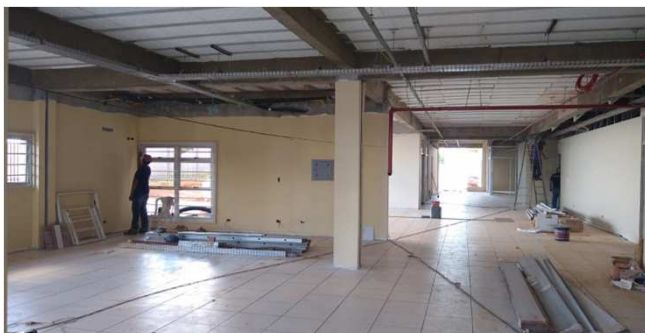
Figura 16C: Piso aplicado na área destinada a OAB
