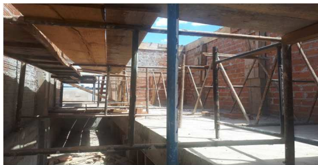
Figura 04C: Em meio a andaimes, a laje do reservatório
