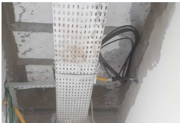
Figura 35E: ramais alimentadores QDAR1, QDAR2, QDAR3
