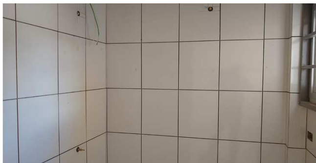
Figura 09C: Azulejo instalado em sanitário público masculino
