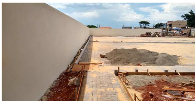
Figura 36C: Pintura do muro de fechamento do terreno
