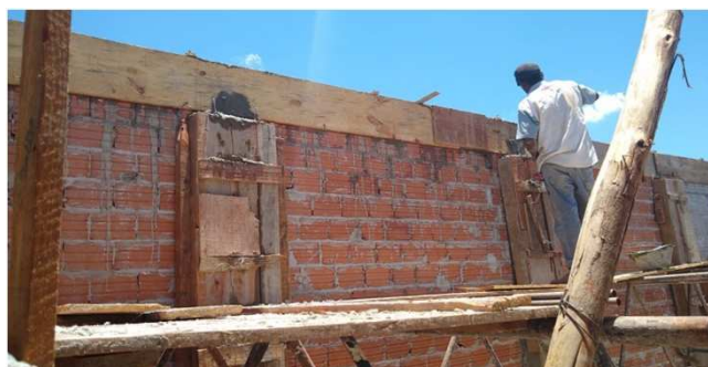
Figura 02C: Alvenaria, pilares e vigas de cobertura do reservatório de incêndio
