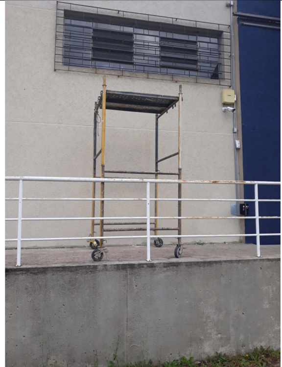
Figura 03 - Andaime metálico modular
