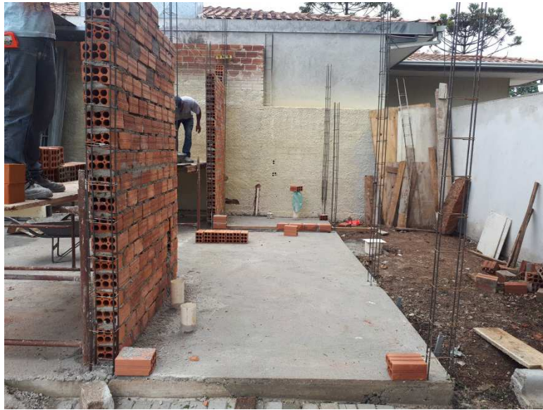
Figuras 09: Pontos de esgoto e água instalados.
