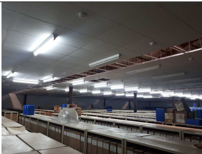
Figura 12 - Forro removível do Arquivo.
