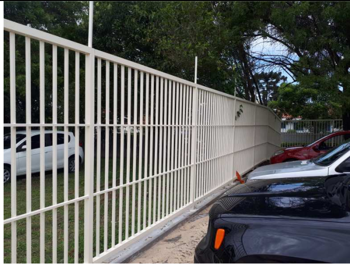
Figuras 10 - Gradis de fechamento de terreno.
