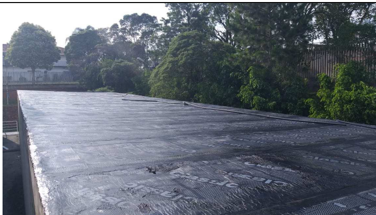
Figura 13 -Impermeabilização.
