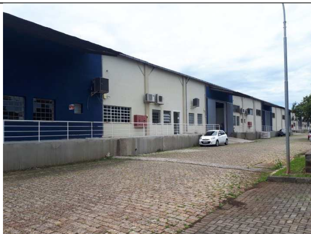
Figura 15 - Pintura da fachada.
