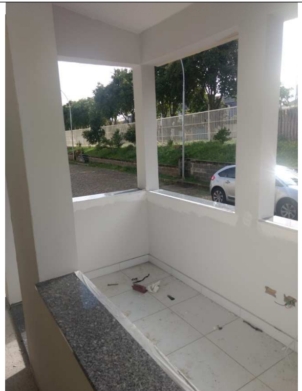
Figura 08 - Concretagem da guarita finalizada.
