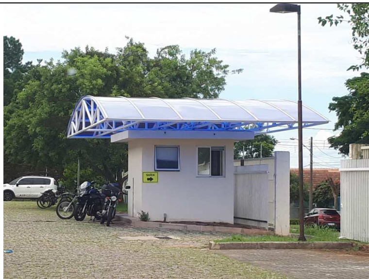
Figura 14 - Cobertura de policarbonato alveolar.
