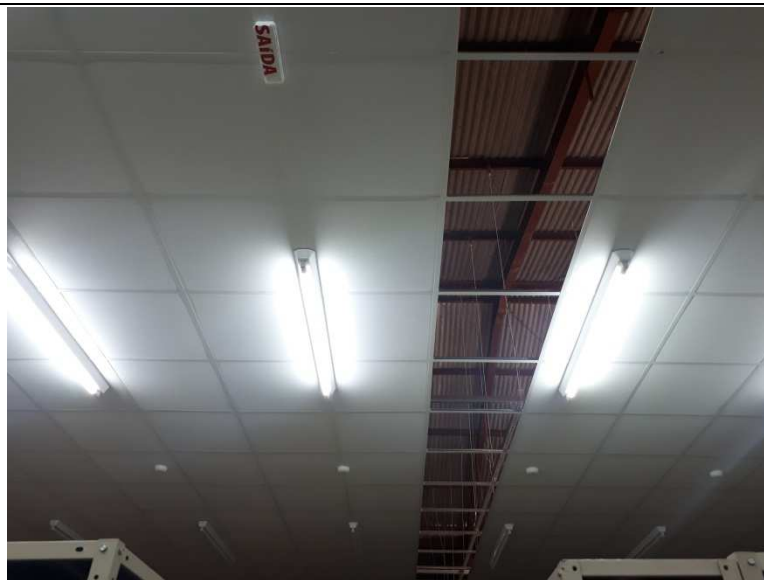
Figura 11 - Forro removível do Arquivo.
