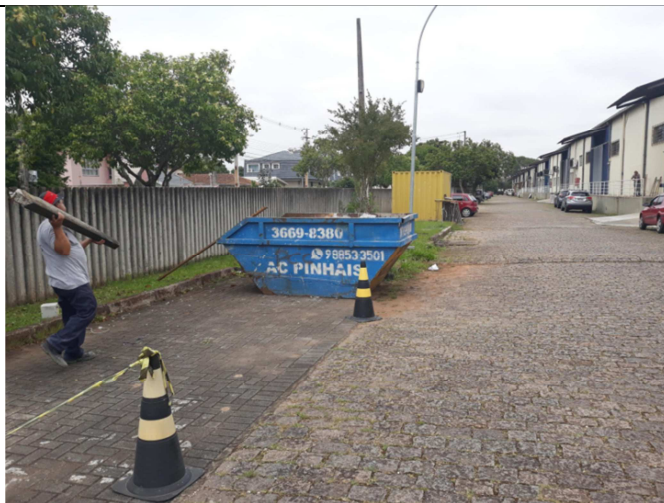
Figura 04 - Caçamba de entulho
