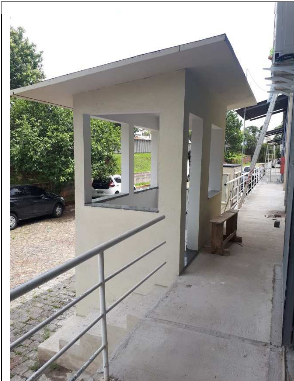
Figura 07 - Concretagem da guarita finalizada.
