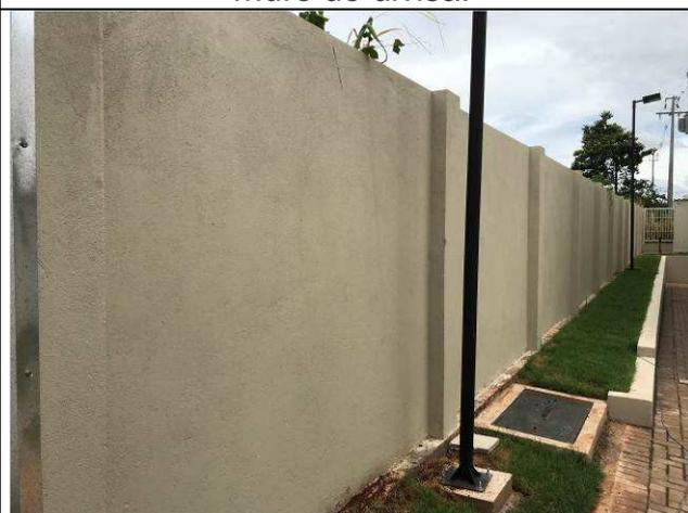
Figura 108C: Pintura na face interna do muro de divisa.
