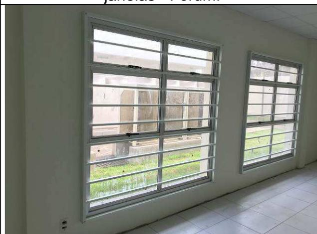
Figura 14C: Grades de proteção das janelas - Fórum.
