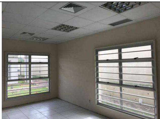
Figura 15C: Grades de proteção das janelas - Fórum.
