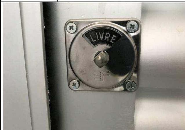
Figura 05C: Portas de alumínio - banheiros públicos - detalhe fechadura.
