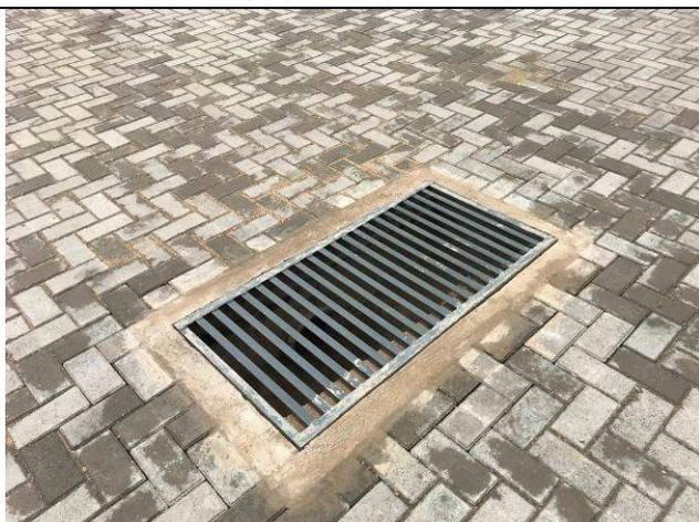
Figura 68C: Caixas de inspeção com grelha
