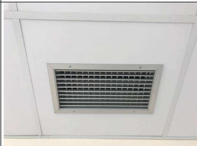
Figura 78C: Grelhas internas de retorno no forro - Fórum.
