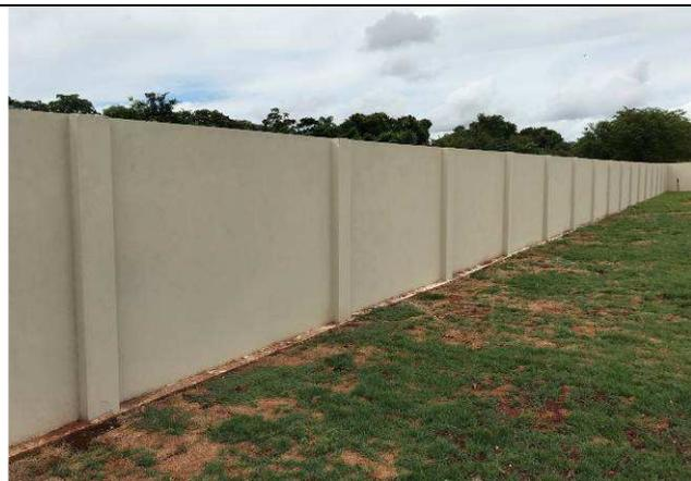
Figura 105C: Pintura na face interna do muro de divisa.
