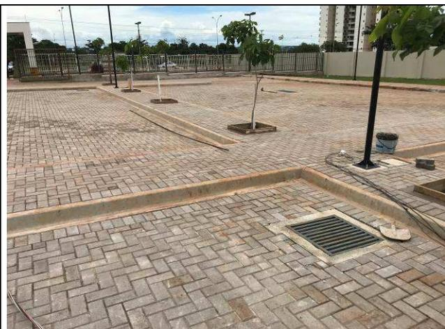
Figura 70C: Caixas de inspeção com grelha - águas pluviais.
