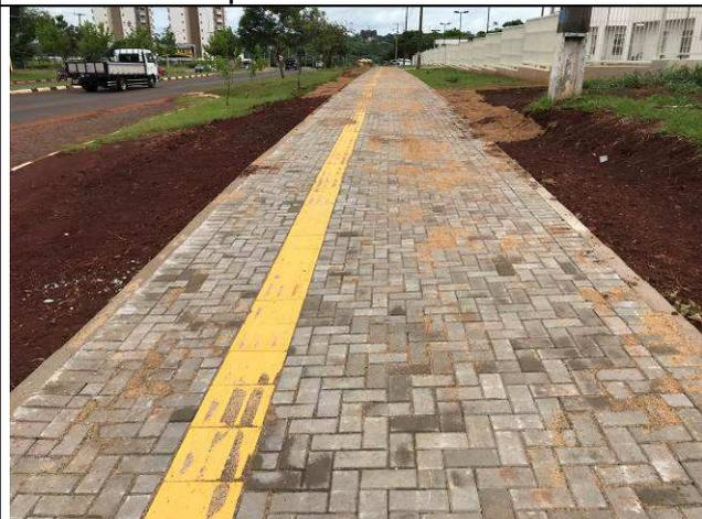
Figura 98C: Calçada externa com piso podotátil.
