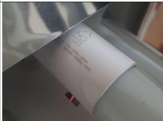
Figura 08E: lâmpadas 10W tubulares
