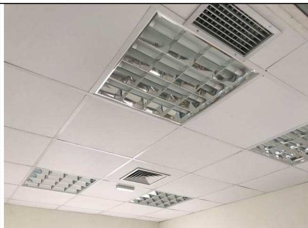
Figura 79C: Grelhas internas de insuflamento e retorno no forro - Fórum.
