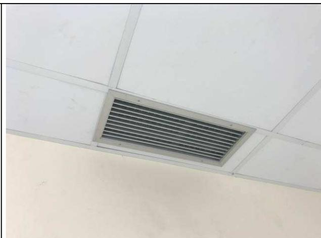
Figura 76C: Grelhas internas de retorno no forro - Fórum.
