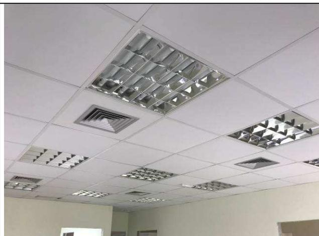
Figura 77C: Grelhas internas de insuflamento no forro - Fórum.
