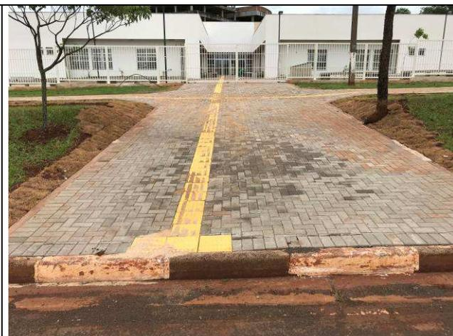
Figura 100C: Calçada externa com piso podotátil - Acesso de pedestres.
