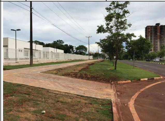
Figura 102C: Calçada externa com piso podotátil.
