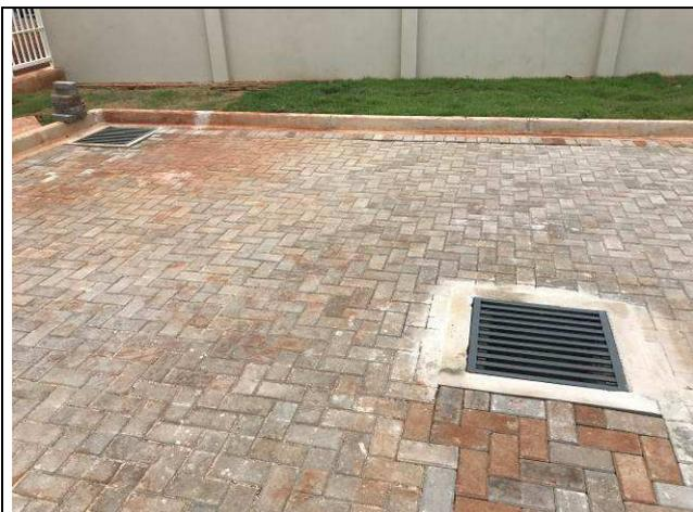
Figura 69C: Caixas de inspeção com grelha - águas pluviais.
