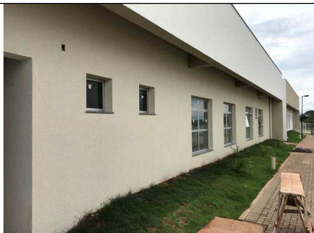
Figura 123C: Textura em paredes externas - Fórum.
