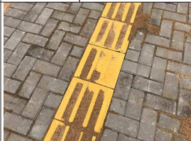
Figura 104C: Calçada externa com piso podotátil.
