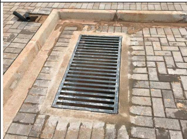
Figura 67C: Caixas de inspeção com grelha
