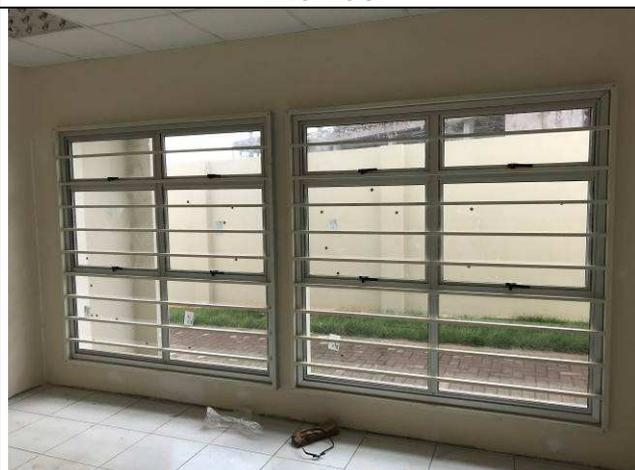
Figura 11C: Grades de proteção das janelas - Fórum.
