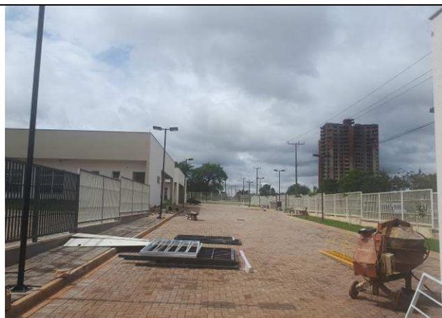
Figura 11E: iluminação externa - postes tipo pétala
