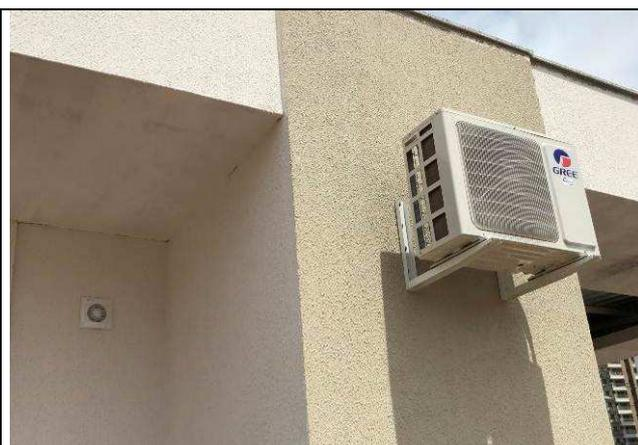
Figura 72C: Condensadora 9.000 BTU's e exaustor - Guarita.
