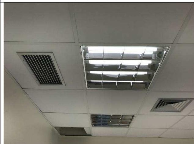
Figura 80C: Grelhas internas de insuflamento e retorno no forro - Fórum.
