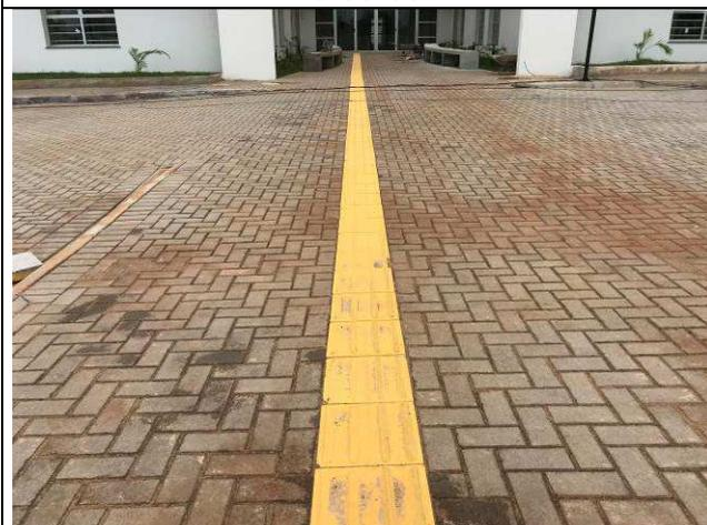
Figura 103C: Calçada interna com piso podotátil.
