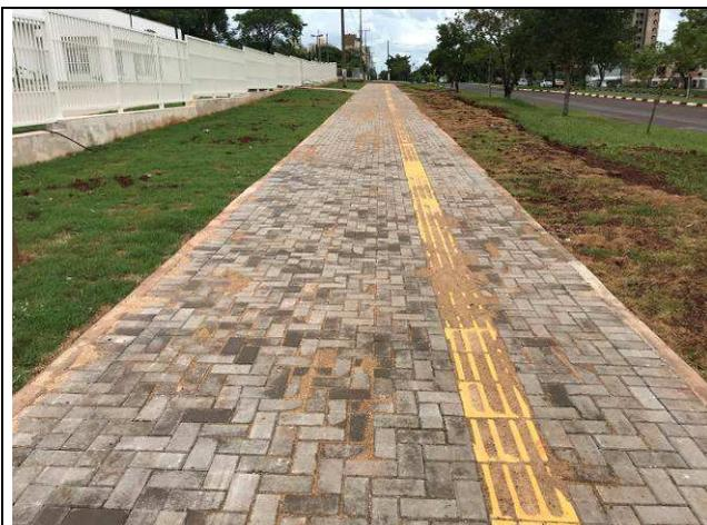
Figura 99C: Calçada externa com piso podotátil.
