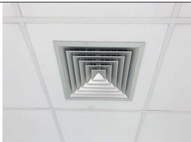
Figura 75C: Grelhas internas de insuflamento no forro - Fórum.
