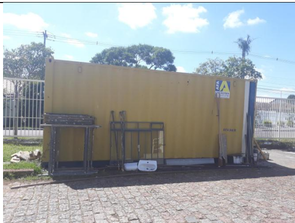
Figura 01 - Container alugado para escritório da obra.
