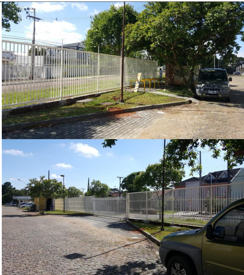
Figuras 11- Gradis de fechamento de terreno.
