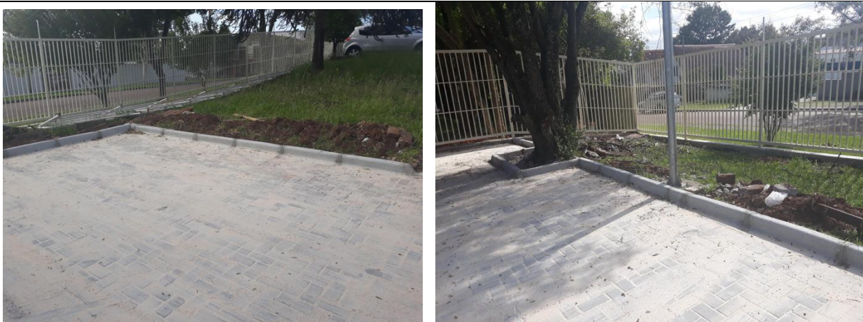
Figuras 10: Confeção de meio-fio em concreto no estacionamento da Área de Vivência.
