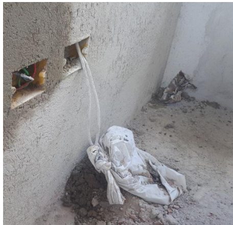
Figura 04E - cabeamento para ponto lógico da guarita.
