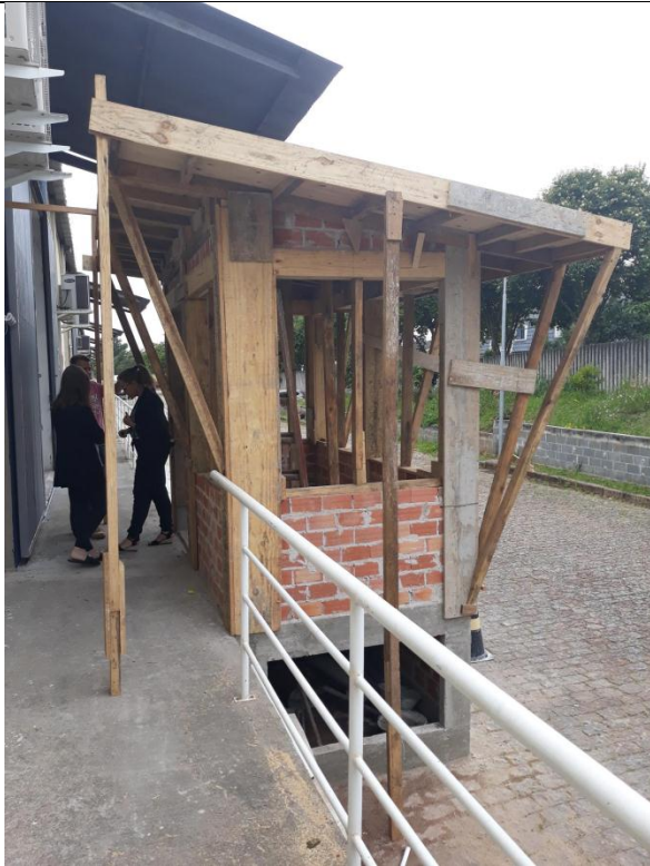
Figuras 08 - Execução de fôrmas e concretagem das vigas, dos pilares e laje da Guarita da Plataforma.
