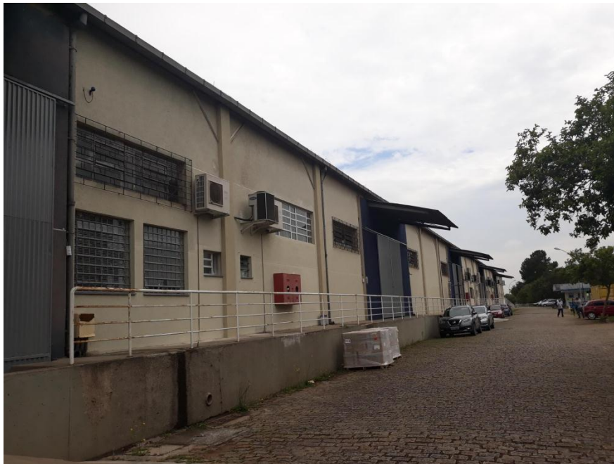
Figuras 18 - Pintura da fachada principal.
