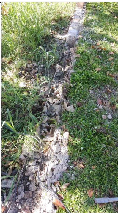
Figuras 06: Demolição das vigas baldrame sob os muros palitos.
