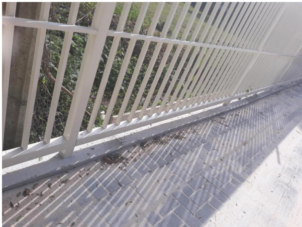
Figuras 07 - Execução de baldrame em concreto sob o gradil.
