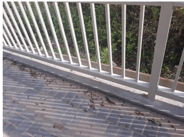
Figuras 07 - Execução de baldrame em concreto sob o gradil.
