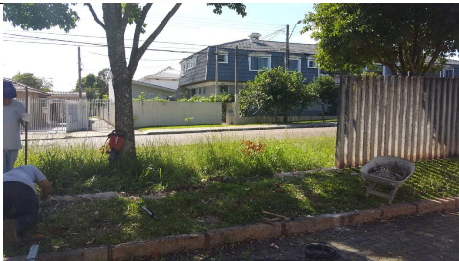
Figura 05: Pilaretes removidos para colocação de gradil.
