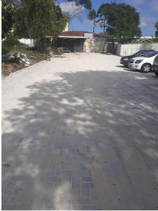
Figura 09: Compactação da base e assentamento do piso intertravado no estacionamento da Área da Vivência.
