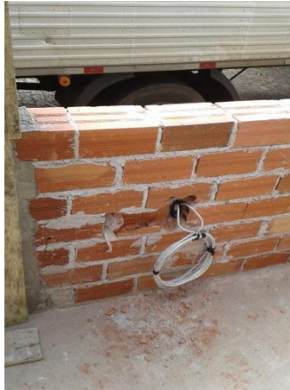
Figura 04E - cabeamento para ponto lógico da guarita.
