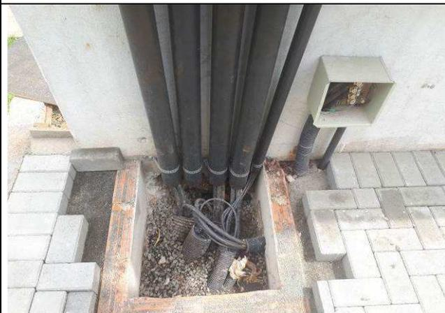
Figura 03E: entrada de energia ramal QDG incêndios
