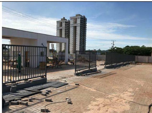
Figura 58C: Pavimentação intertravada - estacionamento.
