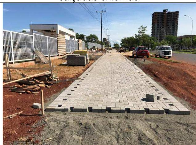
Figura 65C: Pavimentação intertravada - calçadas externas.
