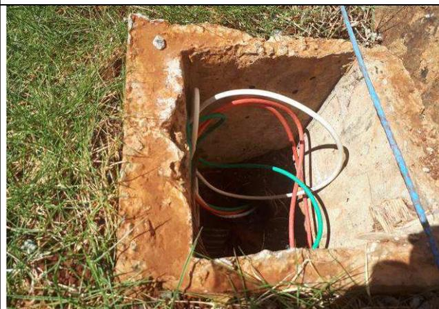
Figura 06E: cabeamento elétrico iluminação externa e portões eletrônicos
