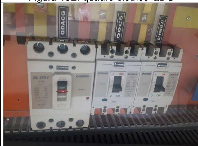
Figura 21E: quadro elétrico QDG
