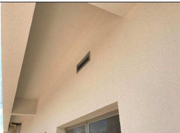
Figura 51C: Venezianas externas, com filtro, para o sistema de renovação de ar.
