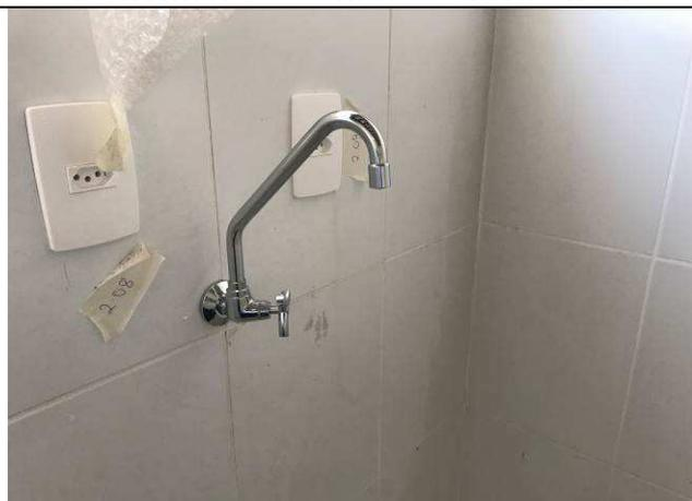
Figura 35C: Torneira de pressão de parede para pia - copa 2ª VT.
