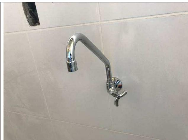
Figura 34C: Torneira de pressão de parede para pia - copa Arquivo.
