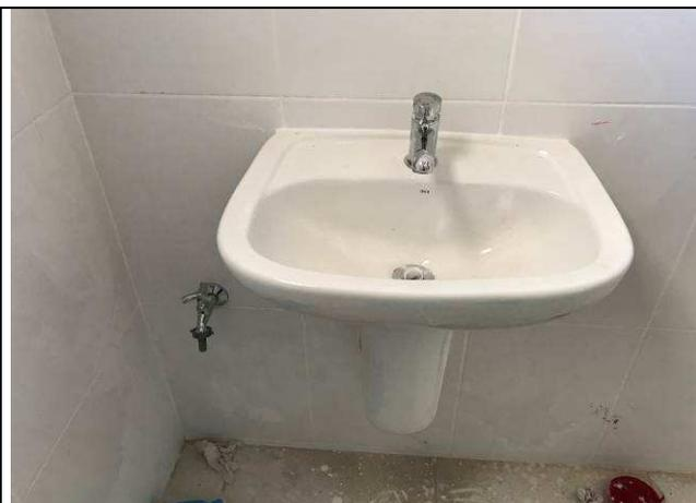
Figura 10C: Lavatório com coluna suspensa para banheiros adaptados.
