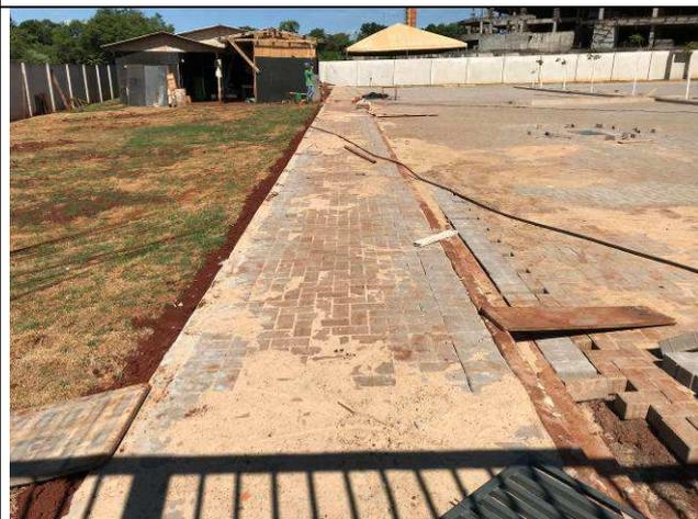
Figura 59C: Pavimentação intertravada - calçadas internas.
