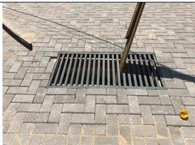
Figura 45C: Grelhas de caixas de inspeção de águas pluviais.
