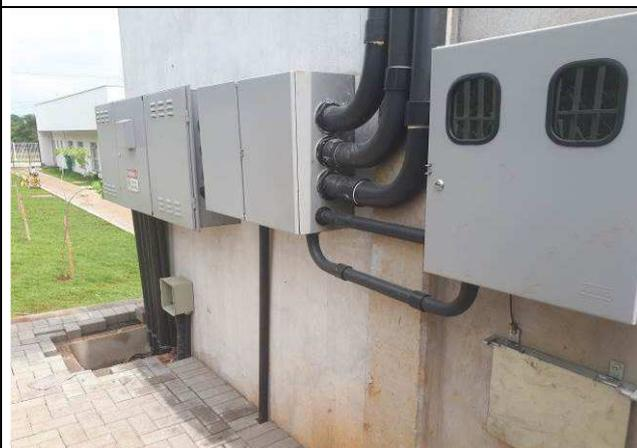
Figura 05E: entrada de energia ramal QDG incêndios
