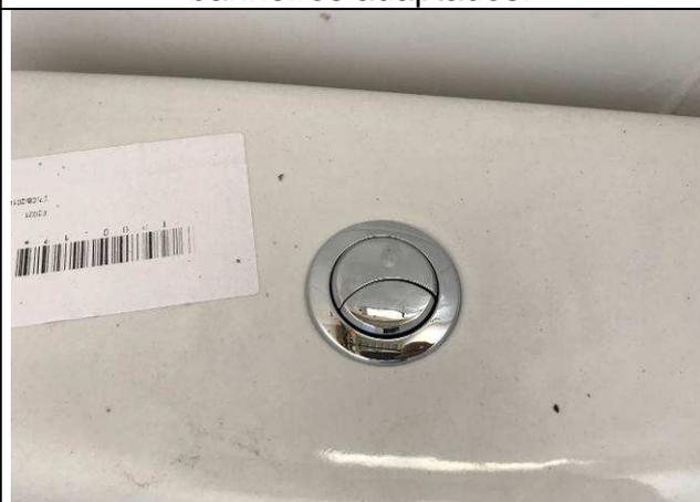
Figura 44C: Duplo botão de acionamento para as acopladas.
