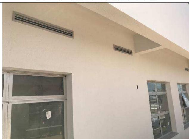
Figura 52C: Venezianas externas, com filtro, para o sistema de renovação de ar.
