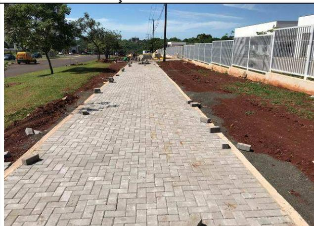
Figura 62C: Pavimentação intertravada - calçadas externas.
