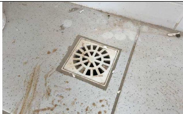
Figura 03C: Ralos (grelha branca) em caixas sifonadas.
