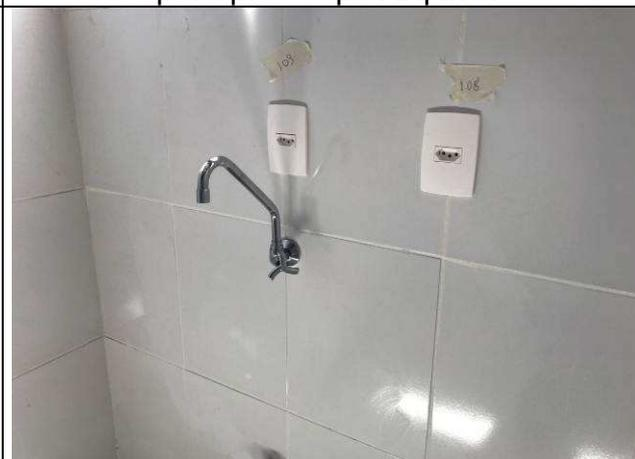
Figura 36C: Torneira de pressão de parede para pia - copa 1ª VT.
