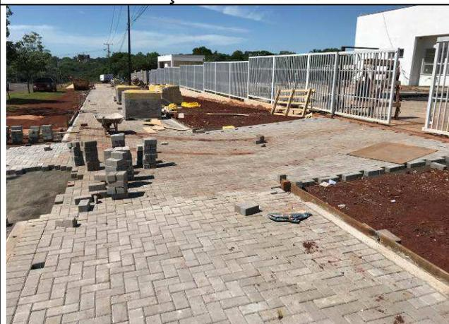
Figura 63C: Pavimentação intertravada - calçadas externas.
