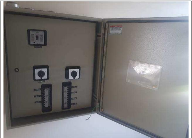
Figura 26E: Quadro elétrico QDEG
