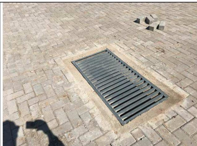
Figura 46C: Grelhas de caixas de inspeção de águas pluviais.
