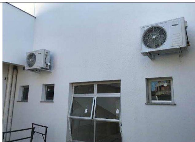
Figura 50C: Condensadoras de 22.000 BTU's - salas técnicas 1 e 2.
