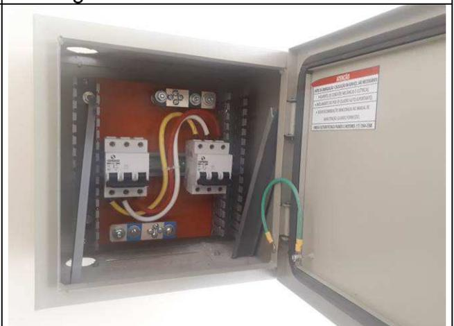
Figura 28E: Quadro elétrico QDG-INC
