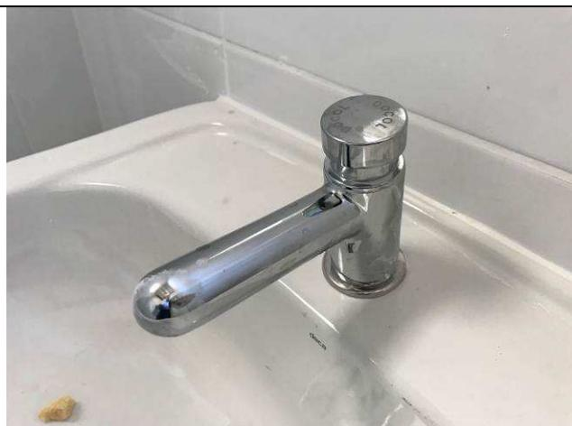
Figura 33C: Torneira de pressão com fechamento automático - lavatórios.
