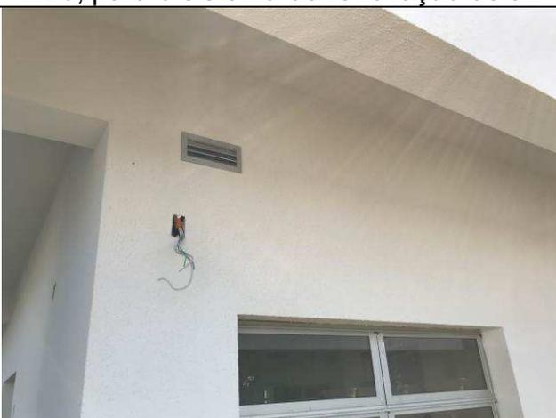
Figura 53C: Venezianas externas, com filtro, para o sistema de renovação de ar.
