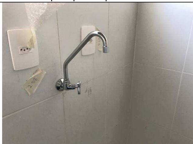
Figura 37C: Torneira de pressão de parede para pia - copa 3ª VT.
