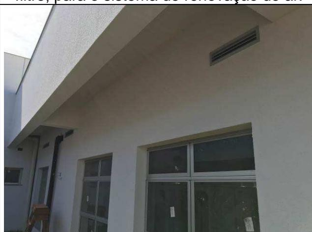
Figura 54C: Venezianas externas, com filtro, para o sistema de renovação de ar.
