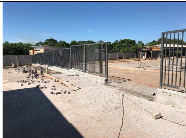
Figura 57C: Pavimentação intertravada - estacionamento.
