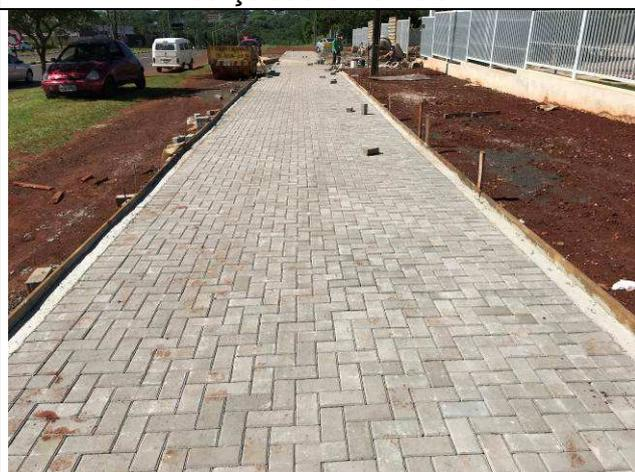
Figura 64C: Pavimentação intertravada - calçadas externas.
