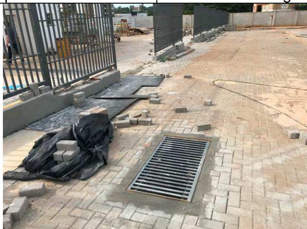
Figura 47C: Grelhas de caixas de inspeção de águas pluviais.
