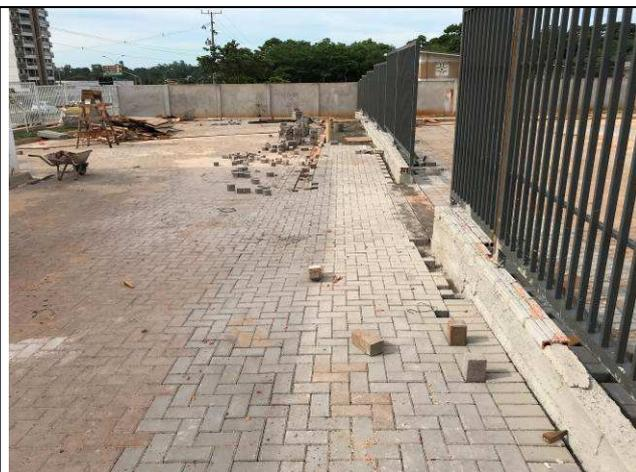
Figura 61C: Pavimentação intertravada - calçadas internas.
