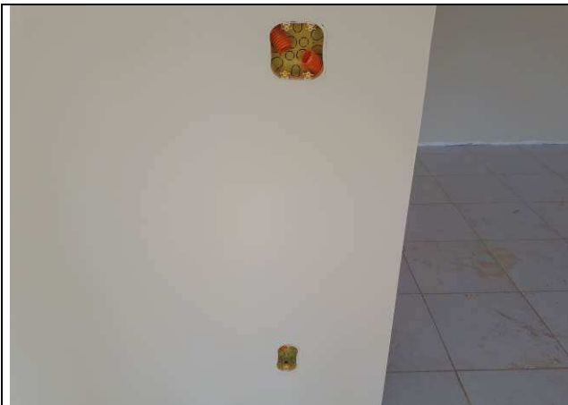
Figura 01E: infraestrutura interna - eletrodutos, caixas drywall.
