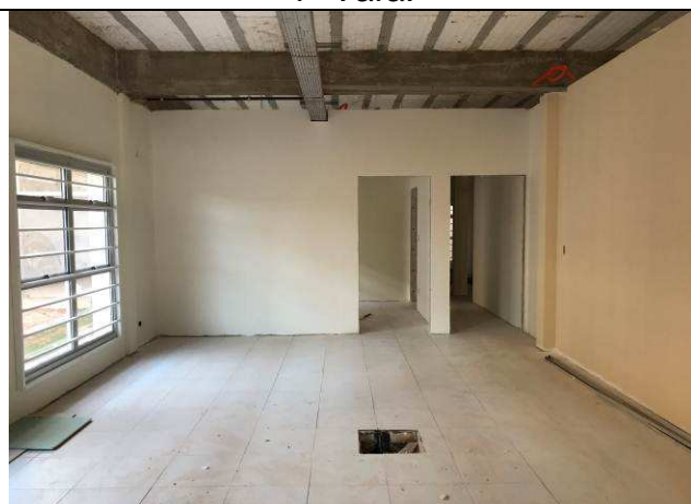
Figura 11C: Paredes de gesso acartonado - 1ª Vara.
