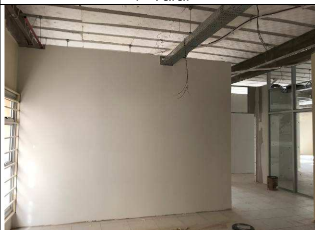
Figura 12C: Paredes de gesso acartonado - 2ª Vara.
