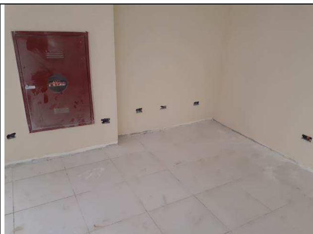
Figura 08E: infraestrutura interna - eletrodutos, caixas drywall.
