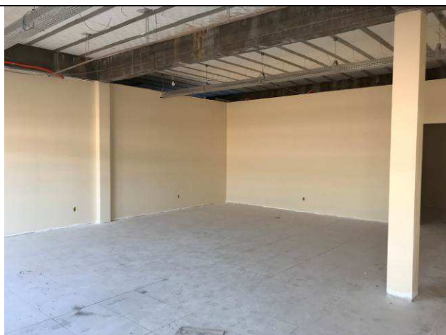
Figura 87C: Pintura - Sala Múltiplo Uso.
