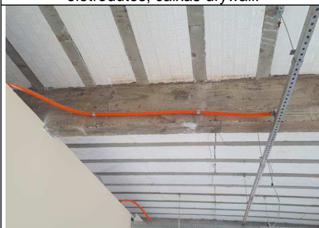
Figura 05E: infraestrutura interna - eletrodutos, caixas drywall.
