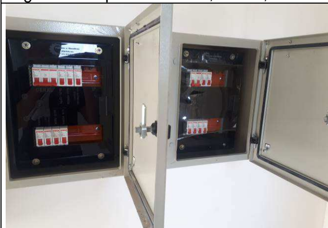
Figura 17E: quadros QDC4, QDE4, QDIL4.
