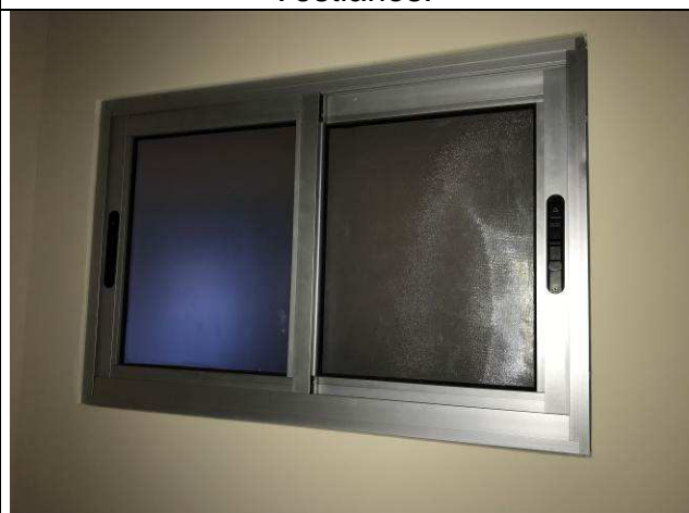
Figura 37C: Janelas em alumínio - Vestiários.
