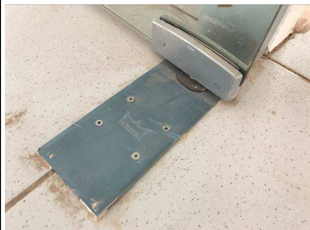
Figura 28C: Portas de Vidro Temperado - Molas de piso.
