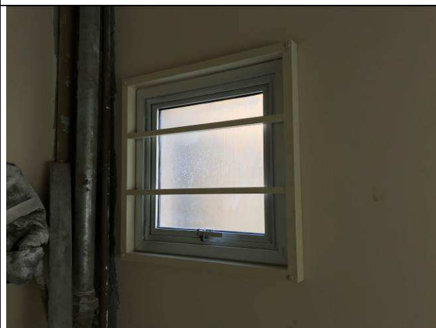
Figura 52C: Gradis de proteção.
