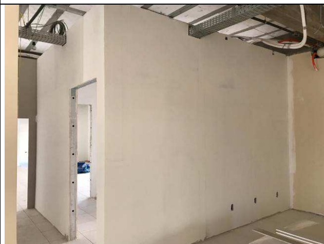
Figura 14C: Paredes de gesso acartonado - 2ª Vara.
