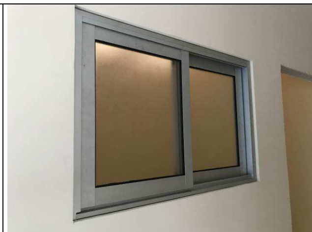
Figura 36C: Janelas em alumínio - Vestiários.
