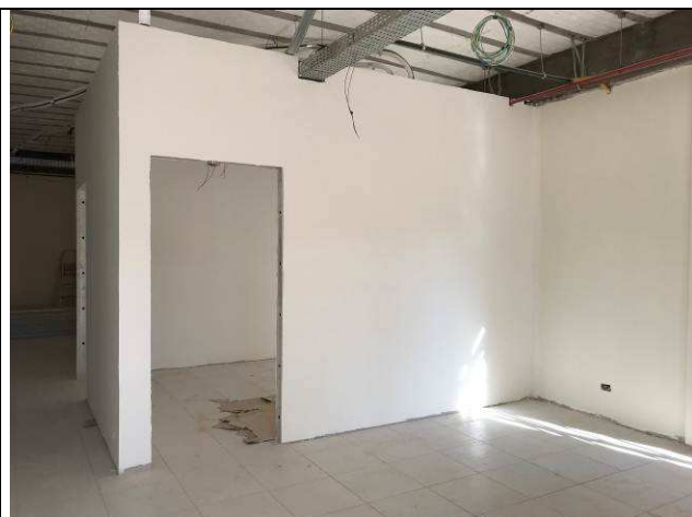
Figura 16C: Paredes de gesso acartonado - 2ª Vara.
