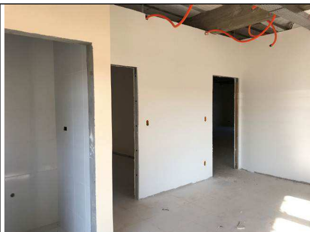
Figura 10C: Paredes de gesso acartonado - 1ª Vara.
