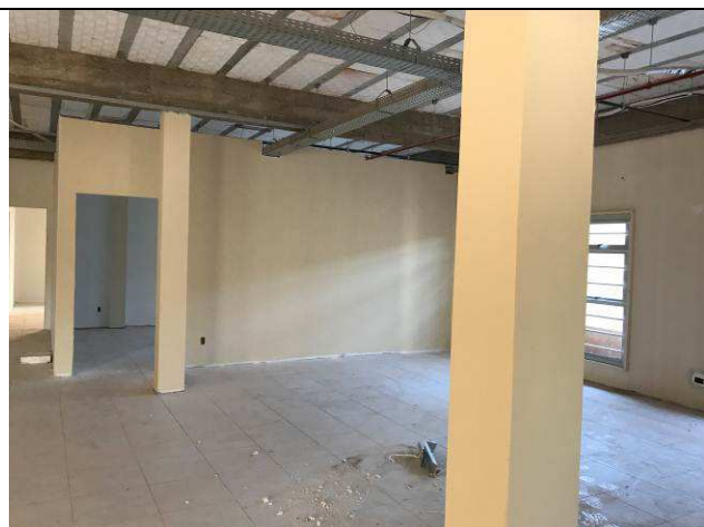
Figura 09C: Paredes de gesso acartonado - 1ª Vara.
