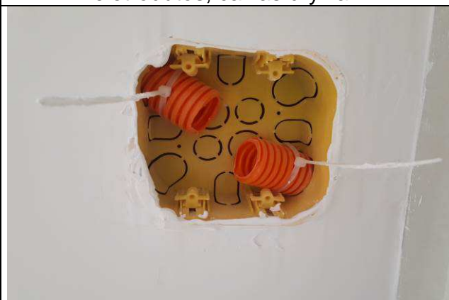
Figura 04E: infraestrutura interna - eletrodutos, caixas drywall.
