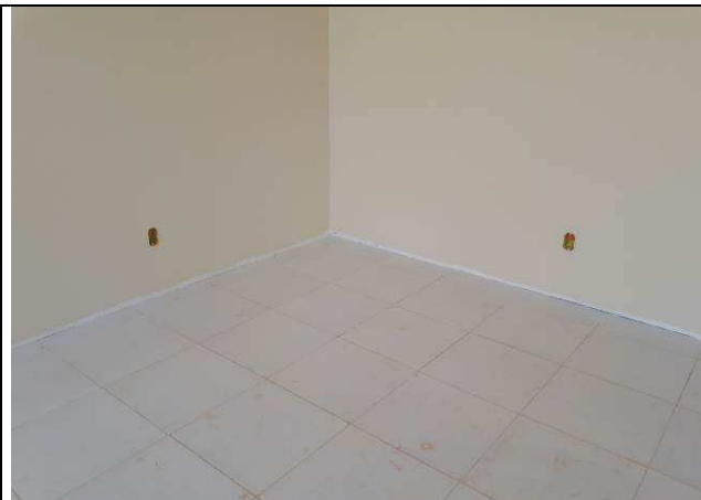
Figura 02E: infraestrutura interna - eletrodutos, caixas drywall.
