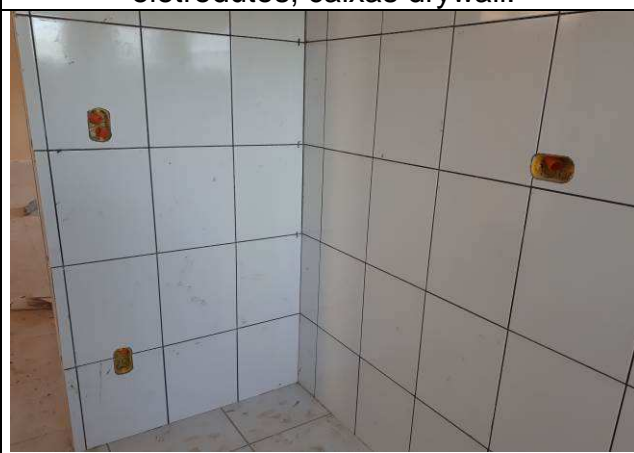
Figura 06E: infraestrutura interna - eletrodutos, caixas drywall.
