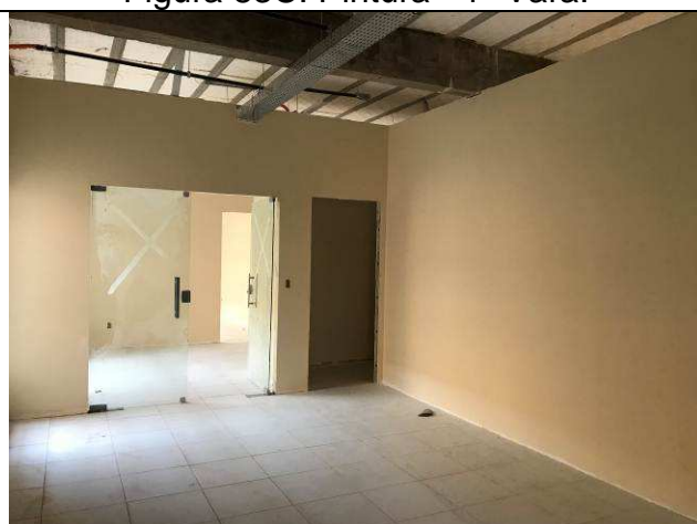
Figura 85C: Pintura - Hall da Sala Múltiplo Uso.
