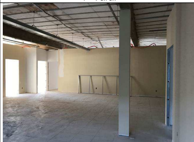
Figura 08C: Paredes de gesso acartonado - 1ª Vara.
