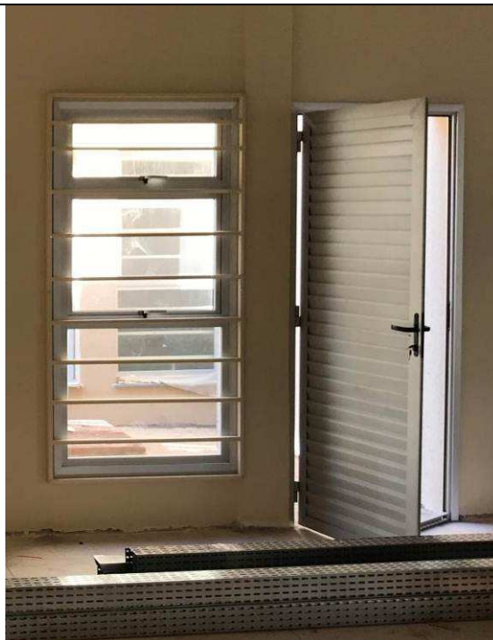
Figura 22C: Porta de Alumínio - entrada lateral do Hall central.
