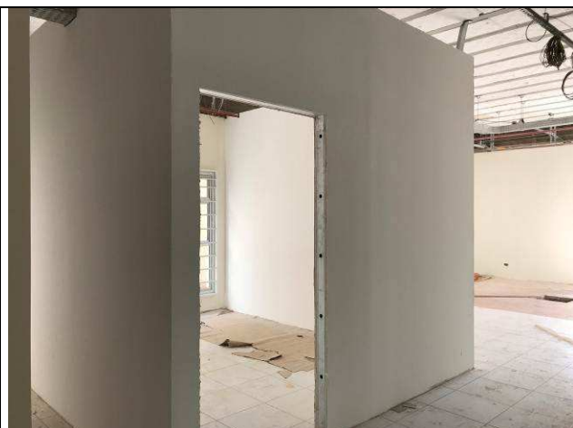
Figura 15C: Paredes de gesso acartonado - 2ª Vara.
