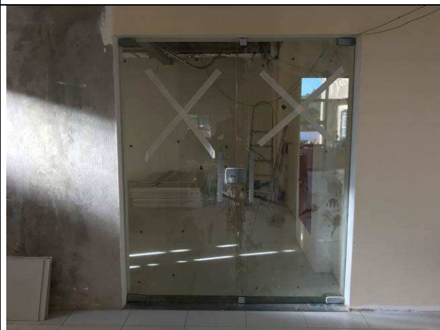
Figura 34C: Portas de Vidro Temperado - Entrada 2ª Vara.
