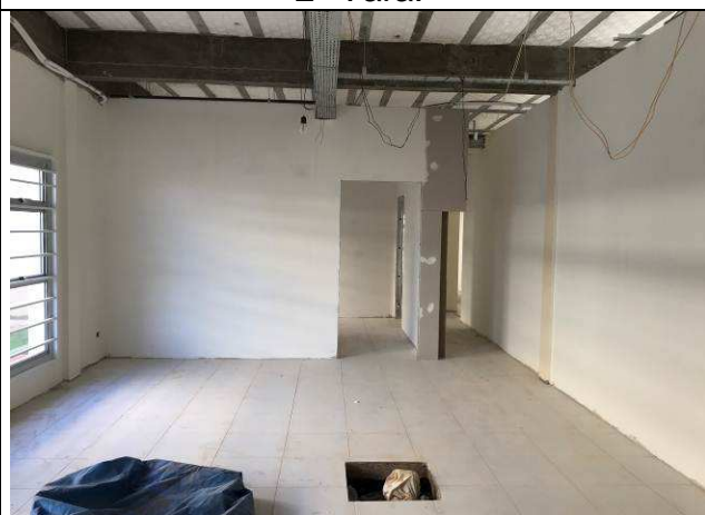
Figura 18C: Paredes de gesso acartonado - 2ª Vara.
