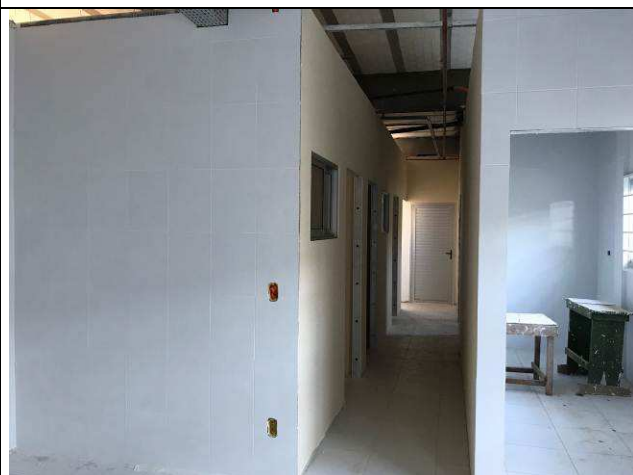
Figura 20C: Paredes de gesso acartonado - 2ª Vara.
