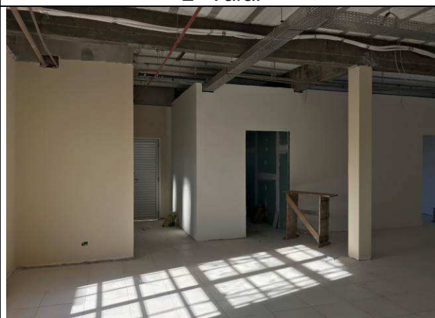
Figura 17C: Paredes de gesso acartonado - 2ª Vara.
