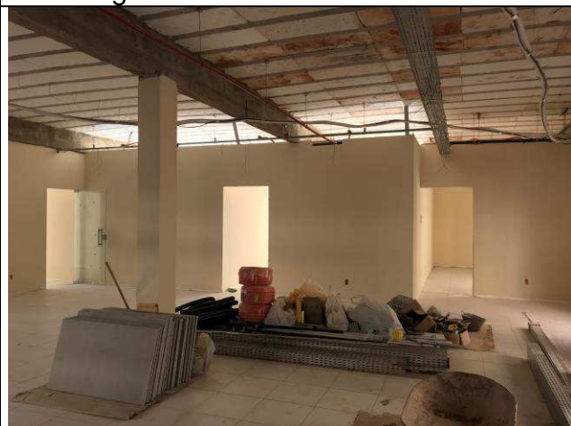
Figura 78C: Pintura - Distribuição, sala de perícias e OAB.
