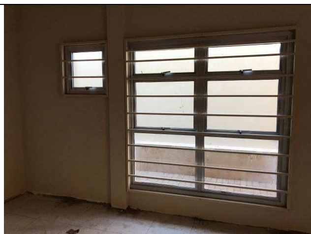
Figura 45C: Gradis de proteção.
