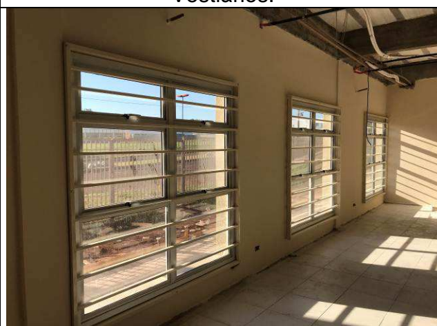
Figura 39C: Gradis de proteção.
