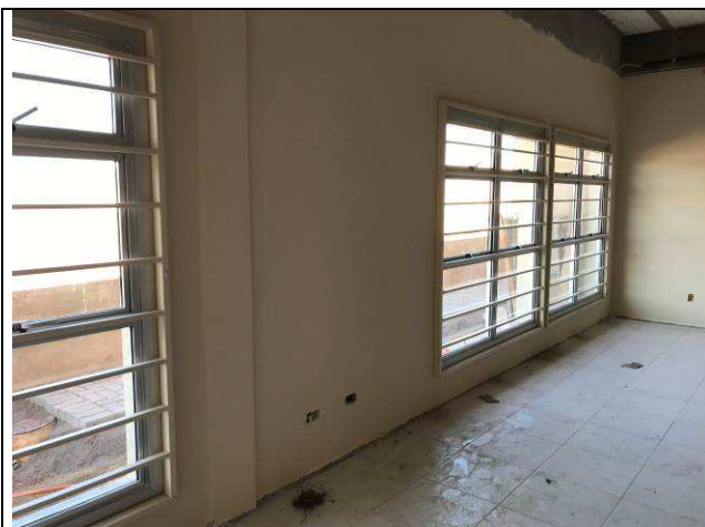
Figura 47C: Gradis de proteção.
