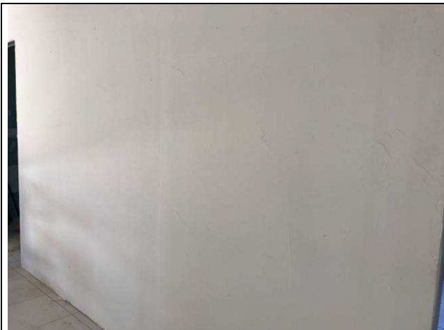
Figura 75C: Emassamento das paredes de gesso acartonado - 2ª Vara.
