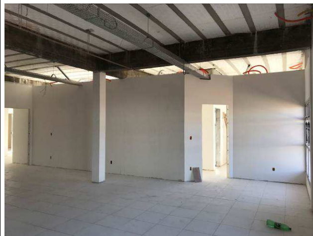
Figura 02C: Paredes de gesso acartonado - Auditório.
