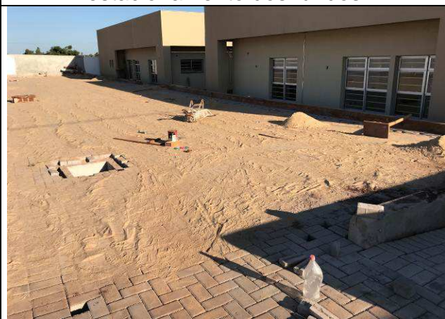
Figura 68C: Pavimentação intertravada - estacionamento dos fundos.
