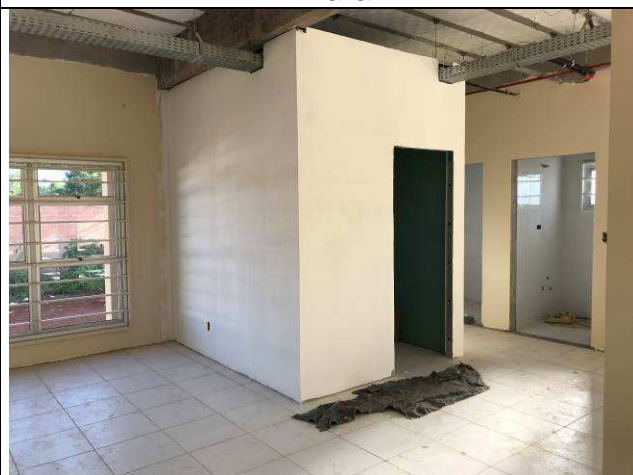
Figura 19C: Paredes de gesso acartonado - 2ª Vara.
