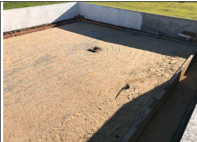
Figura 66C: Pavimentação intertravada - estacionamento dos fundos.
