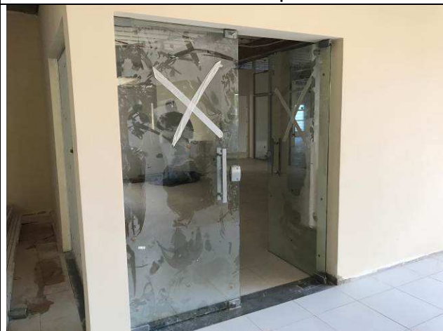
Figura 32C: Portas de Vidro Temperado - Entrada 1ª Vara.
