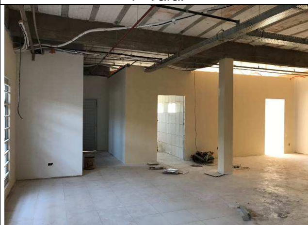
Figura 07C: Paredes de gesso acartonado - 1ª Vara.
