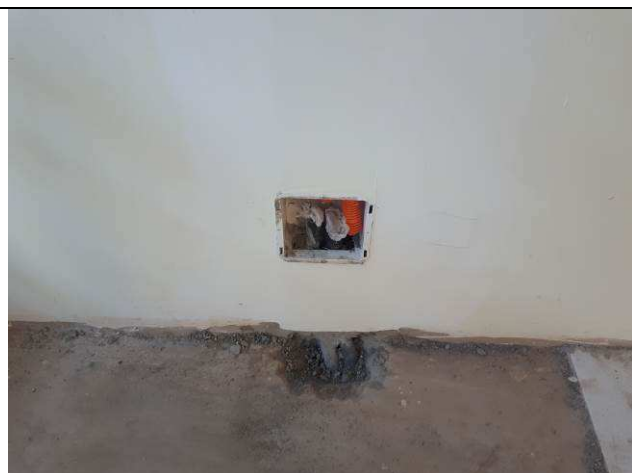
Figura 07E: infraestrutura interna - eletrodutos, caixas drywall.
