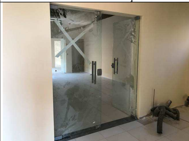
Figura 33C: Portas de Vidro Temperado - Entrada Hall do Auditório.
