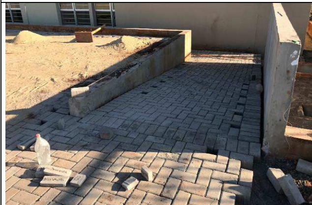
Figura 69C: Pavimentação intertravada - rampa estacionamento dos fundos.
