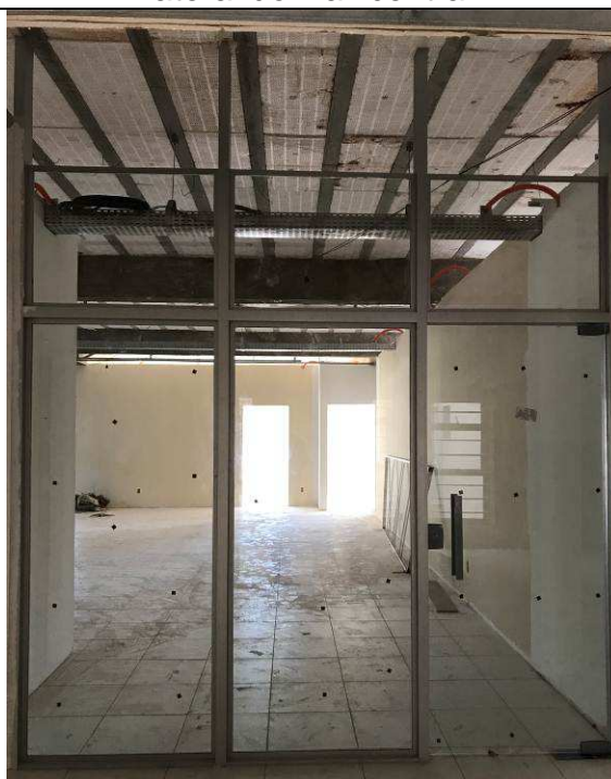
Figura 24C: Portas e painéis de vidro temperado - Balcão da 1ª Vara.
