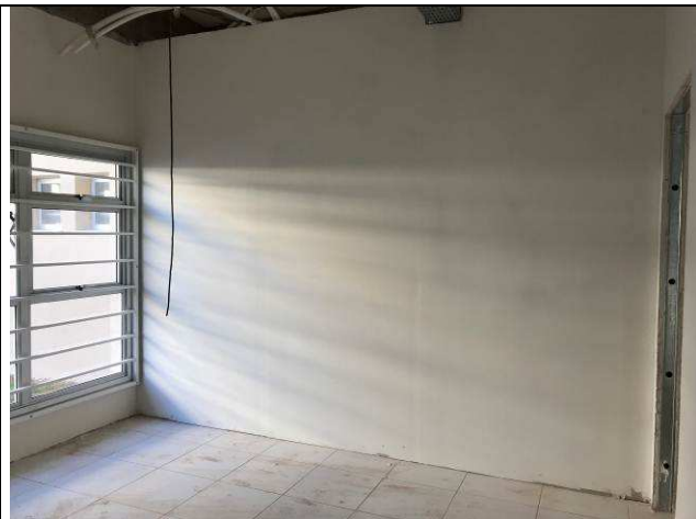
Figura 76C: Emassamento das paredes de gesso acartonado - 2ª Vara.
