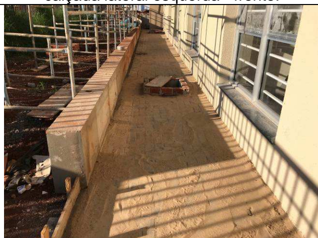
Figura 73C: Pavimentação intertravada - calçada lateral esquerda - frente.
