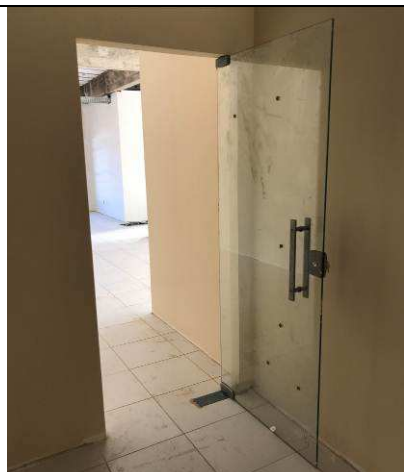
Figura 31C: Portas de Vidro Temperado - Entrada da Distribuição.
