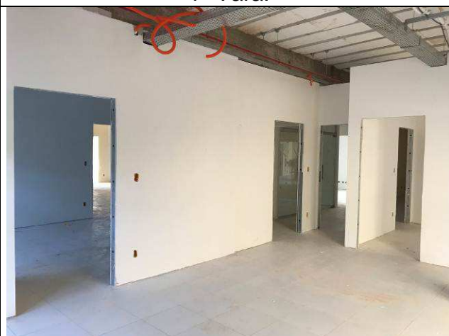
Figura 06C: Paredes de gesso acartonado - 1ª Vara.
