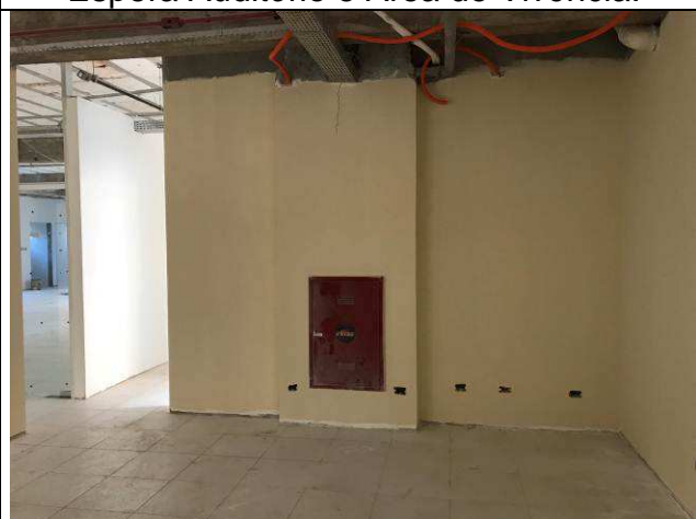
Figura 05C: Paredes de gesso acartonado - 1ª Vara.
