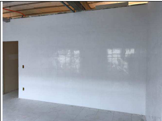
Figura 54C: Azulejos - Copa Terceirizados.
