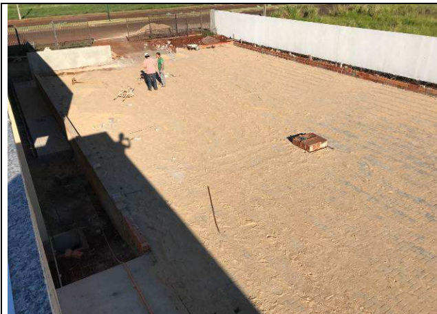
Figura 65C: Pavimentação intertravada - estacionamento dos fundos.
