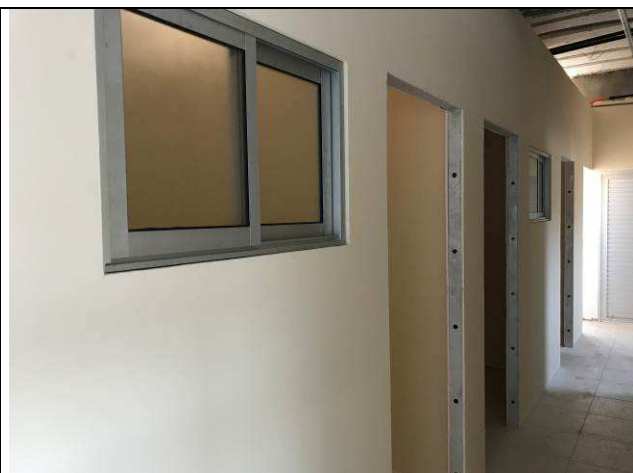
Figura 35C: Janelas em alumínio - Vestiários.
