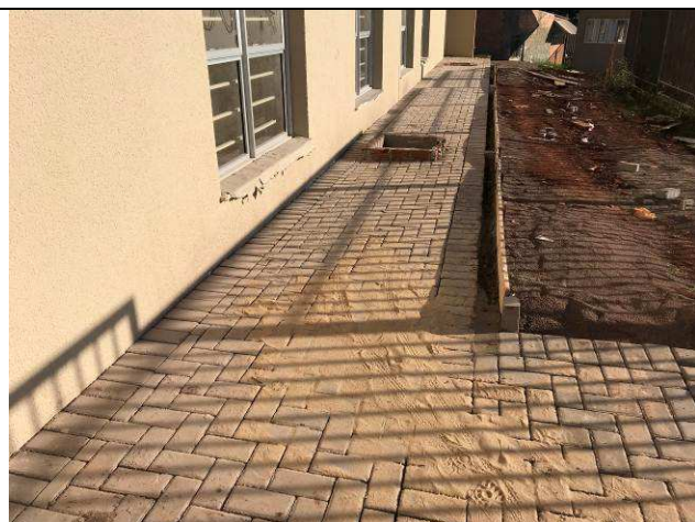
Figura 71C: Pavimentação intertravada - calçada lateral esquerda - frente.
