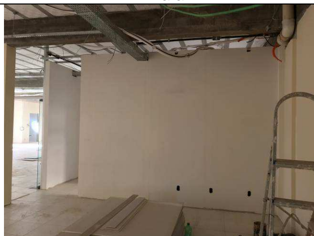
Figura 13C: Paredes de gesso acartonado - 2ª Vara.
