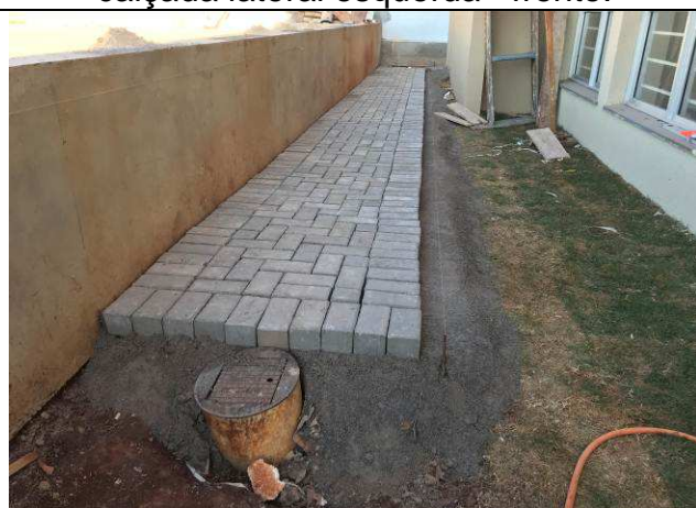
Figura 73C: Pavimentação intertravada - calçada fundos - direita.
