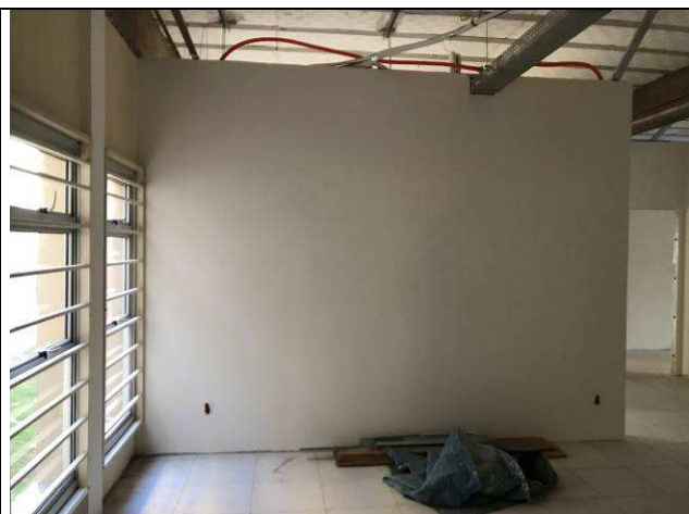
Figura 04C: Paredes de gesso acartonado - 1ª Vara.
