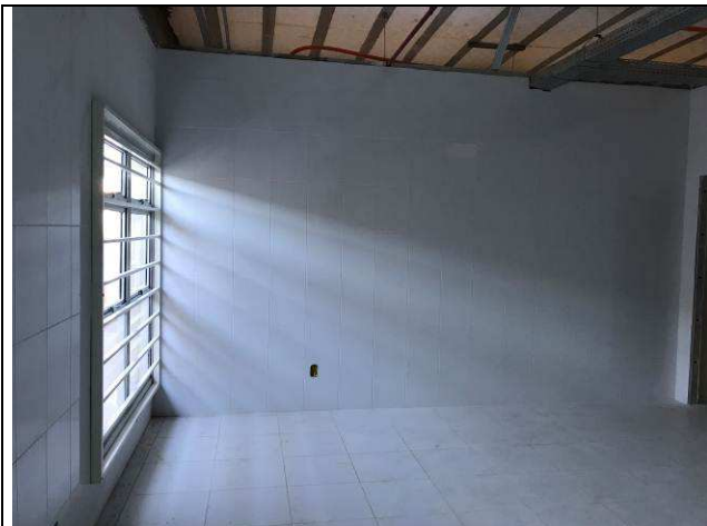
Figura 53C: Azulejos - Copa Terceirizados.
