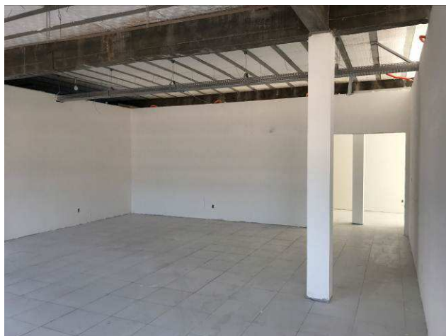
Figura 01C: Paredes de gesso acartonado - Auditório.
