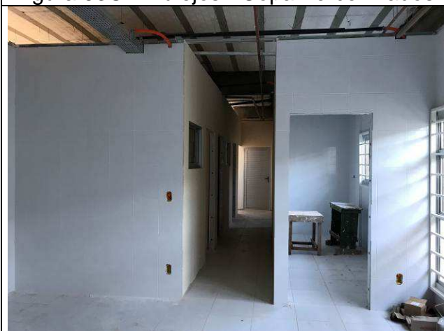
Figura 55C: Azulejos - Copa Terceirizados.
