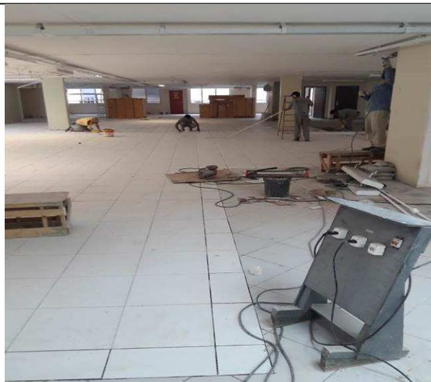
Figura 06C:Assentamento do piso cerâmico.
