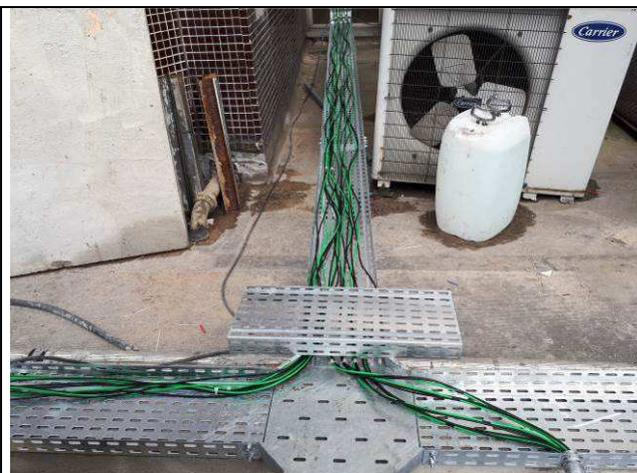
Figura 19E: infraestrutura e circuitos para condicionadores de ar - frente anexo.
