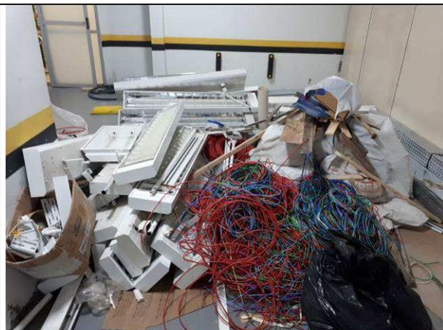
Figura 01E: retirada instalações elétricas e cabeamento estruturado 19ª e 20ªVT
