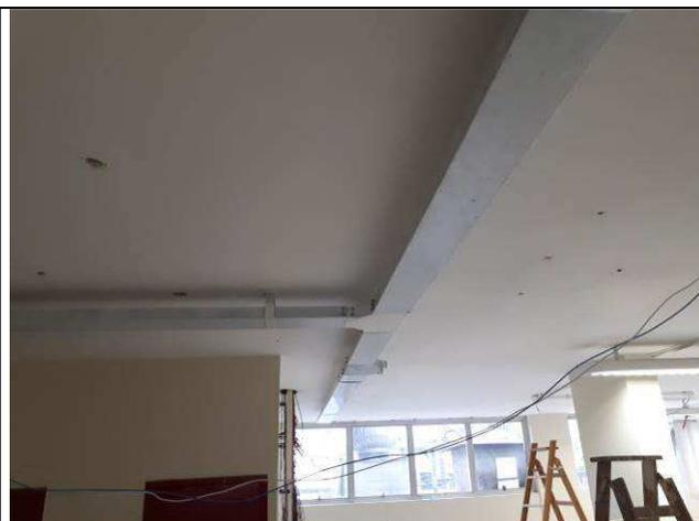
Figura 04E: instalação de infraestrutura - eletrocalhas e perfilados - 19ª e 20ª VT
