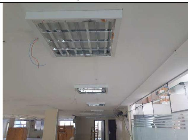
Figura 06E: instalação de eletrodutos, condutes e luminárias 4x16W 19ª e 20ª VT
