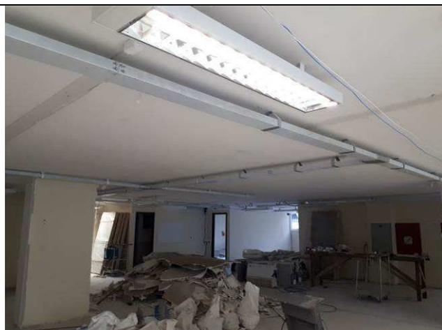
Figura 03E: instalação de infraestrutura - eletrocalhas e perfilados - 19ª e 20ª VT
