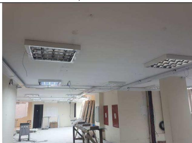
Figura 05E: instalação de eletrodutos, condutes e luminárias 4x16W 19ª e 20ª VT
