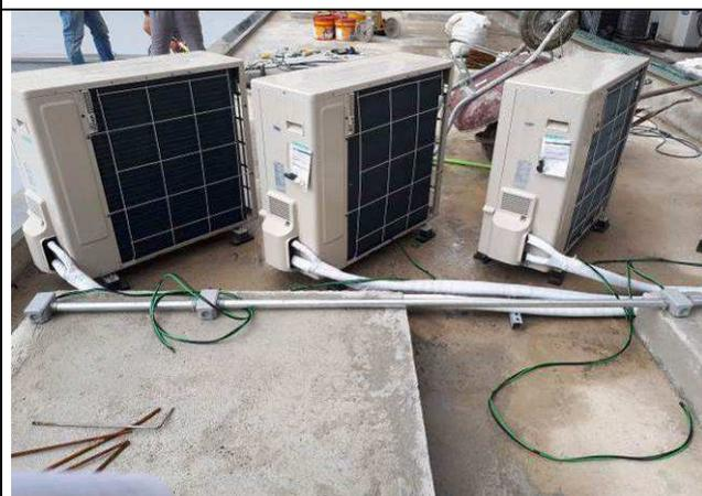
Figura 21E: infraestrutura e circuitos para condicionadores de ar - frente anexo.
