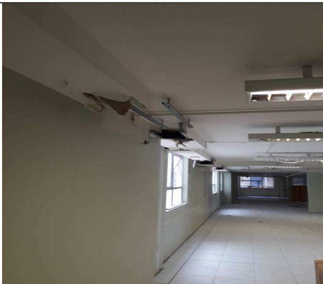
Figura 05C:Equipamentos de ar condicionado retirados.
