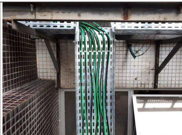
Figura 20E: infraestrutura e circuitos para condicionadores de ar - frente anexo.
