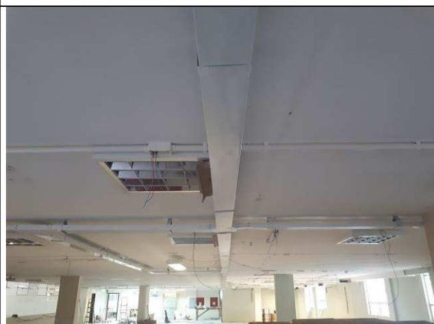
Figura 08E: instalação de eletrodutos, condutes e luminárias 4x16W 19ª e 20ª VT
