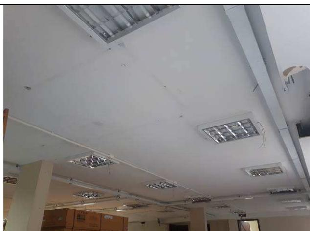
Figura 07E: instalação de eletrodutos, condutes e luminárias 4x16W 19ª e 20ª VT
