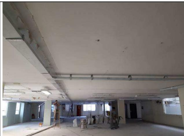
Figura 02E: instalação de infraestrutura - eletrocalhas e perfisados - 19ª e 20ª VT
