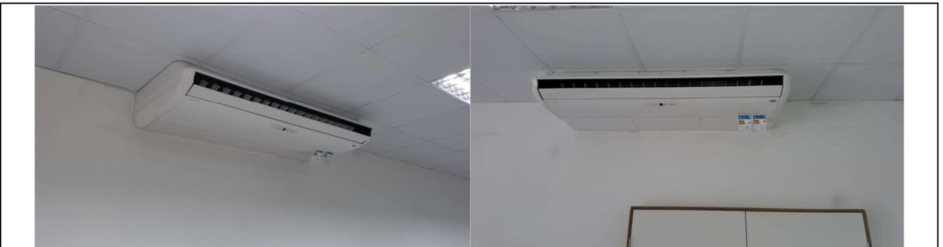
Figuras 16: Os dois equipamentos de ar condicionado tipo Split de 4200 Btus da Sala do Almojarifado foram instalados.
