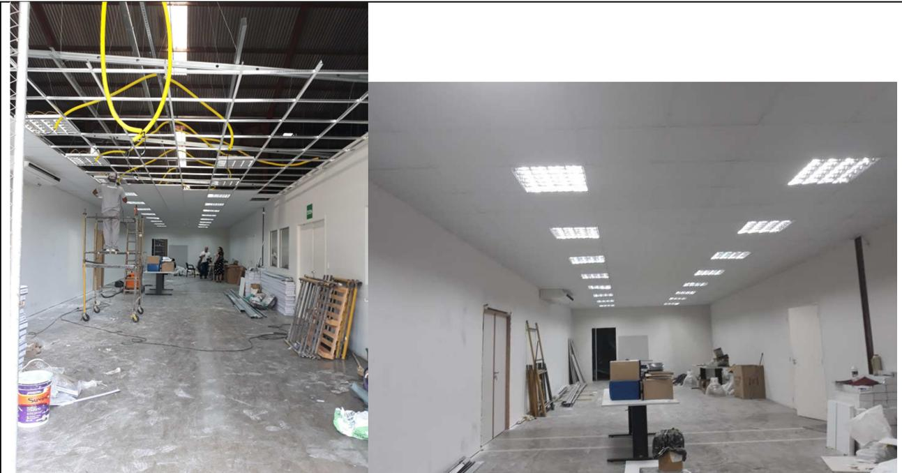
Figura 15 - Instalação de forro removível na Sala do Almojarifado.
