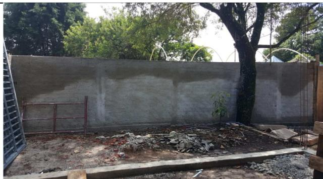
Figura 09 - Execução de muro de divisa nos fundos do terreno.
