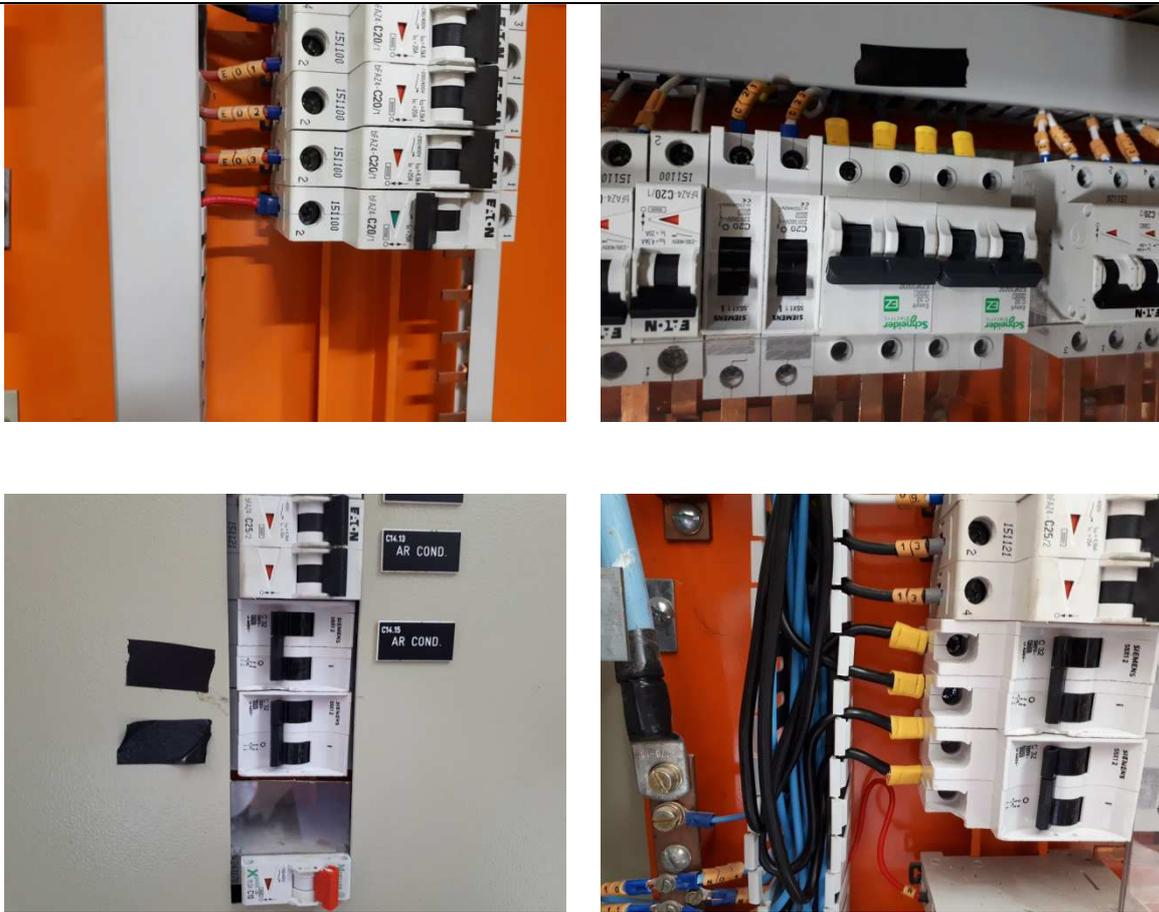
Figura 20 - disjuntores quadros QDE1, QDC5 e QDC14.
