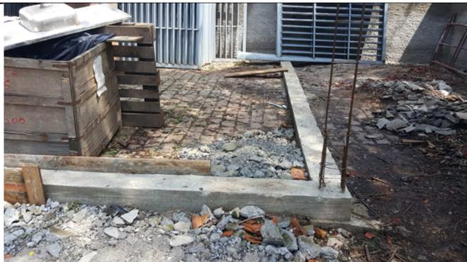
Figura 08: Demolição de baldrame existente e confecção novo baldrame para atender o gradil, o muro novo em alvenaria e a área de vivência.
