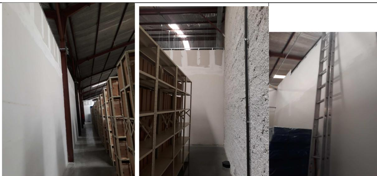
Figuras 11 - Complementação da altura das paredes em gesso acartonado com acréscimo de 80 cm.
