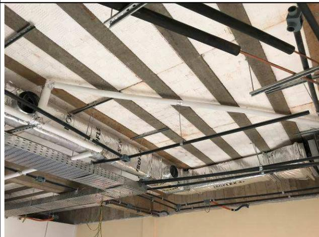
Figura 76C: Rede de drenos internos com isolamento térmico.
