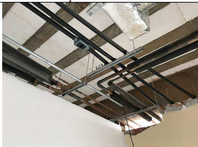
Figura 61C: Rede frigorígena interna - interligação dos ramais principais.
