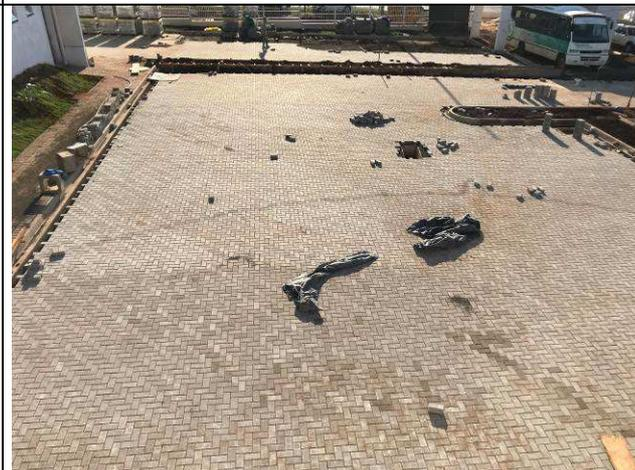
Figura 96C: Pavimentação intertravada dos estacionamentos internos.
