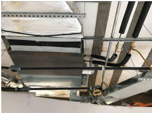
Figura 63C: Rede frigorígena interna - interligação das evaporadoras de 4,0 HP.
