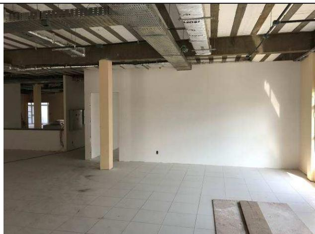
Figura 113C: Paredes internas emassadas
