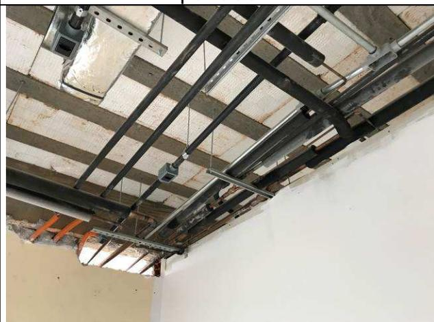
Figura 62C: Rede frigorígena interna - interligação dos ramais principais.
