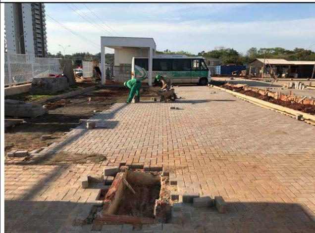
Figura 104C: Pavimentação intertravada dos estacionamentos internos.
