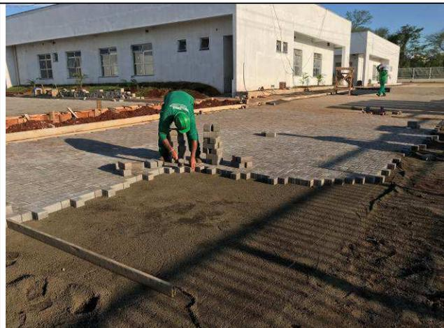
Figura 95C: Execução da pavimentação intertravada dos estacionamentos internos.
