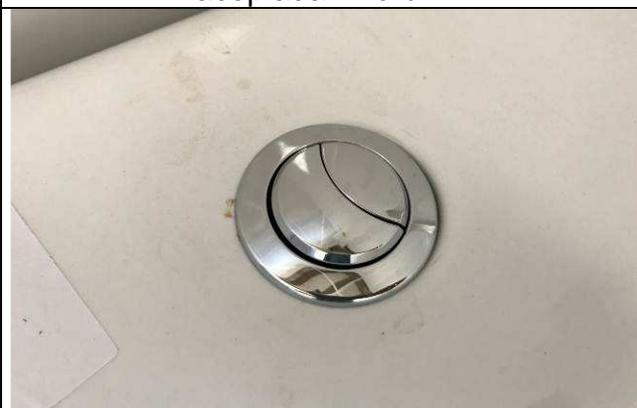
Figura 33C: Detalhe do botão duplo de acionamento da descarga.
