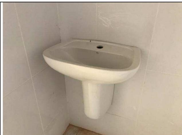
Figura 42C: Lavatório com coluna suspensa - banheiro público adaptado Fórum.
