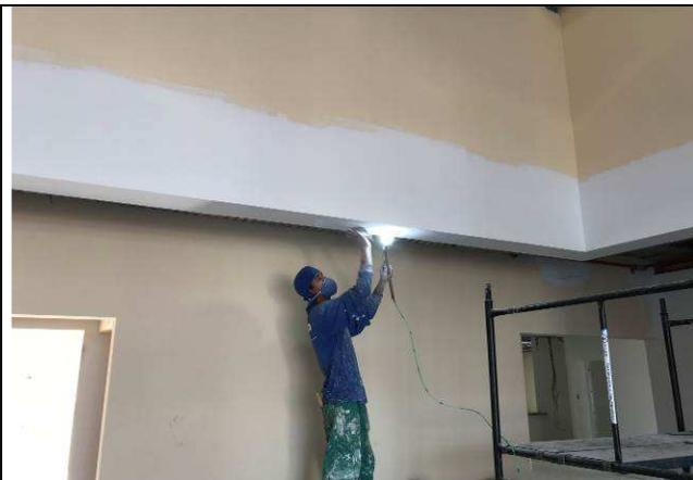
Figura 105C: Emassamento e lixamento de paredes internas.
