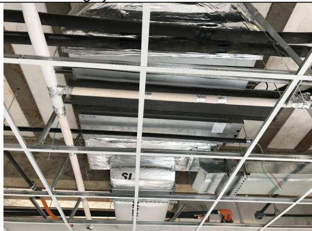
Figura 73C: Rede de drenos internos com isolamento térmico.
