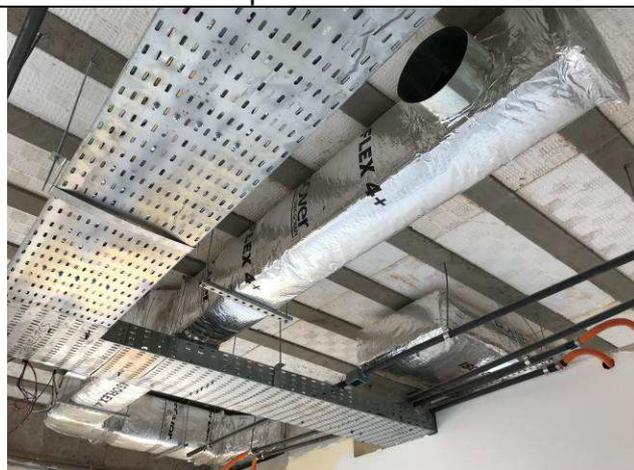
Figura 59C: Duto de insuflamento - Distribuição / Sala dos Oficiais.
