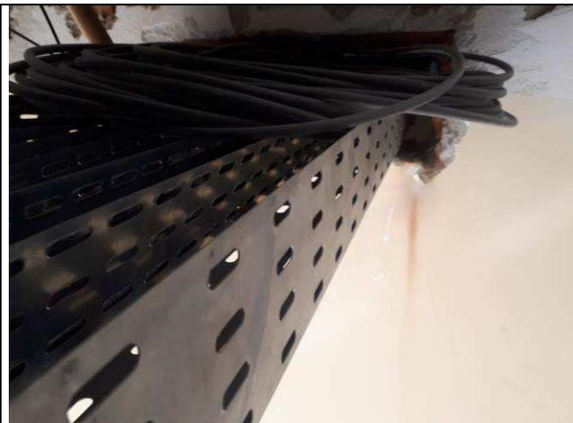
Figura 34E: cabos para alarme CCI 2 pares
