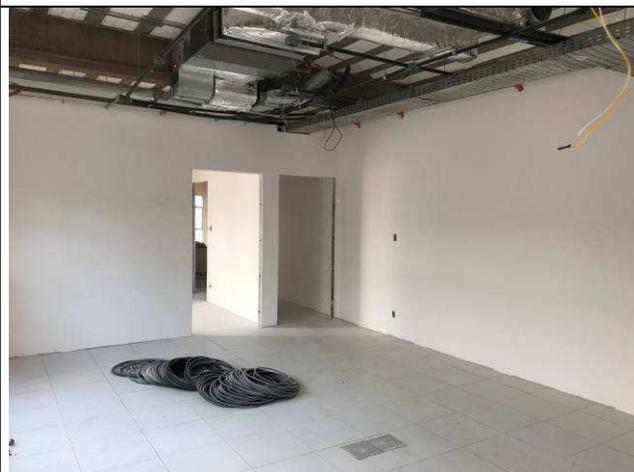
Figura 114C: Paredes internas emassadas
