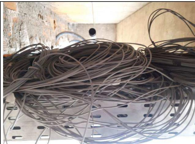
Figura 33E: cabos para alarme CCI 2 pares
