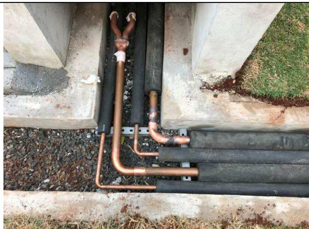
Figura 67C: Rede frigorígena externa - interligação das condensadoras.
