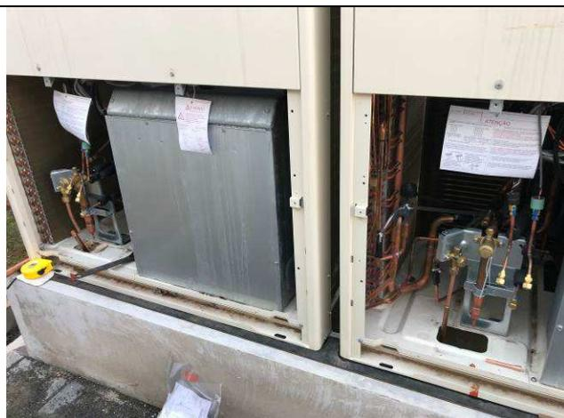
Figura 71C: Rede frigorígena externa - interligação das condensadoras.
