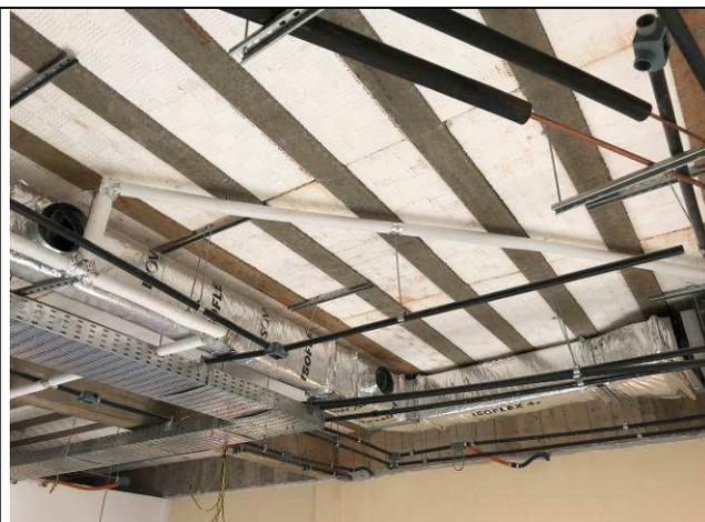
Figura 58C: Dutos de insuflamento e drenos com isolamento - sala múltiplo uso.
