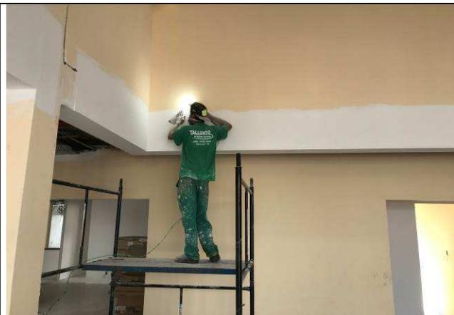
Figura 106C: Emassamento e lixamento de paredes internas.
