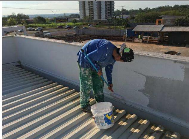
Figura 119C: Textura interna das platibandas - Arquivo.
