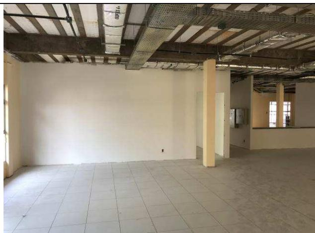
Figura 111C: Paredes internas emassadas
