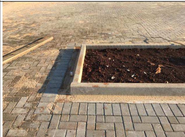
Figura 102C: Pavimentação intertravada dos estacionamentos internos.
