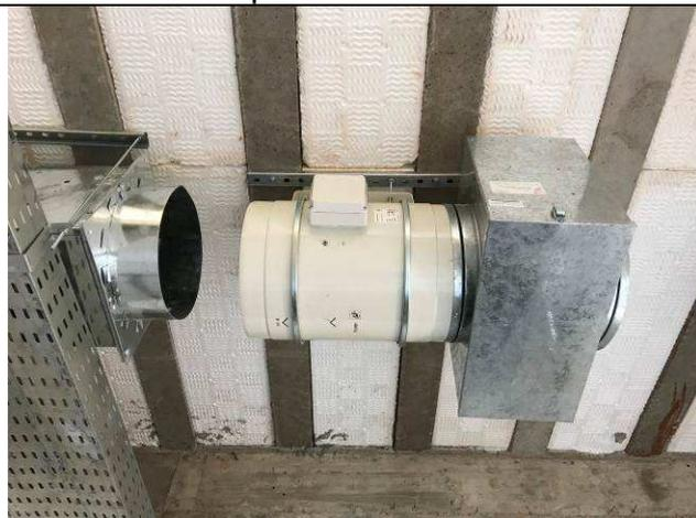
Figura 53C: Ventilador e caixa para filtro / filtros M5 e G4 - PAB II.
