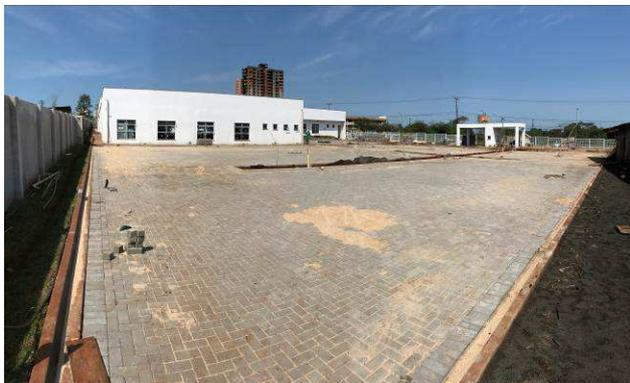
Figura 99C: Pavimentação intertravada dos estacionamentos internos.
