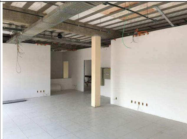
Figura 116C: Paredes internas emassadas
