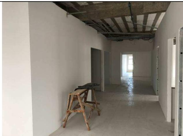
Figura 115C: Paredes internas emassadas
