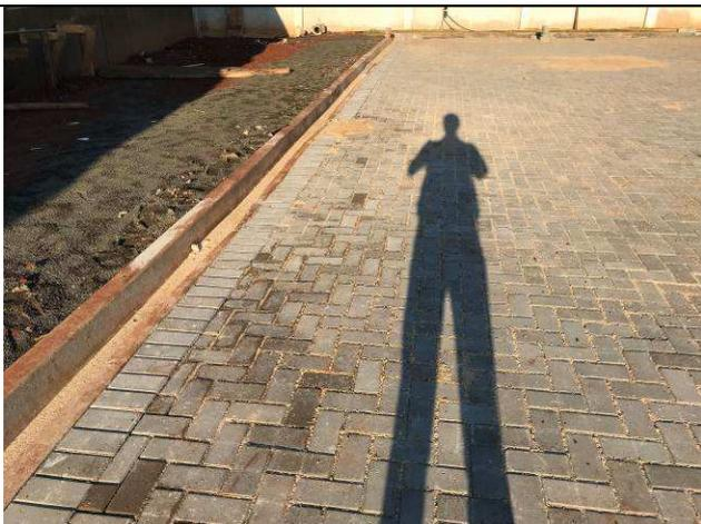
Figura 103C: Pavimentação intertravada dos estacionamentos internos.
