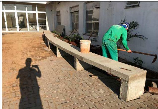
Figura 132C: Bancos de concreto da entrada.
