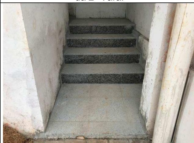
Figura 28C: Piso em granito - acesso lateral da Distribuição / Sala Oficiais.
