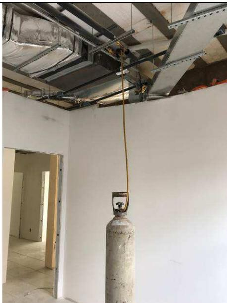
Figura 64C: Rede frigorígena interna - interligação das evaporadoras de 4,0 HP.
