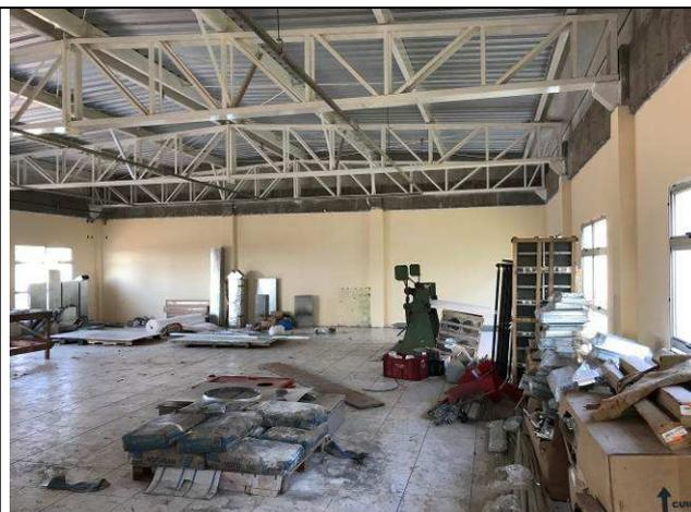
Figura 118C: Paredes internas emassadas - Arquivo.
