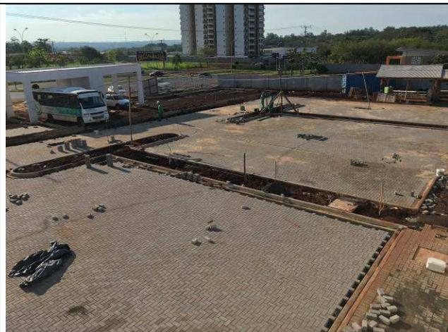
Figura 97C: Pavimentação intertravada dos estacionamentos internos.
