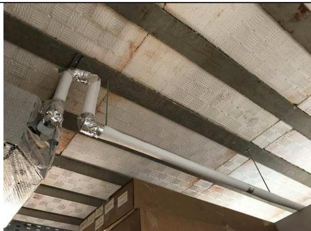
Figura 75C: Rede de drenos internos com isolamento térmico.
