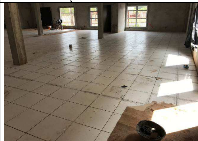
Figura 24C: Pisos Cerâmicos - Sala de Perícias e OAB.
