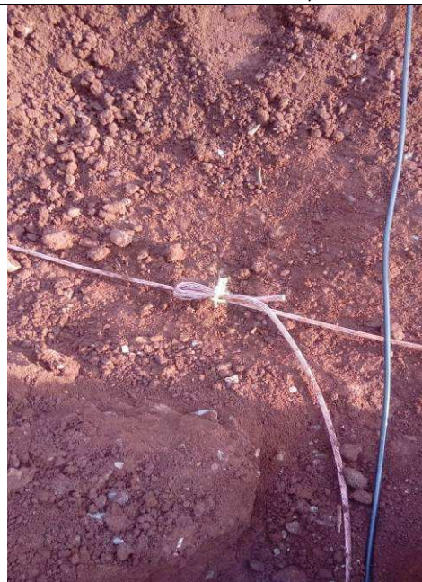
Figura 04E: escavação, reaterro, malha de aterramento cobre nu, hastes
