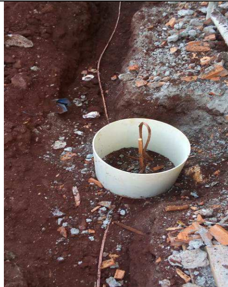
Figura 02E: escavação, reaterro, malha de aterramento cobre nu, hastes
