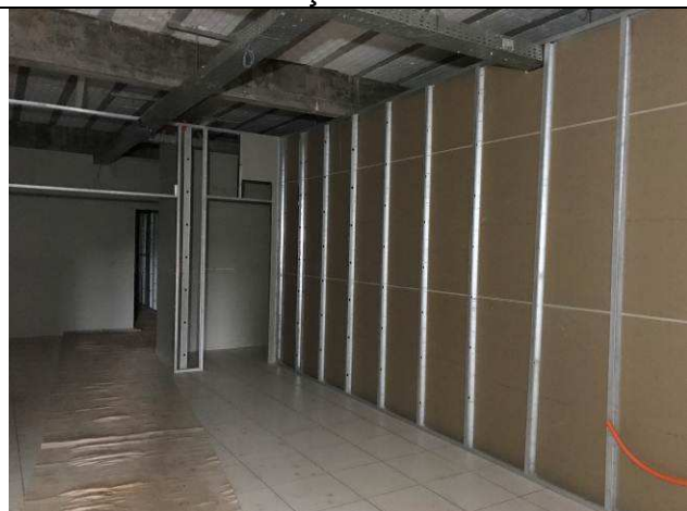
Figura 05C: Paredes de gesso acartonado - Arquivo e Hall / Espera Auditório.
