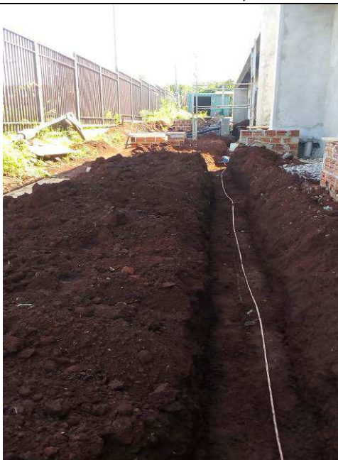
Figura 03E: escavação, reaterro, malha de aterramento cobre nu, hastes
