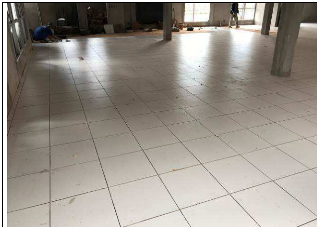
Figura 21C: Pisos Cerâmicos - PAB's e Distribuição / Sala dos Oficiais.
