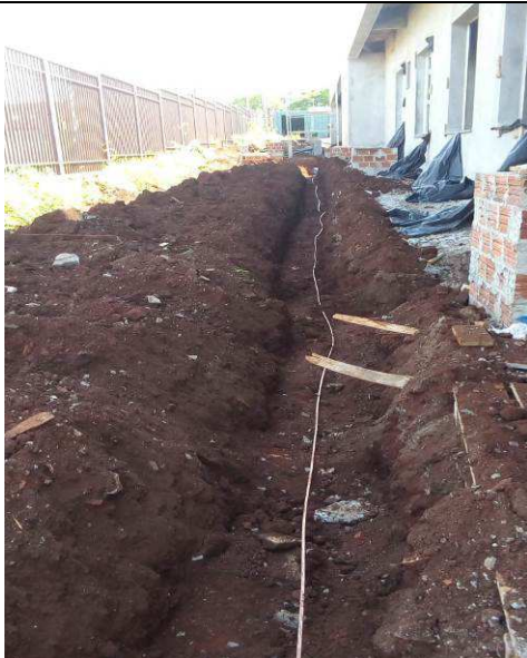
Figura 01E: escavação, reaterro, malha de aterramento cobre nu, hastes
