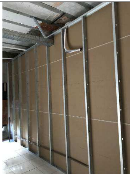
Figura 10C: Paredes de gesso acartonado - Sala de Perícias.
