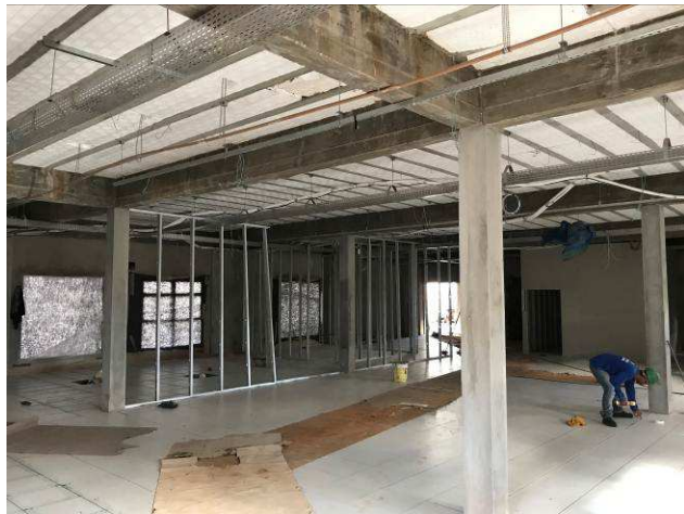
Figura 09C: Paredes de gesso acartonado - 2ª Vara.
