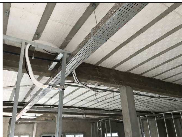
Figura 54C: Tubulações internas - rede frigorígena - 2ª Vara.
