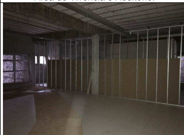
Figura 08C: Paredes de gesso acartonado - Auditório.
