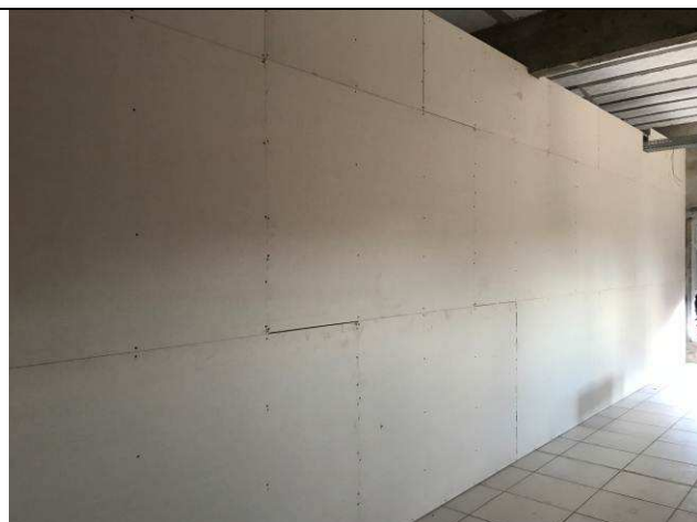
Figura 03C: Paredes de gesso acartonado - PAB's e Distribuição / Sala dos Oficiais.
