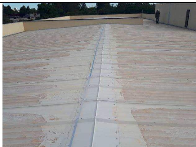
Figura 11E: captação SPDA com fitas de alumínio
