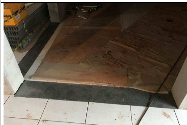
Figura 37C: Soleira em granito - Sala de espera da 1ª Vara.
