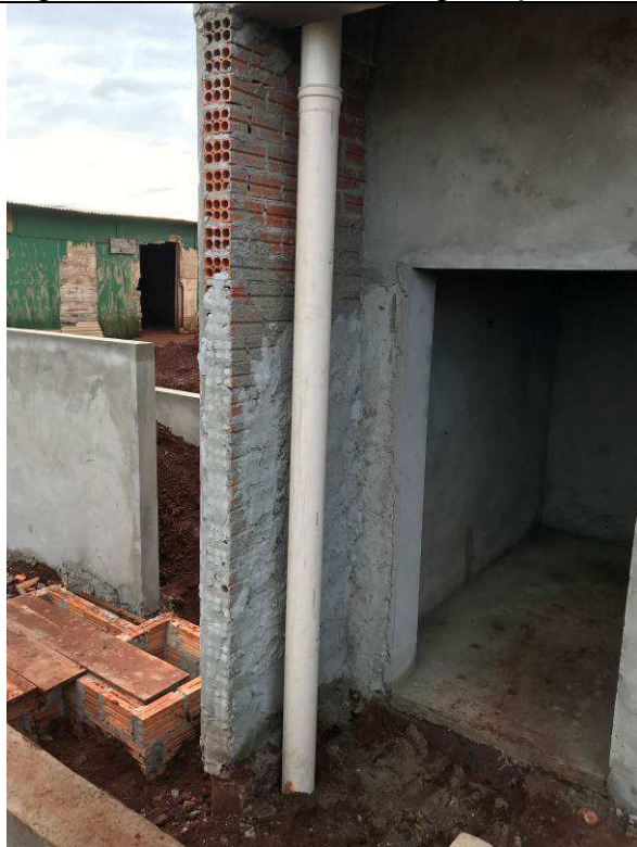
Figura 68C: Prumadas de águas pluviais.
