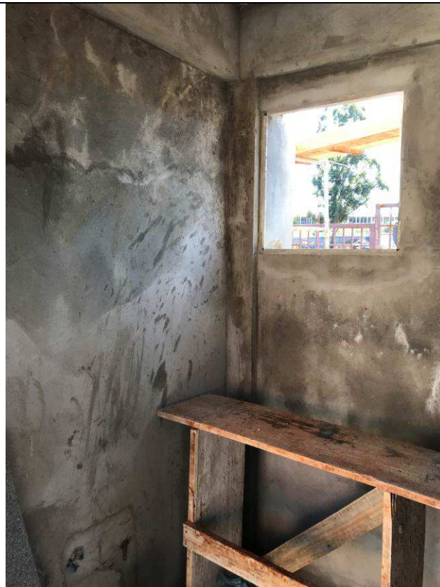
Figura 46C: Revestimento argamassado - Guarita.
