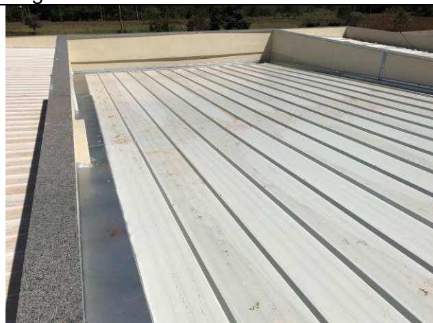
Figura 16C: Telhas de cobertura - Hall central e reservatórios.
