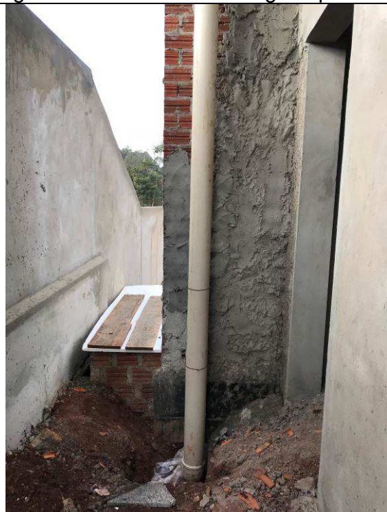
Figura 64C: Prumadas de águas pluviais.
