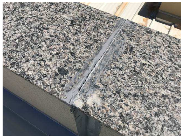
Figura 27C: Copeamento da platibanda - aplicação de poliuretano nas juntas.
