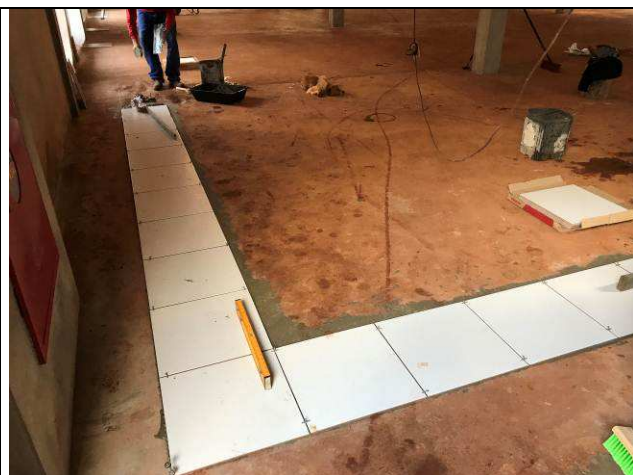
Figura 50C: Piso cerâmico - início do assentamento - Auditório.
