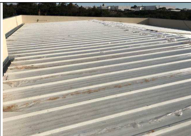
Figura 13C: Telhas de cobertura - PAB's / distribuição / Oficiais.
