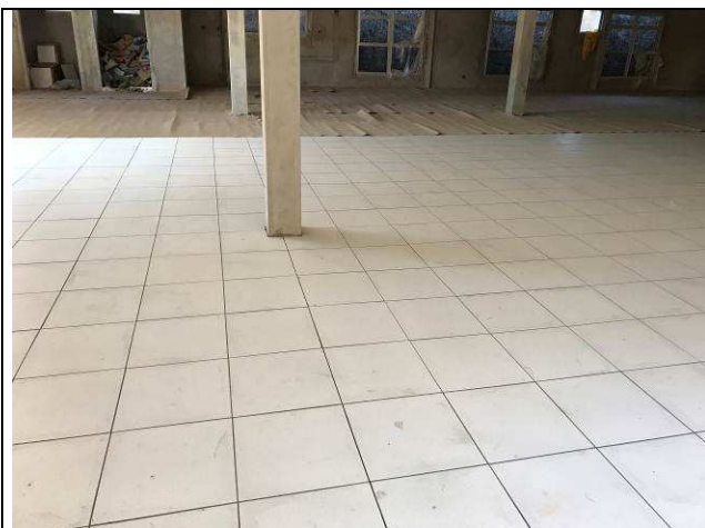
Figura 56C: Piso cerâmico - Auditório.
