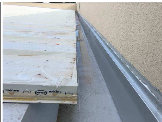
Figura 19C: Avanço das telhas na calha.
