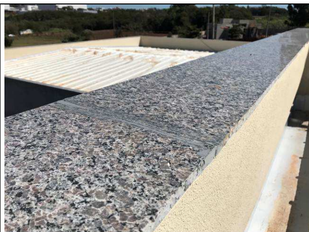
Figura 25C: Copeamento da platibanda - Hall central.
