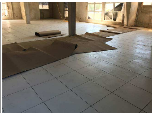
Figura 57C: Piso cerâmico - Auditório.
