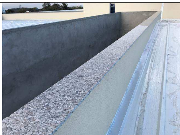
Figura 24C: Copeamento da platibanda - PAB's / Distribuição / Oficiais.
