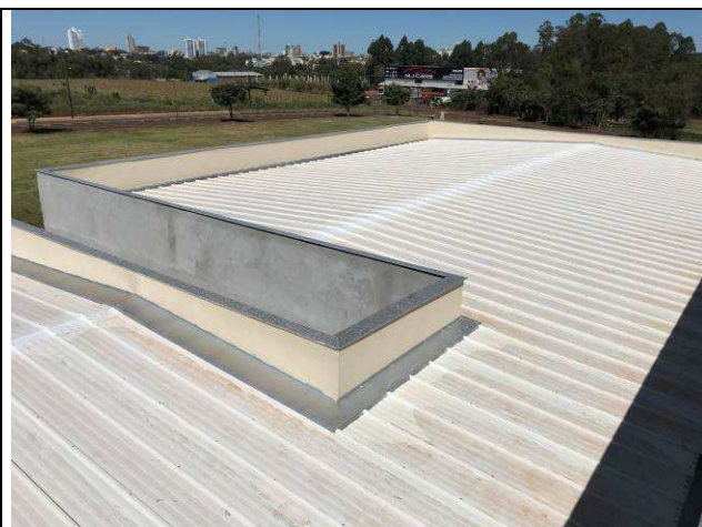
Figura 83C: Textura na face interna das platibandas.
