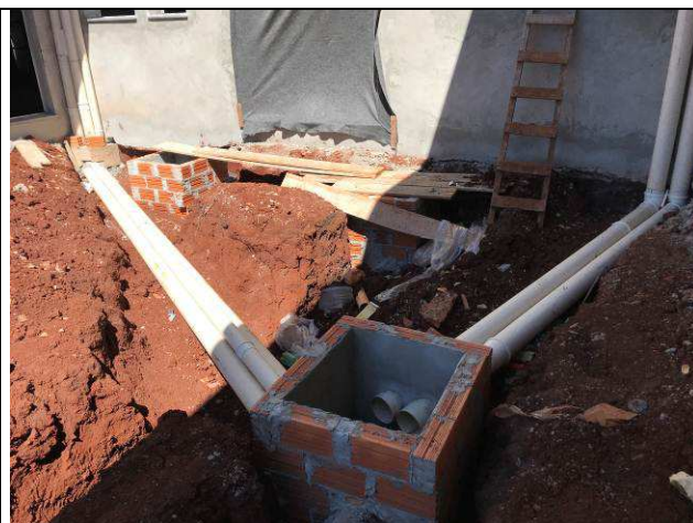
Figura 71C: Tubos de águas pluviais.
