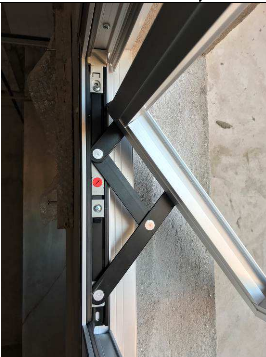
Figura 04C: Braços tipo projetante deslizante - folhas de 30 cm.
