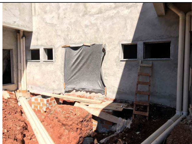
Figura 70C: Tubos de águas pluviais.
