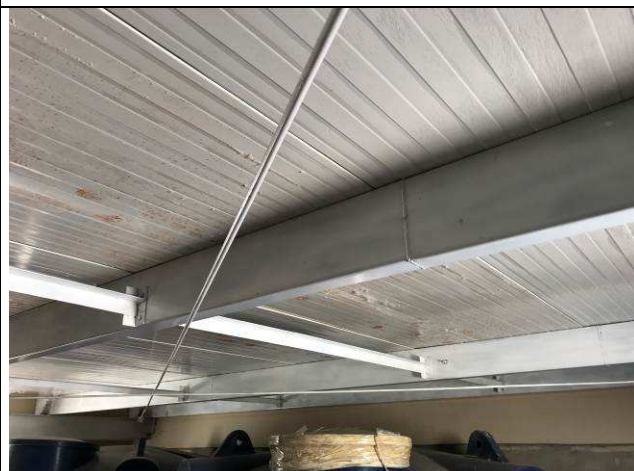
Figura 11C: Estrutura metálica de cobertura - reservatórios de água.
