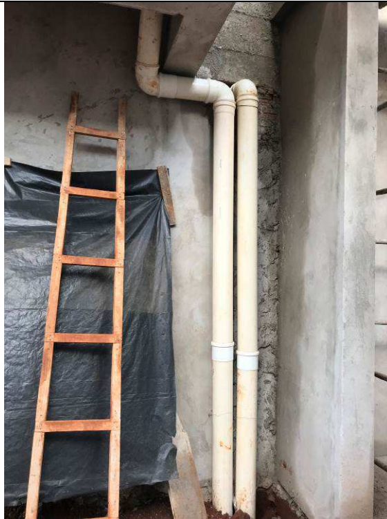
Figura 63C: Prumadas de águas pluviais.
