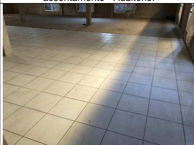
Figura 54C: Piso cerâmico - Auditório.
