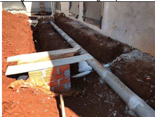
Figura 72C: Tubos de águas pluviais.
