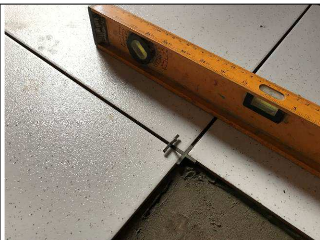
Figura 51C: Piso cerâmico - espaçadores plásticos de 3 mm.
