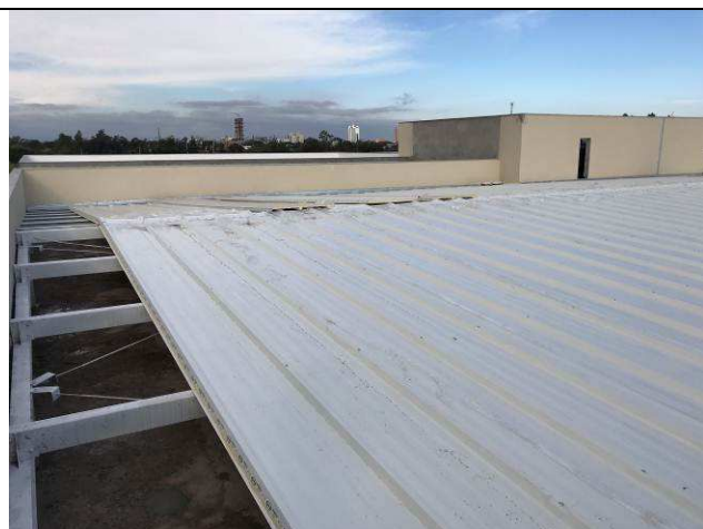
Figura 18C: Montagem das telhas - 2ª Vara.
