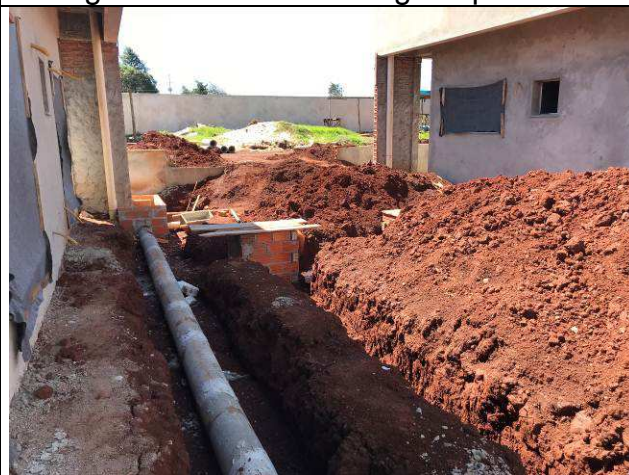
Figura 73C: Tubos de águas pluviais.
