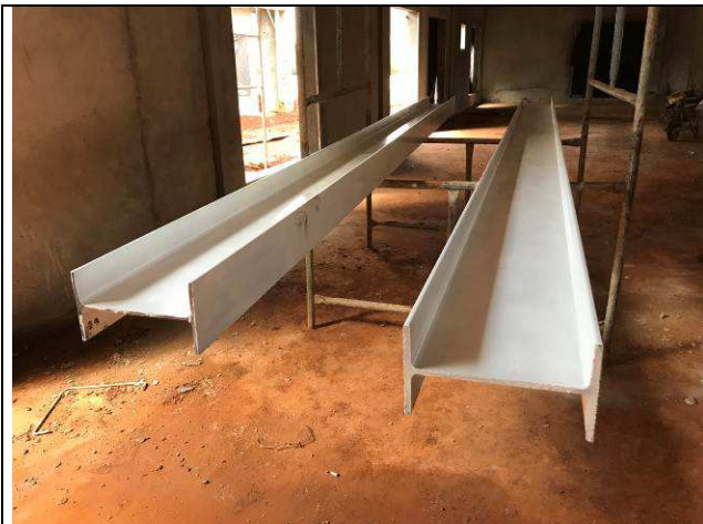
Figura 06C: Pintura das vigas W 250.
