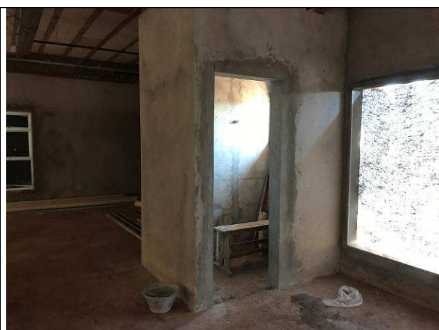
Figura 45C: Revestimento argamassado - requadros - Fórum.
