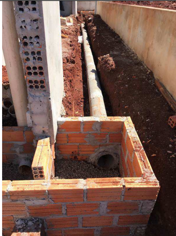
Figura 69C: Prumadas de águas pluviais.
