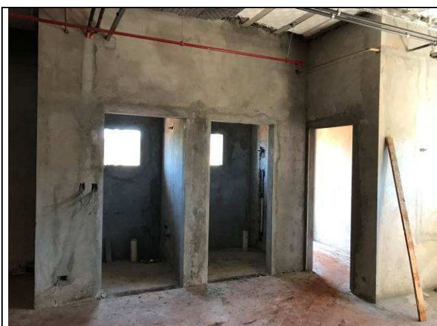
Figura 44C: Revestimento argamassado - requadros - Fórum.
