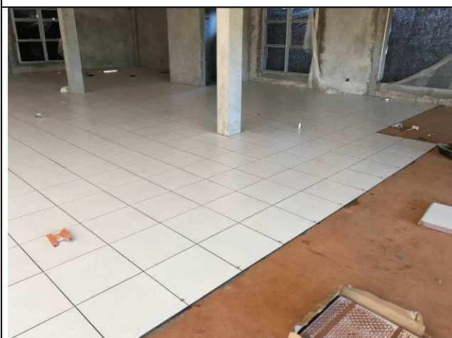
Figura 60C: Piso cerâmico - 1ª Vara.
