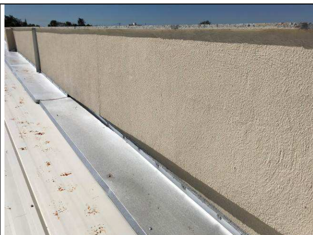
Figura 82C: Textura na face interna das platibandas.
