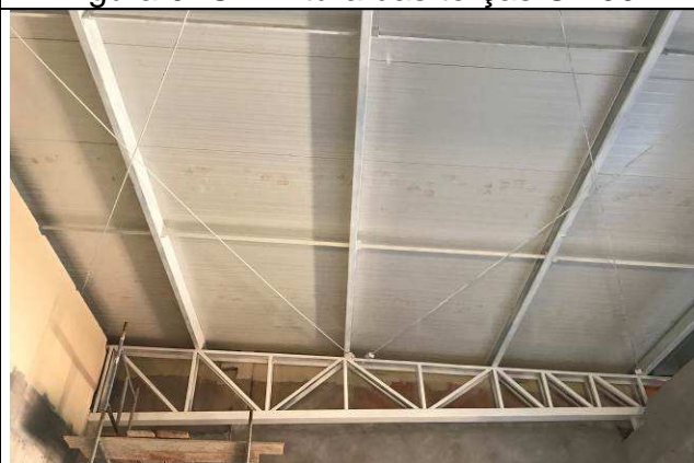
Figura 09C: Estrutura metálica de cobertura - hall de entrada.
