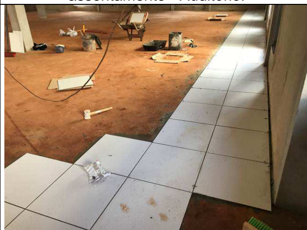
Figura 52C: Piso cerâmico - início do assentamento - Auditório.
