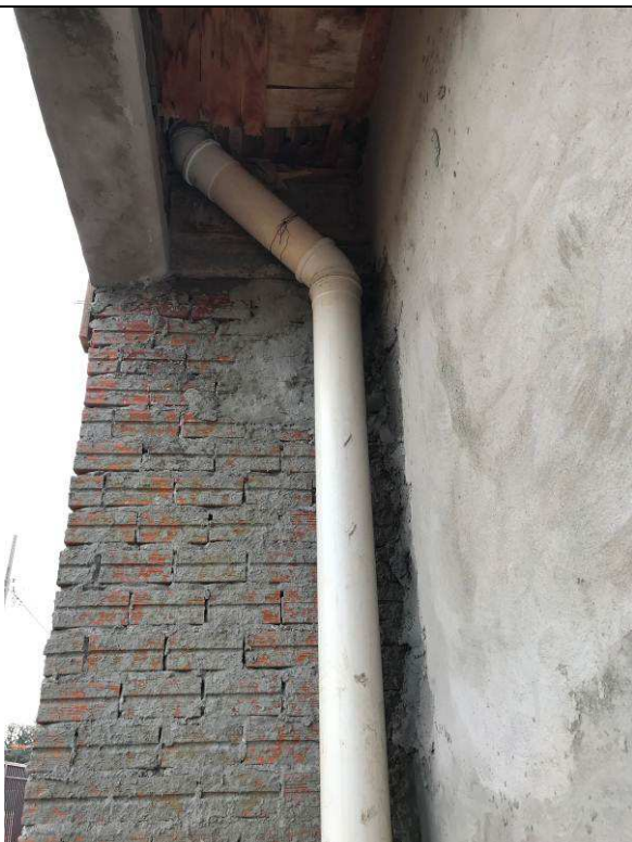
Figura 66C: Prumadas de águas pluviais.
