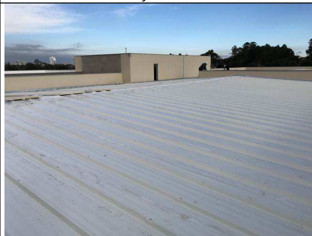
Figura 15C: Telhas de cobertura - PAB's.
