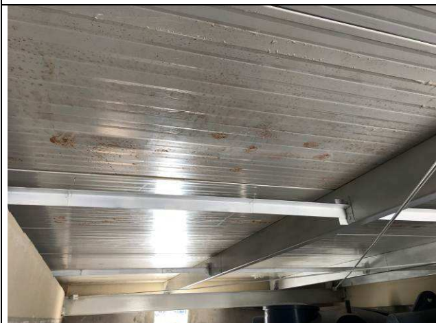
Figura 10C: Estrutura metálica de cobertura - reservatórios de água.
