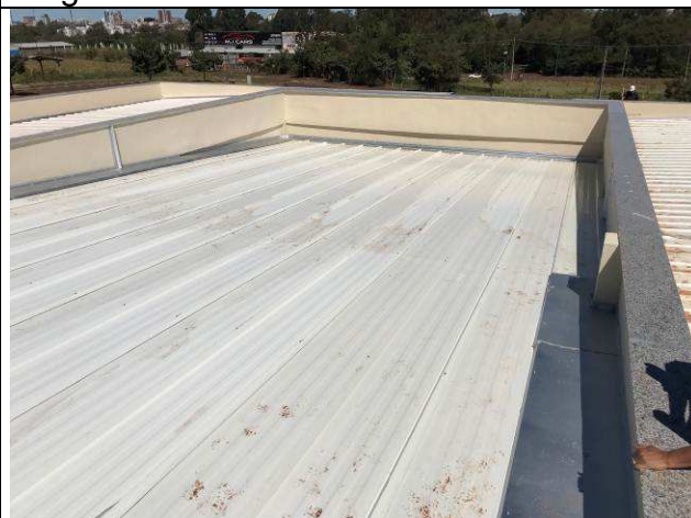
Figura 17C: Telhas de cobertura - Hall central e reservatórios.
