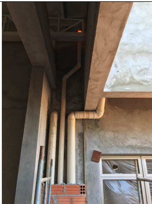
Figura 67C: Prumadas de águas pluviais.
