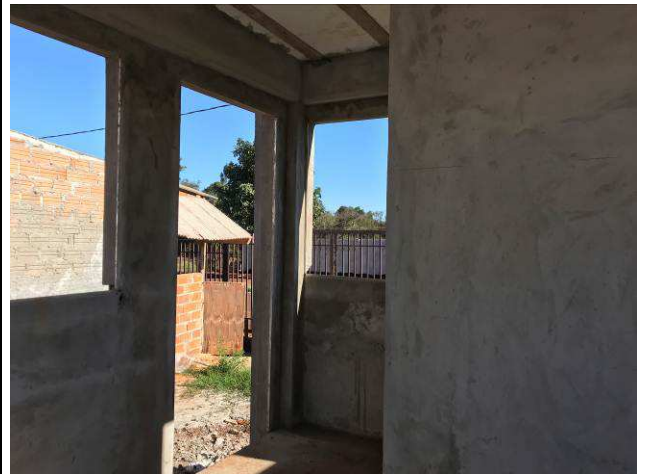
Figura 47C: Revestimento argamassado - Guarita.
