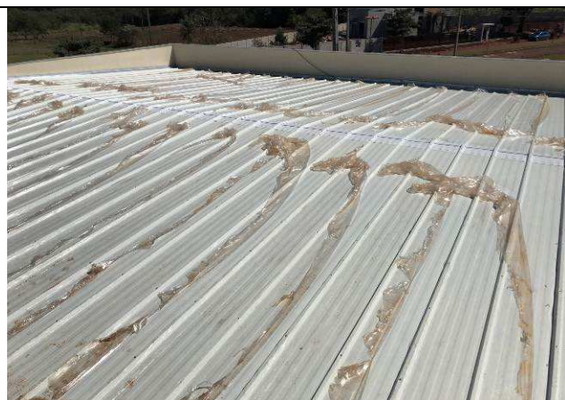
Figura 12C: Telhas de cobertura - PAB's / distribuição / Oficiais.
