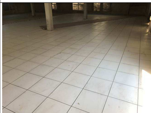
Figura 55C: Piso cerâmico - Auditório.
