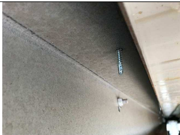
Figura 22C: Fixação das telhas na onda alta com parafuso autobrocante.
