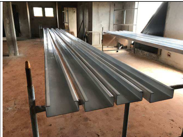
Figura 07C: Pintura das terças C 200.
