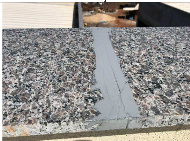
Figura 26C: Copeamento da platibanda - aplicação de poliuretano nas juntas.
