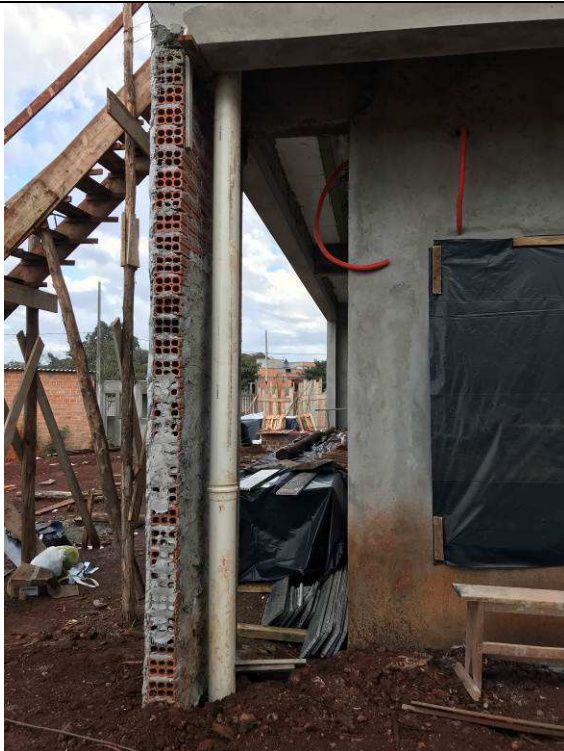
Figura 62C: Prumadas de águas pluviais.
