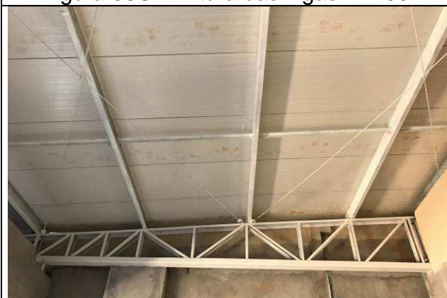
Figura 08C: Estrutura metálica de cobertura - hall de entrada.
