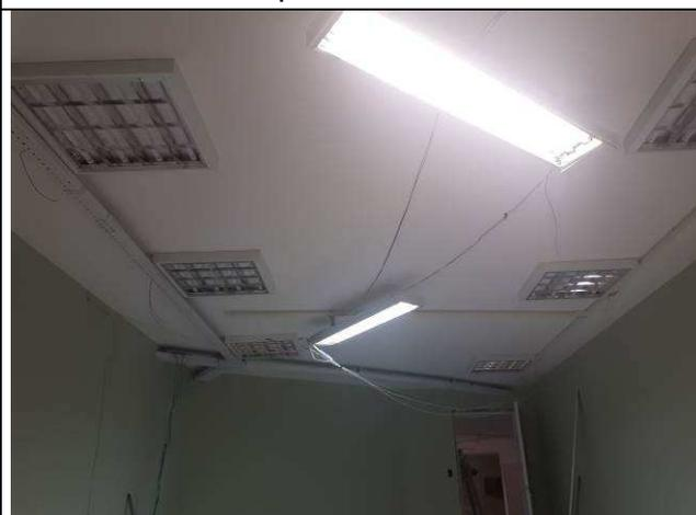
Figura 16E: iluminação - luminárias 4x16W sobrepôr 17ª e 18ª VT
