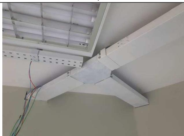
Figura 03E: infraestrutura interna - eletrocalhas, eletrodutos, perfilados.
