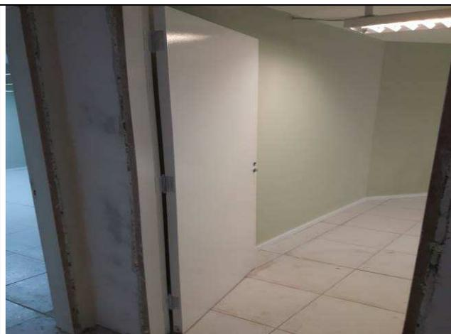
Figura 09C: porta acústica (PA) instalada.
