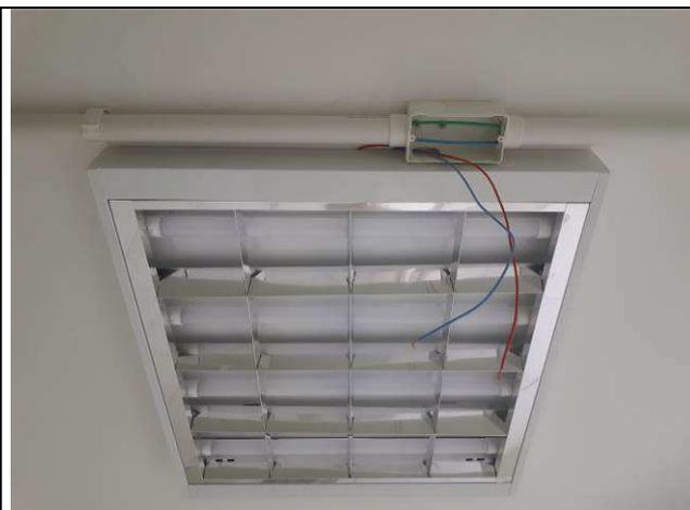
Figura 14E: iluminação - luminárias 4x16W sobrepôr 17ª e 18ª VT
