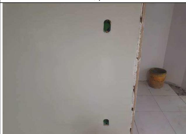
Figura 06E: infraestrutura interna - eletrodutos, caixas 2x4\" data-bbox="529 846 923 879"/>
