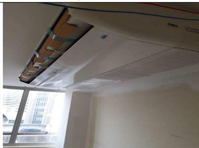
Figura 16C: equipamento de ar condicionado Split instalado.
