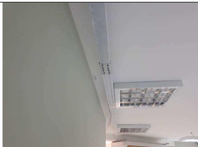
Figura 01E: infraestrutura interna - eletrocalhas, eletrodutos, perfilados.
