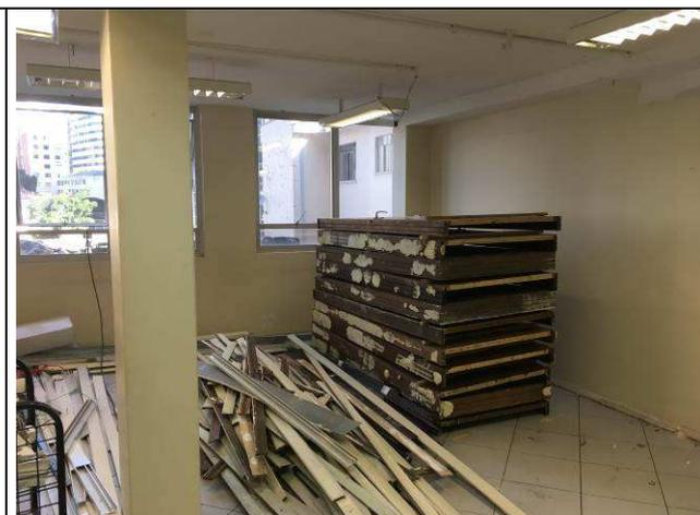
Figura 02C: retirada de esquadrias de madeira.
