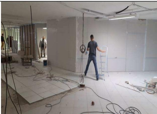
Figura 07C: instalação das paredes de gesso acartonado.
