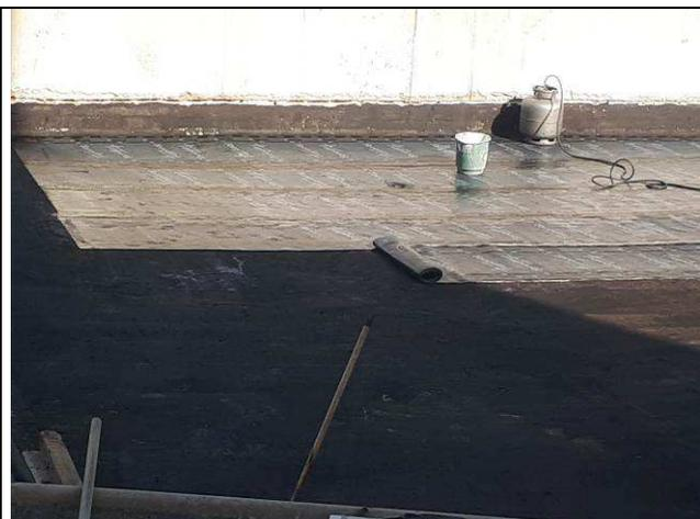
Figura 21C: aplicação de manta asfáltica.
