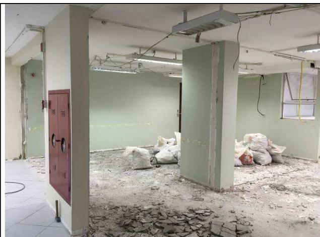
Figura 04C: retirada das divisórias de gesso acartonado.
