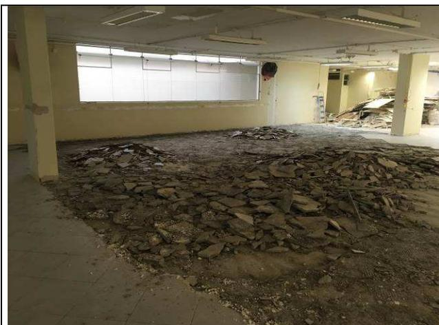
Figura 01C: demolição de piso cerâmico
