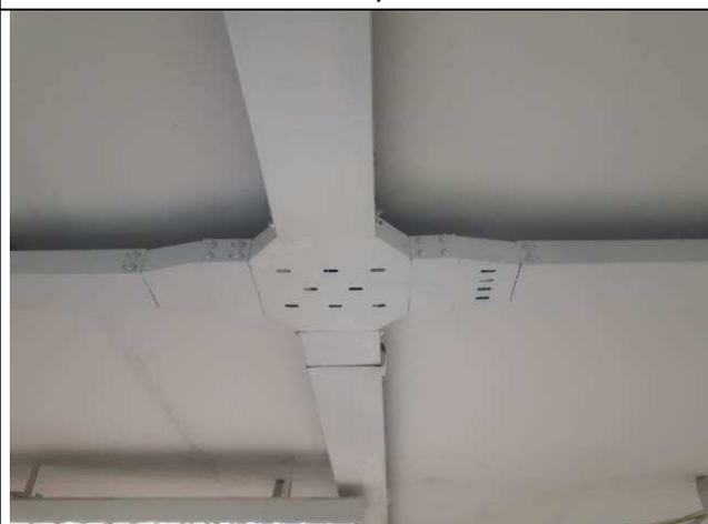
Figura 04E: infraestrutura interna - eletrocalhas, eletrodutos, perfilados.
