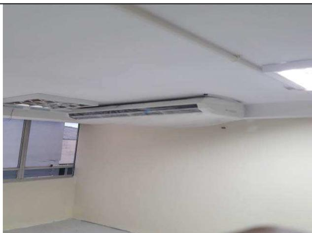
Figura 17C: equipamento de ar condicionado Split instalado.
