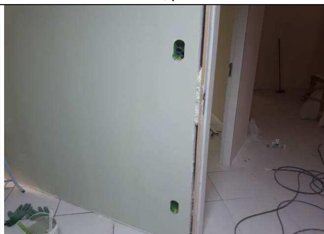
Figura 05E: infraestrutura interna - eletrodutos, caixas 2x4\" data-bbox="122 846 515 878"/>
