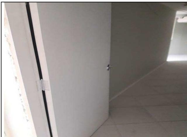
Figura 08C: porta acústica (PA) instalada.
