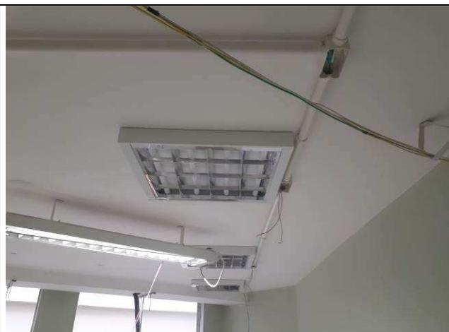
Figura 13E: iluminação - luminárias 4x16W sobrepôr 17ª e 18ª VT
