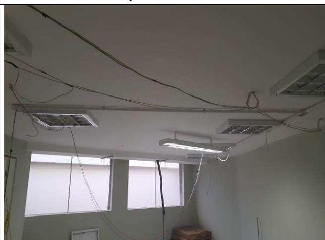
Figura 15E: iluminação - luminárias 4x16W sobrepôr 17ª e 18ª VT
