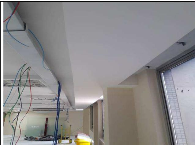
Figura 10C: envelopamento da rede de ar condicionado em gesso acartonado.
