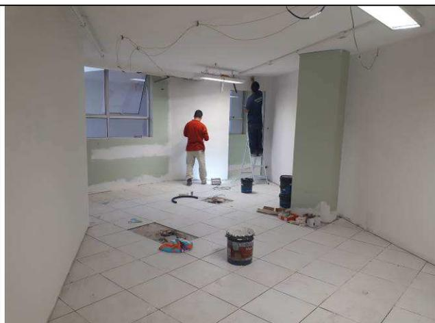
Figura 13C: aplicação de fundo selador látex PVA.
