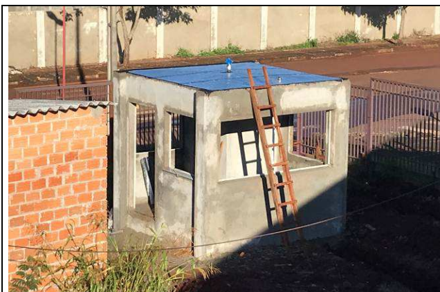
Figura 27C: Impermeabilização da cobertura com manta - Guarita.
