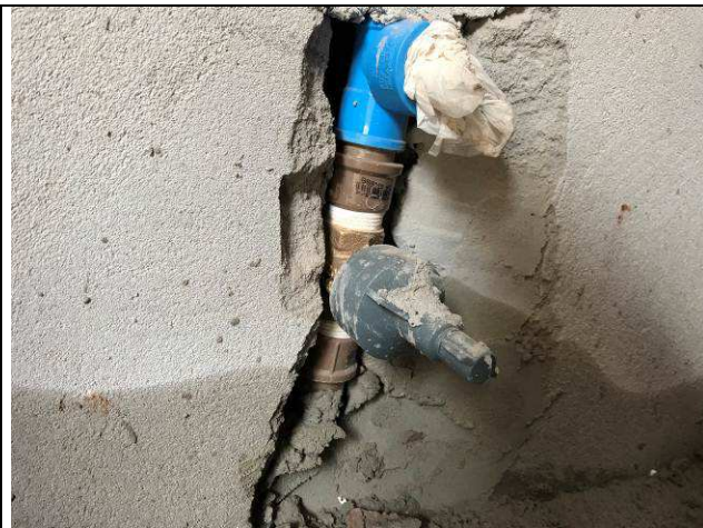
Figura 60C: Registro instalado - guarita.
