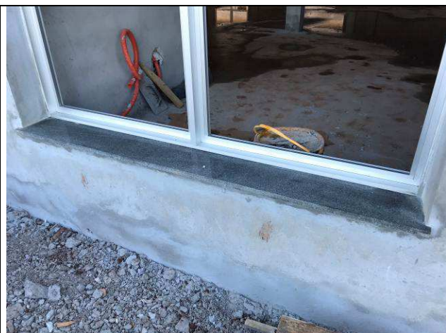
Figura 53C: Peitoris das janelas - Fórum.
