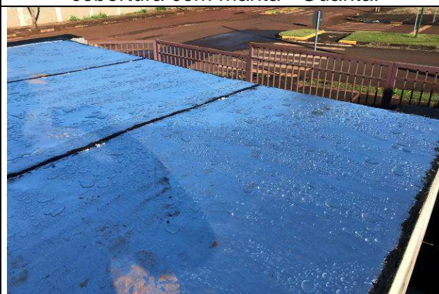
Figura 30C: Impermeabilização da cobertura com manta - Guarita.
