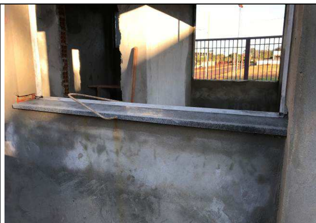
Figura 45C: Peitoris das janelas - Guarita.
