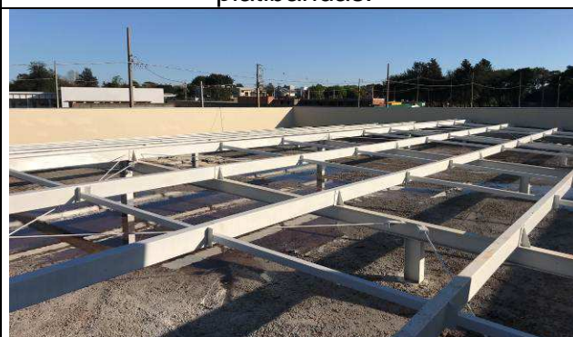
Figura 72C: Textura na face interna das platibandas.
