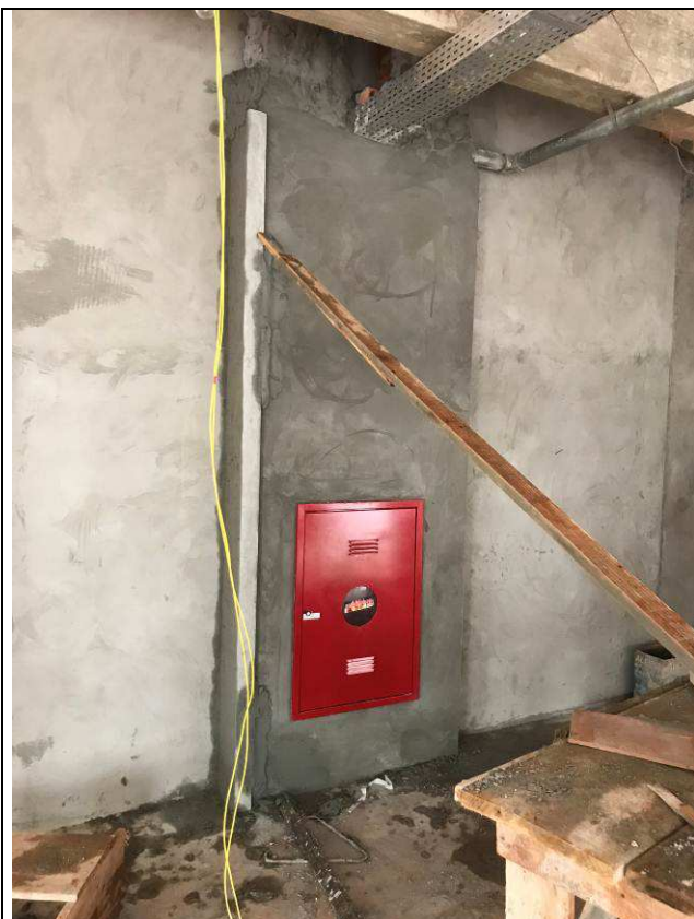
Figura 09C: Alvenaria de fechamento lateral do Hall central.
