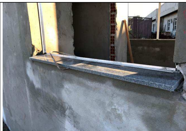
Figura 46C: Peitoris das janelas - Guarita.
