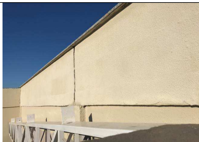
Figura 73C: Textura na face interna das platibandas.
