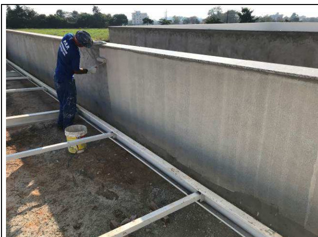
Figura 69C: Textura na face interna das platibandas - 1ª demão.
