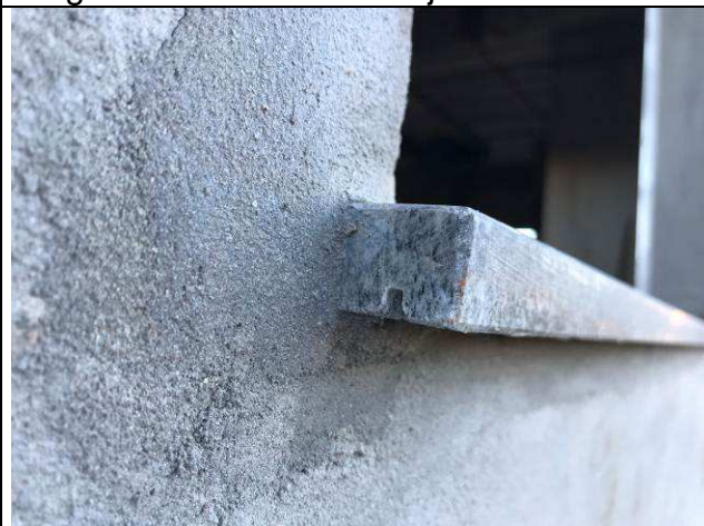
Figura 52C: Peitoris das janelas - detalhe da pingadeira - Fórum.
