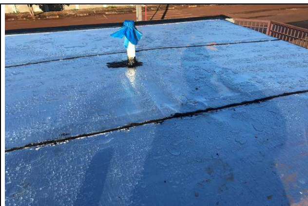
Figura 28C: Impermeabilização da cobertura com manta - Guarita.
