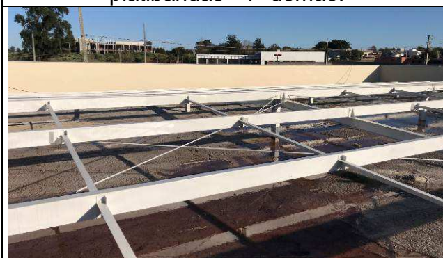
Figura 71C: Textura na face interna das platibandas.
