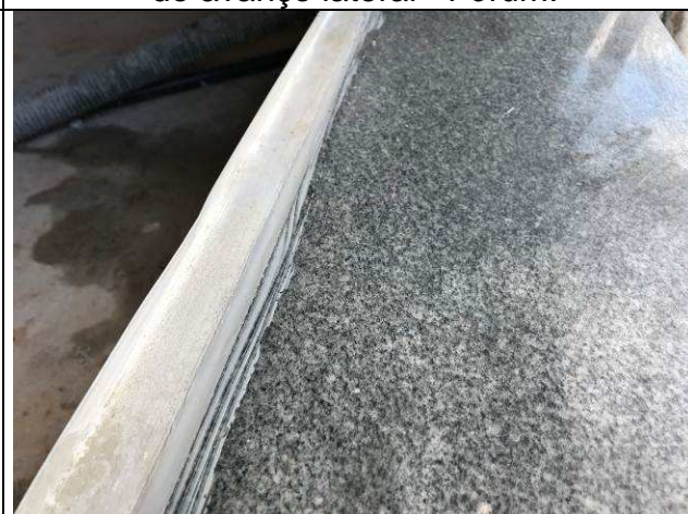
Figura 56C: Aplicação de elastômero de poliuretano entre o caixilho e o peitoril.
