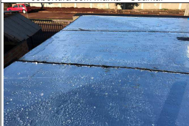
Figura 29C: Impermeabilização da cobertura com manta - Guarita.
