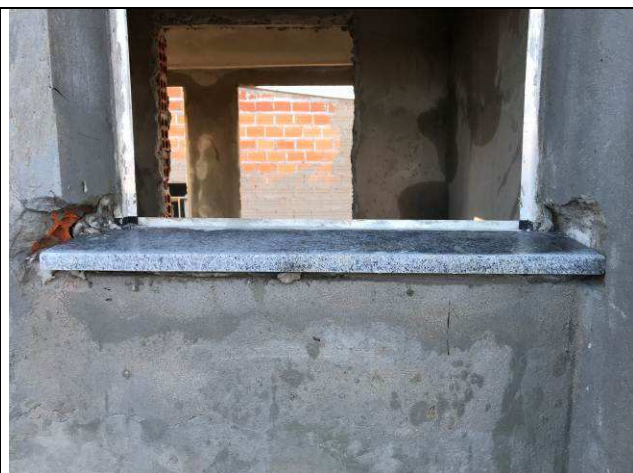
Figura 47C: Peitoris das janelas - Guarita.
