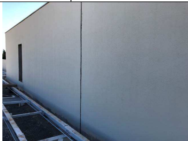
Figura 75C: Textura na face interna das platibandas.
