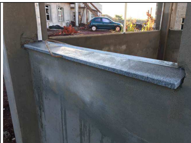
Figura 48C: Peitoris das janelas - Guarita.
