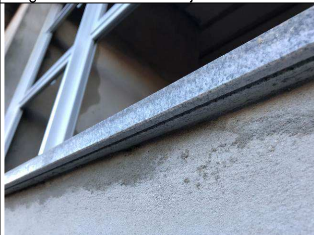
Figura 51C: Peitoris das janelas - detalhe da pingadeira - Fórum.
