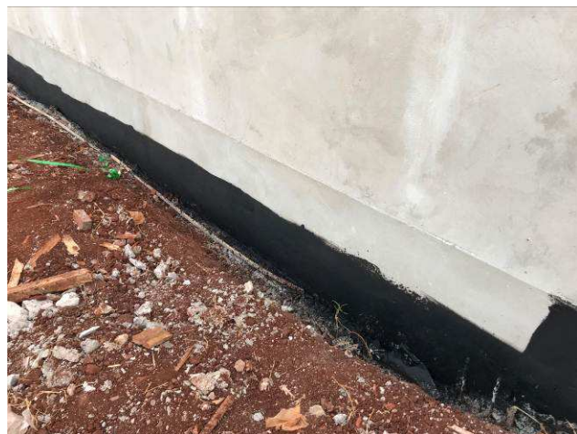
Figura 01C: Revestimento argamassado - Muros de arrimo.
