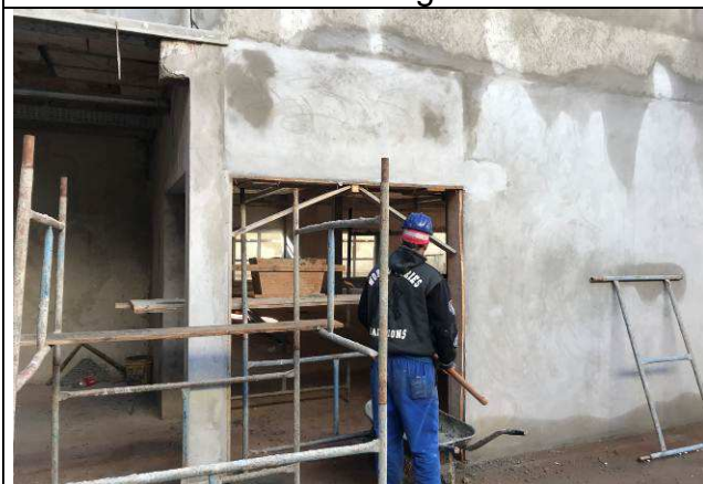
Figura 07C: Alvenaria de fechamento lateral do Hall central.
