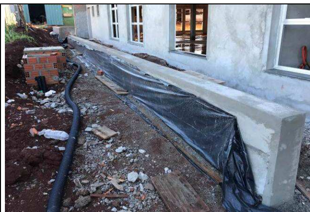
Figura 04C: Revestimento argamassado e lona da drenagem - Muros de arrimo.
