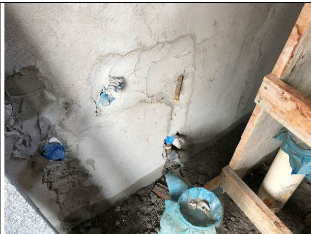
Figura 59C: Registro instalado - guarita.
