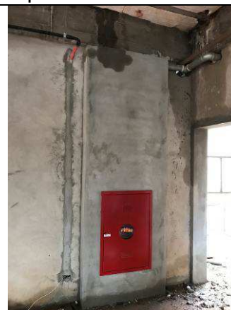
Figura 08C: Alvenaria de fechamento dos abrigos de hidrantes.
