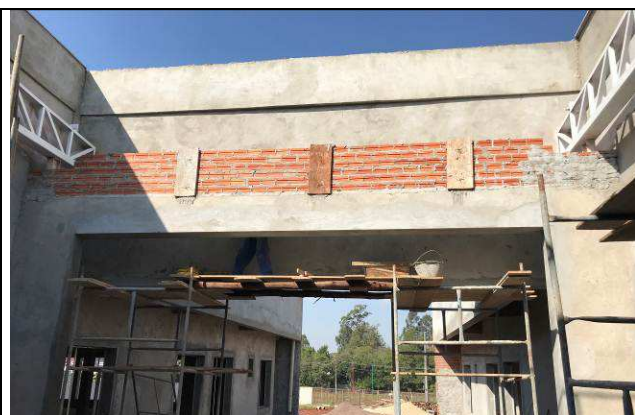
Figura 06C: Alvenaria de fechamento superior do Hall central.
