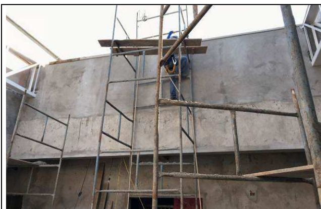
Figura 05C: Alvenaria de fechamento das caixas de água.
