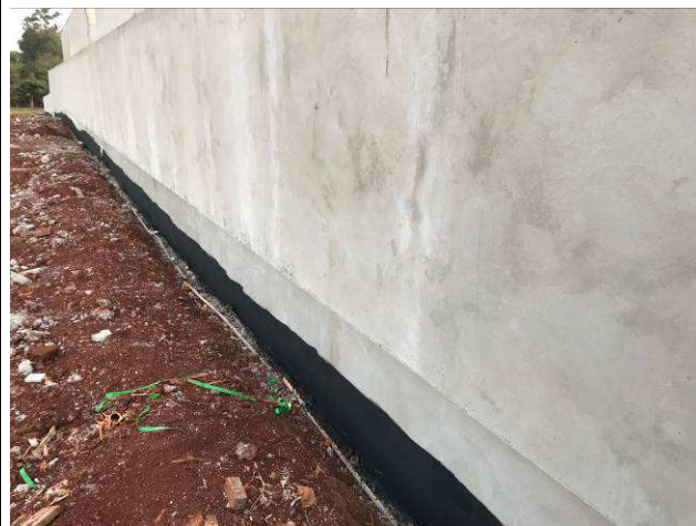
Figura 02C: Revestimento argamassado - Muros de arrimo.
