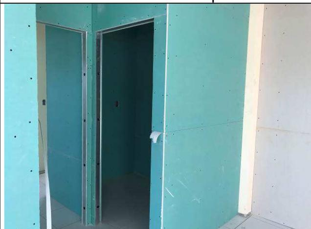
Figura 17C: Paredes de gesso acartonado verde - Módulo de apoio.
