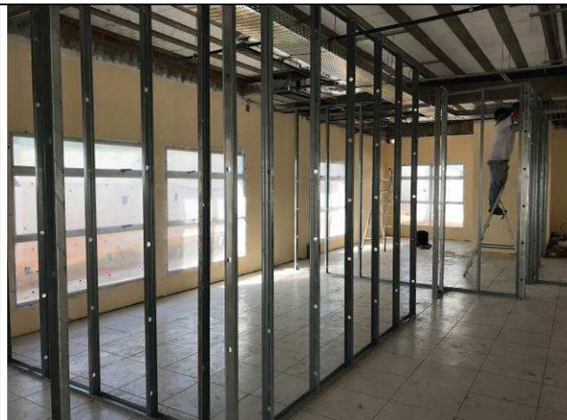
Figura 02C: Paredes de gesso acartonado - 3ª Vara.
