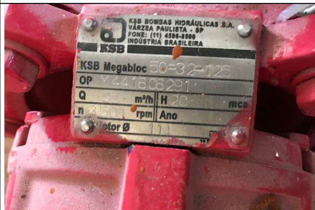
Figura 78C: Bomba de incêndio.
