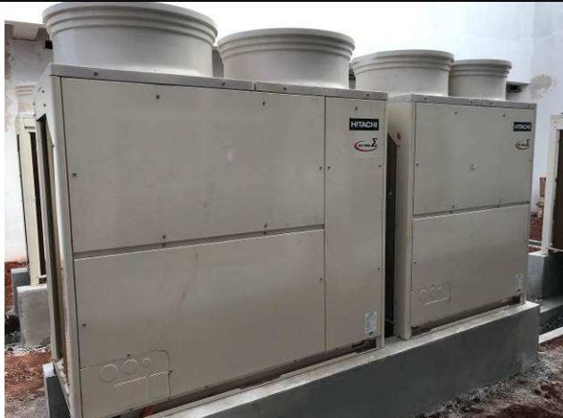
Figura 53C: Conjunto de condensadoras - Capacidade nominal de 40 HP.
