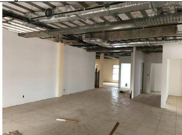
Figura 111C: Paredes com massa corrida.
