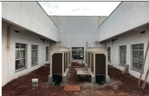
Figura 47C: Conjuntos de condensadoras VRF externas.
