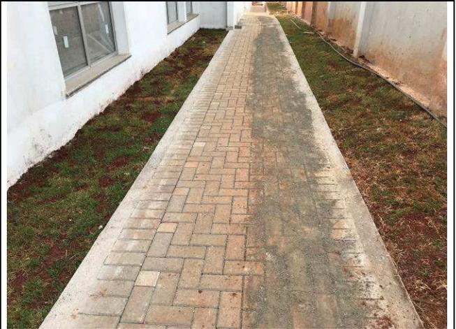
Figura 98C: Calçadas internas em paver.
