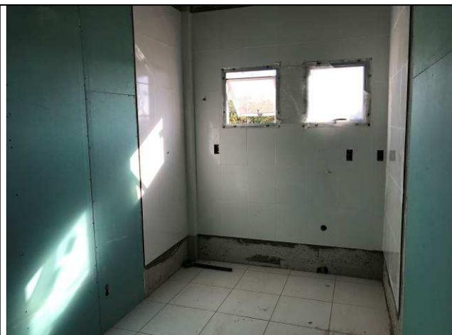
Figura 15C: Paredes de gesso acartonado verde - Módulo de apoio.
