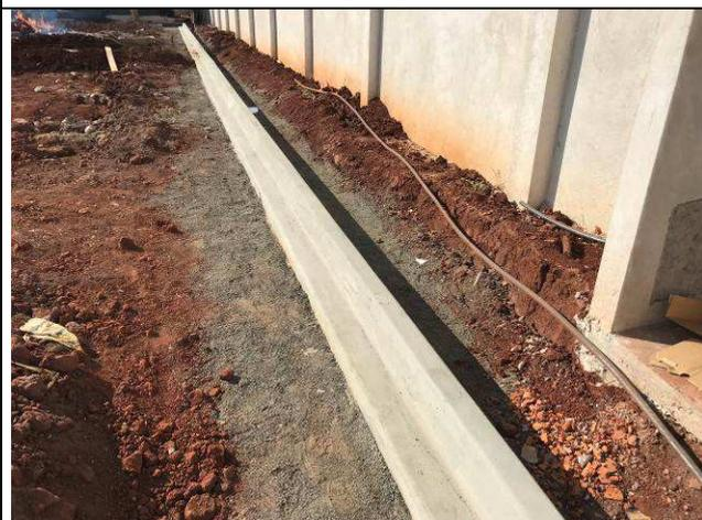
Figura 81C: Meio-fios do estacionamento interno.
