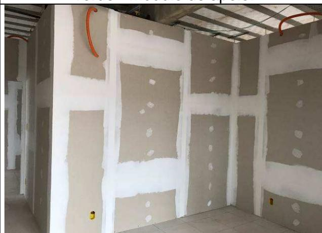
Figura 19C: Paredes de gesso acartonado - Módulo de apoio.
