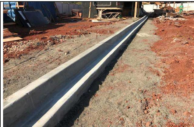
Figura 79C: Meio-fios do estacionamento interno.
