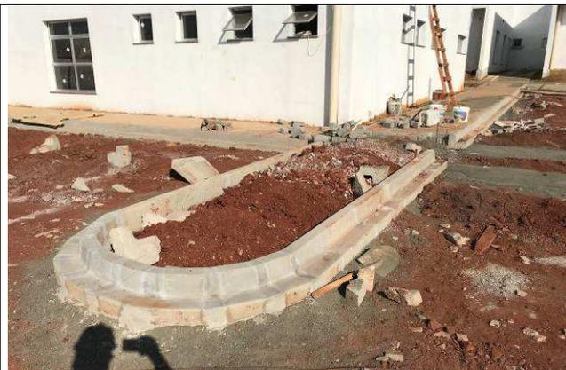
Figura 80C: Meio-fios do estacionamento interno.
