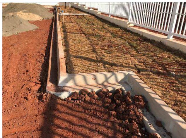
Figura 85C: Meio-fios do estacionamento interno.
