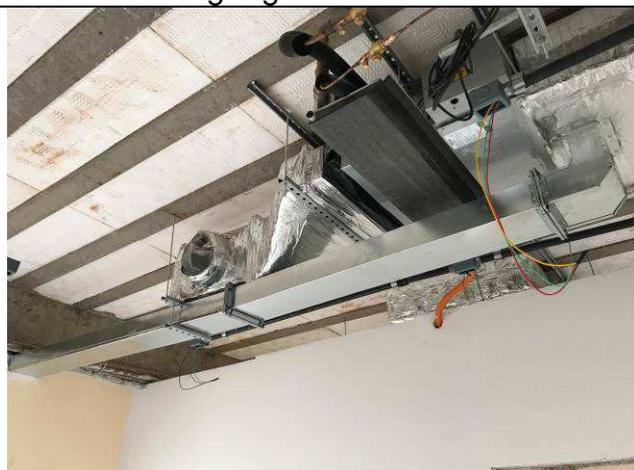
Figura 69C: Rede de drenos, tubulações da rede frigorígena e dutos de ar.
