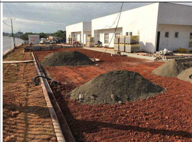
Figura 88C: Meio-fios do estacionamento interno.
