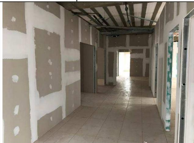
Figura 10C: Paredes de gesso acartonado - Módulo de apoio.
