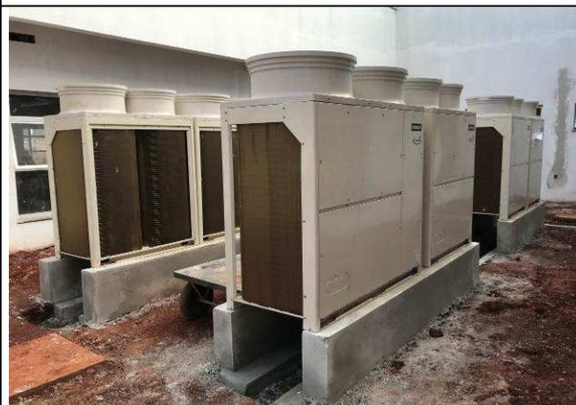
Figura 50C: Conjuntos de condensadoras VRF externas.
