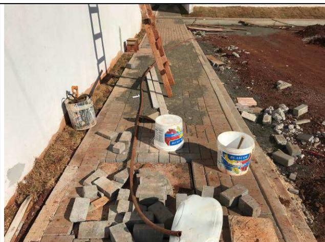
Figura 91C: Calçadas internas em paver.
