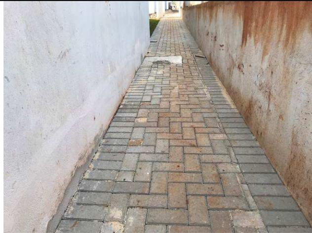
Figura 97C: Calçadas internas em paver.
