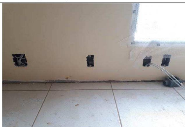
Figura 31E: infraestrutura e cabeamento lógico - quadrante frente esquerda
