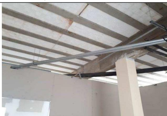
Figura 19E: eletrodutos alimentação quadros - frente esquerda
