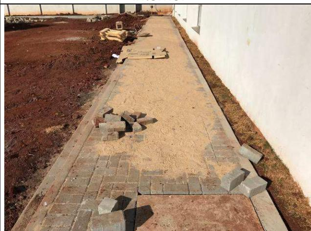
Figura 90C: Calçadas internas em paver.
