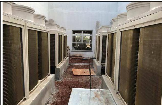
Figura 48C: Conjuntos de condensadoras VRF externas.
