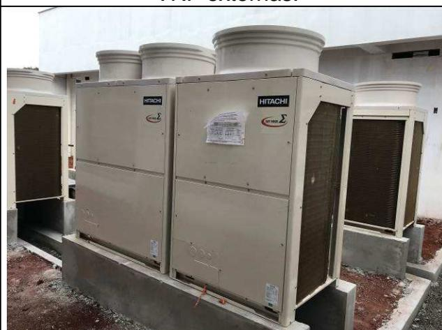
Figura 52C: Conjunto de condensadoras - Capacidade nominal de 30 HP.
