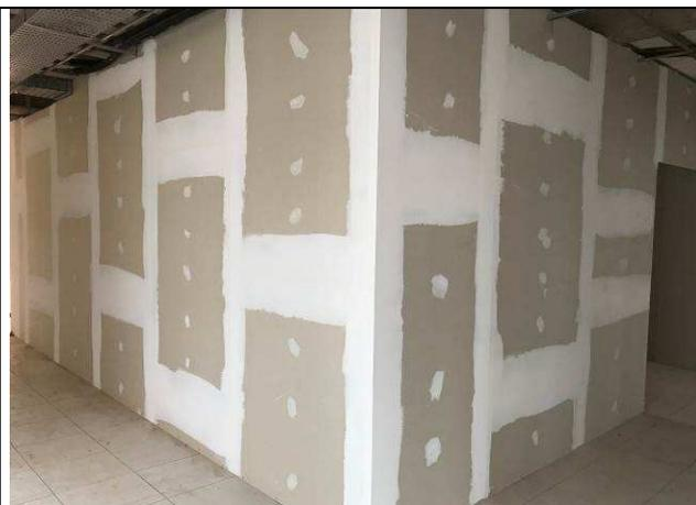
Figura 09C: Paredes de gesso acartonado - Módulo de apoio.
