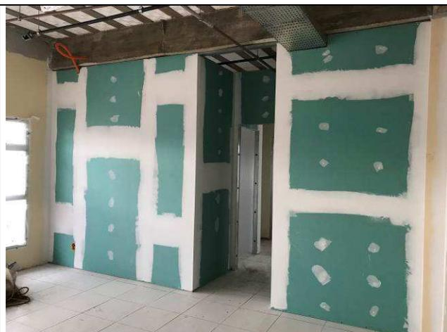
Figura 14C: Paredes de gesso acartonado verde - Módulo de apoio.
