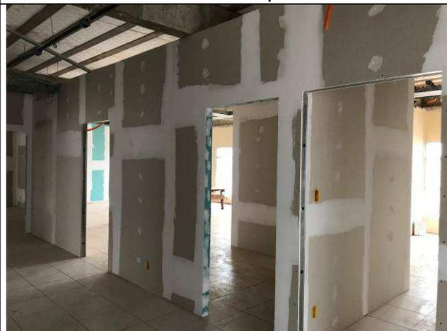
Figura 11C: Paredes de gesso acartonado - Módulo de apoio.
