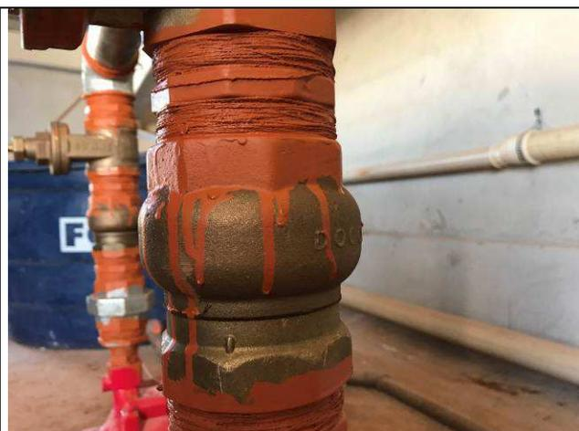
Figura 76C: Válvulas de retenção.
