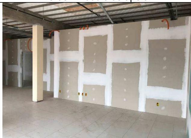
Figura 18C: Paredes de gesso acartonado - Módulo de apoio.
