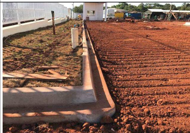
Figura 84C: Meio-fios do estacionamento interno.
