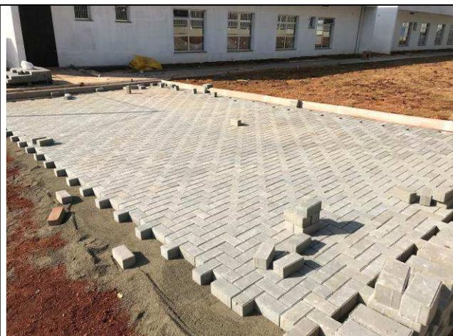
Figura 86C: Meio-fios e calçamento do estacionamento interno.
