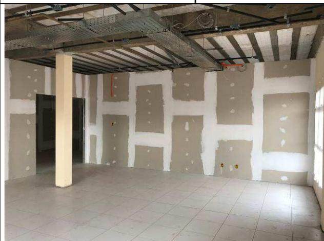
Figura 13C: Paredes de gesso acartonado - Módulo de apoio.
