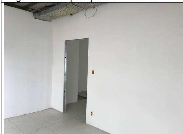
Figura 107C: Paredes com massa corrida.
