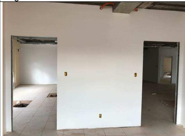
Figura 112C: Paredes com massa corrida.
