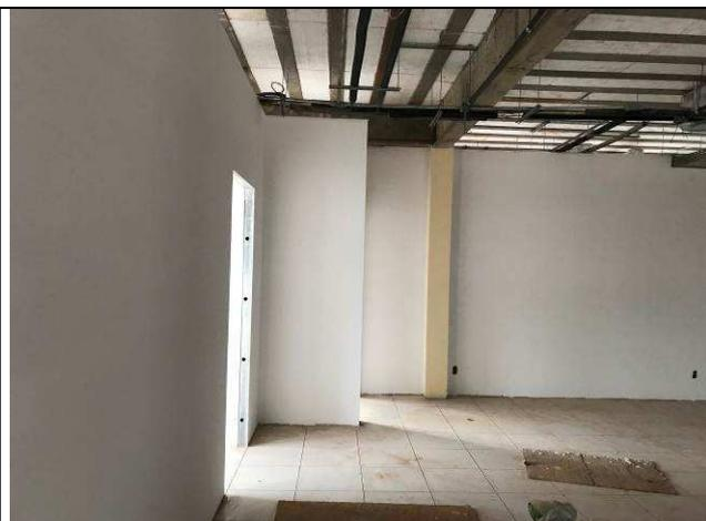
Figura 110C: Paredes com massa corrida.
