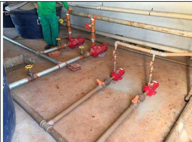
Figura 42C: Alimentação de água fria - interligação dos reservatórios e bombas.
