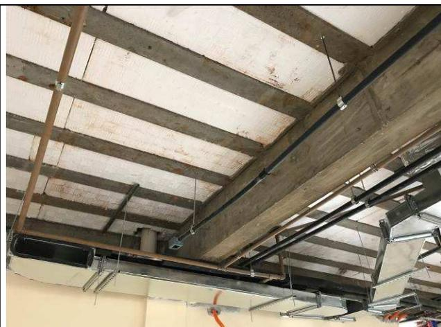
Figura 62C: Rede de drenos, tubulações da rede frigorígena e dutos de ar.
