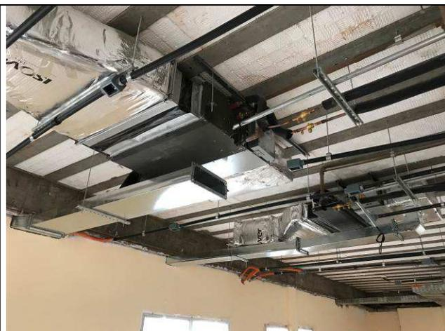
Figura 68C: Rede de drenos, tubulações da rede frigorígena e dutos de ar.
