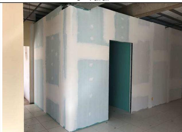
Figura 06C: Paredes de gesso acartonado - 3ª Vara.
