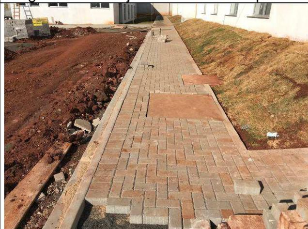
Figura 94C: Calçadas internas em paver.
