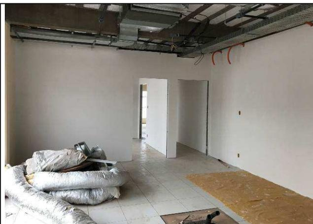
Figura 106C: Paredes com massa corrida.
