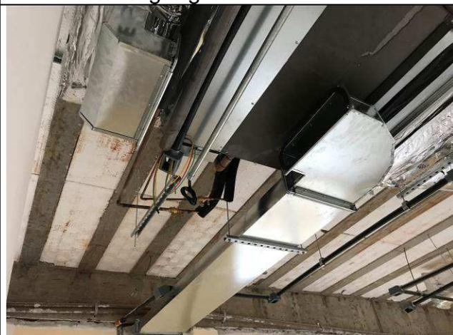
Figura 70C: Rede de drenos, tubulações da rede frigorígena e dutos de ar.
