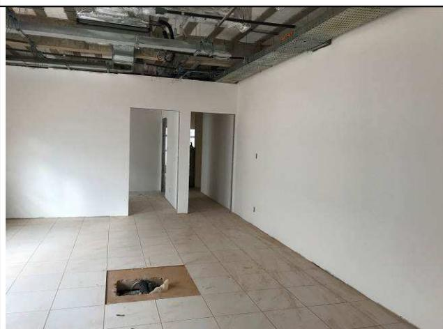
Figura 113C: Paredes com massa corrida.
