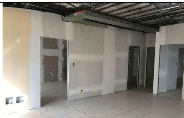
Figura 05C: Paredes de gesso acartonado - 3ª Vara.
