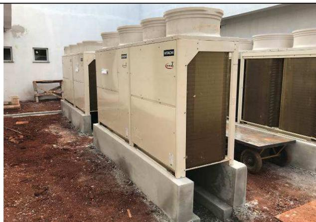
Figura 49C: Conjuntos de condensadoras VRF externas.
