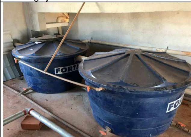
Figura 44C: Reaproveitamento de águas pluviais - interligação reservatórios.
