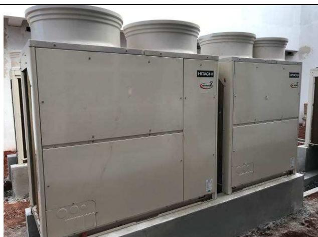
Figura 51C: Conjunto de condensadoras - Capacidade nominal de 40 HP.
