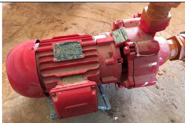
Figura 77C: Bomba de incêndio.
