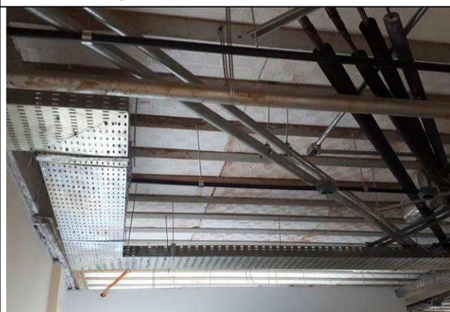
Figura 20E: eletrodutos alimentação quadros - frente direita
