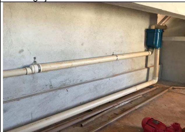
Figura 43C: Reaproveitamento de águas pluviais - interligação reservatórios.
