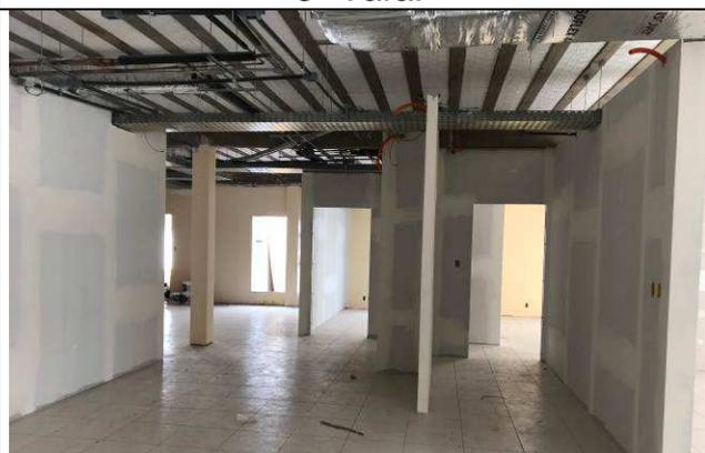
Figura 04C: Paredes de gesso acartonado - 3ª Vara.
