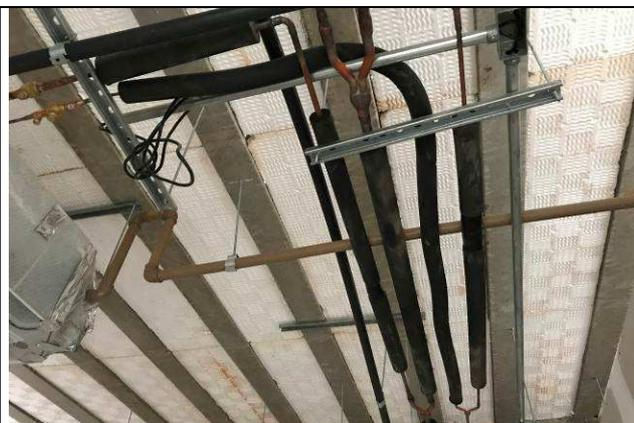
Figura 74C: Rede de drenos e tubulações da rede frigorígena.
