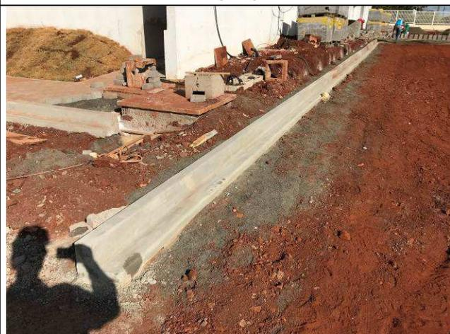
Figura 82C: Meio-fios do estacionamento interno.
