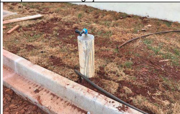
Figura 46C: Reaproveitamento de águas pluviais - tubulações externas.
