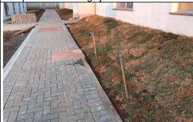
Figura 45C: Reaproveitamento de águas pluviais - tubulações externas.
