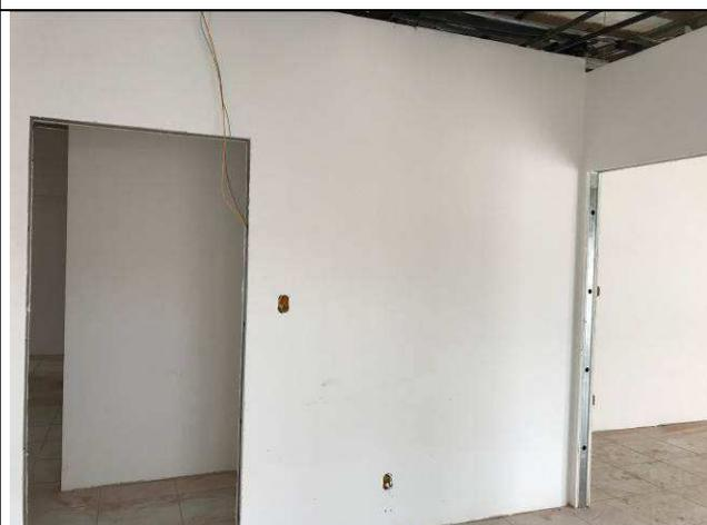
Figura 114C: Paredes com massa corrida.
