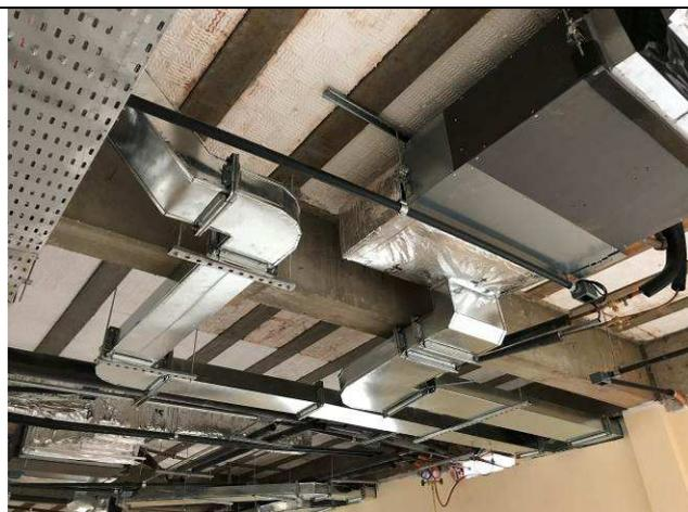
Figura 67C: Rede de drenos, tubulações da rede frigorígena e dutos de ar.
