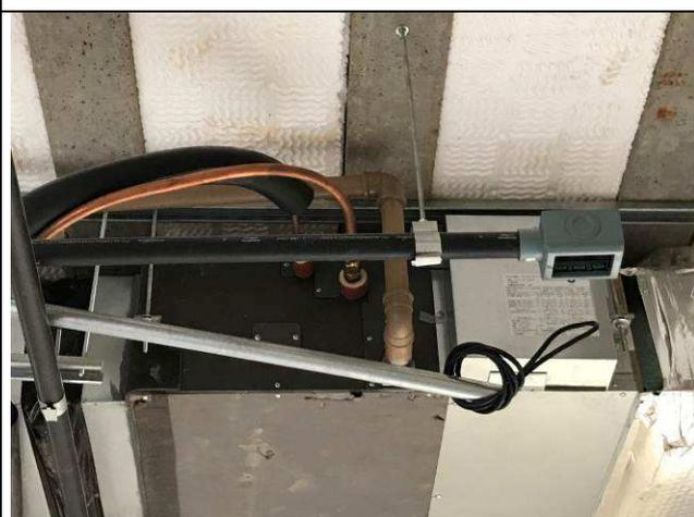
Figura 60C: Rede de drenos e tubulações da rede frigorígena.
