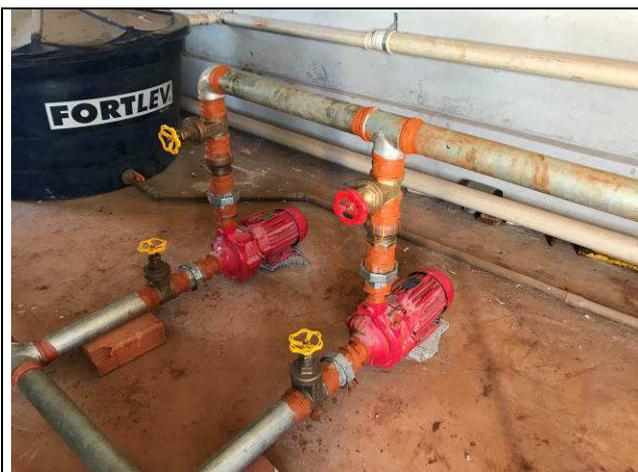
Figura 75C: Interligação das bombas de incêndio.
