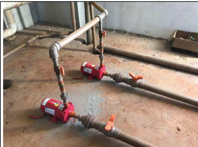
Figura 41C: Alimentação de água fria - interligação dos reservatórios e bombas.
