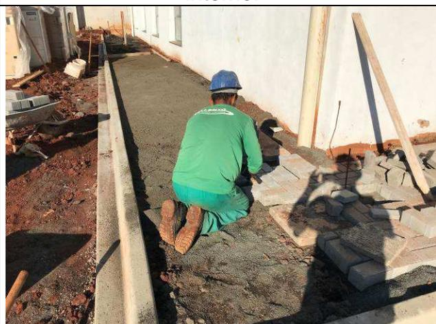
Figura 89C: Calçadas internas em paver.
