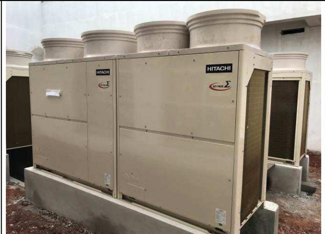
Figura 54C: Conjunto de condensadoras - Capacidade nominal de 40 HP.
