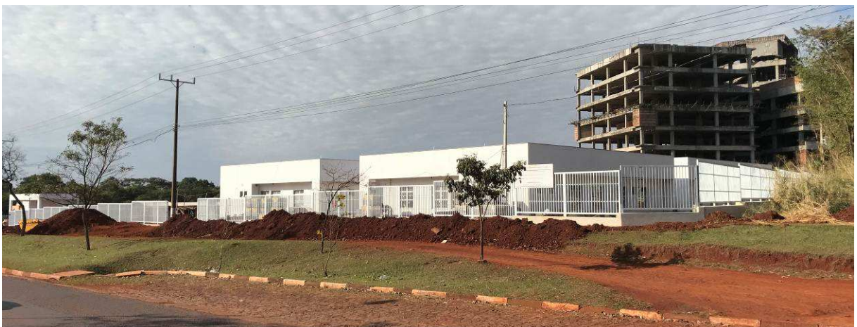
Figura 1 – Prédio do Fórum – vista externa.
