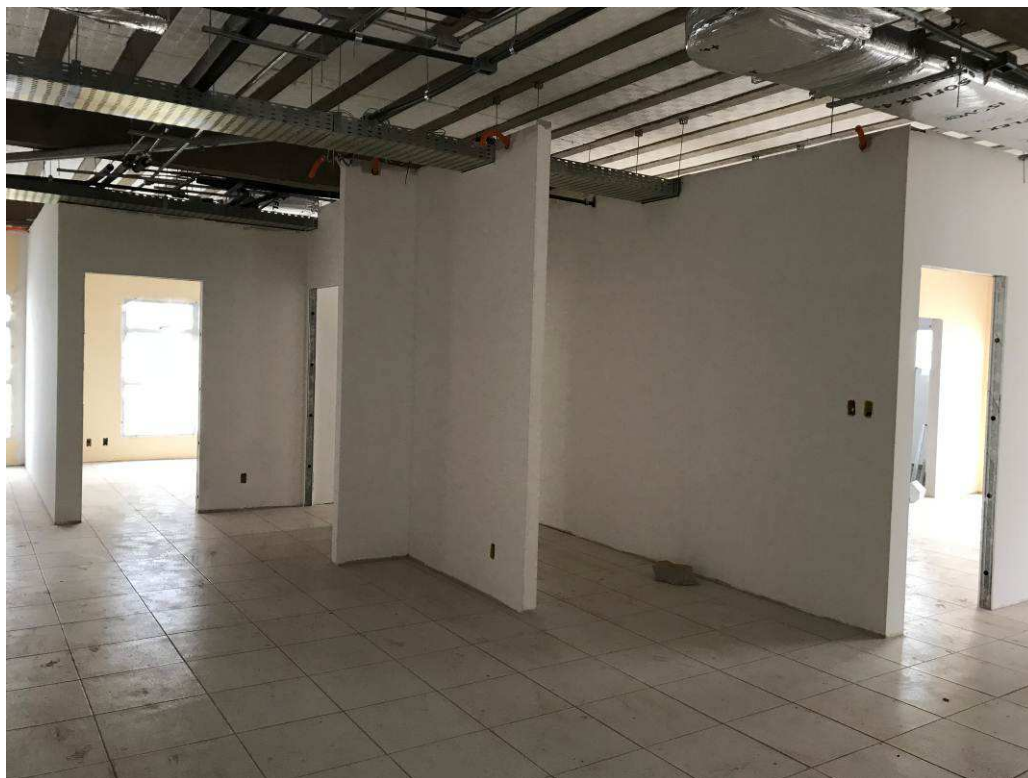
Figura 6 – Prédio do Fórum – vista interna.
