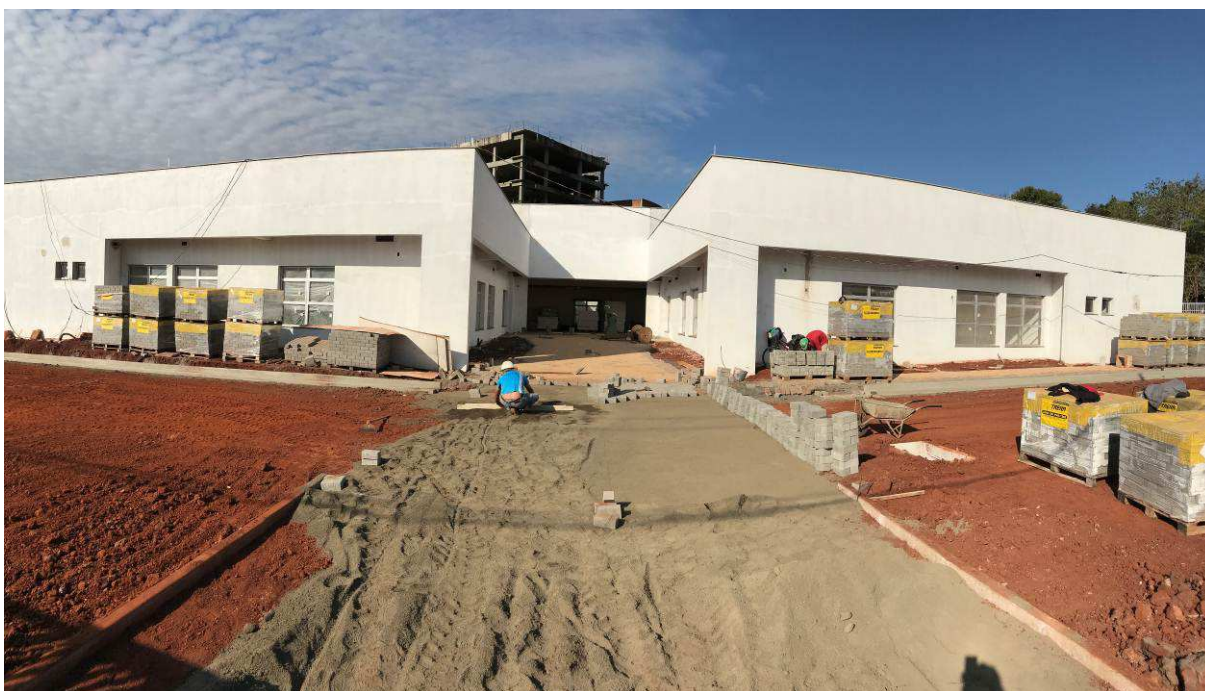
Figura 2 – Prédio do Fórum – vista externa.
