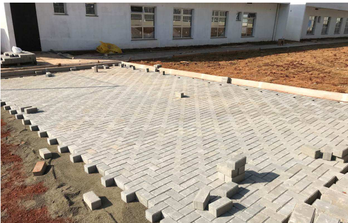
Figura 4 – Prédio do Fórum – vista externa.
