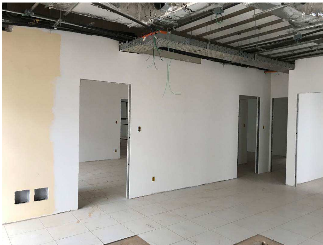
Figura 7 – Prédio do Fórum – vista interna.
