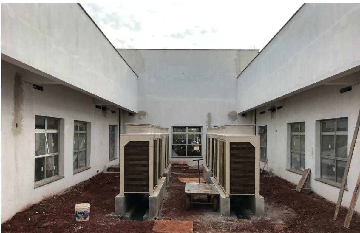
Figura 5 – Prédio do Fórum – vista externa.
