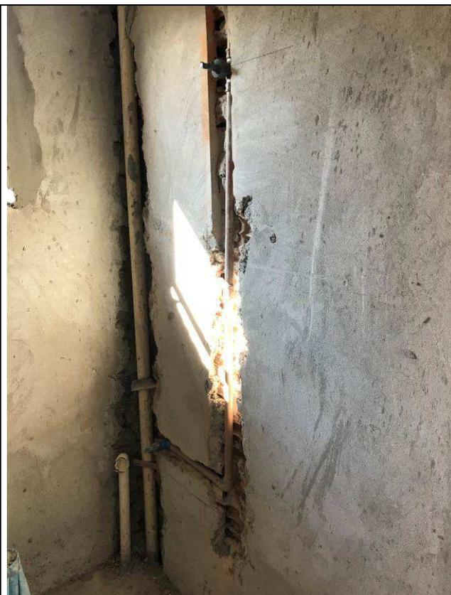
Figura 84C: Registro e pontos de água e esgoto do lavatório - bwc gabinete - Fórum.
