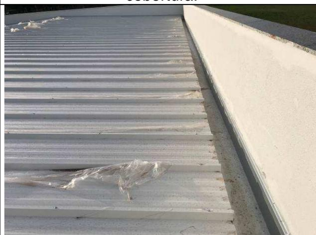
Figura 36C: Telhas termoacústicas e calhas de cobertura.
