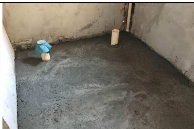
Figura 77C: Pontos de esgoto - banheiro público - Fórum.
