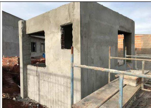
Figura 14C: Paredes de alvenaria - Guarita.
