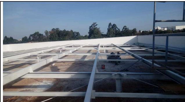
Figura 105C: Pintura da estrutura metálica de cobertura antes da fixação das telhas.
