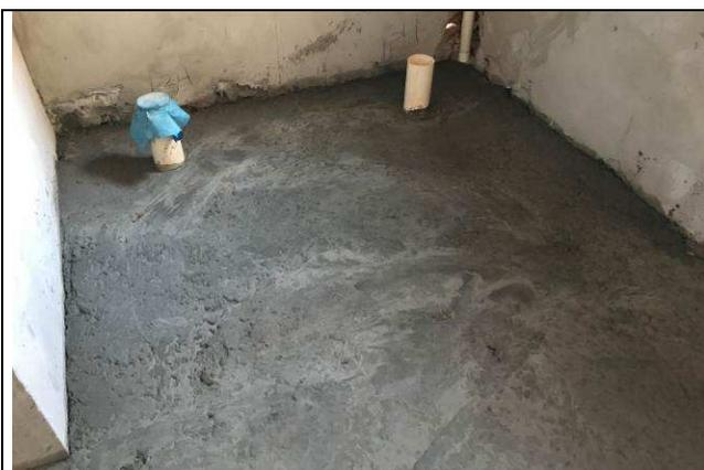
Figura 69C: Contrapiso instalações sanitárias - Fórum.
