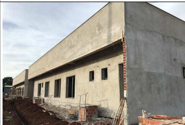
Figura 58C: Revestimento argamassado externo - Fórum.
