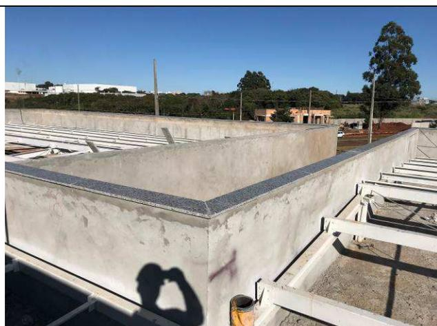
Figura 39C: Capeamento da platibanda.
