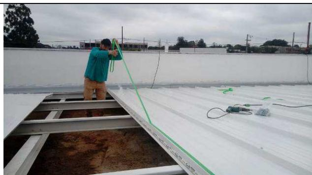
Figura 37C: Aplicação de fita de vedação nas emendas das telhas.
