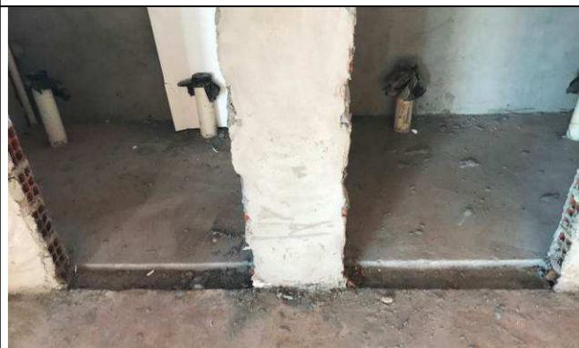
Figura 72C: Contrapiso instalações sanitárias - Fórum.
