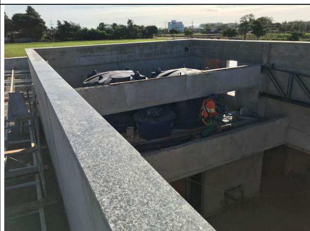
Figura 40C: Capeamento da platibanda.
