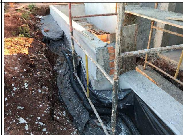
Figura 06C: Impermeabilização e drenagem
