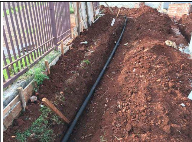
Figura 94C: Tubulação de alimentação dos hidrantes - rede externa - Fórum.
