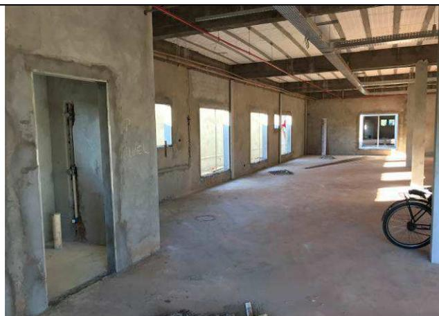
Figura 49C: Revestimento argamassado interno - Fórum.
