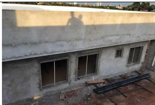
Figura 59C: Revestimento argamassado externo - Fórum.
