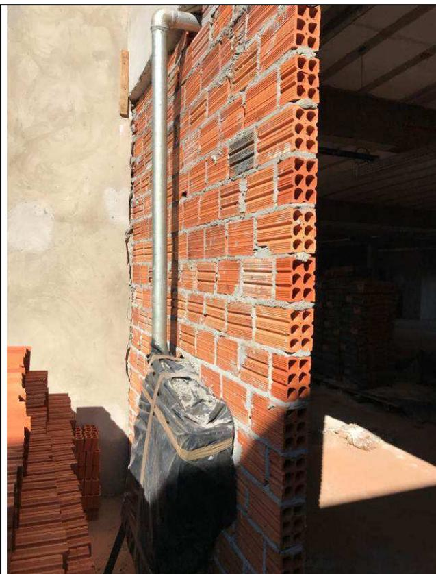
Figura 11C: Divisórias internas - abrigos de hidrante - Fórum.
