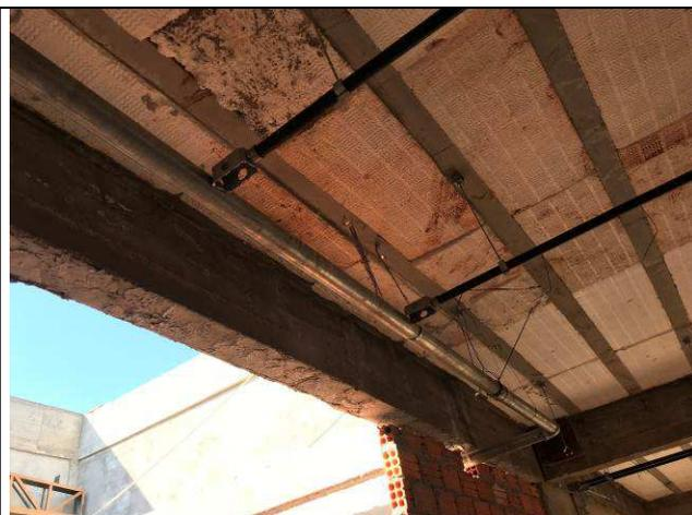
Figura 98C: Tubulação de alimentação dos hidrantes - rede interna - Fórum.
