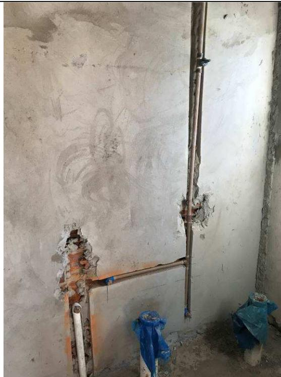
Figura 82C: Registro e pontos de água e esgoto - bwc gabinete - Fórum.
