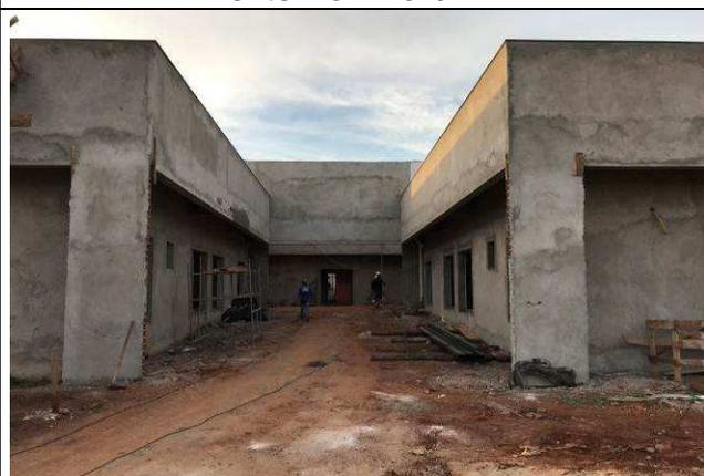
Figura 60C: Revestimento argamassado externo - Fórum.
