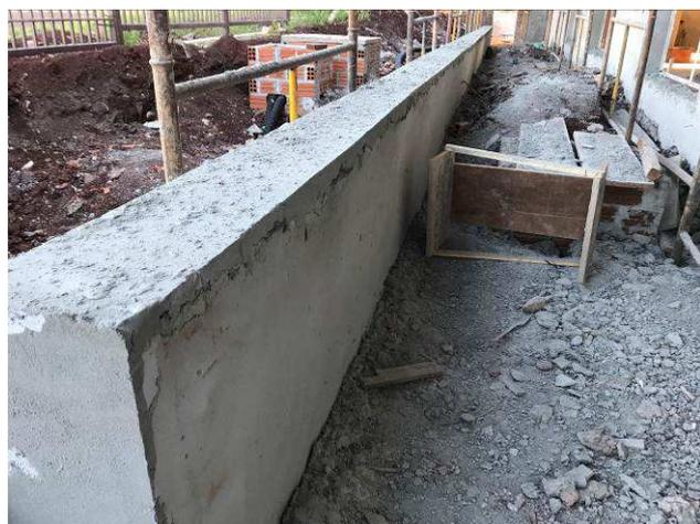
**Figura 01C: Revestimento argamassado - Muros de arrimo.**
