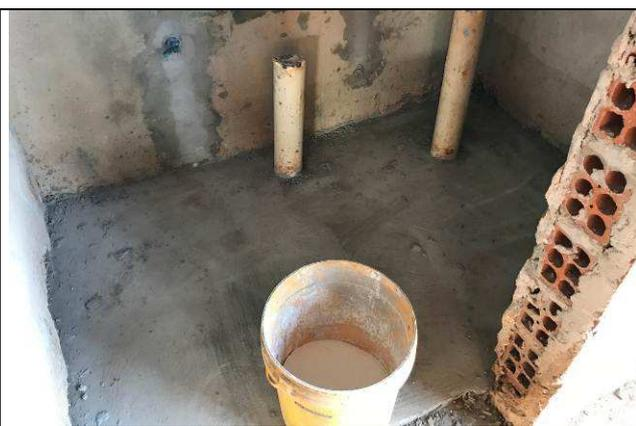
Figura 70C: Contrapiso instalações sanitárias - Fórum.
