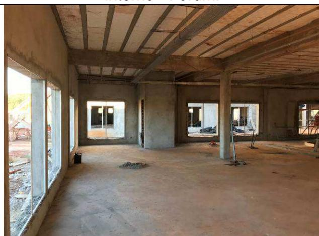
Figura 53C: Revestimento argamassado interno - Fórum.
