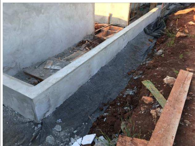
**Figura 02C: Revestimento argamassado - Muros de arrimo.**
