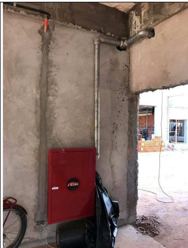
Figura 102C: Abrigo para hidrante - rede interna - Fórum.
