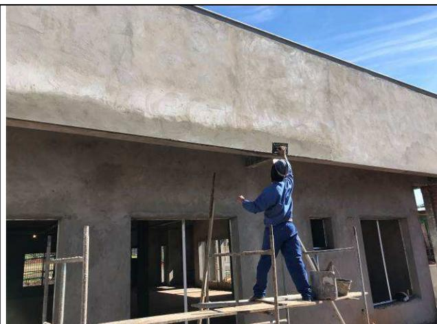
Figura 68C: Revestimento argamassado externo - Fórum.
