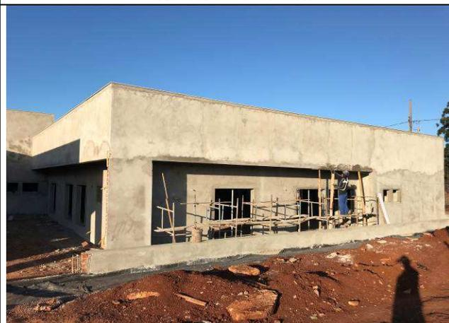
Figura 64C: Revestimento argamassado externo - Fórum.
