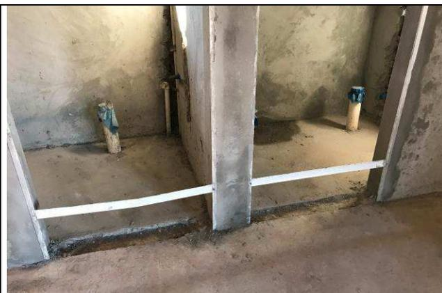
Figura 74C: Contrapiso instalações sanitárias - Fórum.
