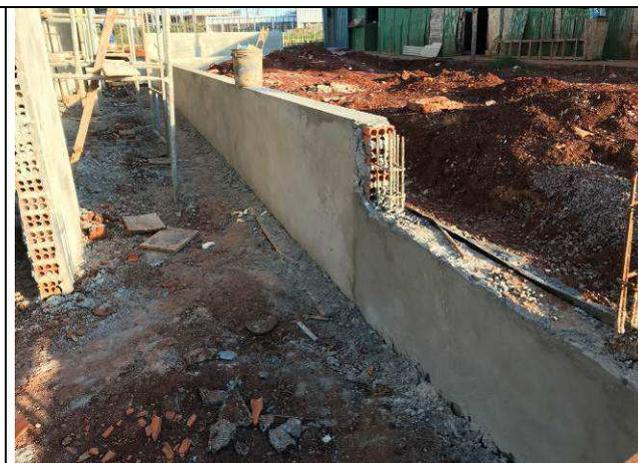
Figura 04C: Revestimento argamassado -
