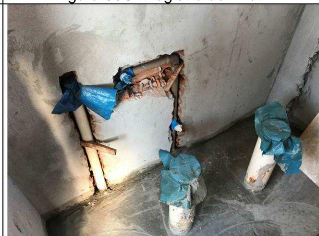
Figura 90C: Pontos de água e esgoto -
