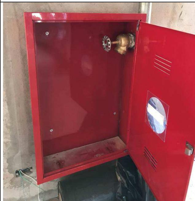
Figura 104C: Abrigo para hidrante - rede interna - Fórum.
