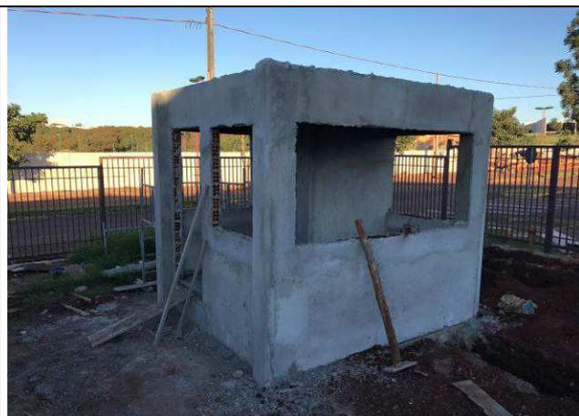
Figura 13C: Paredes de alvenaria - Guarita.
