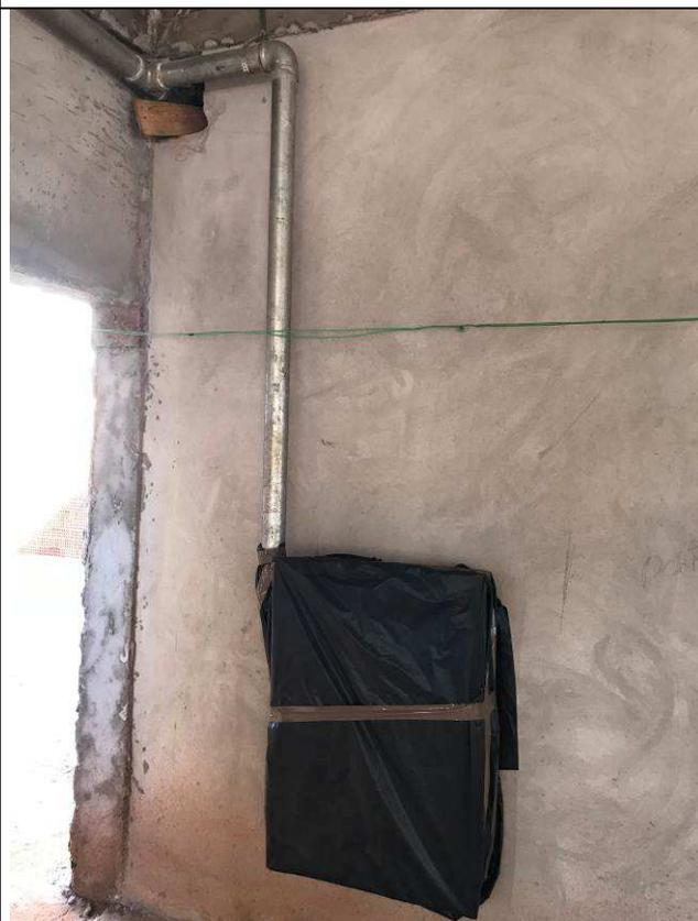
Figura 100C: Abrigo para hidrante - rede interna - Fórum.
