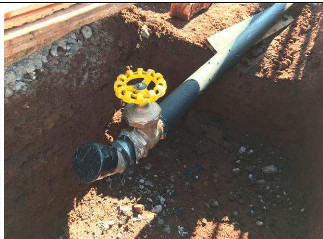
Figura 93C: Registro do hidrante de recalque - rede externa - Fórum.
