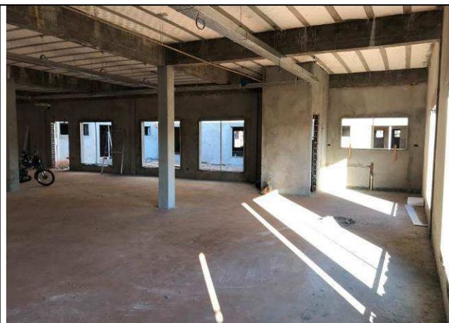
Figura 50C: Revestimento argamassado interno - Fórum.
