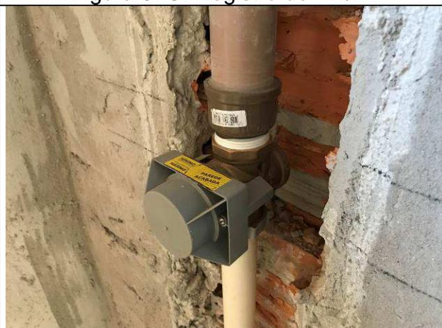
Figura 89C: Válvula de descarga.
