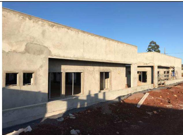
Figura 65C: Revestimento argamassado externo - Fórum.
