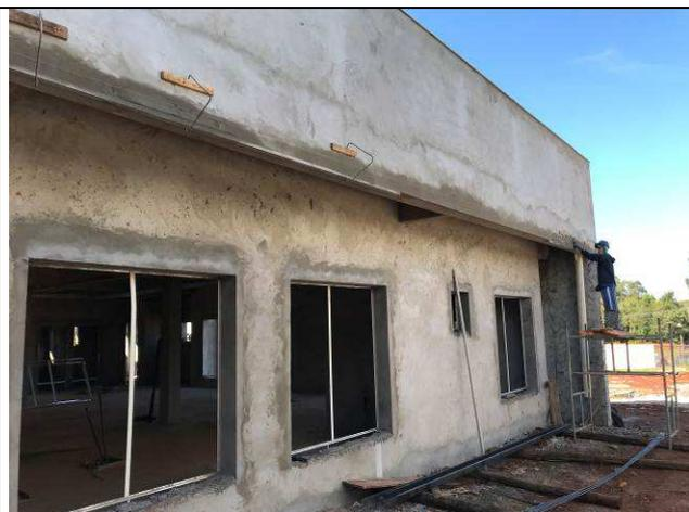
Figura 67C: Revestimento argamassado externo - Fórum.
