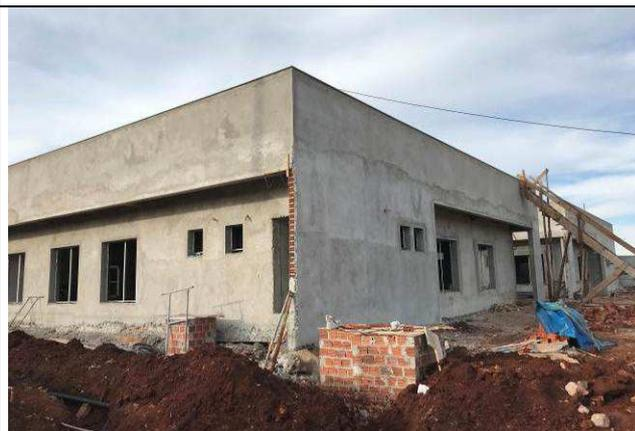
Figura 57C: Revestimento argamassado externo - Fórum.
