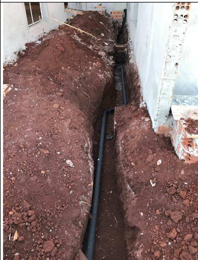
Figura 96C: Tubulação de alimentação dos hidrantes - rede externa - Fórum.
