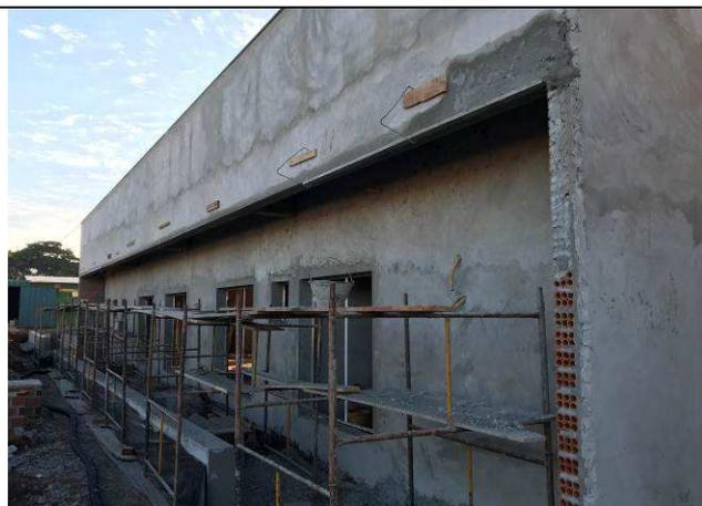
Figura 63C: Revestimento argamassado externo - Fórum.
