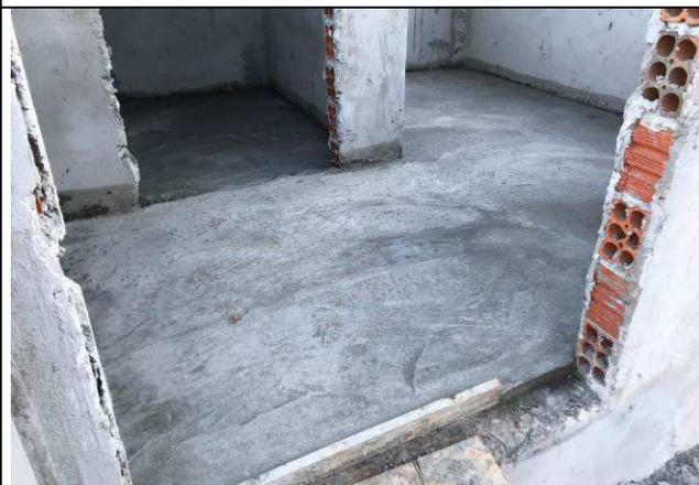
Figura 76C: Contrapiso instalações sanitárias - Fórum.
