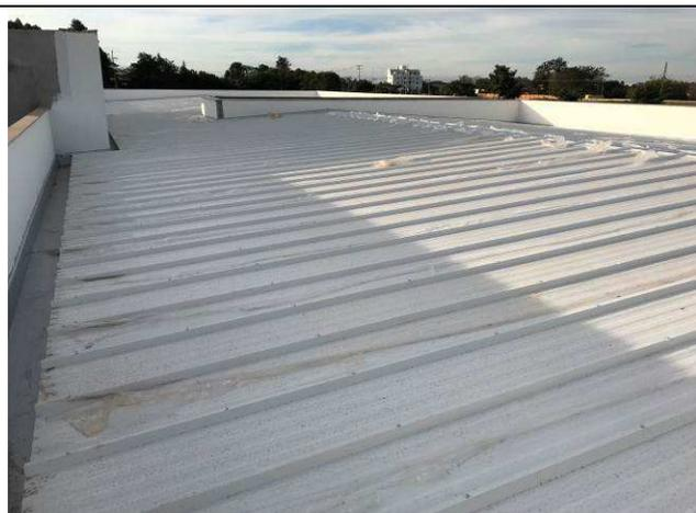
Figura 33C: Telhas termoacústicas e calhas de cobertura.
