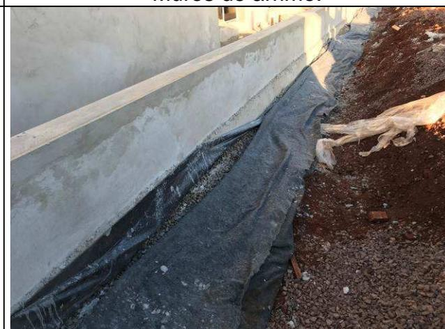
Figura 08C: Impermeabilização e drenagem
