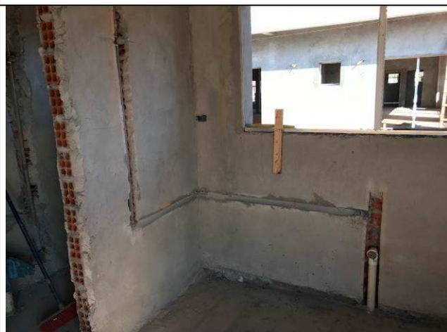
Figura 85C: Registro e pontos de água e esgoto - copa auditório - Fórum.
