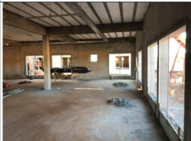
Figura 52C: Revestimento argamassado interno - Fórum.
