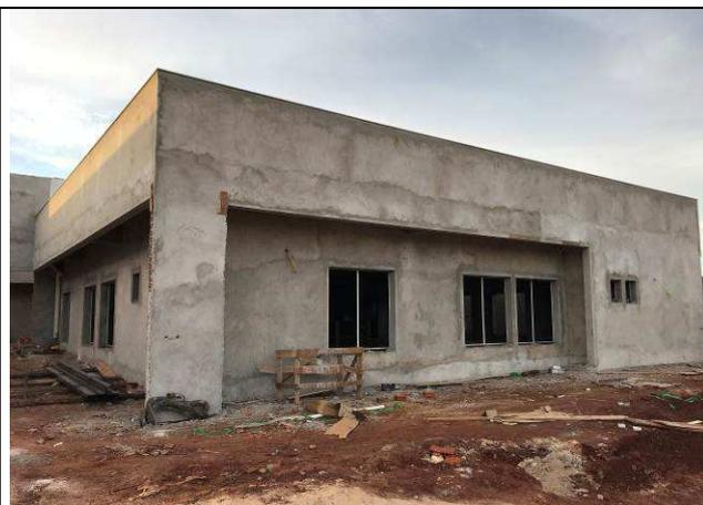
Figura 62C: Revestimento argamassado externo - Fórum.
