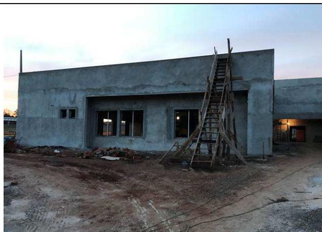
Figura 61C: Revestimento argamassado externo - Fórum.
