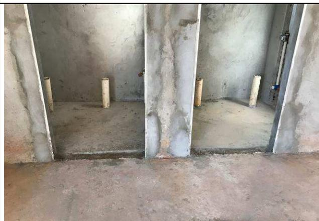
Figura 75C: Contrapiso instalações sanitárias - Fórum.
