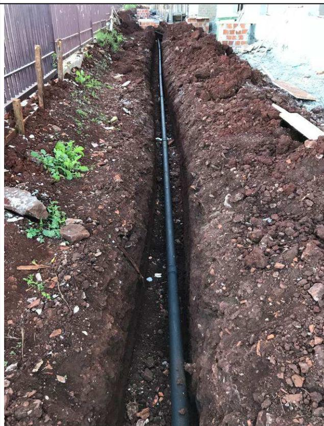
Figura 95C: Tubulação de alimentação dos hidrantes - rede externa - Fórum.
