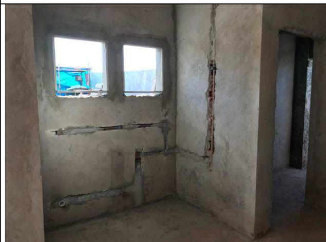
Figura 86C: Registro e pontos de água e esgoto dos tanques- terceirizados - Fórum.
