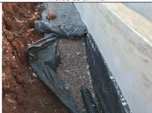
Figura 07C: Impermeabilização e drenagem
