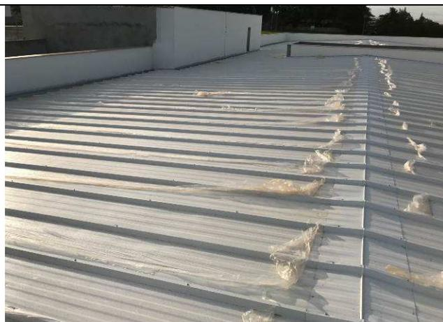
Figura 31C: Telhas termoacústicas de cobertura.
