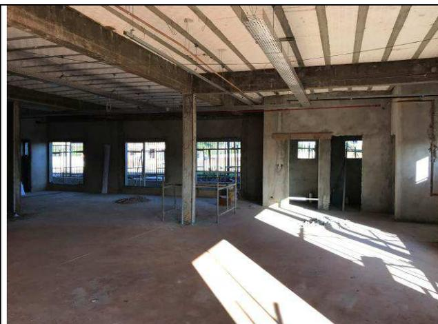
Figura 48C: Revestimento argamassado interno - Fórum.
