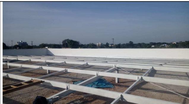
Figura 106C: Pintura da estrutura metálica de cobertura antes da fixação das telhas.
