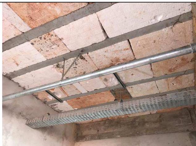
Figura 97C: Tubulação de alimentação dos hidrantes - rede interna - Fórum.
