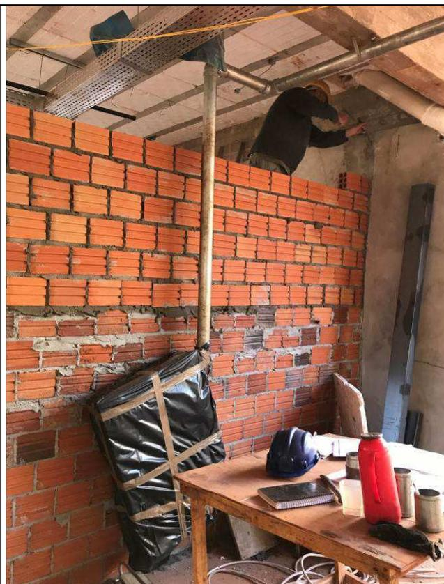
Figura 12C: Divisórias internas - abrigos de hidrante - Fórum.
