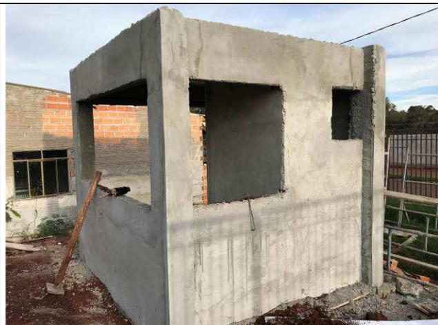
Figura 55C: Revestimento argamassado externo - Guarita.
