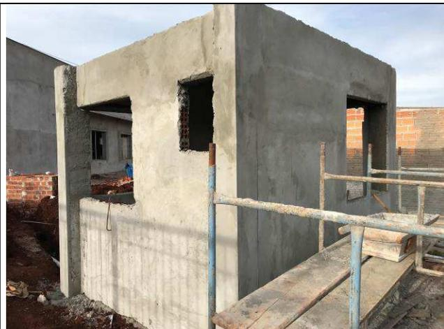
Figura 56C: Revestimento argamassado externo - Guarita.
