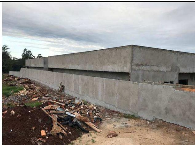
Figura 63C: Revestimento argamassado - muro de fechamento.
