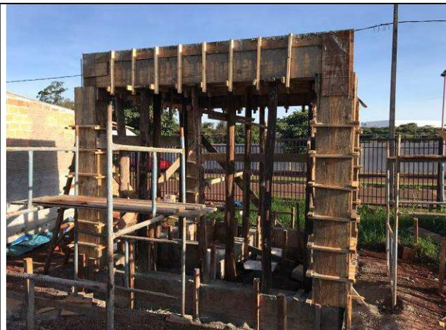
Figura 16C: Pilares, vigas e laje de cobertura - Guarita.
