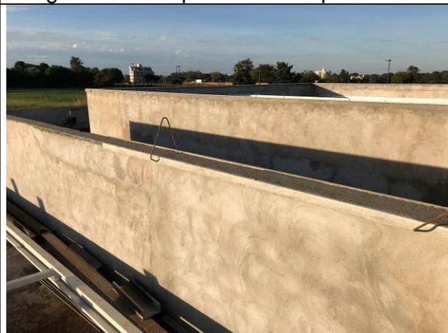
Figura 24C: Copeamento da platibanda - regularização para assentamento.
