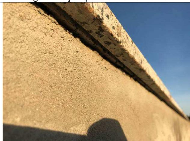
Figura 26C: Copeamento da platibanda - pingadeiras em baixo relevo.
