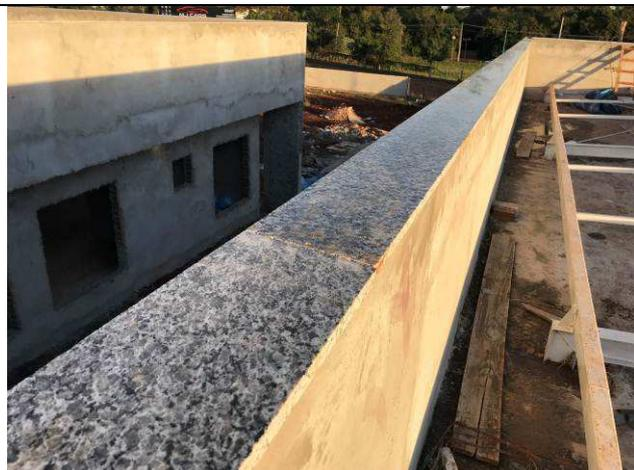
Figura 21C: Copeamento da platibanda.
