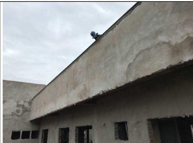
Figura 22C: Copeamento da platibanda.
