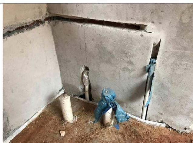
Figura 48C: Pontos de esgoto - BWC apoio administrativo.
