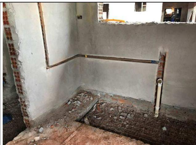
Figura 50C: Pontos de água e esgoto -
