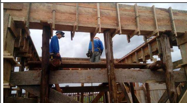
Figura 13C: Montagem das vigas de
