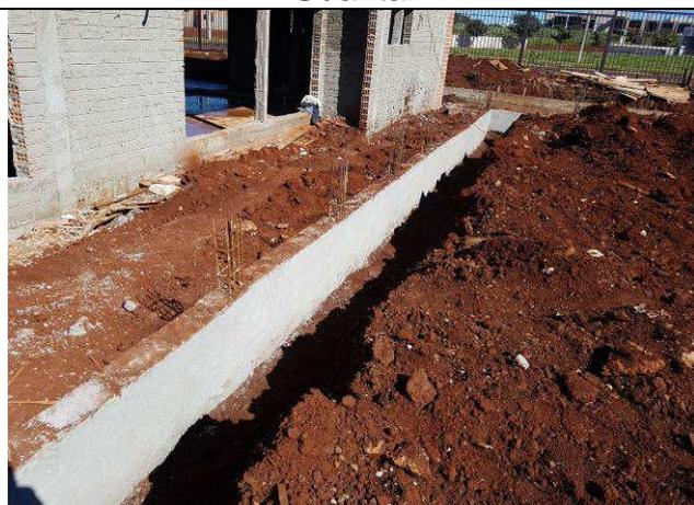
Figura 07C: Revestimento argamassado - Muros de arrimo.
