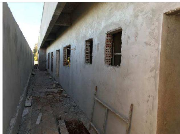
Figura 40C: Revestimento argamassado.
