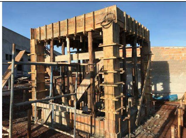
Figura 15C: Pilares, vigas e laje de cobertura - Guarita.
