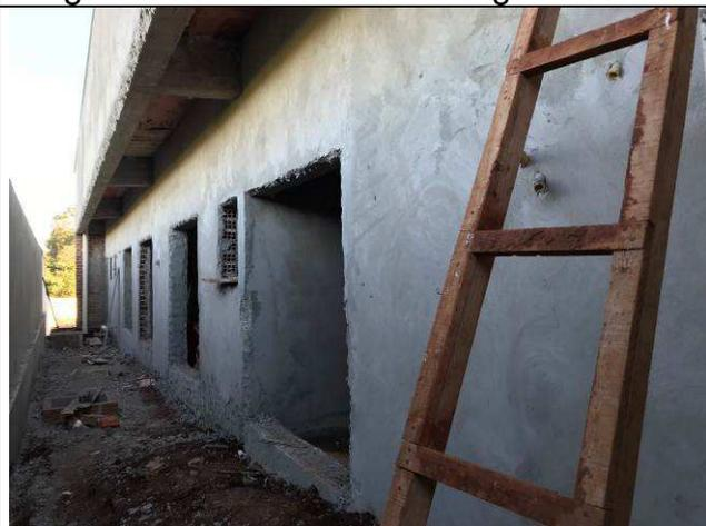
Figura 41C: Revestimento argamassado.
