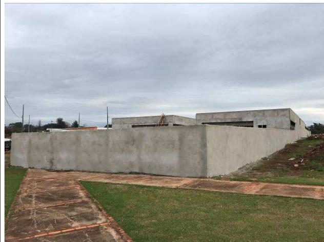
Figura 60C: Revestimento argamassado - muro de fechamento.
