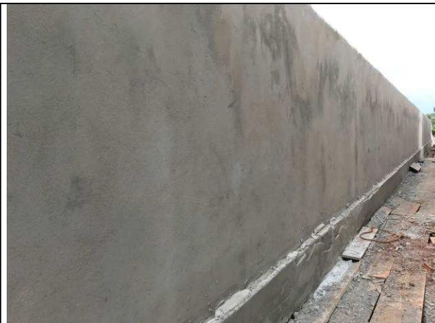
Figura 64C: Revestimento argamassado - muro de fechamento.
