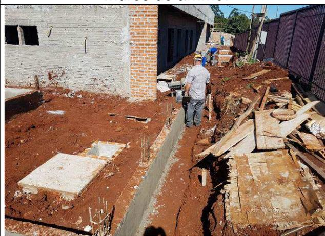
Figura 08C: Revestimento argamassado - Muros de arrimo.
