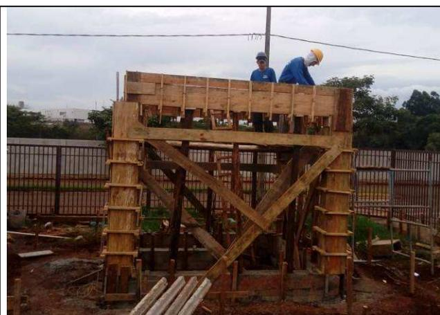
Figura 12C: Montagem das vigas de
