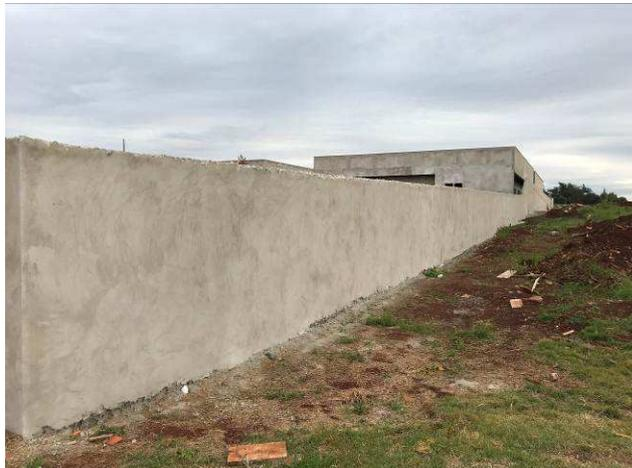
Figura 61C: Revestimento argamassado - muro de fechamento.
