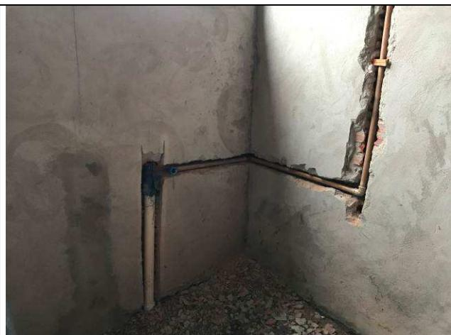
Figura 49C: Pontos de água e esgoto -
