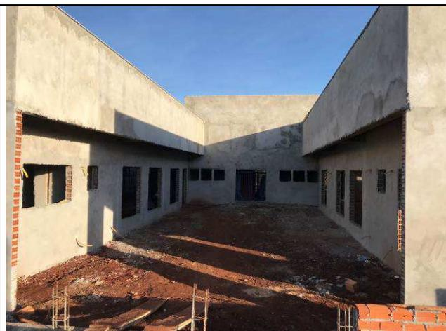
Figura 39C: Revestimento argamassado.
