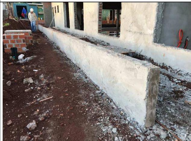
Figura 06C: Revestimento argamassado - Muros de arrimo.
