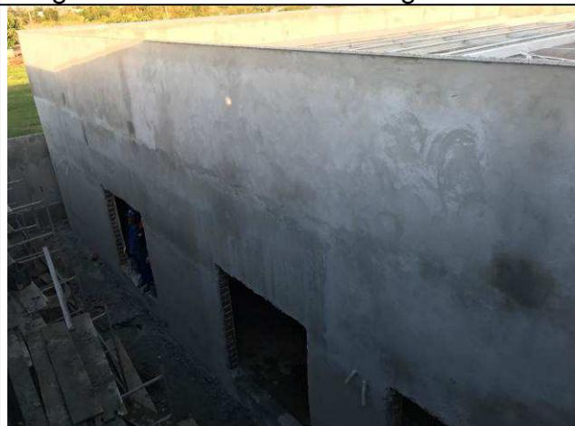
Figura 43C: Revestimento argamassado.
