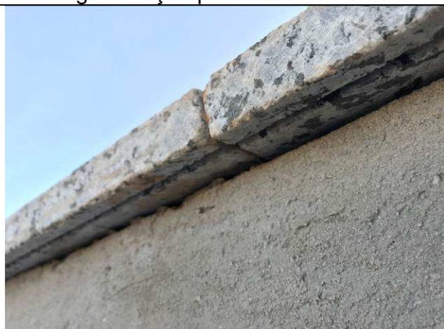
Figura 25C: Copeamento da platibanda - pingadeiras em baixo relevo.
