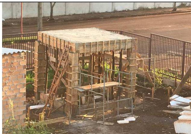
Figura 17C: Pilares, vigas e laje de cobertura - Guarita.
