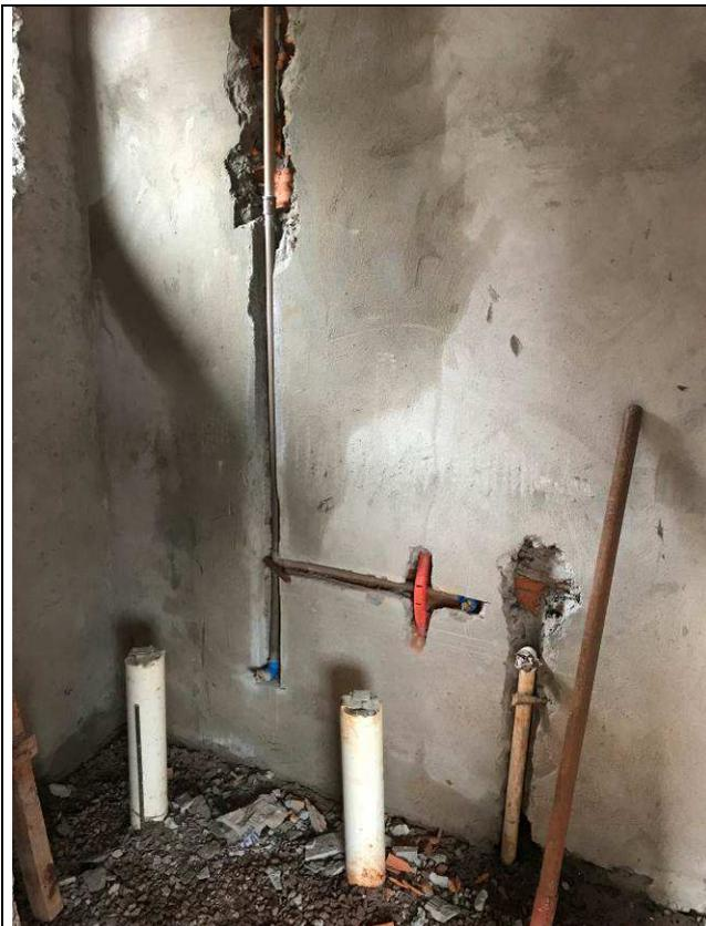
Figura 45C: Pontos de água e esgoto - BWC gabinete de juiz - 2ª Vara.
