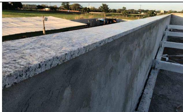
Figura 19C: Capeamento da platibanda.
