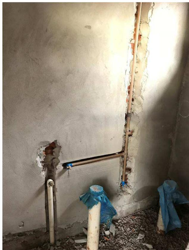
Figura 51C: Pontos de água e esgoto -
