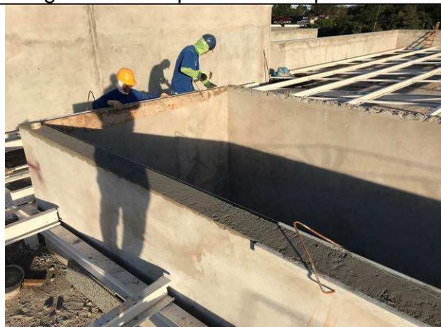
Figura 23C: Copeamento da platibanda - regularização para assentamento.
