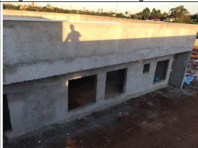
Figura 44C: Revestimento argamassado.
