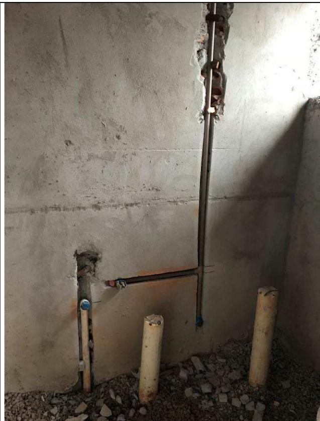
Figura 46C: Pontos de água e esgoto - BWC gabinete de juiz - 2ª Vara.
