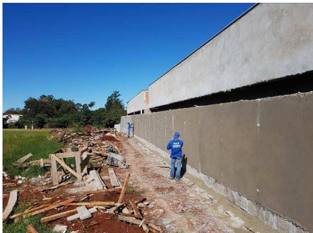
Figura 59C: Revestimento argamassado - muro de fechamento.
