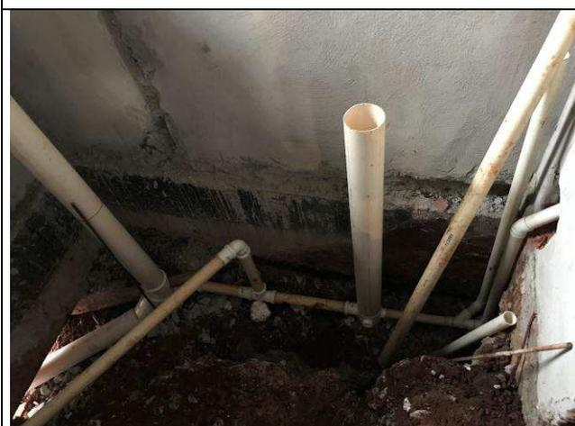
Figura 47C: Pontos de esgoto - BWC sala de perícias.
