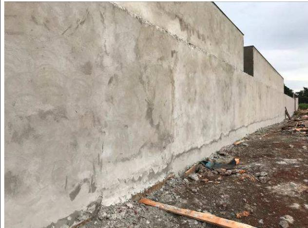
Figura 62C: Revestimento argamassado - muro de fechamento.
