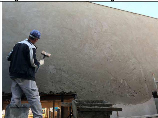
Figura 42C: Revestimento argamassado.
