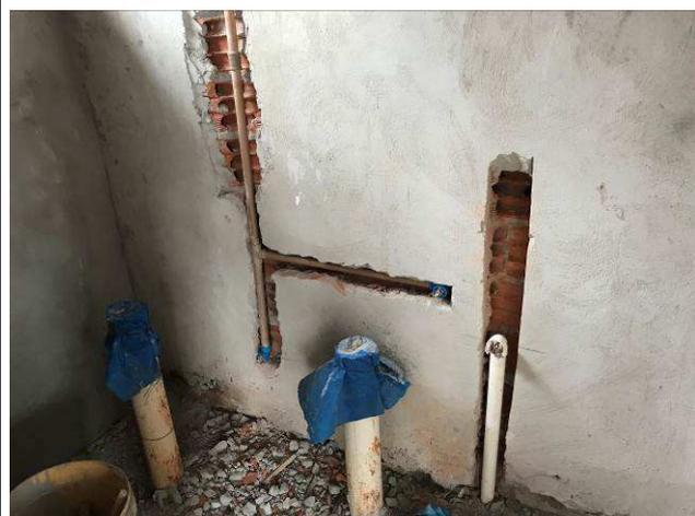
Figura 52C: Pontos de água e esgoto -
