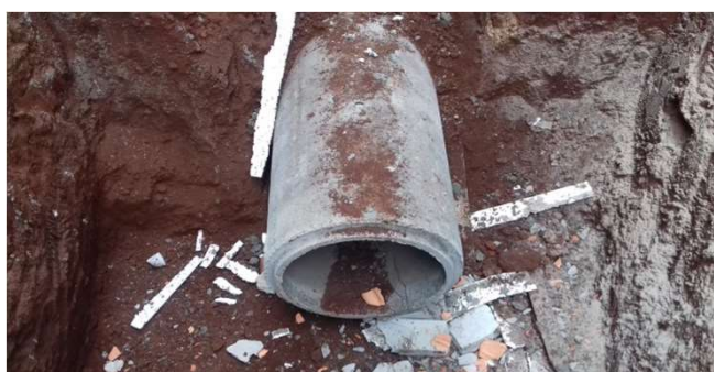
Figura 39C: Tubo de concreto 400mm, instalado nos fundos do terreno - detalhe
