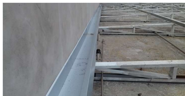
Figura 13C: calha instalada no bloco da direita
