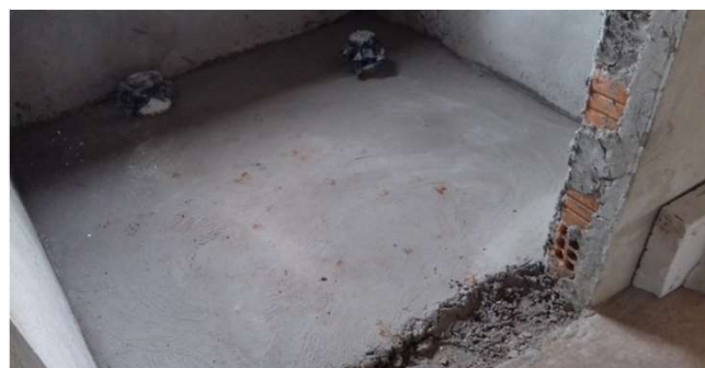
Figura 22C: aplicação de contrapiso em sanitário de vara
