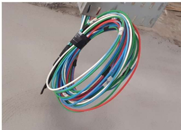
Figura 7E: Cabos elétricos #2,5mm 2 .
