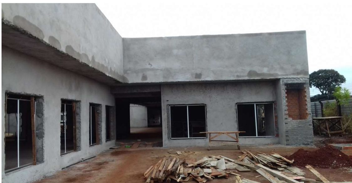
Figura 01C: Visão geral da obra
