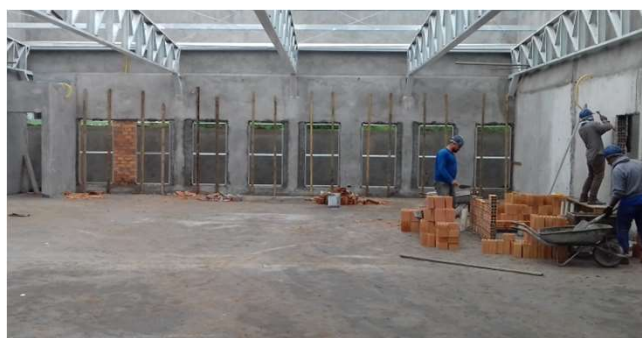
Figura 18C: parede dos fundos das salas múltiplo-uso e lateral direita, após emboço
