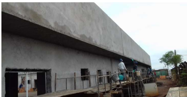
Figura 20C: emboço/reboco da parede frontal
