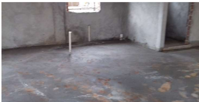
Figura 23C: aplicação de contrapiso em sanitário e sala de perícia
