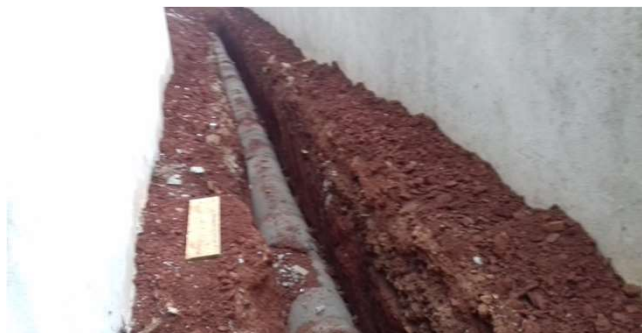
Figura 38C: Tubo de concreto 400mm, instalado nos fundos do terreno
