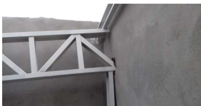
Figura 42C: estrutura de cobertura do reservatório do bloco da direita - pintura
