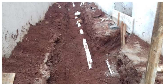
Figura 03C: abertura e fechamento de vala para execução de tubulação de esgoto e pluvial - fundos do terreno
