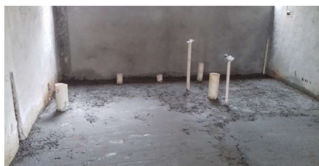
Figura 36C: Pontos de Esgoto primário, secundário e ventilação - sanitários públicos
