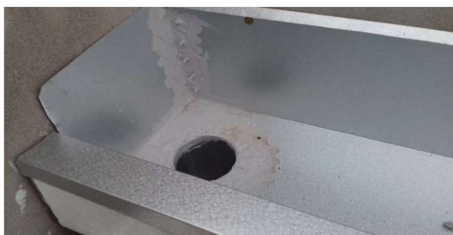
Figura 10C: detalhe de bocal de descida, em calha
