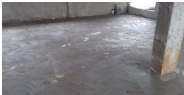
Figura 24C: aplicação de contrapiso no hall de entrada
