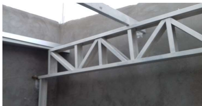
Figura 41C: estrutura de cobertura do reservatório do bloco da esquerda - pintura
