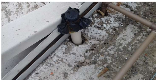
Figura 37C: tubo de AF de 25mm descendo em prumada e tubo de ventilação ao lado
