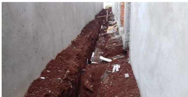
Figura 02C: abertura e fechamento de vala para execução de tubulação de esgoto e pluvial - fundos do terreno
