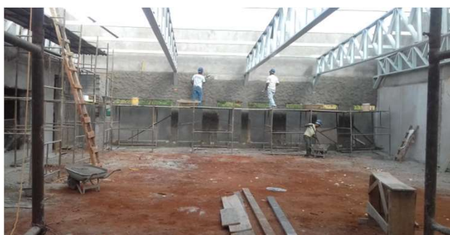
Figura 17C: operários realizando o emboço da parede dos fundos das salas múltiplo-uso
