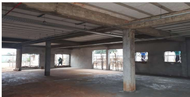
Figura 19C: paredes do hall de entrada com emboço finalizado.
