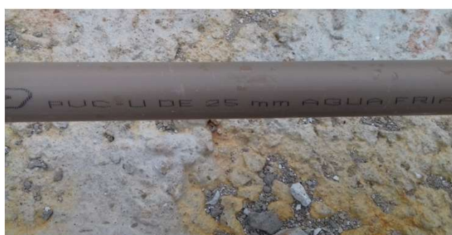
Figura 31C: detalhe da especificação do tubo de PVC marrom (AF) de 25mm
