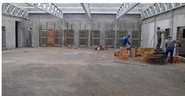
Figura 21C: execução do contrapiso nas salas de múltiplo-uso
