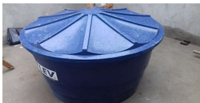
Figura 33C: reservatório de polietileno de 1000L, instalado no bloco da direita
