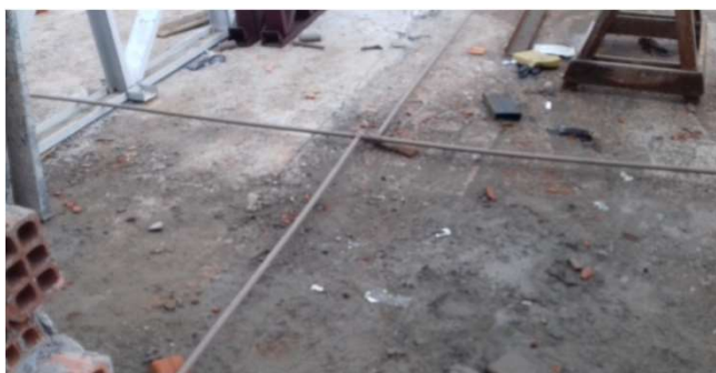
Figura 27C: execução da rede alimentadora de 25mm - região do bloco central (frente)
