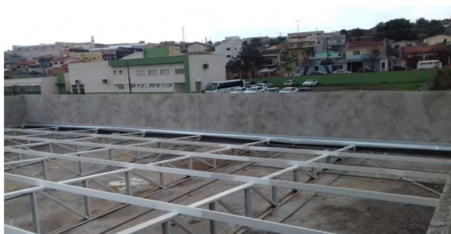
Figura 16C: calha instalada no bloco da esquerda
