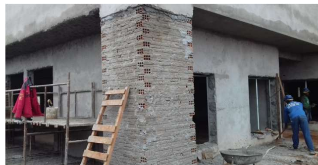
Figura 07C: alvenaria de fechamento em shaft (fachada frontal).
