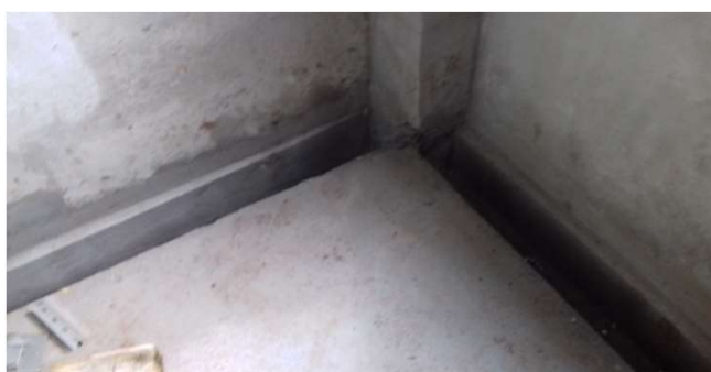
Figura 25C: execução da canaleta no perímetro do piso da sala técnica
