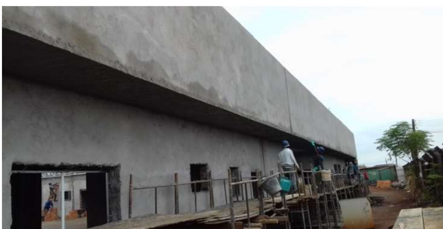
Figura 06C: alvenaria de fechamento finalizada na fachada frontal
