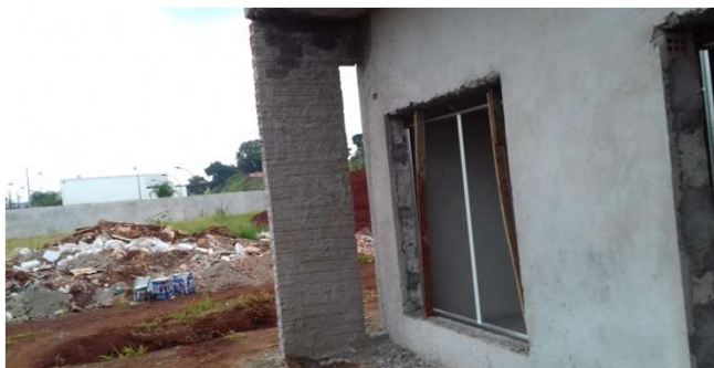
Figura 08C: alvenaria externa - detalhe no canto de fachada frontal
