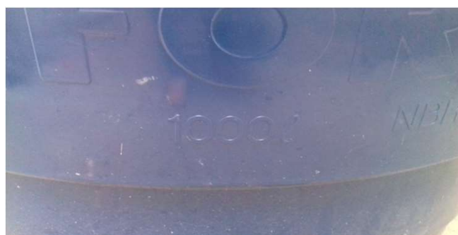
Figura 34C: detalhe da especificação do reservatório (1000L)
