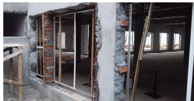
Figura 05C: vergas instaladas em vãos de janelas - parede frontal
