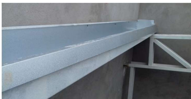
Figura 12C: detalhe em calha do reservatório da direita
