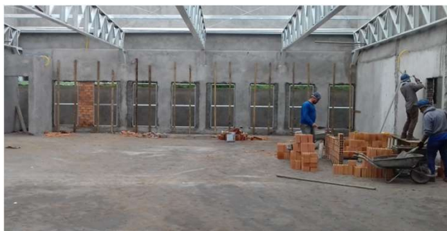
Figura 04C: vergas instaladas em vãos de janelas - fundos das salas múltiplo uso
