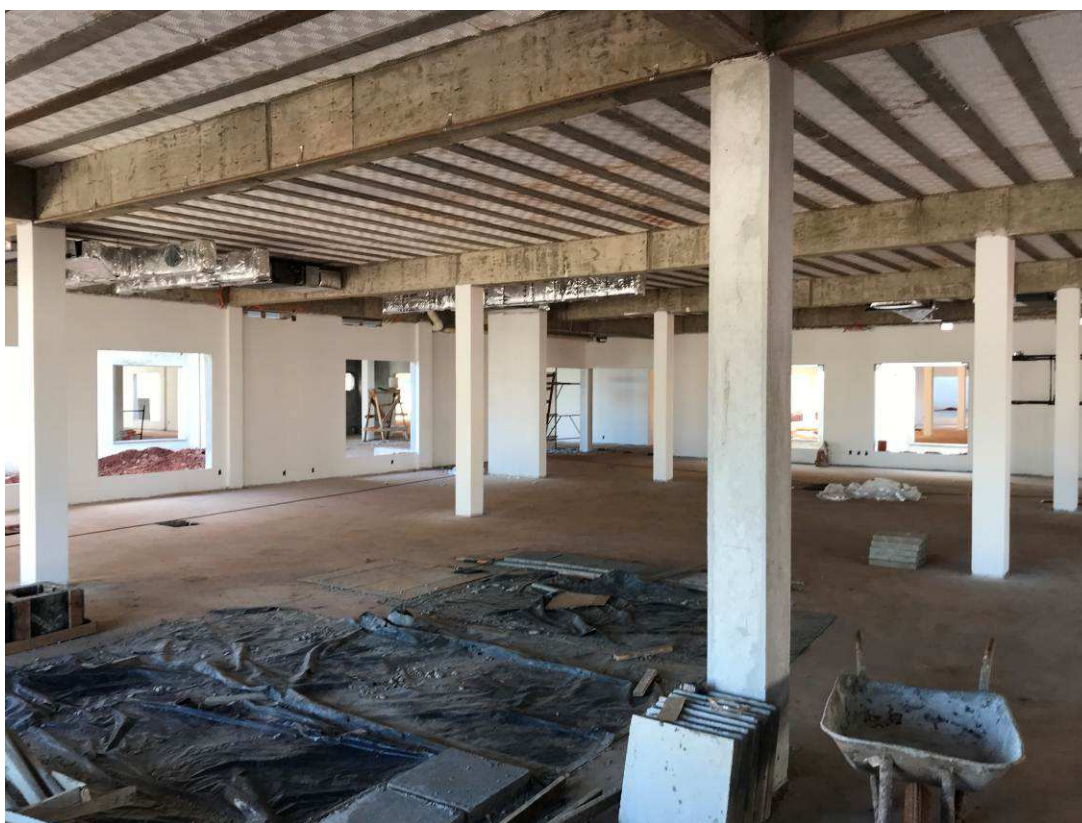
Figura 7 – Prédio do Fórum - vista interna.
