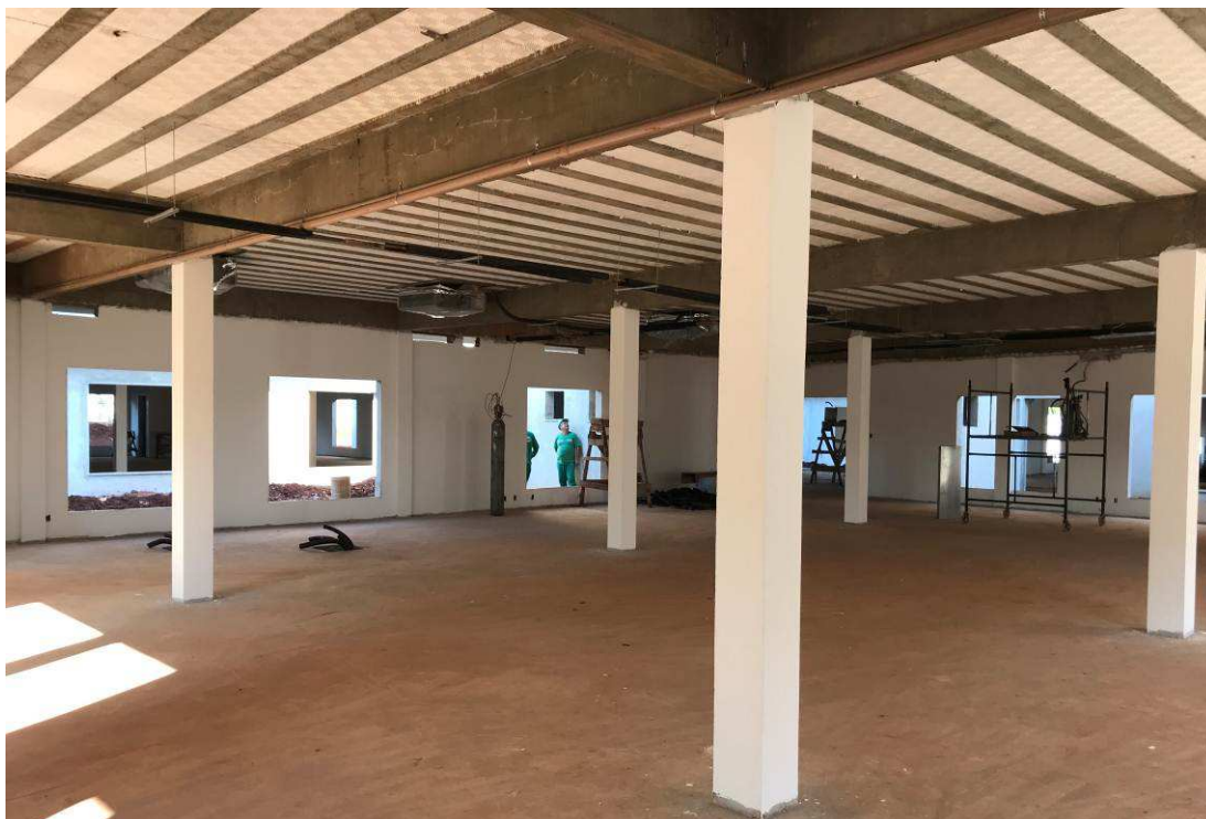
Figura 6 – Prédio do Fórum - vista interna.
